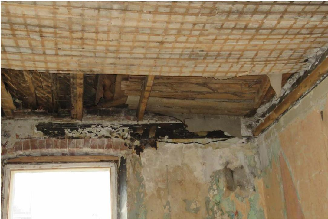
Фото 25. Пом. 2.24. Фрагмент перекрытия 2-го этажа. Дата съемки: 18.01.2022 г. Автор съемки: Глинская Н.Б.
