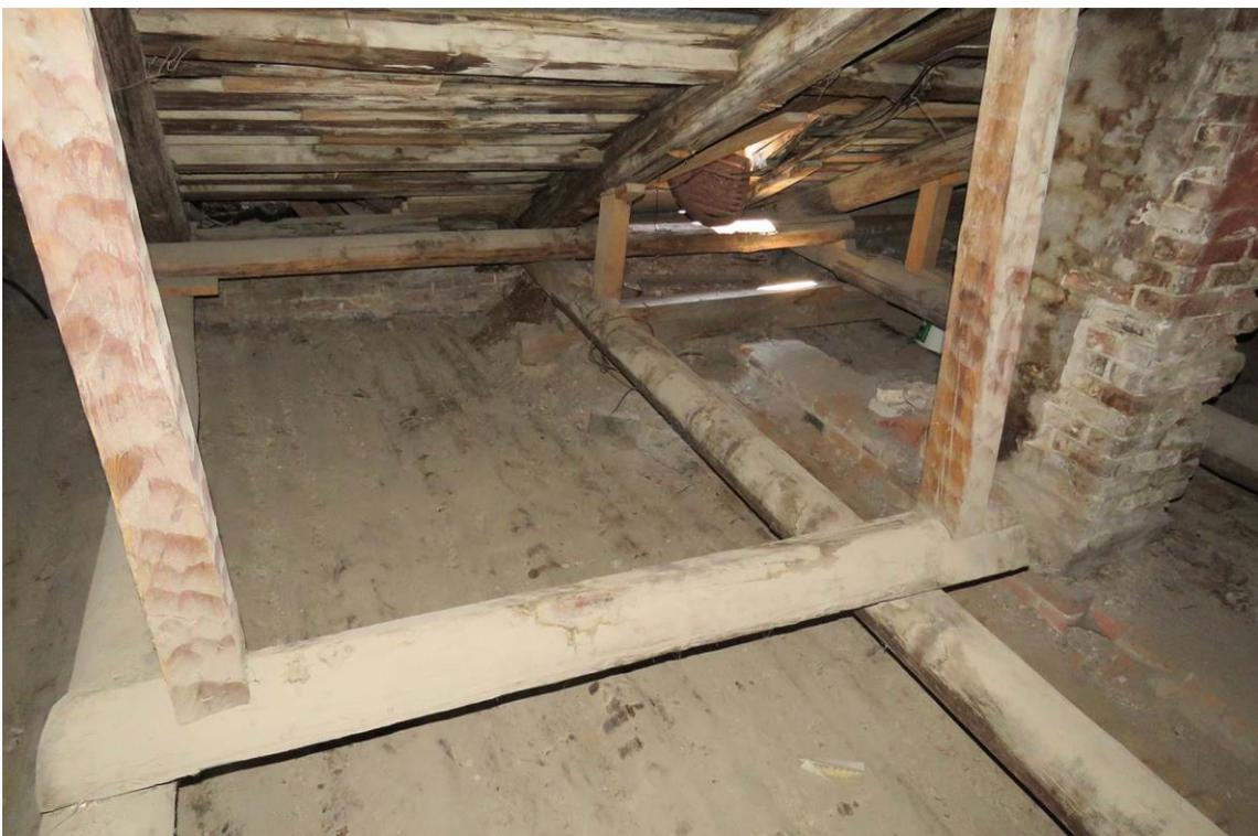
Фото 34. Бревенчатый накат перекрытия. Дата съемки: 18.01.2022 г. Автор съемки: Глинская Н.Б.
