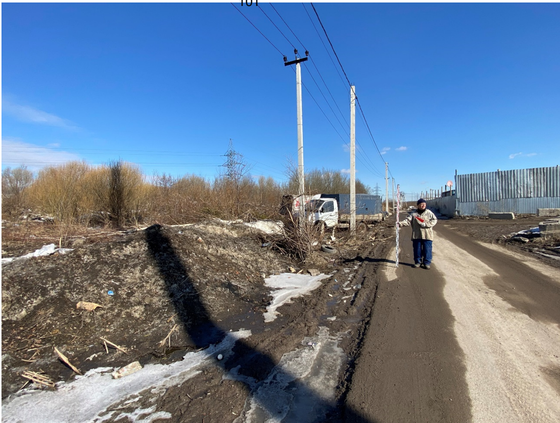
Рис. 38. ЛО-2022, Всеволожский район, дер. Новосаратовка, часть земельного участка с кадастровым номером 47:07:0601006:12. Photo 15. Общий вид территории обследования. Вид с ЮЗ
