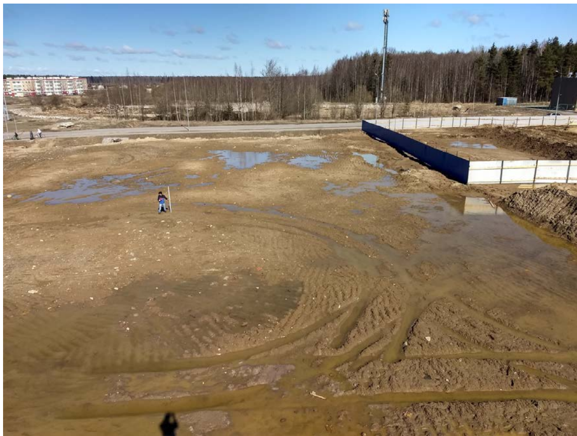
Рис. 17. Всеволожский район, Янино-Восточный, уч. 19, КН: 47:07:1039001:2436. Точка фотофиксации 1. Вид на север.
