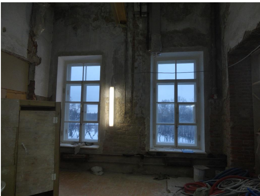
13. «Гатчинский дворец (с Арсенальным и Кухонным каре)», Ленинградская область, Гатчинский муниципальный район, г. Гатчина, Красноармейский пр., д. 1. Арсенальное каре. 3 этаж. Помещение №2. Фрагмент. Фото 01.12.2021г.
