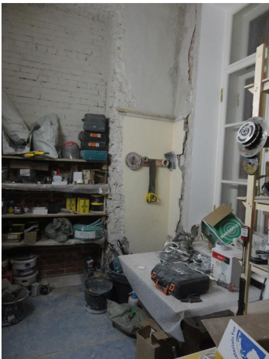
4. «Гатчинский дворец (с Арсенальным и Кухонным каре)», Ленинградская область, Гатчинский муниципальный район, г. Гатчина, Красноармейский пр., д. 1. Арсенальное каре. 3 этаж. Помещение №1. Фрагмент. Фото 01.12.2021г.
