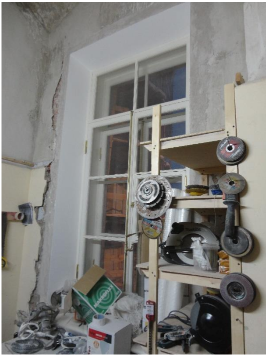
7. «Гатчинский дворец (с Арсенальным и Кухонным каре)», Ленинградская область, Гатчинский муниципальный район, г. Гатчина, Красноармейский пр., д. 1. Арсенальное каре. 3 этаж. Помещение №1. Фрагмент. Фото 01.12.2021г.
