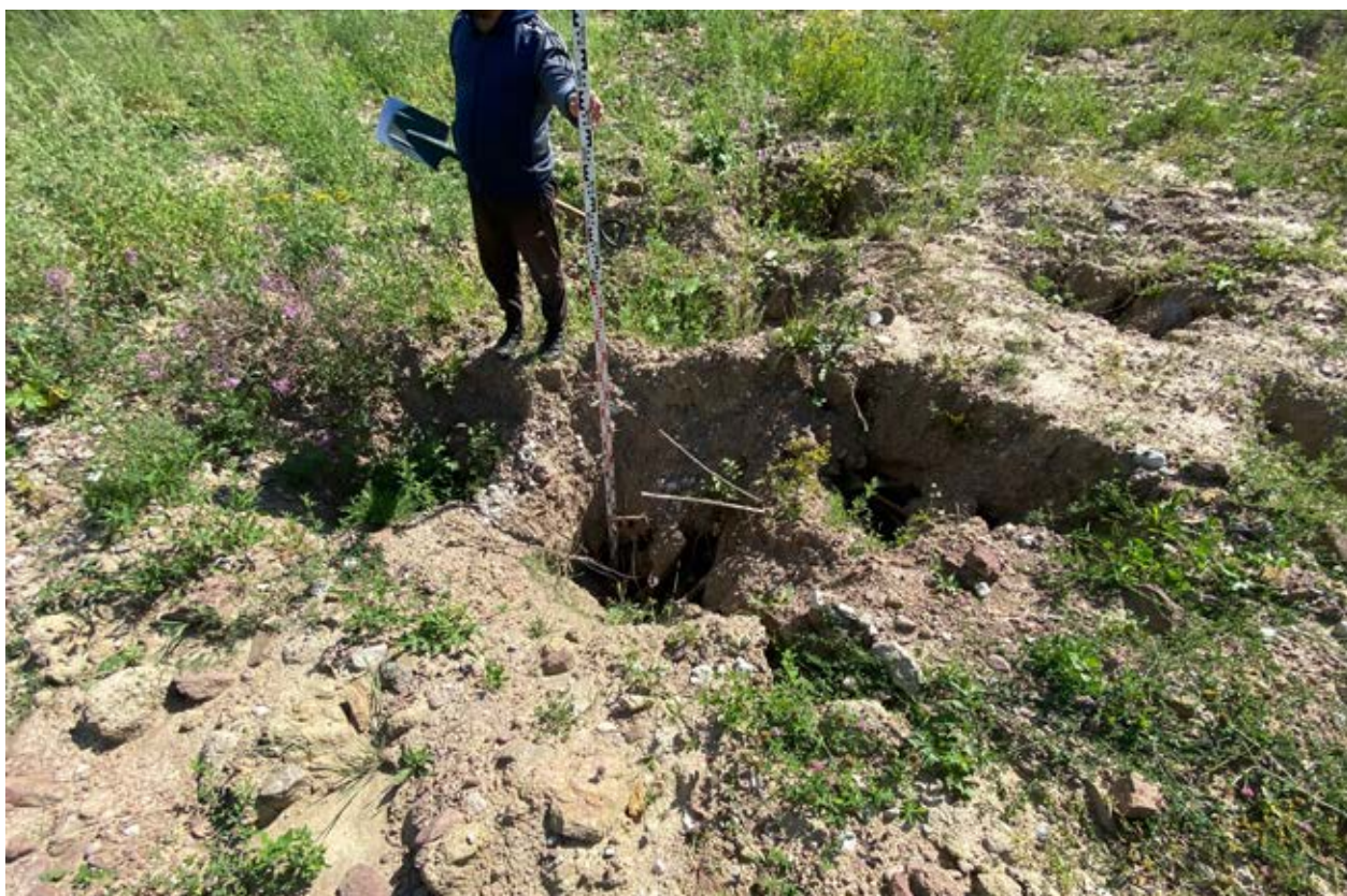
Илл. 23. Ленинградская область. Кингисеппский муниципальный район. Объект археологических исследований. Точка фото-фиксации №8. Участок перехода через р. Луга, разрушение (промывы) насыпного грунта. Вид с севера.
