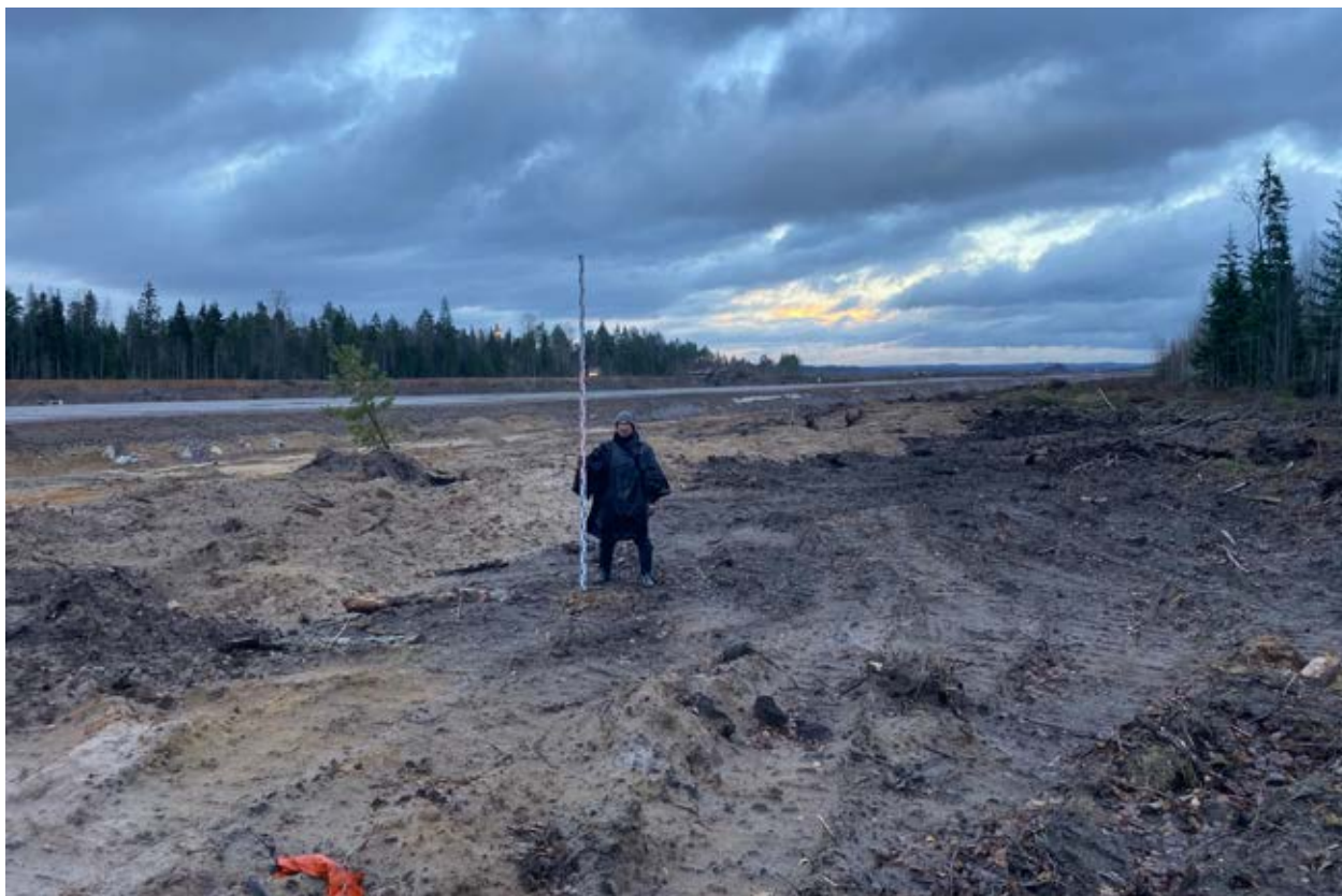
Илл. 48. Ленинградская область. Кингисеппский муниципальный район. Объект археологических исследований. Точка фото-фиксации №57. Площадное вскрытие грунта (расторфовка), на участке пересечения обследованного земельного отвода и строящейся автомобильной дороги. Вид с запада.
