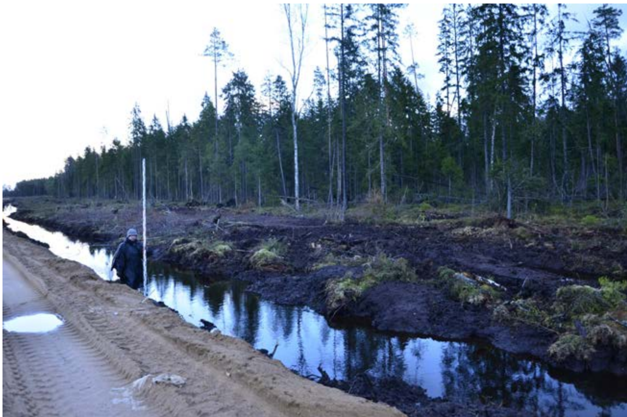
Илл. 46. Ленинградская область. Кингисеппский муниципальный район. Объект археологических исследований. Точка фото-фиксации №55. Площадное вскрытие грунта (расторфовка), на участке пересечения обследованного земельного отвода и строящейся автомобильной дороги. Вид с запада.
