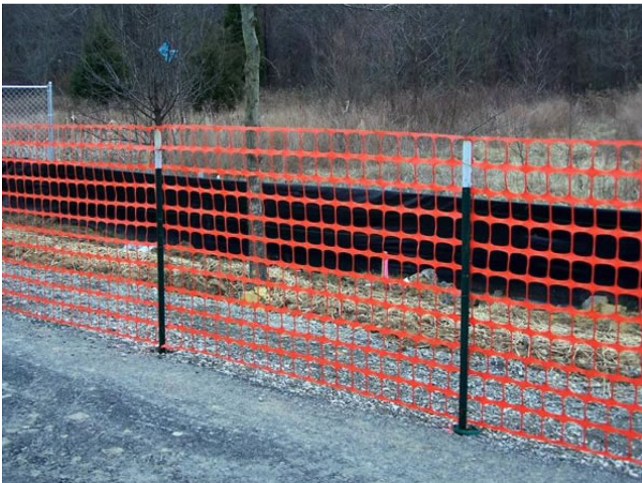
Ограждение объекта культурного наследия (пример выполнения).
