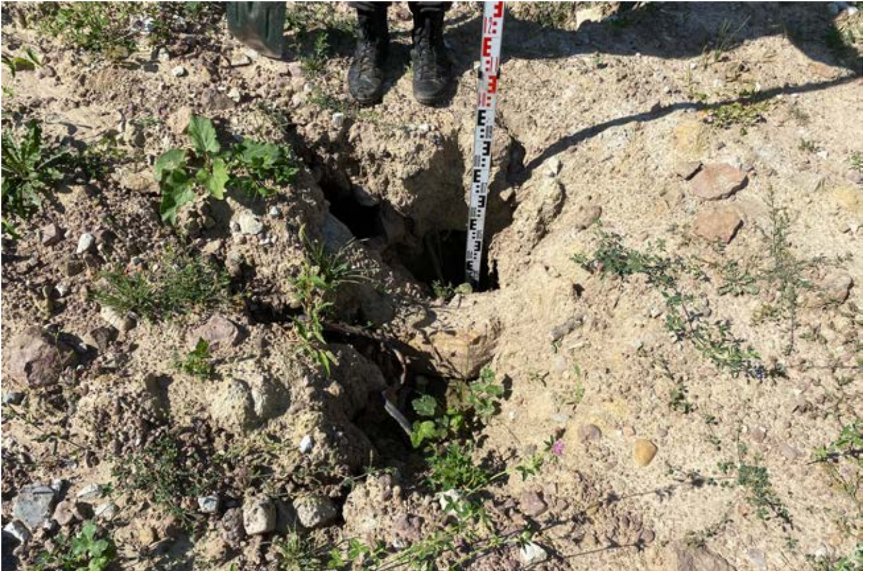
Илл. 24. Ленинградская область. Кингисеппский муниципальный район. Объект археологических исследований. Точка фото-фиксации №9. Участок перехода через р. Луга, разрушение (промывы) насыпного грунта. Вид с востока.
