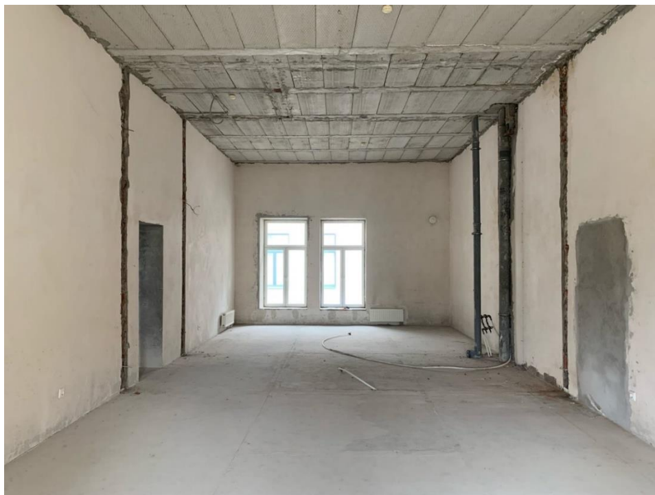
Фото 15. Общий вид помещения № 7. Вид с юго-западной стороны.
