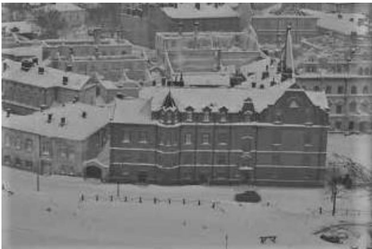
Илл. 22. Исследуемое здание. Фото (копия) 30.01.1942 г.
