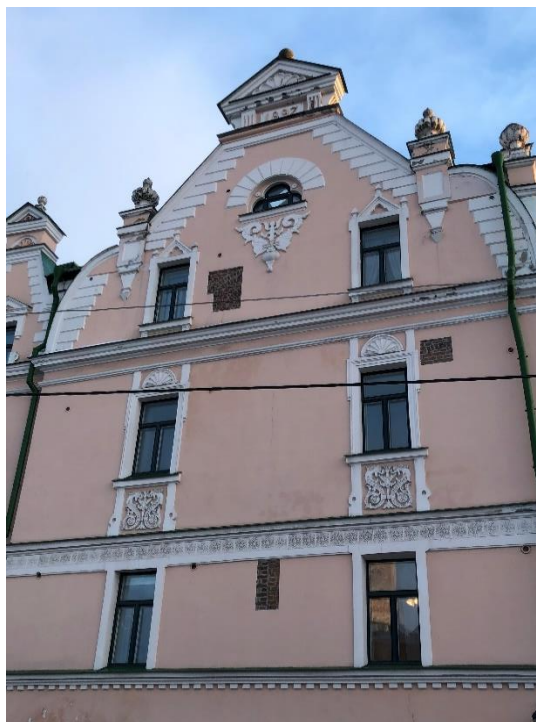
Фото 3. Фрагмент лицевого фасада здания по ул. Северный Вал (соответствующий помещениям Заказчика).
