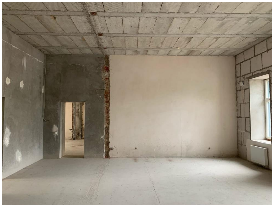
Фото 9. Общий вид помещения № 4 с северо-западной стороны.
