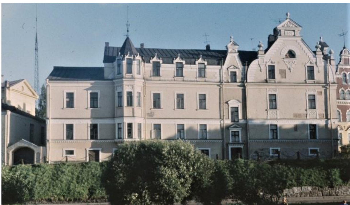
Илл. 29. Северо-западный фасад здания. Фото (копия) Ю. Ланкинена 1988 г.
