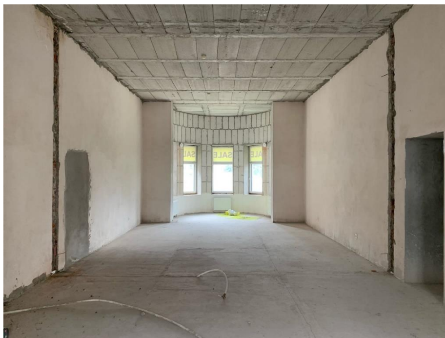
Фото 14. Общий вид помещения № 7. Вид с северо-восточной стороны.
