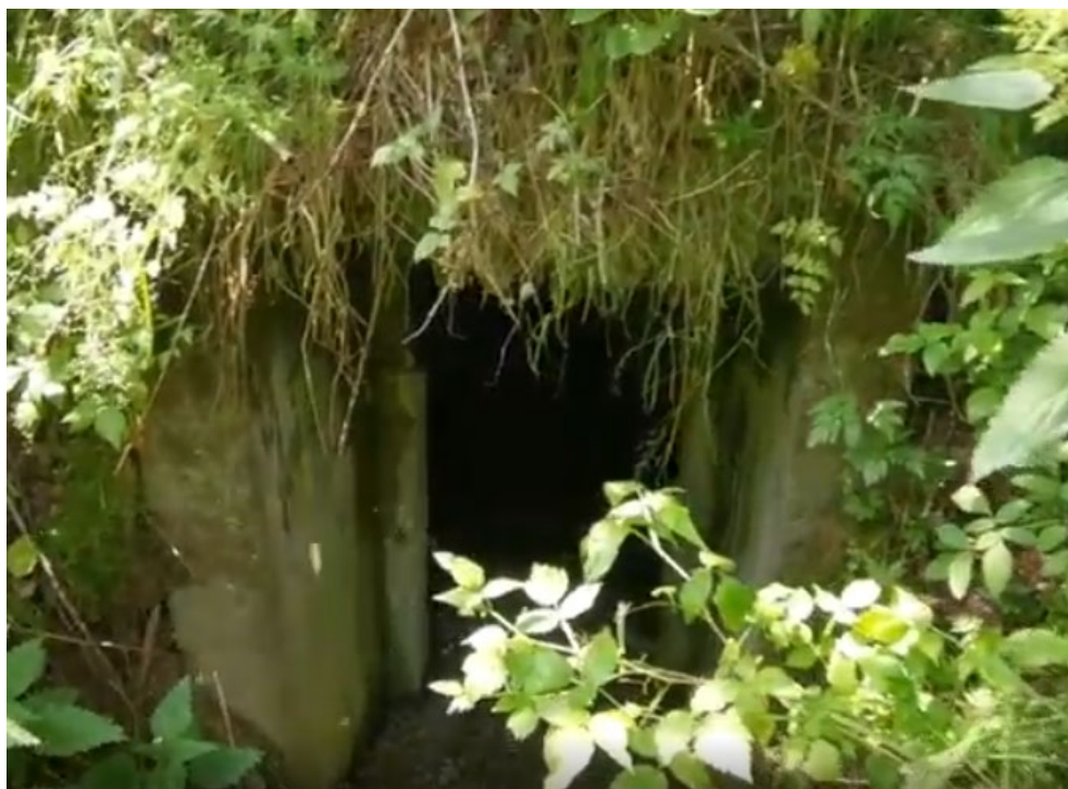
3. Вид на вход в ДОТ. Фото 26.05.22.
