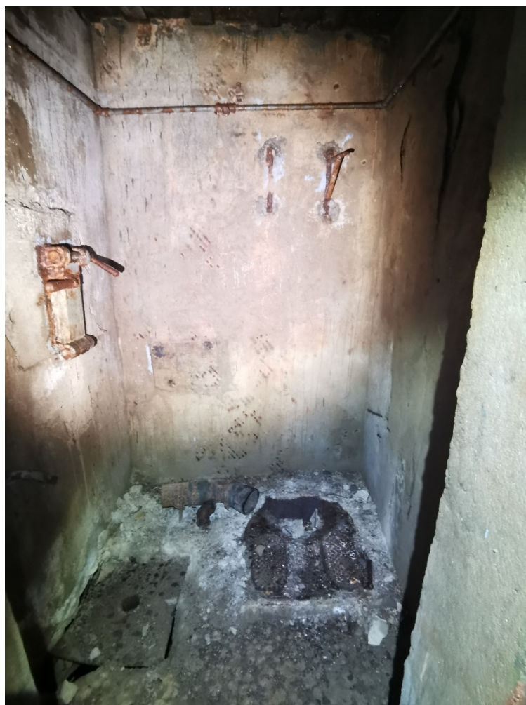
4. Интерьер ДОТа: помещение с ружейной амбразурой обороны входа, фрагментами оборудования. Фото: 08.11.21.
