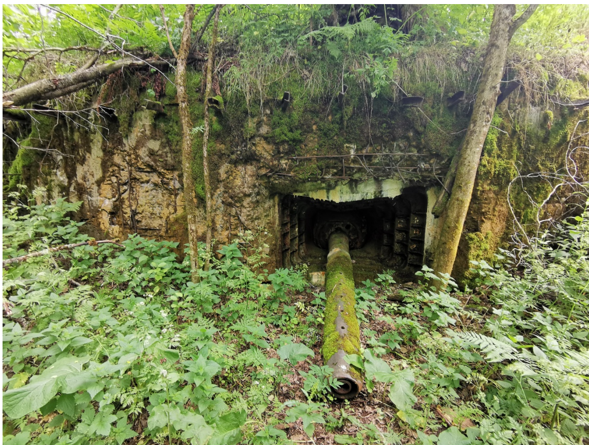
1. Общий вид сооружения со стороны амбразуры с орудием ЗИФ-26 в бронированной установке. Фото 26.05.22
