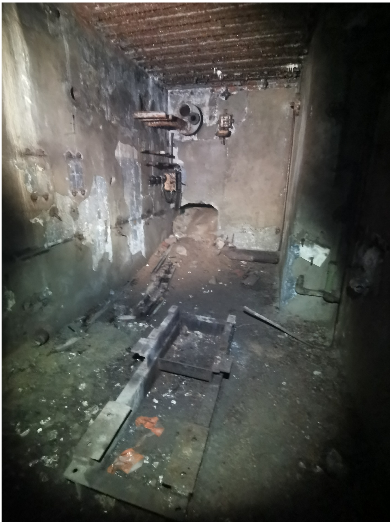
5. Интерьер ДОТа: помещение с фрагментами оборудования. Фото: 08.11.21.
