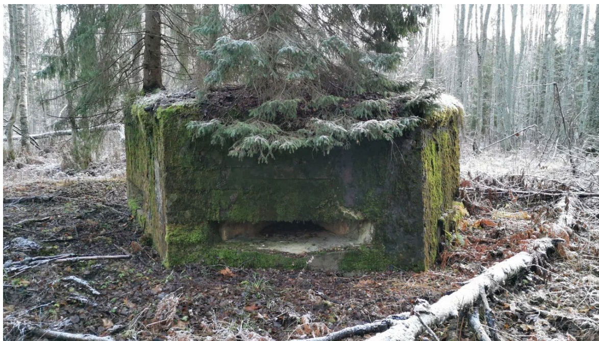
2. Вид на ДОТ со стороны амбразур. ДОТ № 64.
