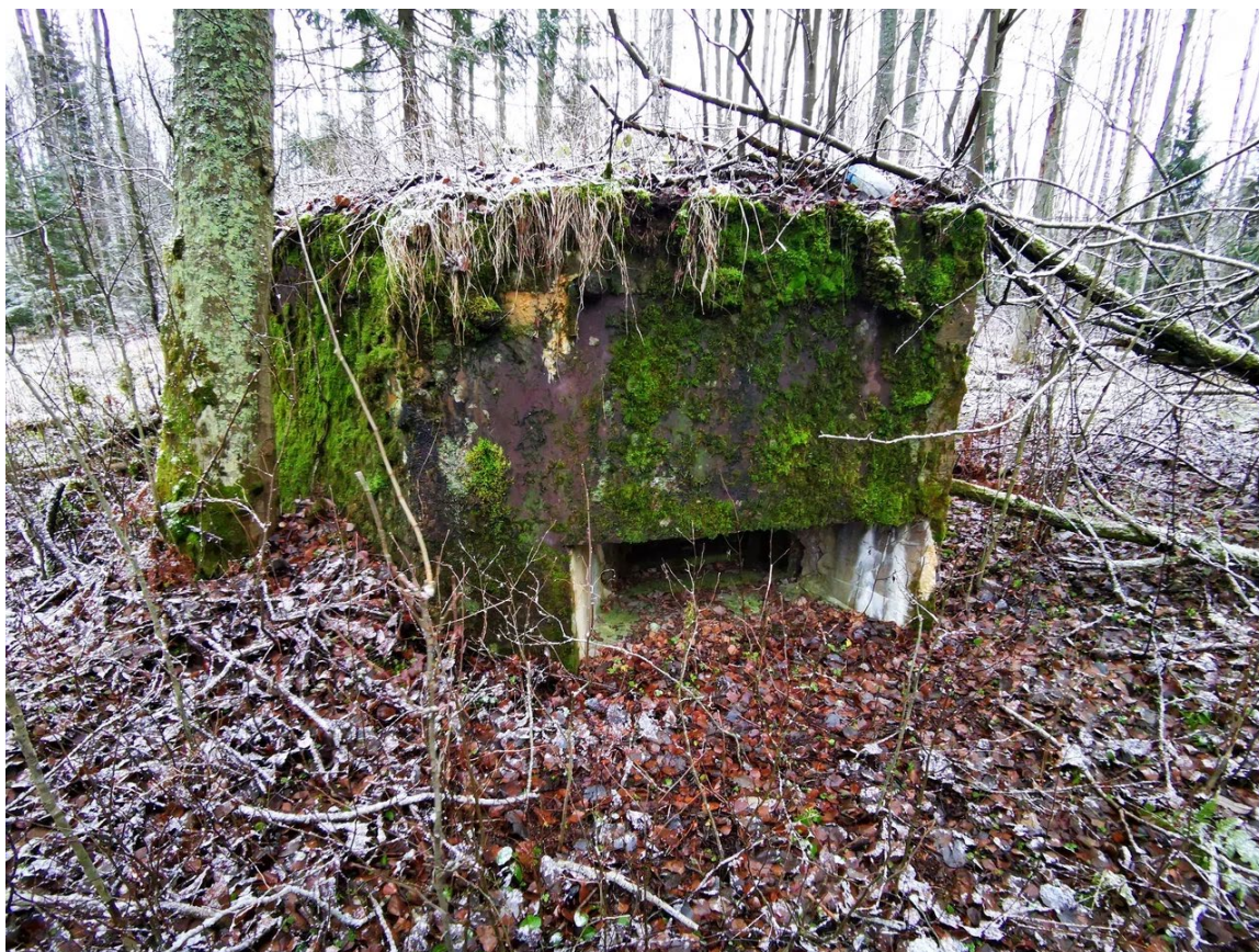
1. Вид на ДОТ со стороны амбразур. ДОТ № 64.
