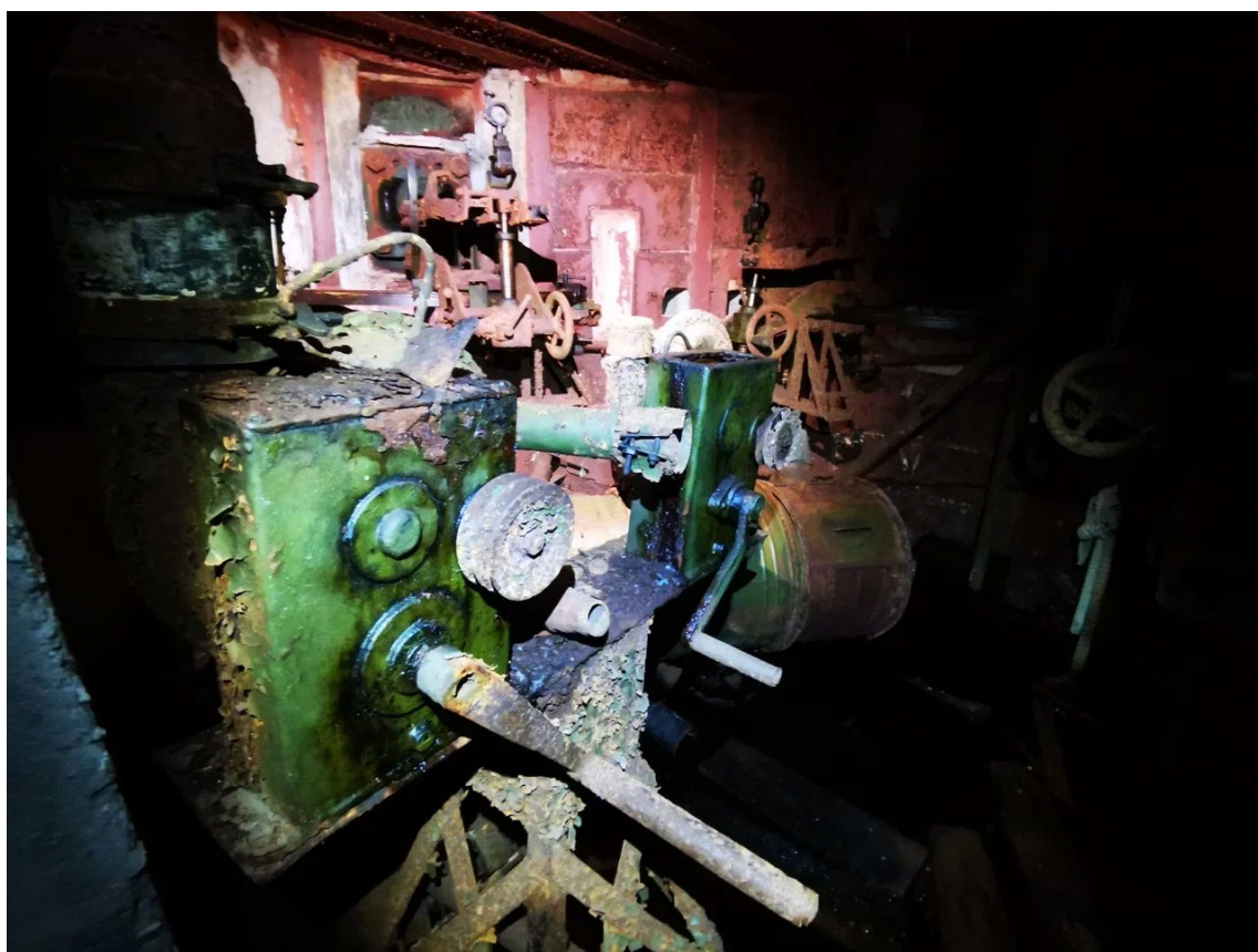
4. Сохранившиеся фрагменты фильтровентиляционной установки в ДОТ №65.
