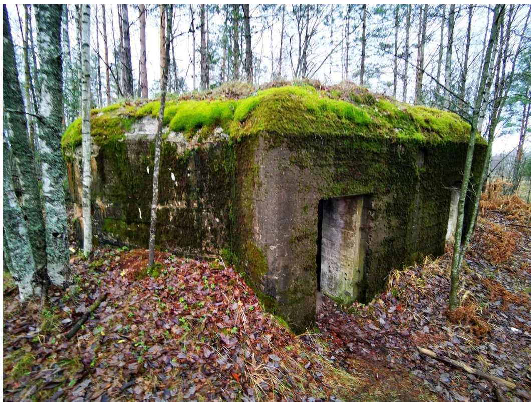
3. Общий вид сооружения с тыла. ДОТ № 640.
