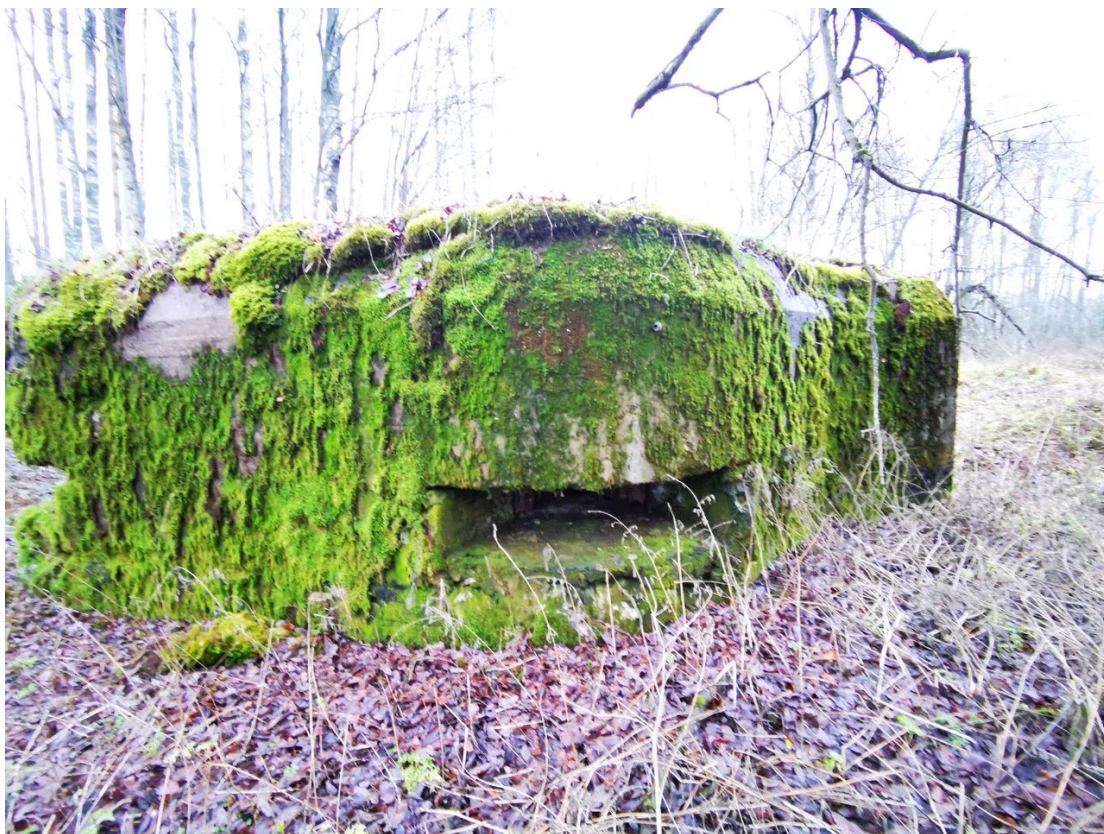
3. Вид на сооружение с угла. ДОТ № 627.
