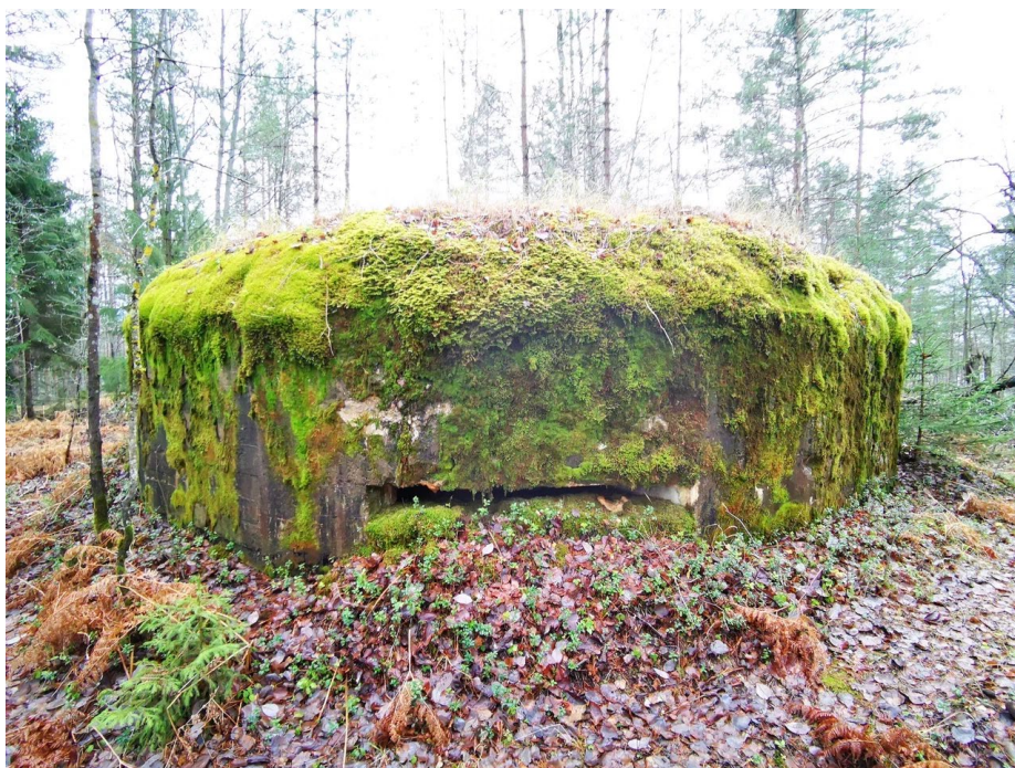
1. Общий вид сооружения с фронта. ДОТ № 640.
