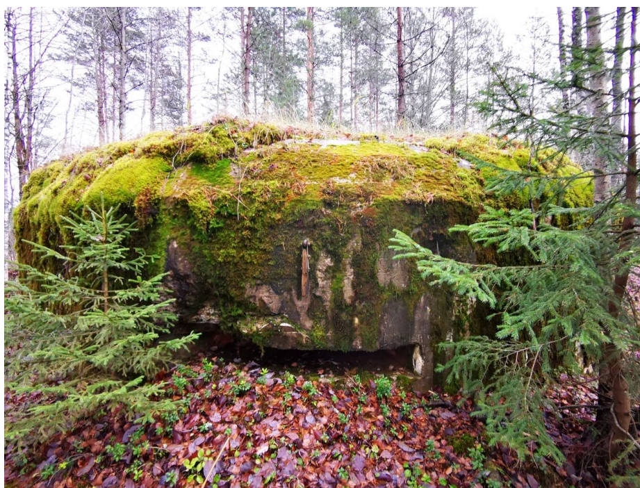
2. Общий вид сооружения с фронта. ДОТ № 640.
