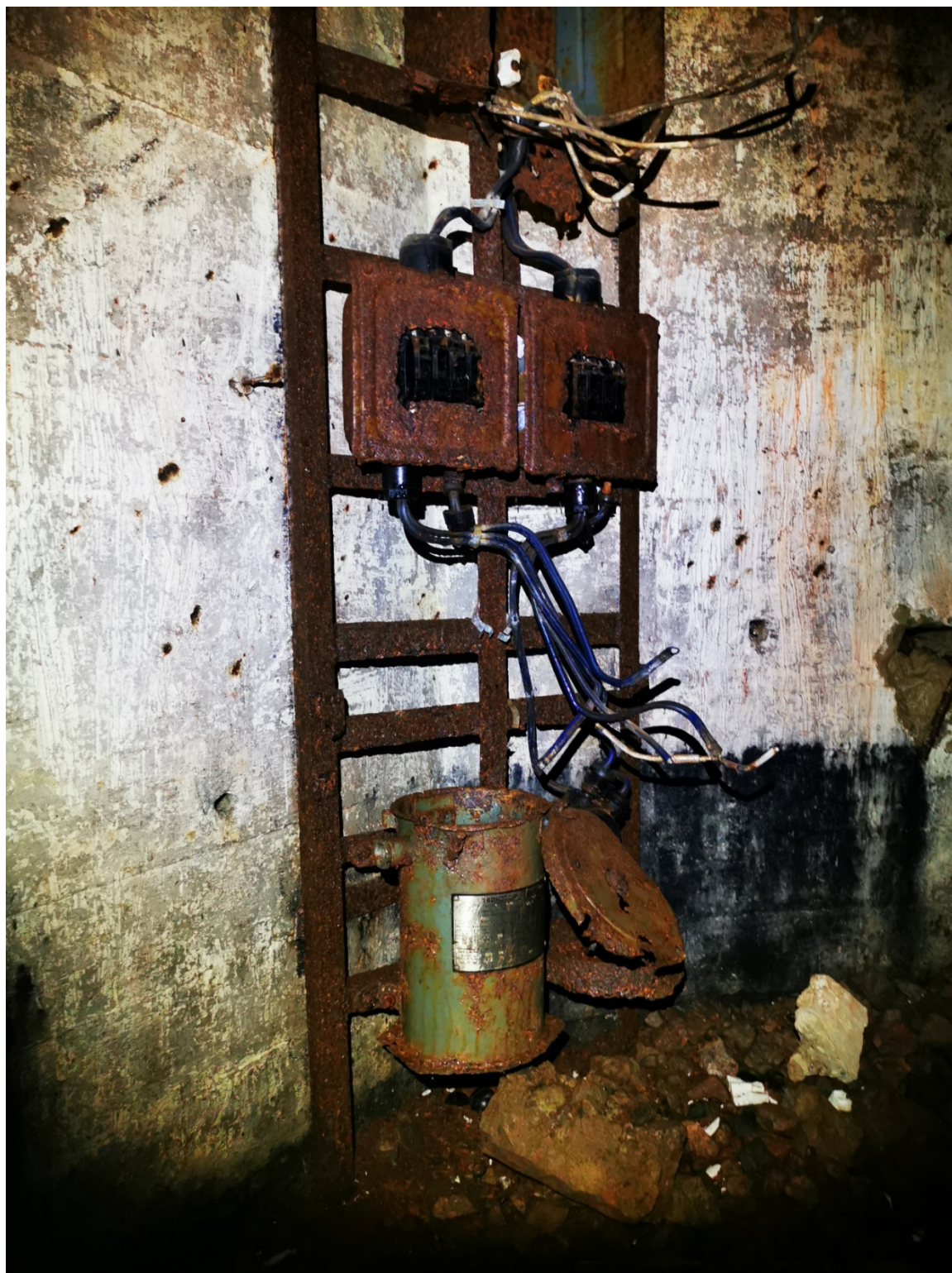
6. Интерьер боевого каземата. Фрагменты оборудования. (Фото: 19.05.22)
