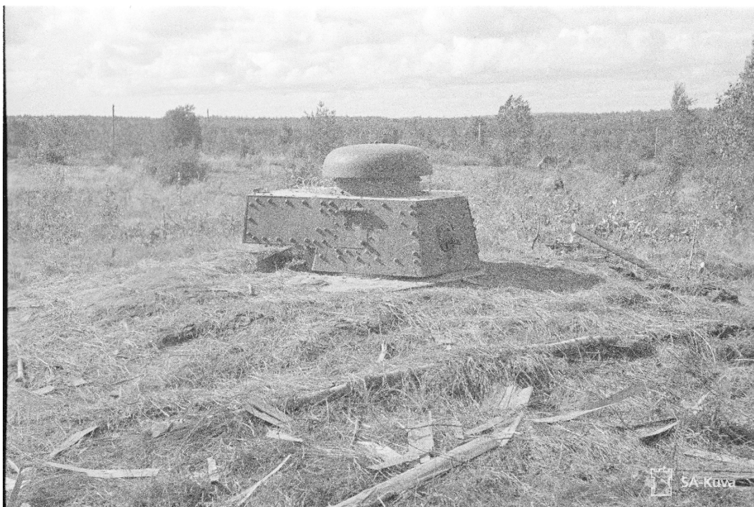
Захваченная финнами танковая огневая точка на базе танка МС-1 на передовом рубеже Карельского укрепленного района. Сентябрь 1941 года. Фото сделано финскими военными корреспондентами.
