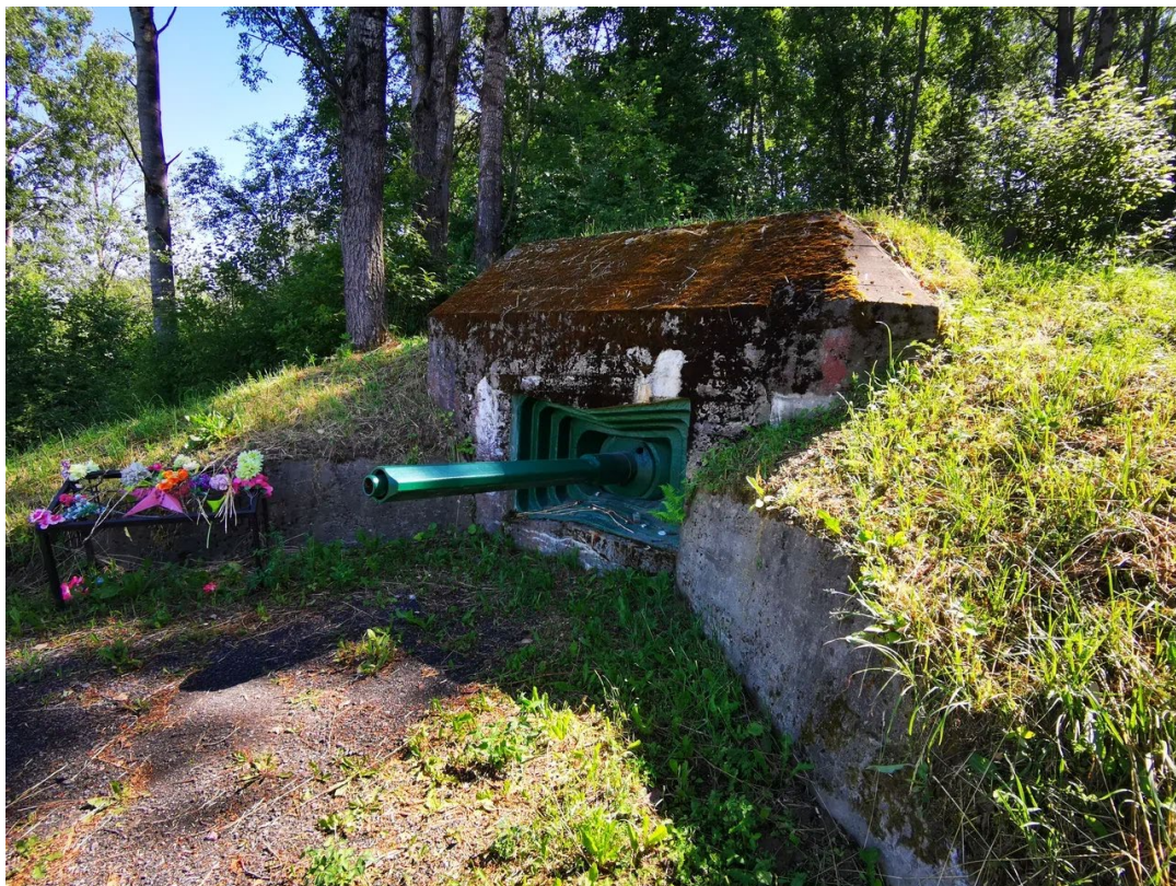
2. Общий вид на ДОТ с северо-запада. Сооружение закрыто и внутренняя съёмка невозможна. Фото: 19.05.22
