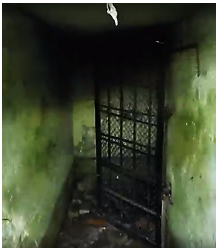
3. Вид на вход в АДОН с противоштурмовой решетчатой дверью. Фото: 08.11.21
