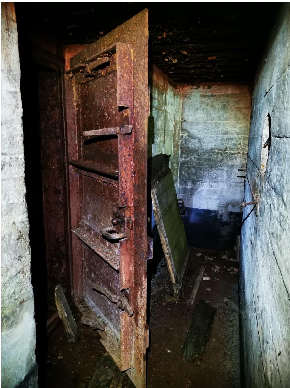
5. Интерьер ДОТ. Коленчатый сквозник и бронированная дверь. (Фото: 08.11.21)
