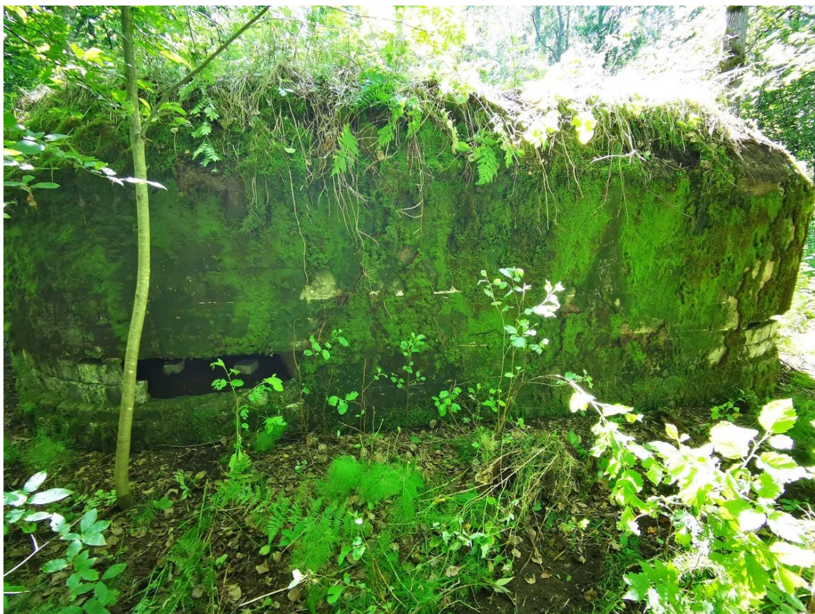
2. Общий вид ДОТ со стороны амбразур. (Фото: 19.05.22)
