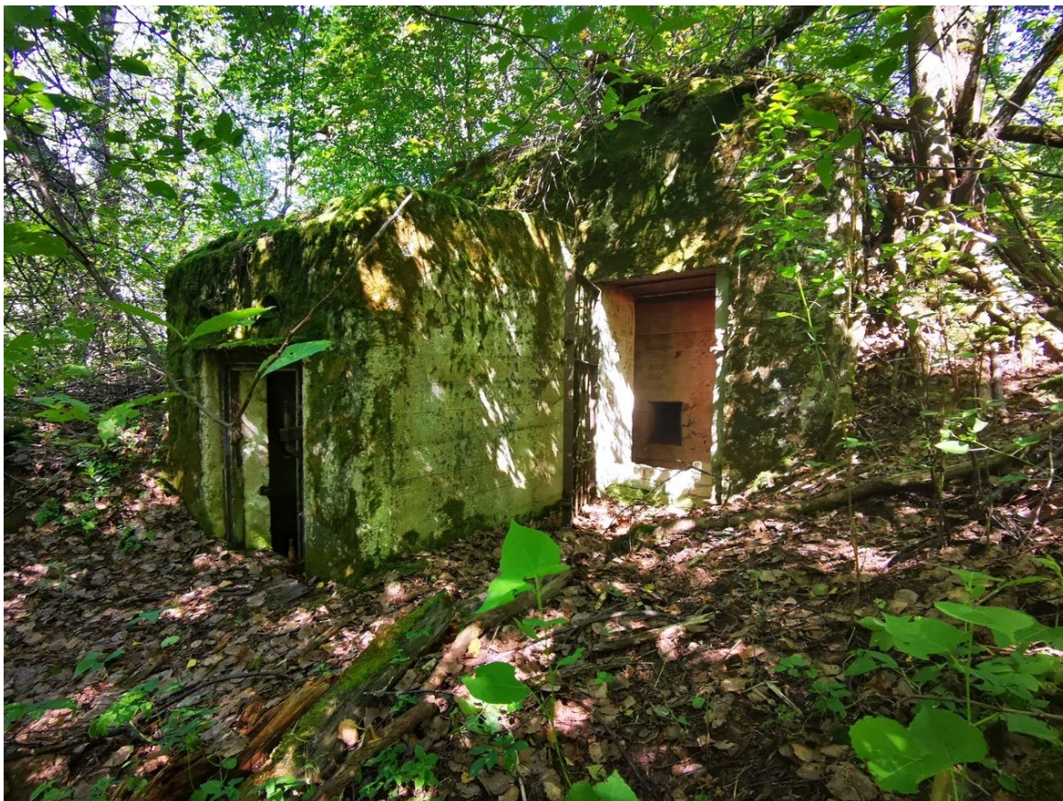
1. Вид на сооружение со стороны входа. Решетчатая дверь, ружейная амбразура обороны входа. (Фото: 19.05.22)
