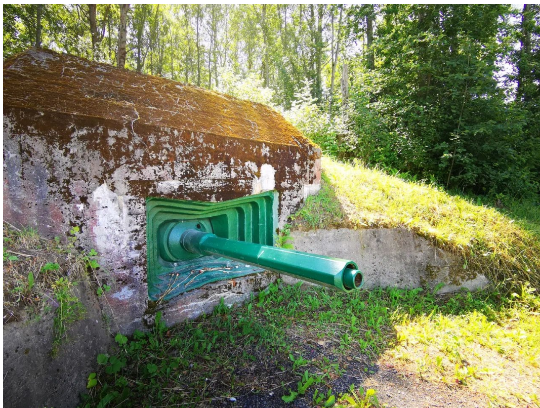
1. Общий вид на ДОТ с северо-востока. Фото: 19.05.22
