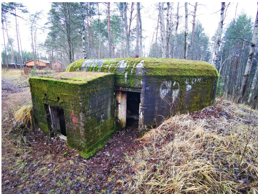
1. Вход в сооружение
