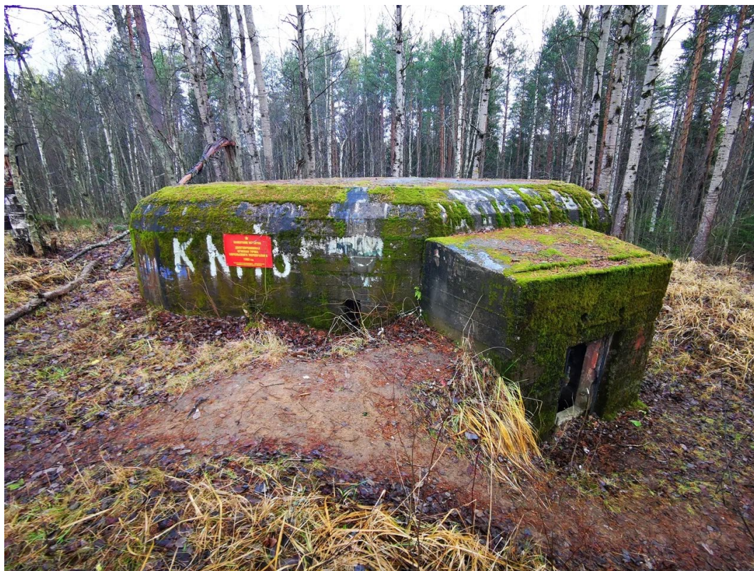
2. Вход в сооружение
