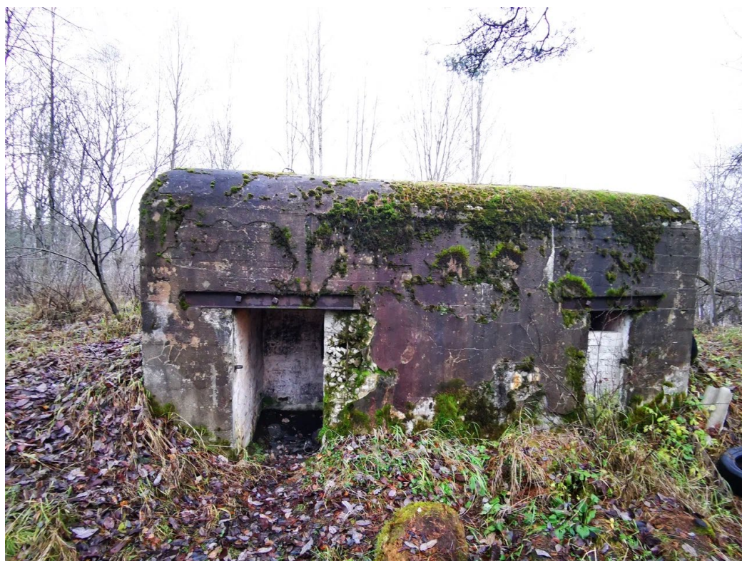
1. Вид на сооружение с тыла
