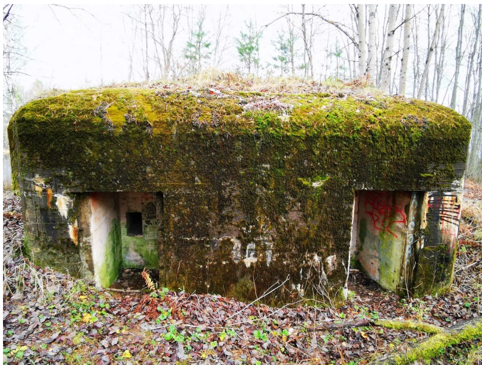
1. Вход в сооружение
