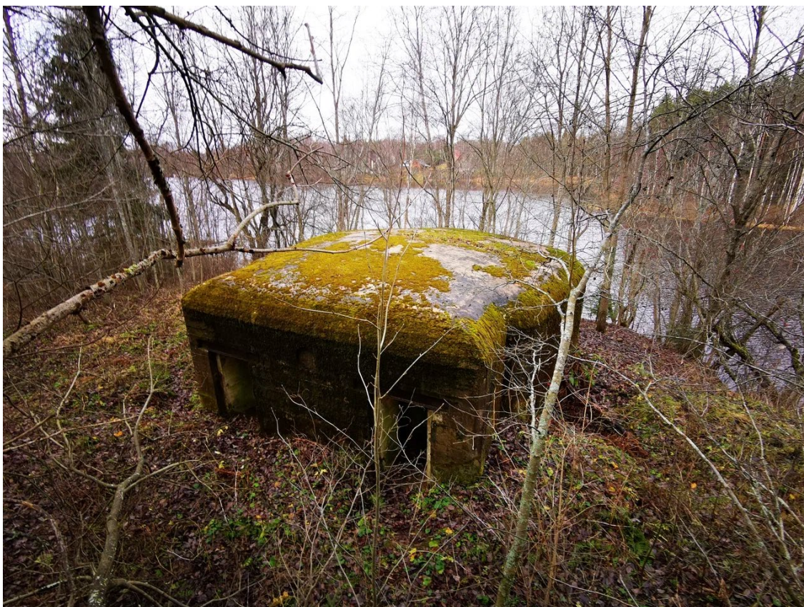
1. Вид на сооружение с тыла
