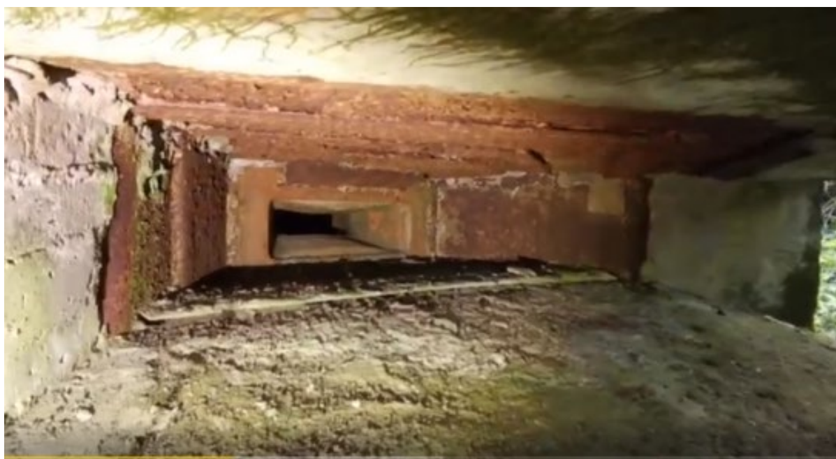
6. Вид на амбразуры ДОТ № 975 изнутри. Фото: 26.05.22
