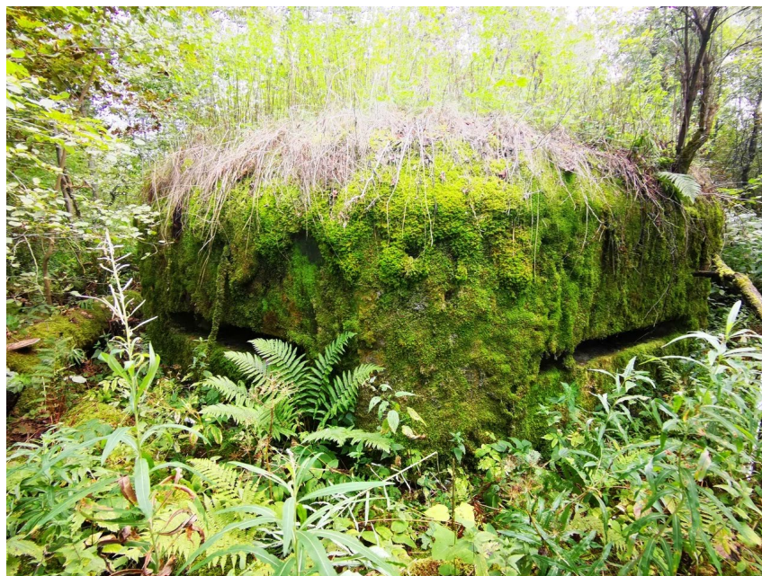
2. Вид на сооружение со стороны амбразур. Фото: 26.05.22
