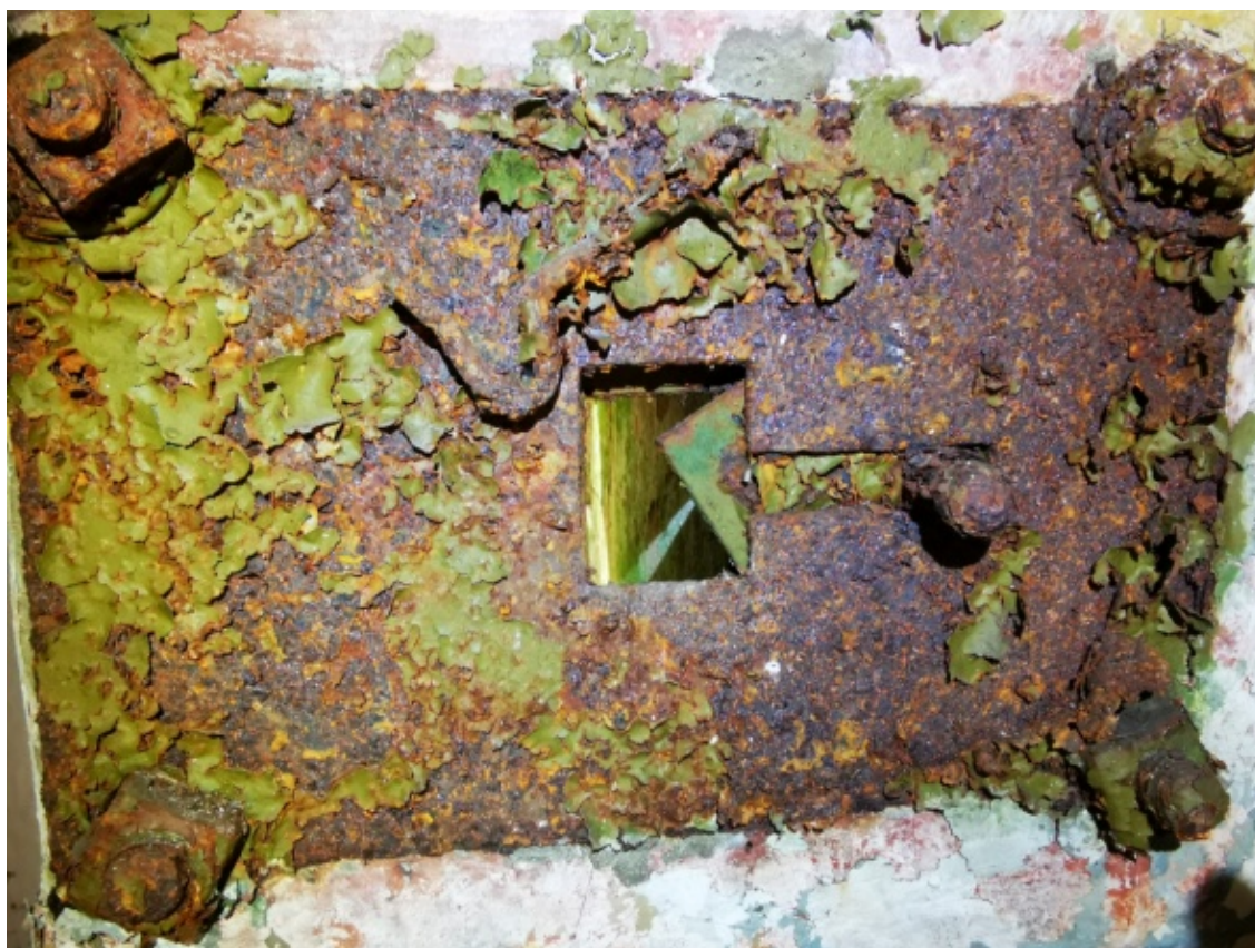
8. Бронезаслонка ружейных амбразур обороны входа. ДОТ № 975. Фото: 26.05.22
