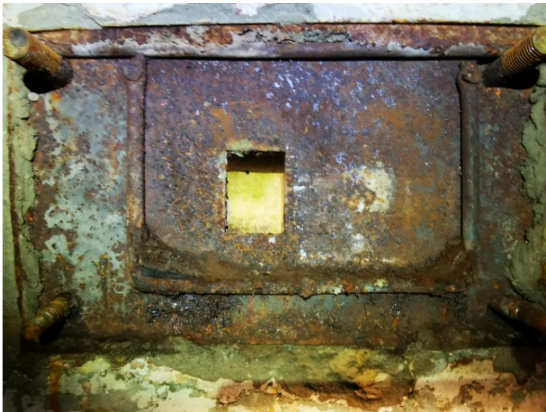
9. Бронезаслонка ружейных амбразур обороны входа. ДОТ № 975. Фото: 26.05.22
