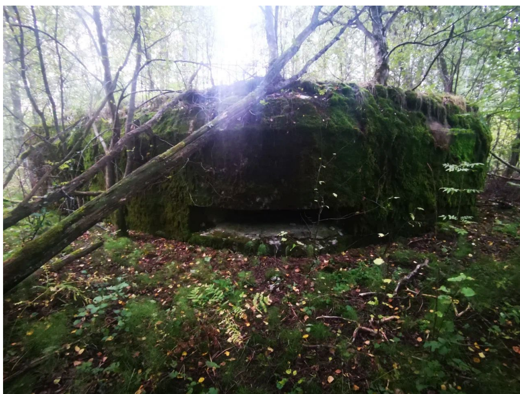
2. Общий вид ДОТ № 951 со стороны амбразур. Фото: 26.05.22
