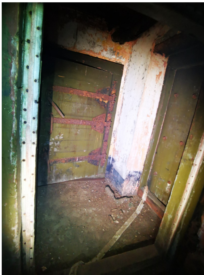
7. Интерьер ДОТ№ 951. Вид тамбура. Фото: 08.11.21
