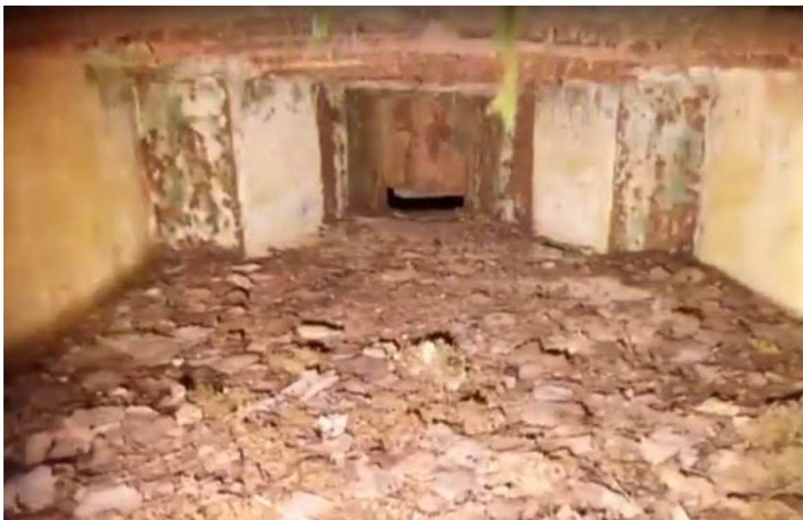
7. Вид на амбразуры ДОТ № 975 изнутри. Фото: 26.05.22
