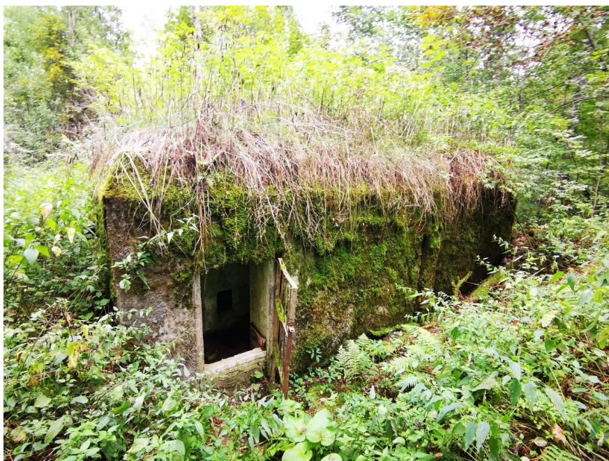
1. Вид на сооружение с тыла. Фото: 26.05.22
