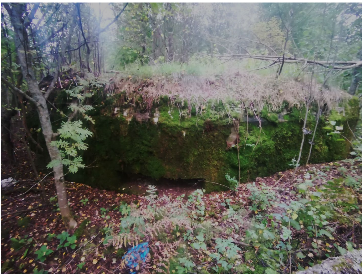
3. Общий вид ДОТ № 951 со стороны амбразуры. Фото: 26.05.22
