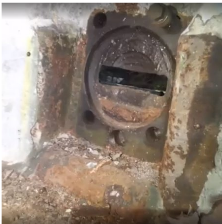
10. Интерьер ДОТ № 951. Броневая плита (заслон) пулеметной амбразуры. Фото: 08.11.21
