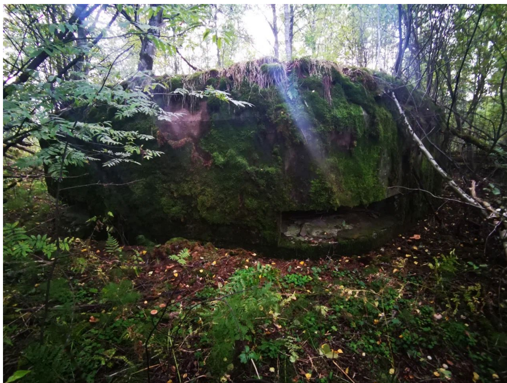
1. Общий вид ДОТ № 951 со стороны амбразур. Фото: 26.05.22
