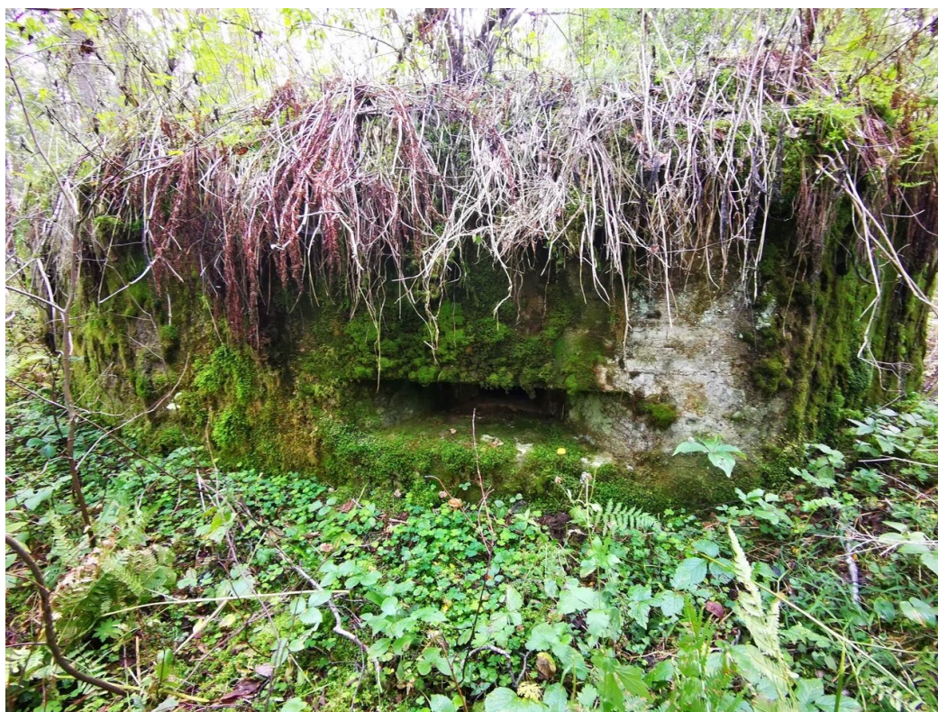
1. Вид на ДОТ со стороны амбразур (Фото: 19.05.22)
