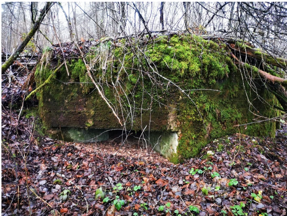
4. Вид на ДОТ со стороны амбразур (Фото 08.11.21)
