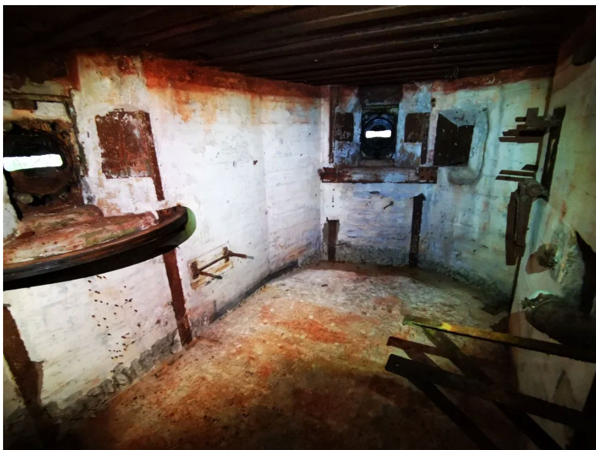
3. Боевое отделение ДОТ с частично сохранившимися амбразурными узлами (Фото: 19.05.22)
