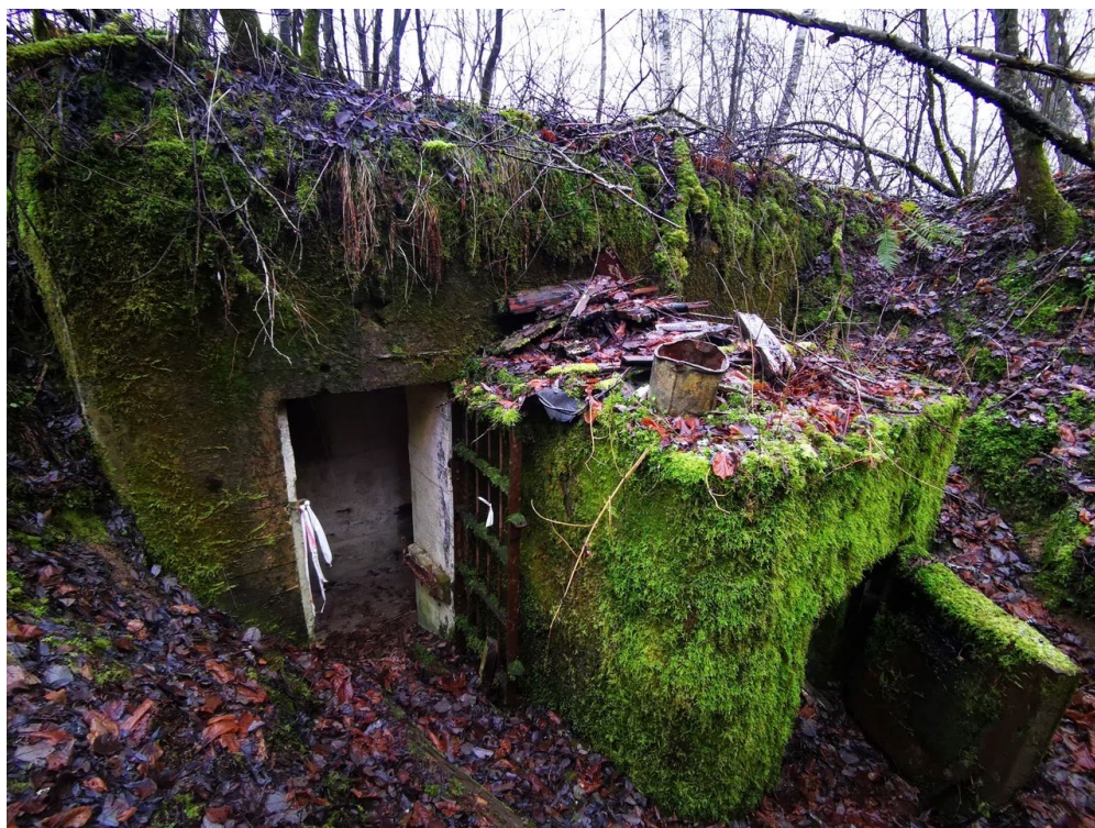
1. Вид на ДОТ с тыльной части (Фото 08.11.21)
