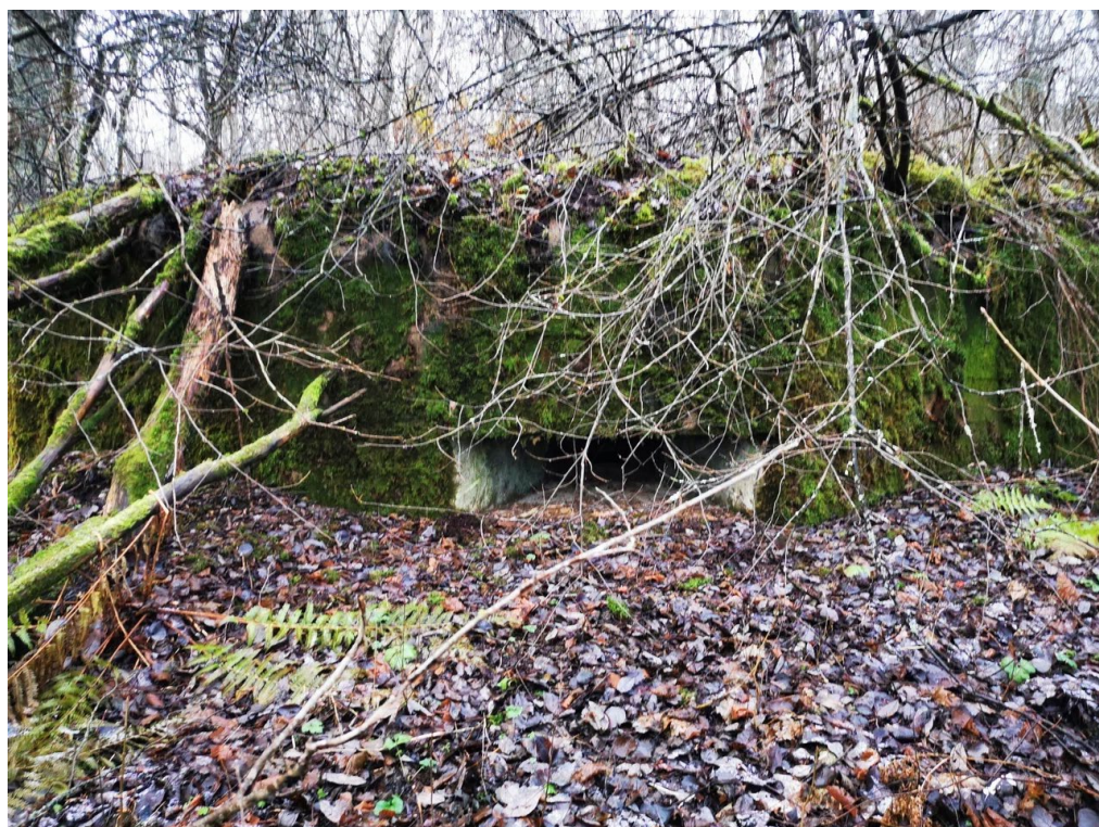
3. Вид на ДОТ со стороны амбразур (Фото 08.11.21)
