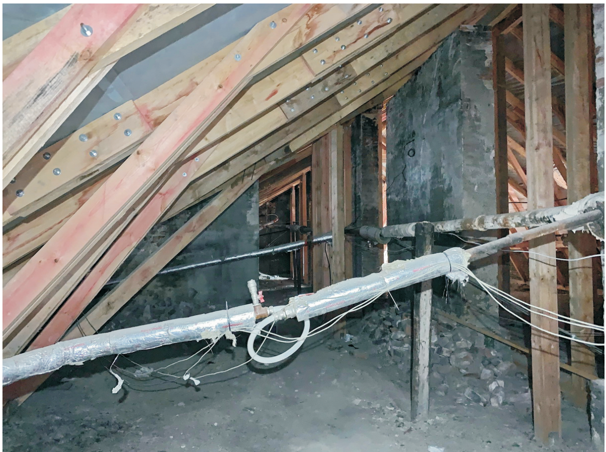
32 ОКН регионального значения “Жилой дом” Ленинградская область, Выборгский муниципальный район, г. Выборг, ул. Железнодорожная, д. 4. Чердак. Дата съемки: 02.05.2022 г.
