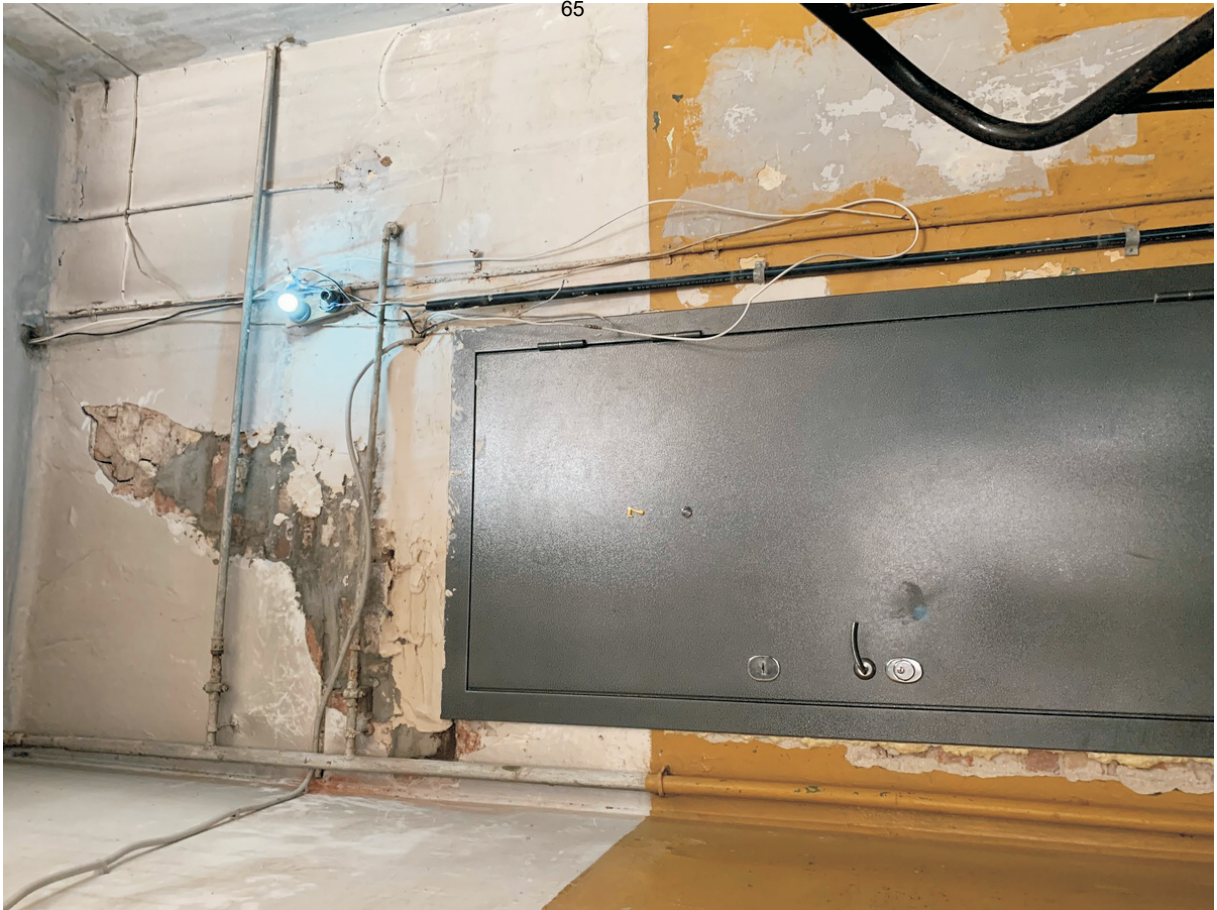
27 ОКН регионального значения “Жилой дом” Ленинградская область, Выборгский муниципальный район, г. Выборг, ул. Железнодорожная, д. 4. Подъезд № 3. Лестничная клетка. 3 этаж. Дата съемки: 02.05.2022 г.
