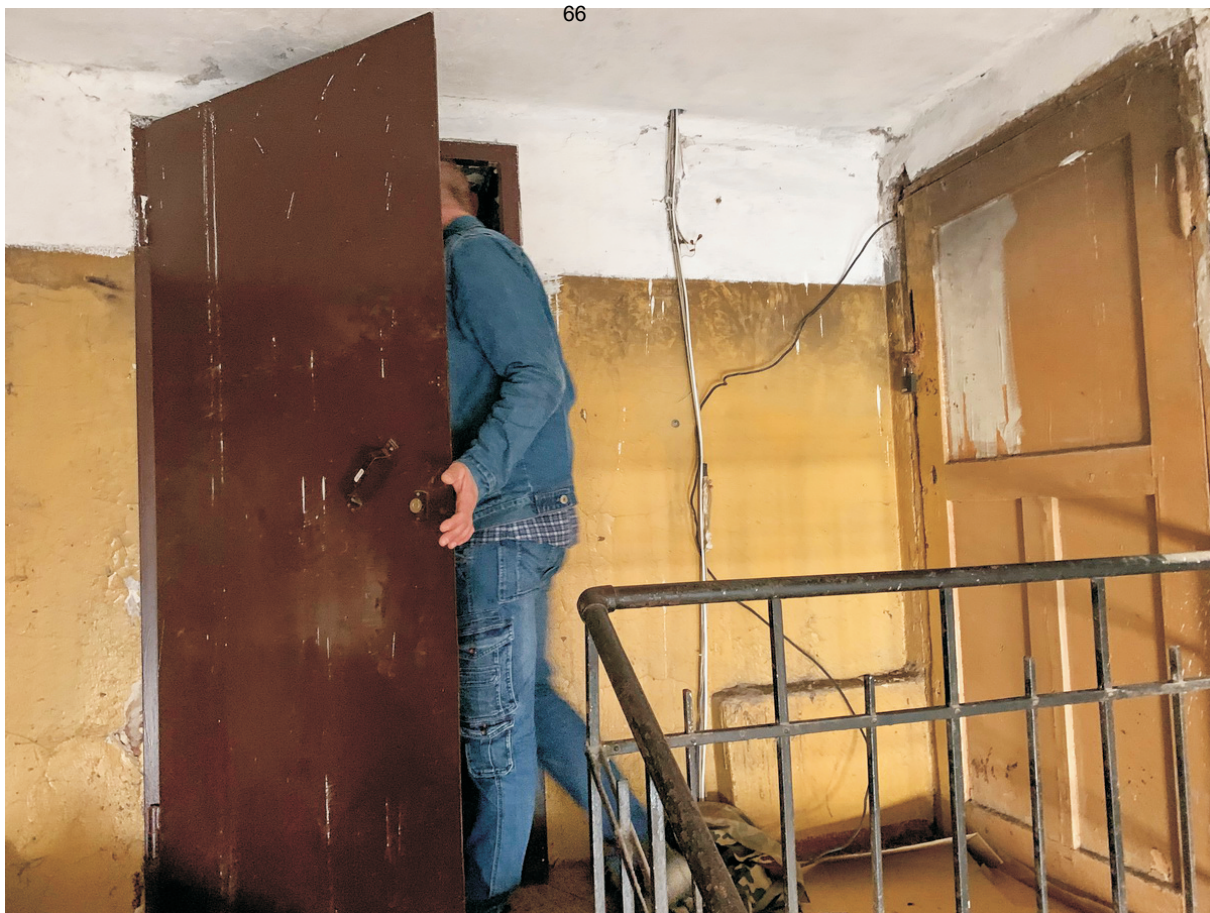
29 ОКН регионального значения “Жилой дом” Ленинградская область, Выборгский муниципальный район, г. Выборг, ул. Железнодорожная, д. 4. Подъезд № 3. Выход на чердак. Дата съемки: 02.05.2022 г.
