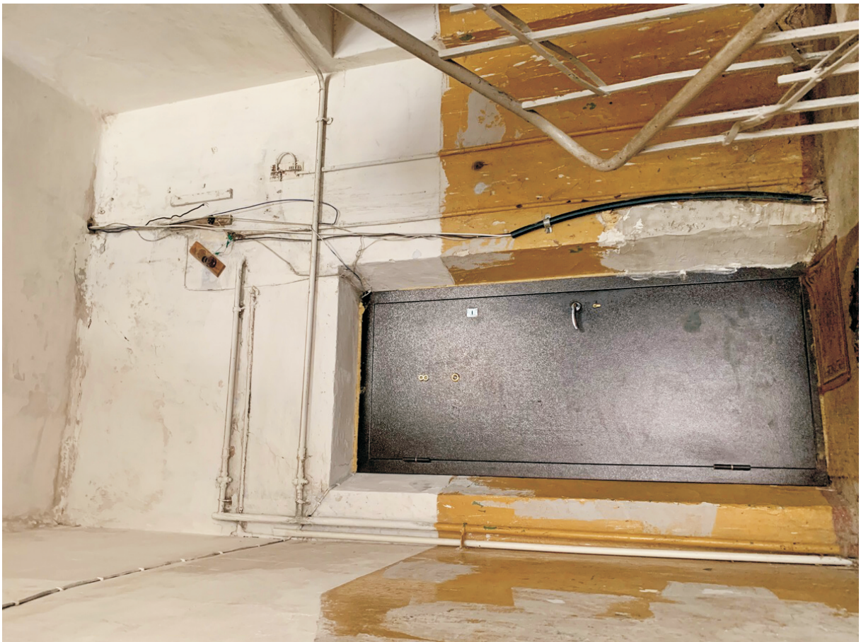
28 ОКН регионального значения “Жилой дом” Ленинградская область, Выборгский муниципальный район, г. Выборг, ул. Железнодорожная, д. 4. Подъезд № 3. Лестничная клетка. 4 этаж. Дата съемки: 02.05.2022 г.
