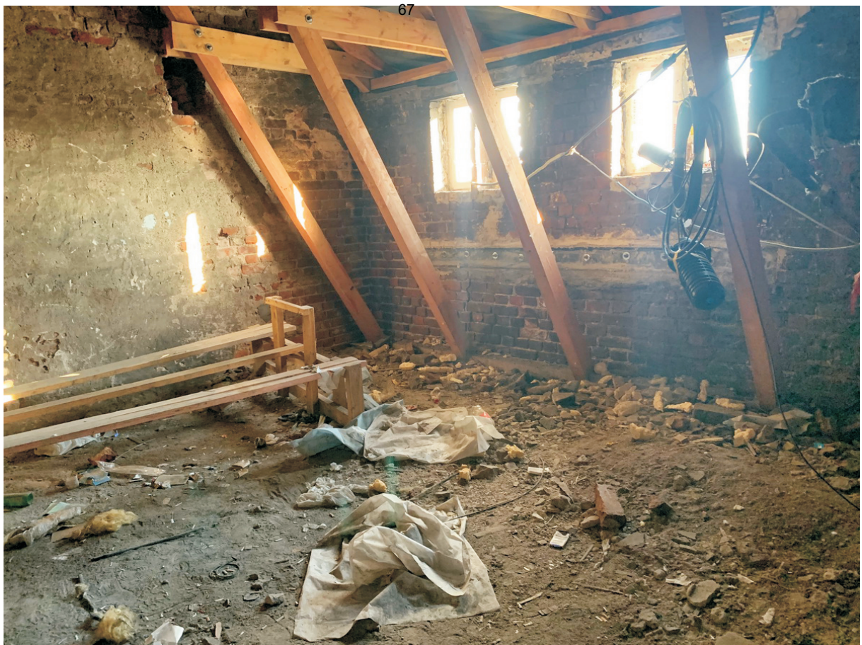
31 ОКН регионального значения “Жилой дом” Ленинградская область, Выборгский муниципальный район, г. Выборг, ул. Железнодорожная, д. 4. Чердак. Дата съемки: 02.05.2022 г.
