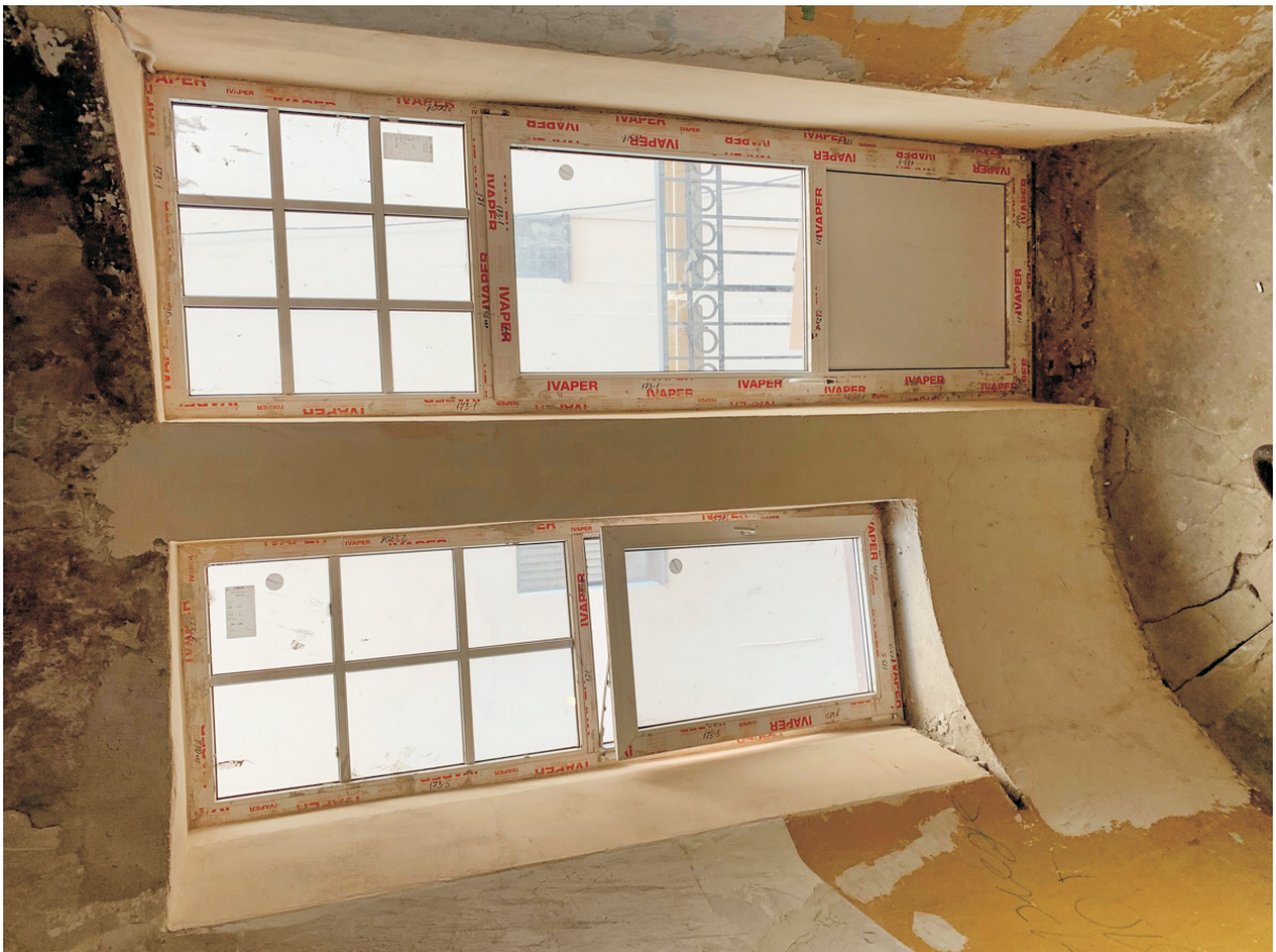
26 ОКН регионального значения “Жилой дом” Ленинградская область, Выборгский муниципальный район, г. Выборг, ул. Железнодорожная, д. 4. Подъезд № 3. Лестничная клетка. Площадка между 2 и 3 этажами. Дата съемки: 02.05.2022 г.
