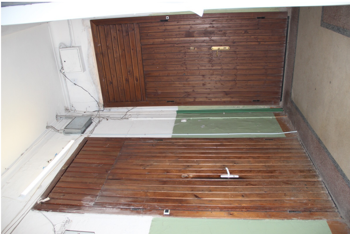
28 ОКН регионального значения “Жилой дом с магазинами Массинена” Ленинградская область, Выборгский муниципальный район, г. Выборг, Ленинградское ш., д. 15. Подъезд № 3. Лестничная клетка. 2 этаж. Дата съемки: 02.05.2022 г.
