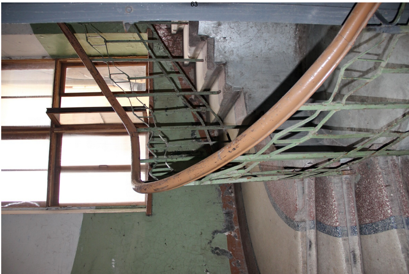
27 ОКН регионального значения “Жилой дом с магазинами Массинена” Ленинградская область, Выборгский муниципальный район, г. Выборг, Ленинградское ш., д. 15. Подъезд № 3. Лестничная клетка. Междуэтажная площадка между 1 и 2 этажами. Дата съемки: 02.05.2022 г.
