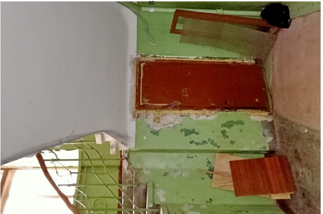
21 ОКН регионального значения “Жилой дом с магазинами Массинена” Ленинградская область, Выборгский муниципальный район, г. Выборг, Ленинградское ш., д. 15. Подъезд № 2. Лестничная клетка. Вид на междуэтажную площадку между 1 и 2 этажами. Дата съемки: 02.05.2022 г.
