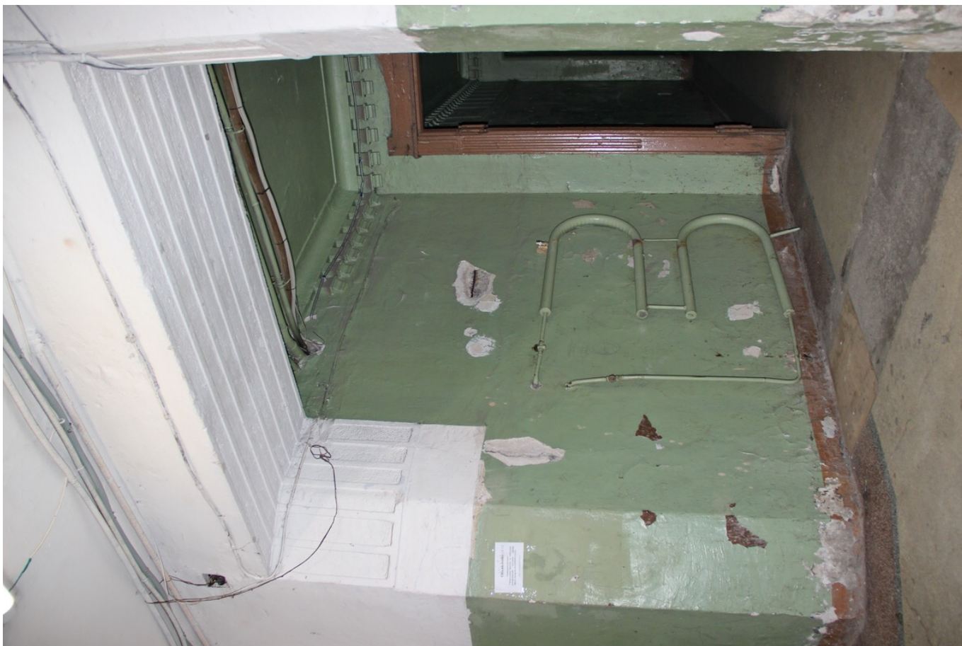
26 ОКН регионального значения “Жилой дом с магазинами Массинена” Ленинградская область, Выборгский муниципальный район, г. Выборг, Ленинградское ш., д. 15. Подъезд № 3. Входной тамбур. 1 этаж. Дата съемки: 02.05.2022 г.
