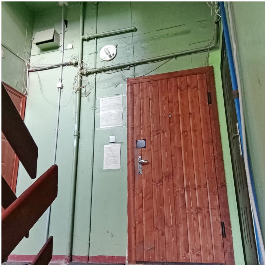
46 ОКН регионального значения “Жилой дом с магазинами Массинена” Ленинградская область, Выборгский муниципальный район, г. Выборг, Ленинградское ш., д. 15. Подъезд № 5. Лестничная клетка. 5 этаж. Дата съемки: 02.05.2022 г.
