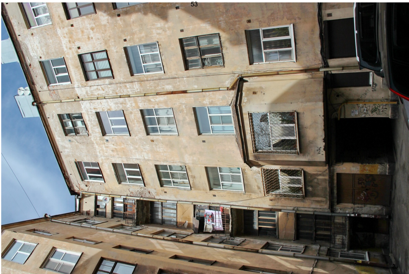
7 ОКН регионального значения “Жилой дом с магазинами Массинена” Ленинградская область, Выборгский муниципальный район, г. Выборг, Ленинградское ш., д. 15. Восточный и южный дворовые фасады в северной части здания. Фрагмент. Дата съемки: 02.05.2022 г.
