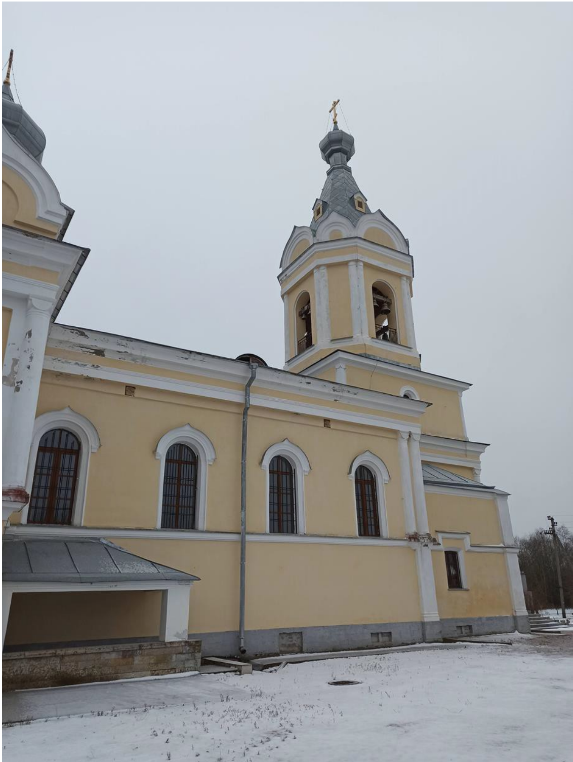
7. Фрагмент северного фасада церкви.
