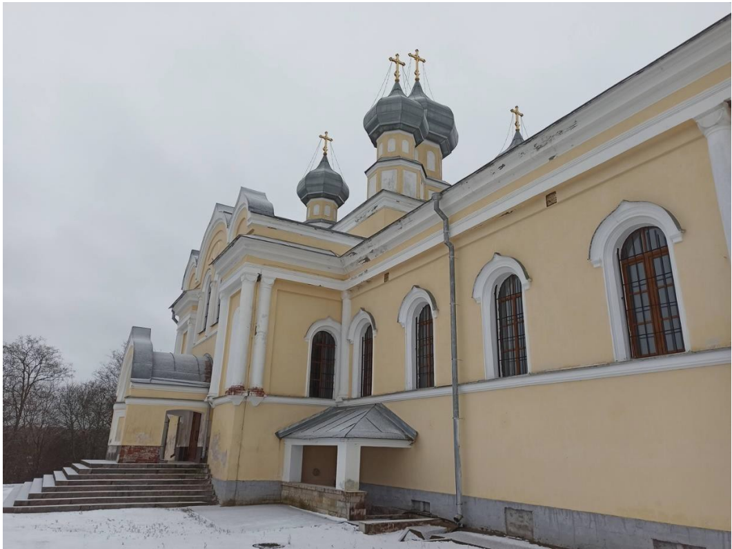
12. Фрагмент северного фасада церкви.
