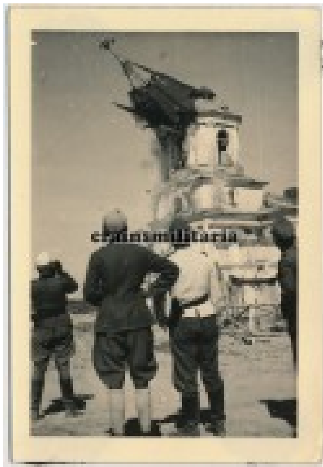
11. 1943 г. Демонтаж куполов церкви. Источник - https://sobory.ru
