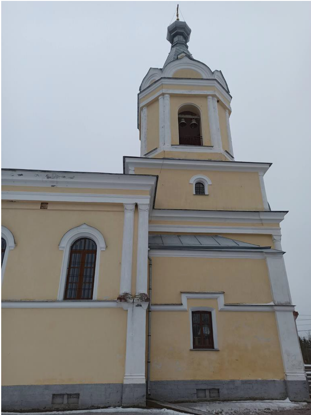
8. Фрагмент северного фасада церкви.
