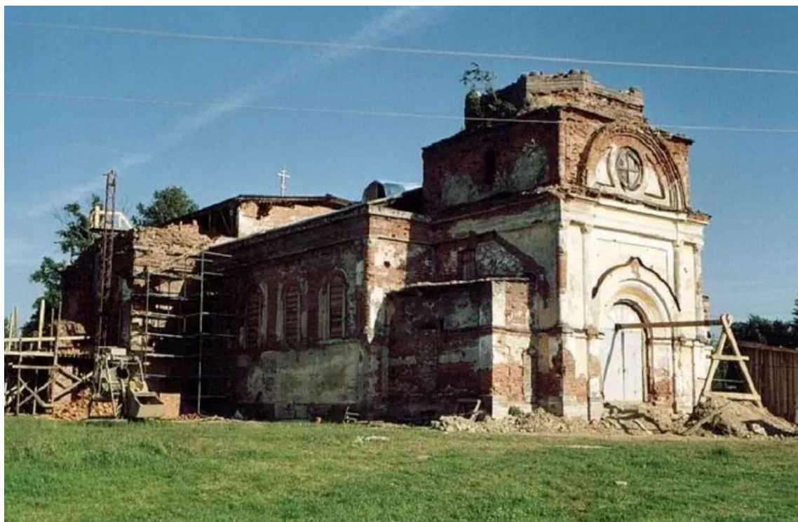
12. 1996-98 гг. Начало реставрационных работ по церкви
