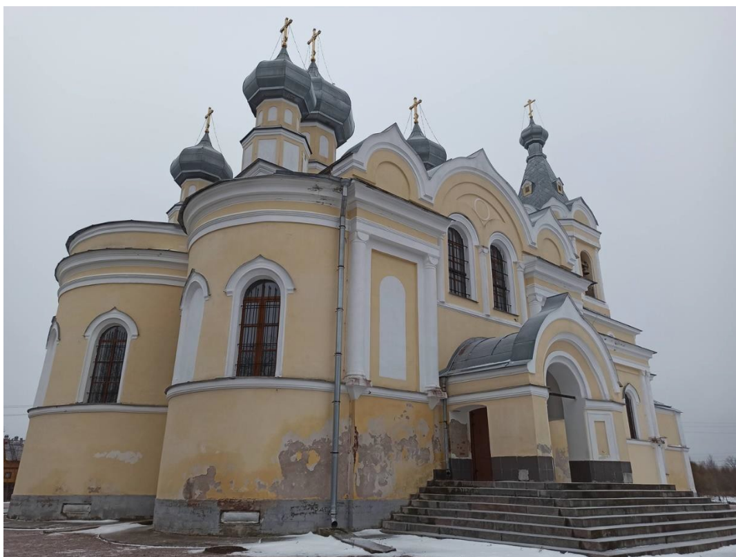
5. Вид на церковь с северо-востока.
