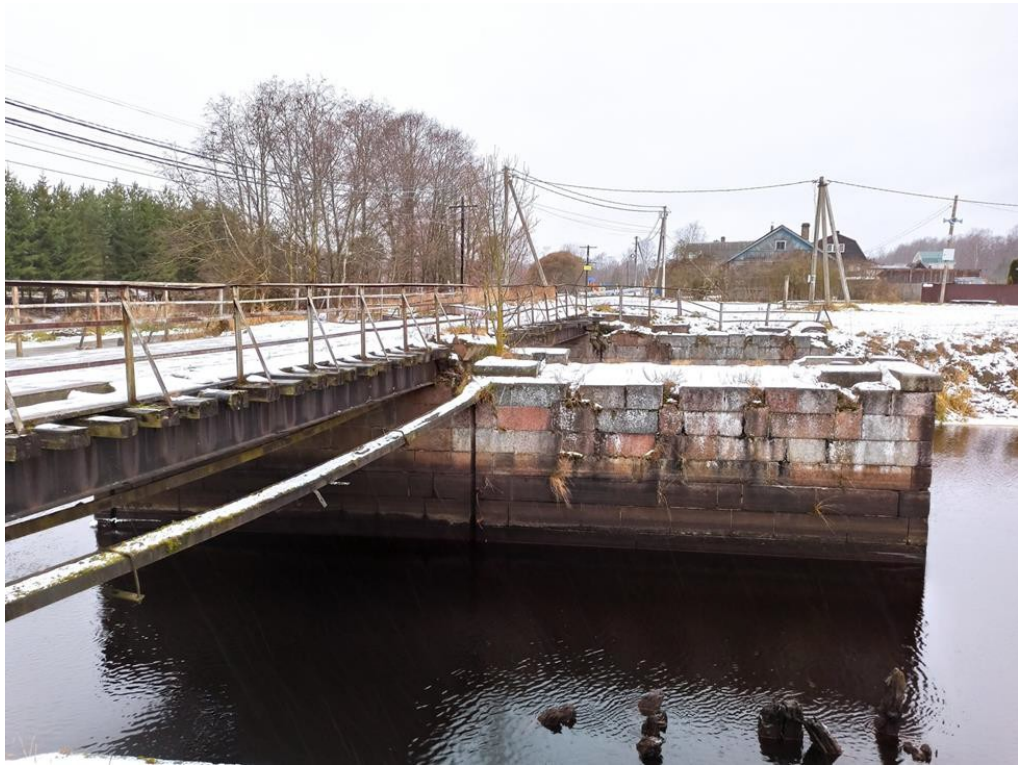
3. Вид на обьект с востока.
