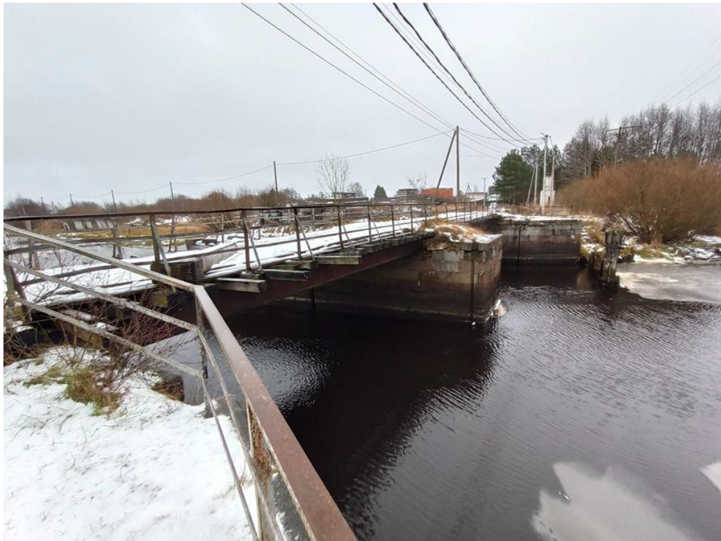
4. Вид на обьект с востока.
