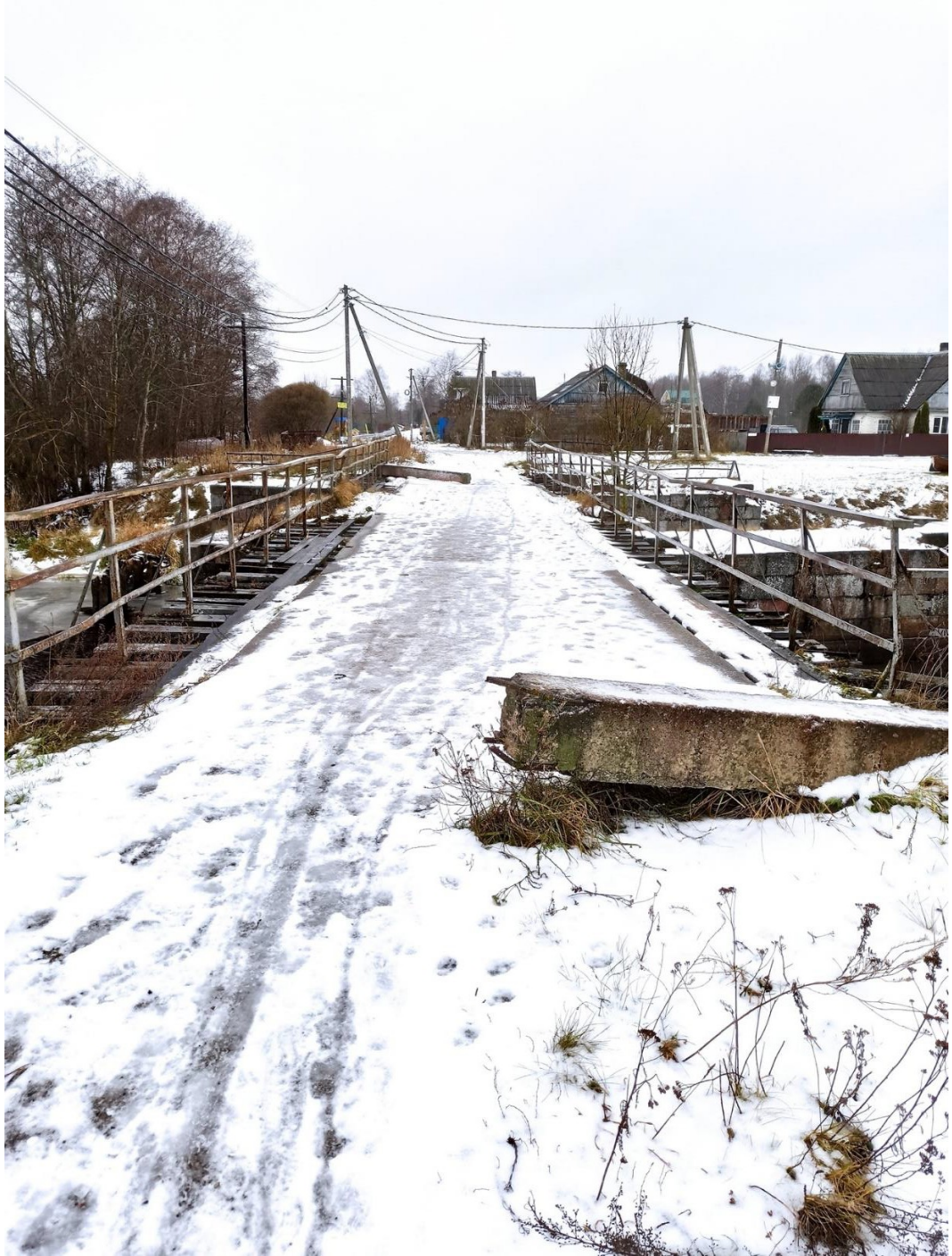
5. Вид на обьект с востока.
