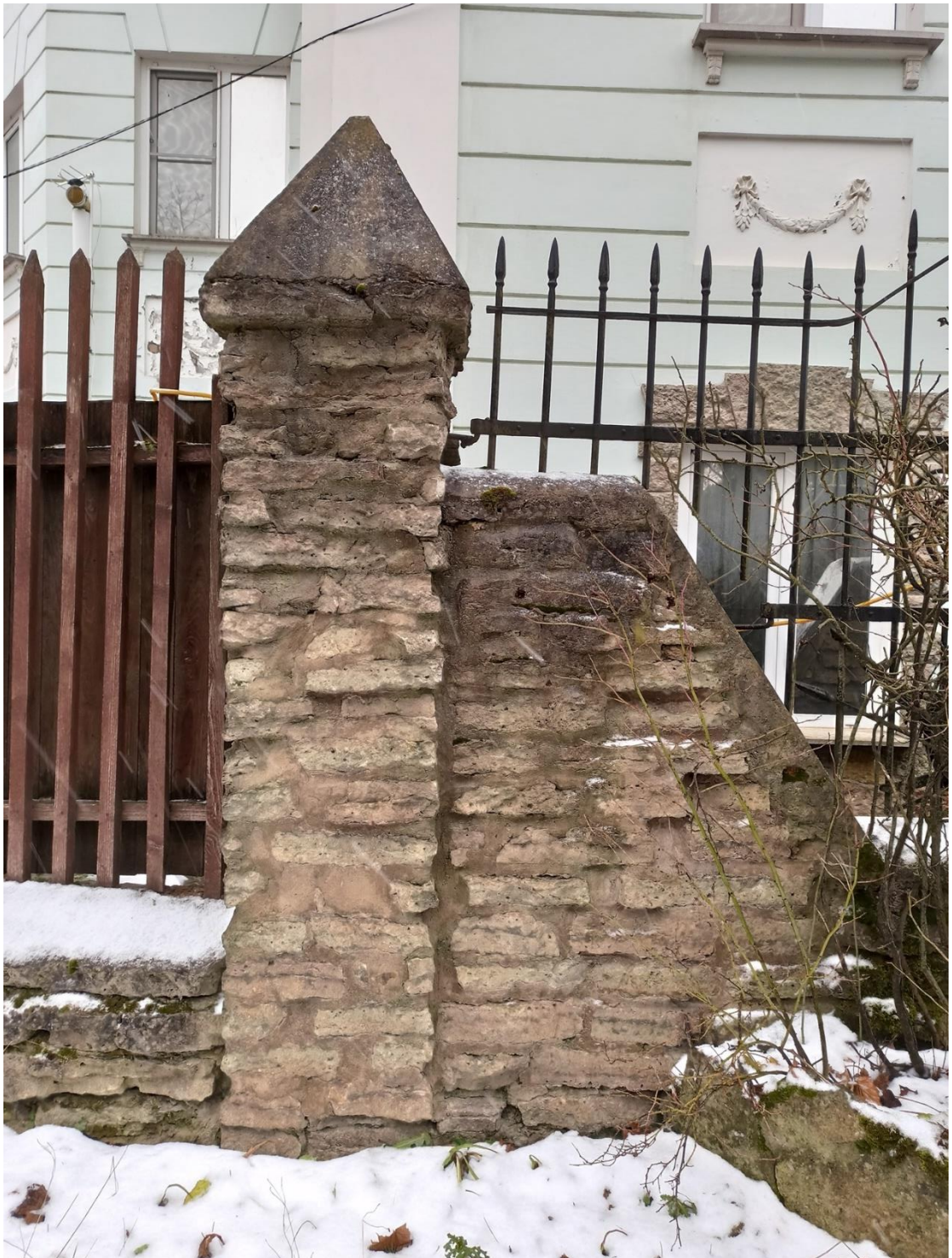
4. Фрагмент южного фасада.
