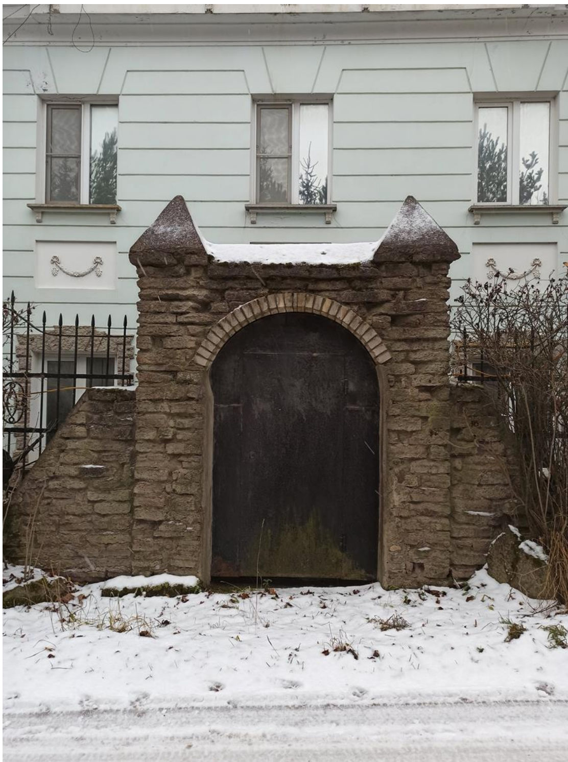
3. Фрагмент южного фасада.
