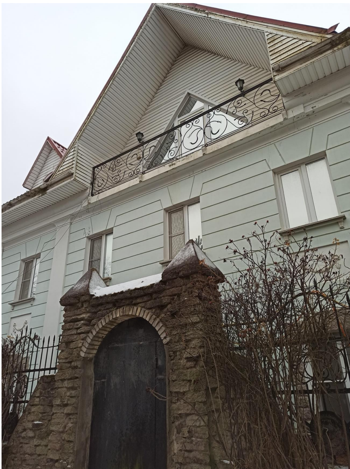
10. Фрагмент южного фасада.
