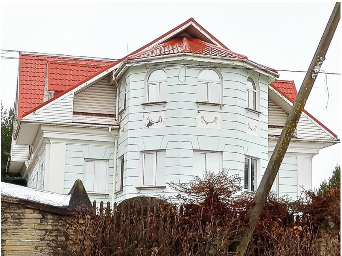
8. Западный фасад объекта.
