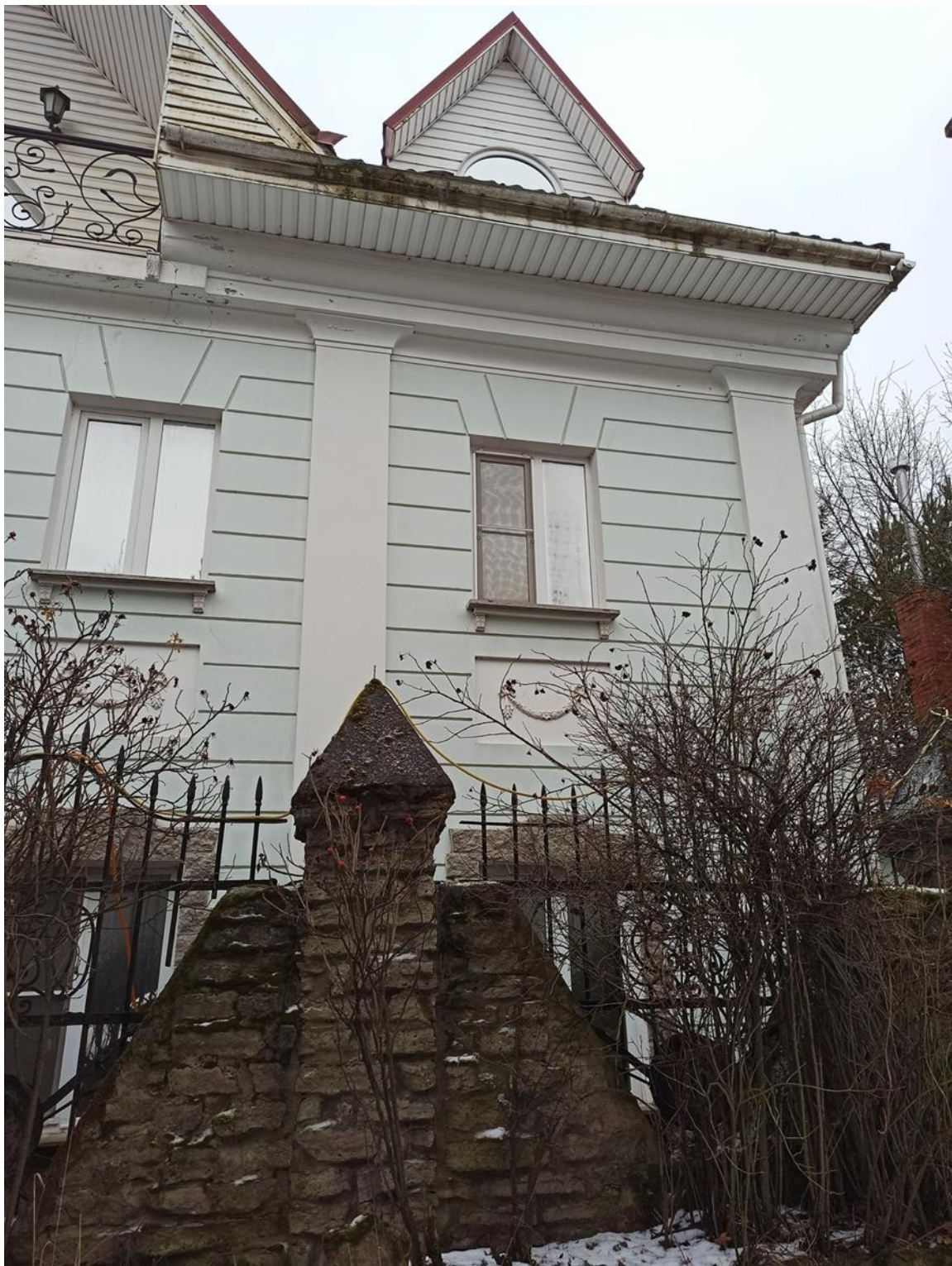
9. Фрагмент южного фасада.
