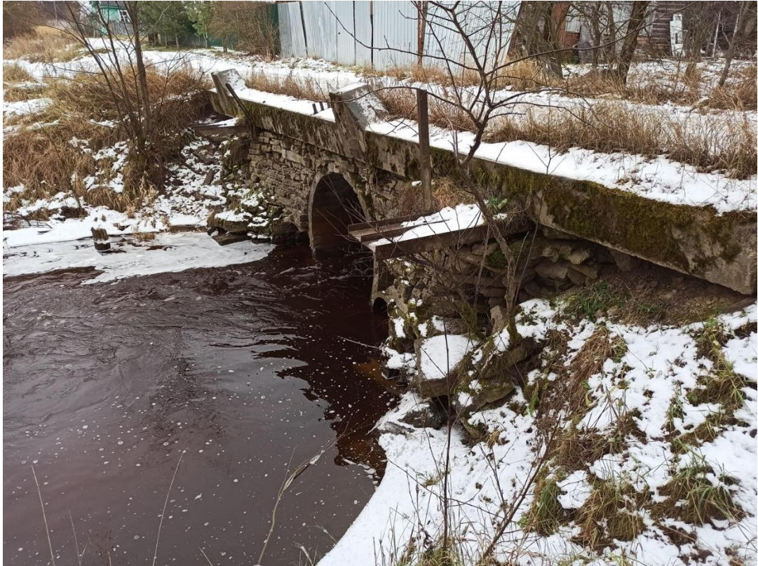
3. Вид объекта с севера.
