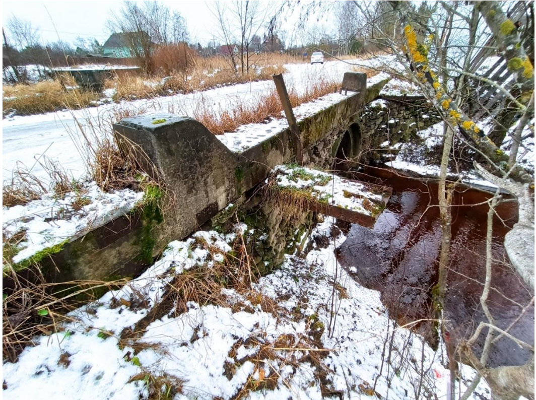
5. Вид объекта с севера.
