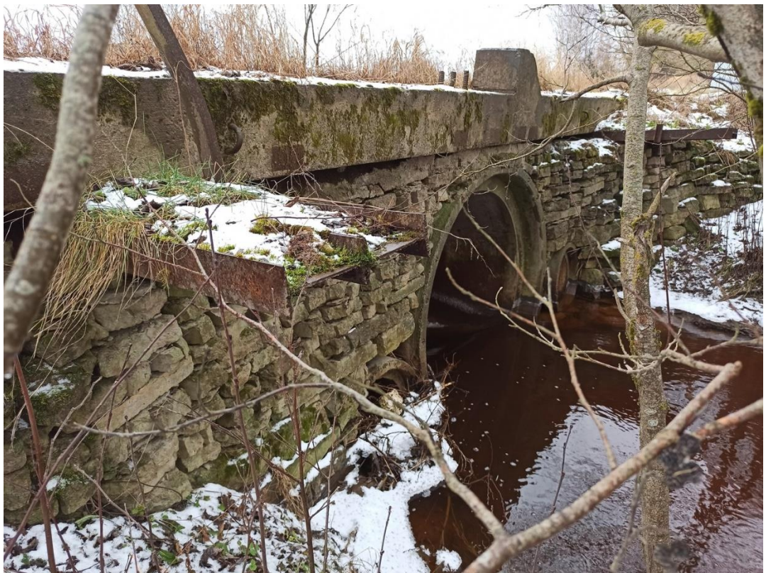
6. Вид объекта с севера.
