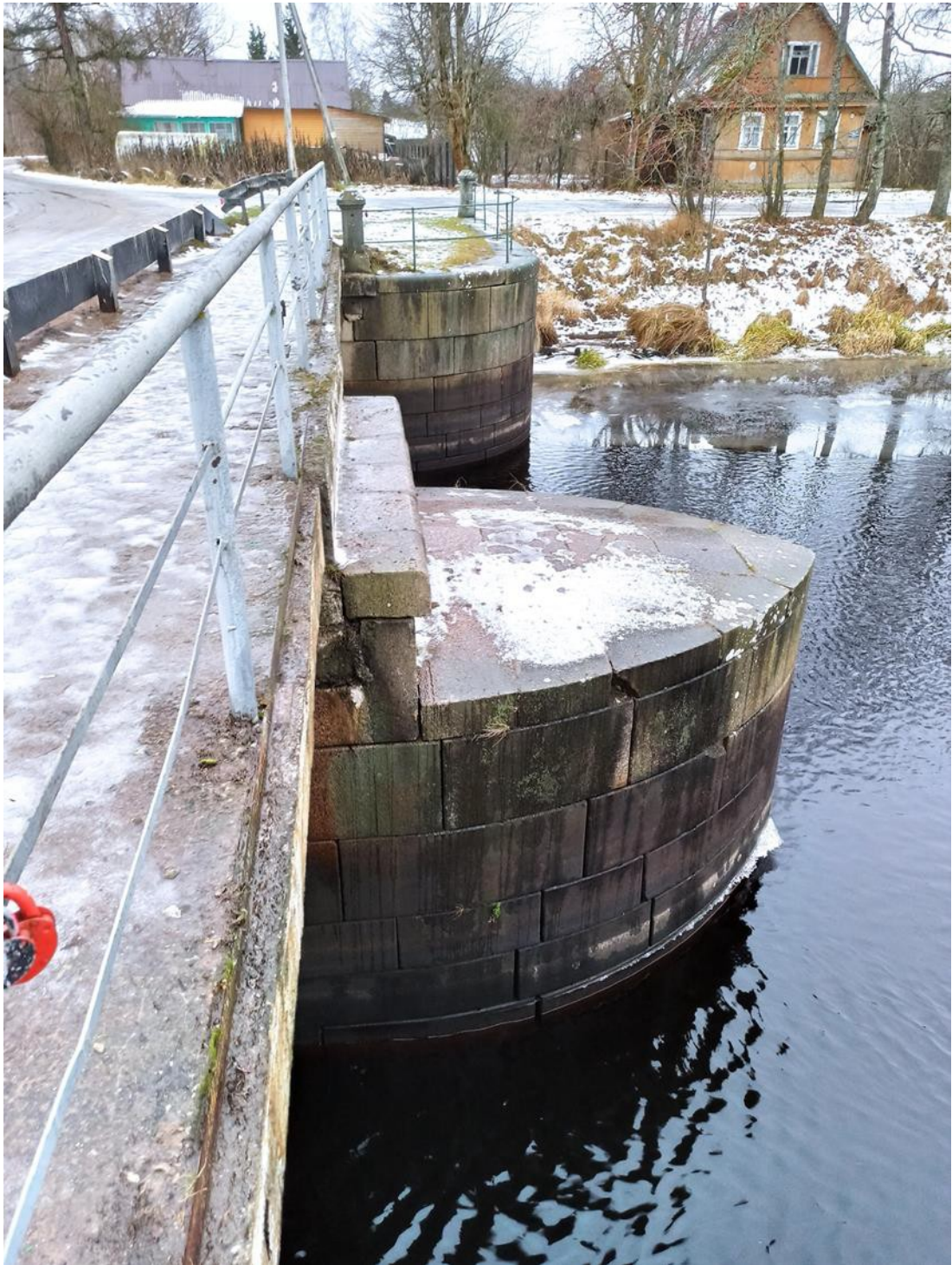
4. Вид объекта с севера.
