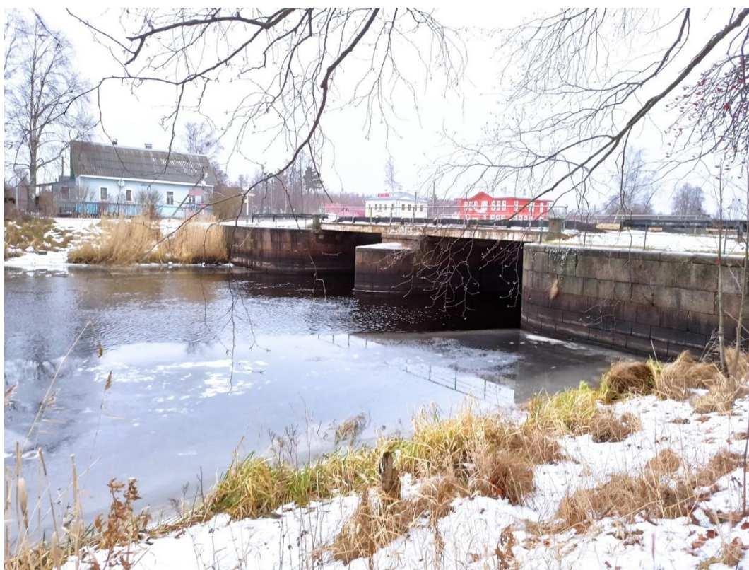
12. Вид обьекта с северо-запада.
