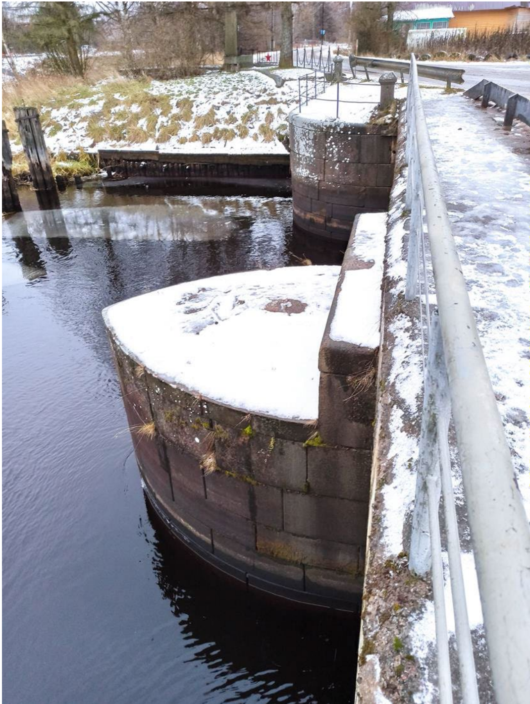
3. Вид объекта с юга.
