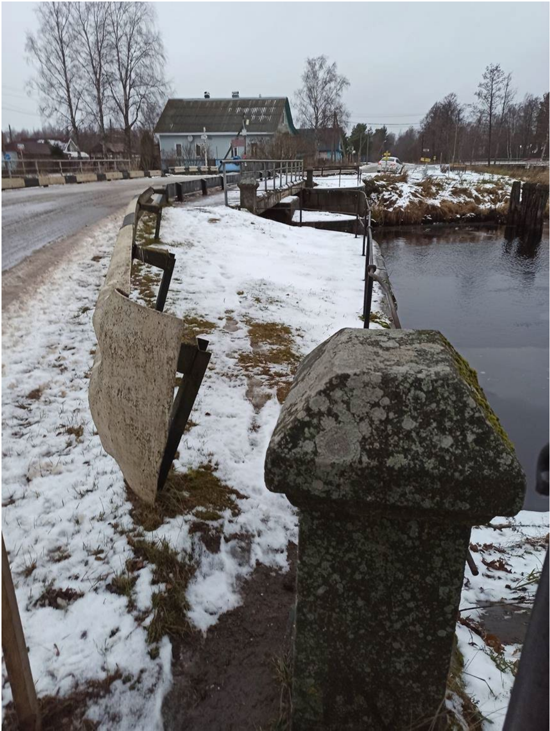
8. Вид объекта с юга.
