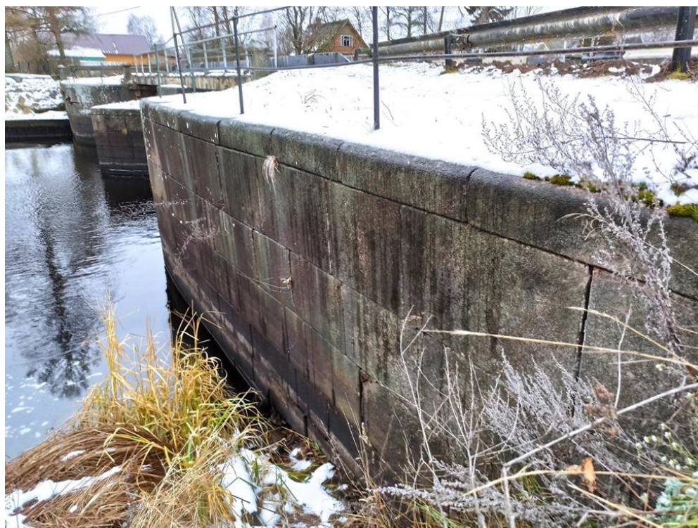
2. Вид объекта с юга.
