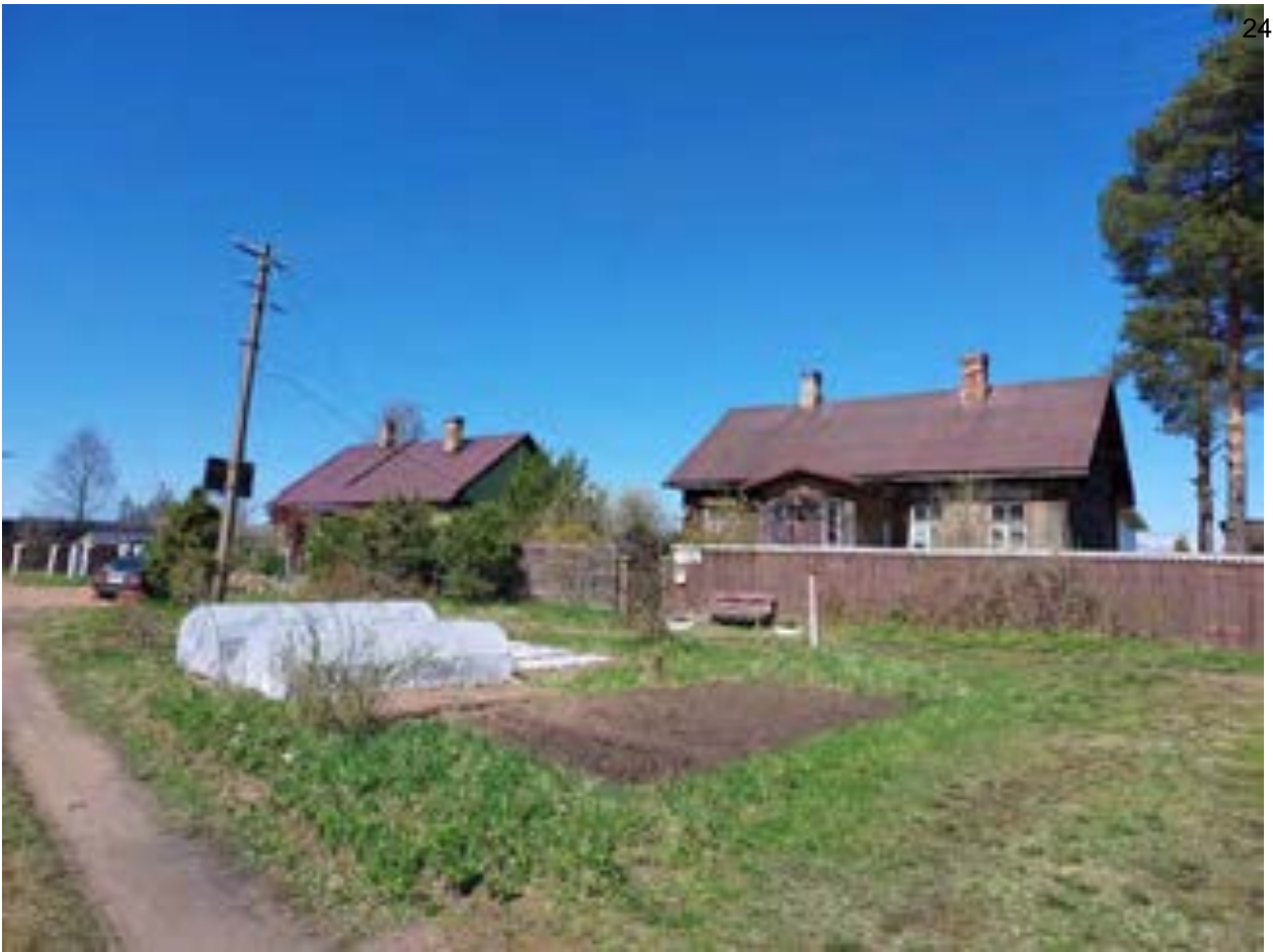
Фото.150. Вид на линию застройки по ул. Лоцманская от 4.05.2022 г.
