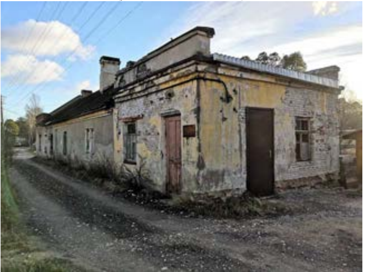
Фото.105. Прачечная (баня) (ул. Лоцманская, 36, лит. Г) от 08.11.2021 г.
