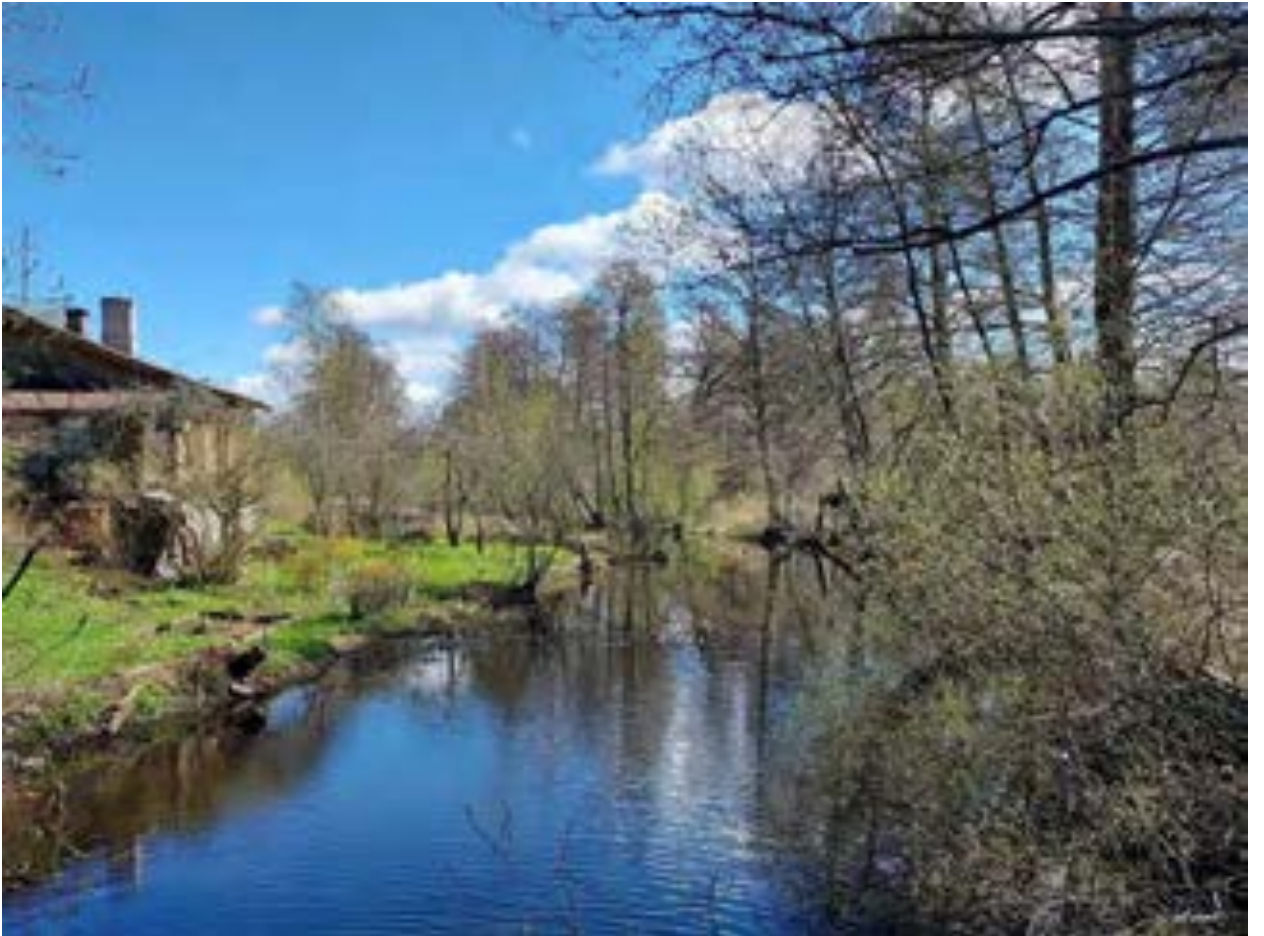
Фото.177. Вид на лоцманский канал от 4.05.2022 г.
