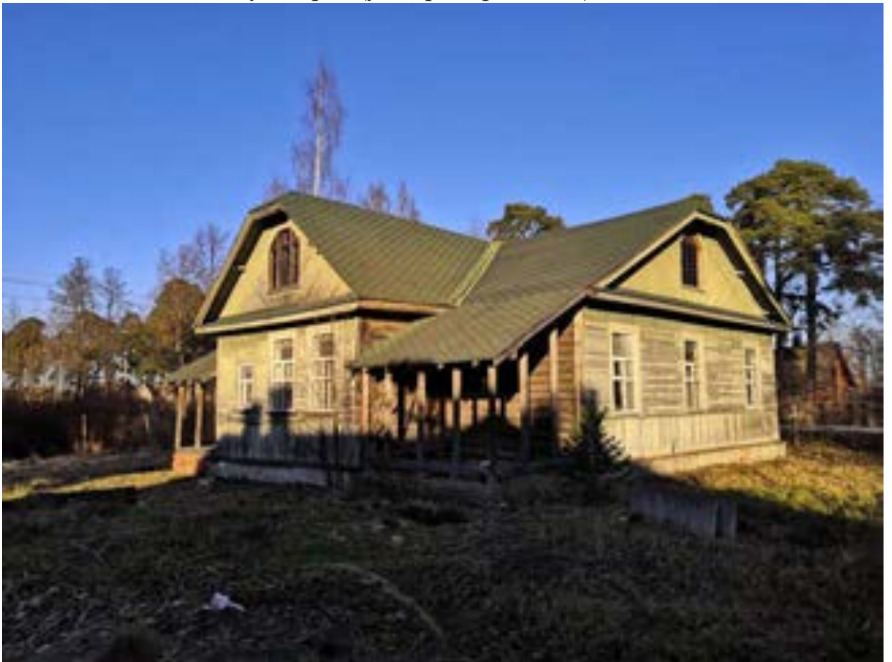
Фото.24. Амбулатория (ул. Приморская, 20) от 08.11.2021 г.
