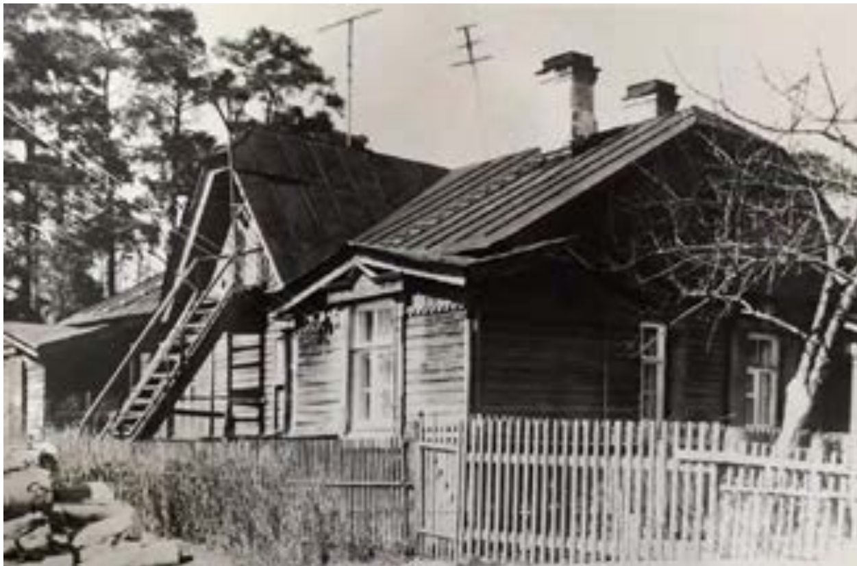
Илл.15. Вид на дом пенсионера по ул. Приморская. Боковой и торцевой фасады. 1980-е гг. / Архив комитета по культуре Ленинградской области
