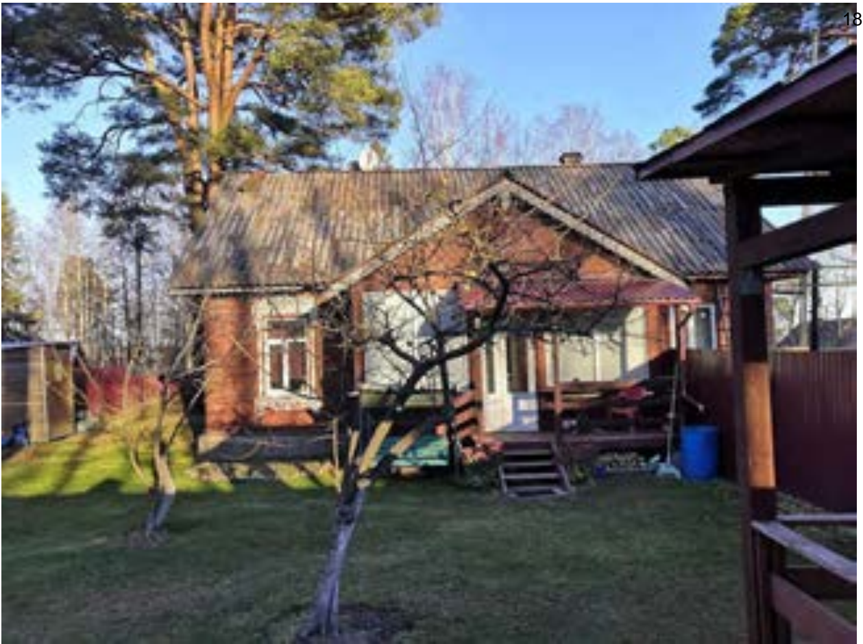
Фото.19. Дом лоцманов (ул. Приморская, 17) от 08.11.2021 г.
