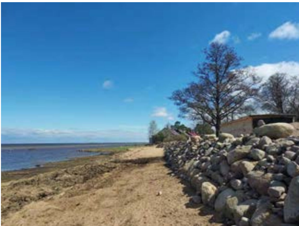
Фото.163. Вид на каменные ряжевые береговые укрепления от 4.05.2022 г.
