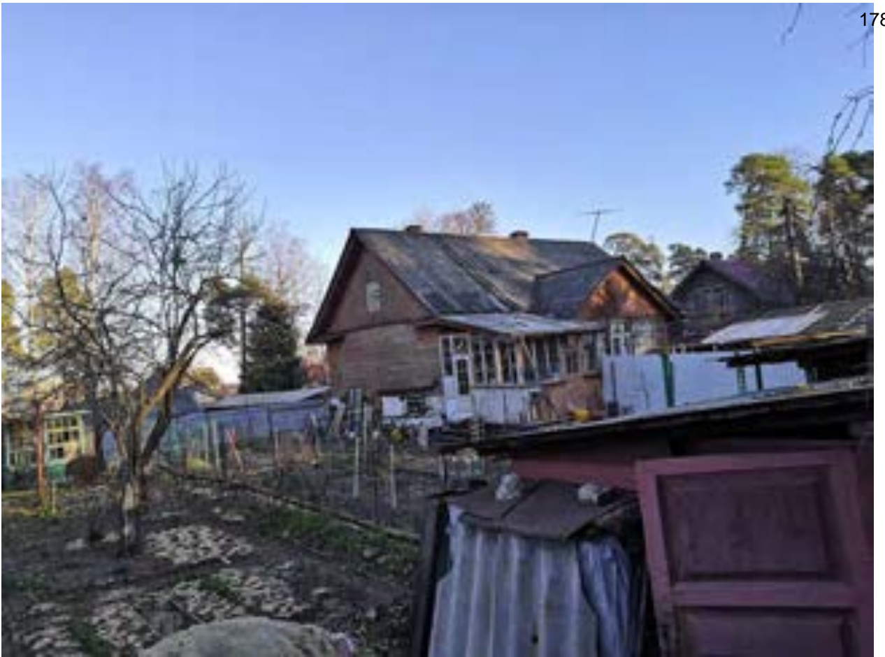
Фото.13. Дом лоцманов (ул. Приморская, 13) от 08.11.2021 г.
