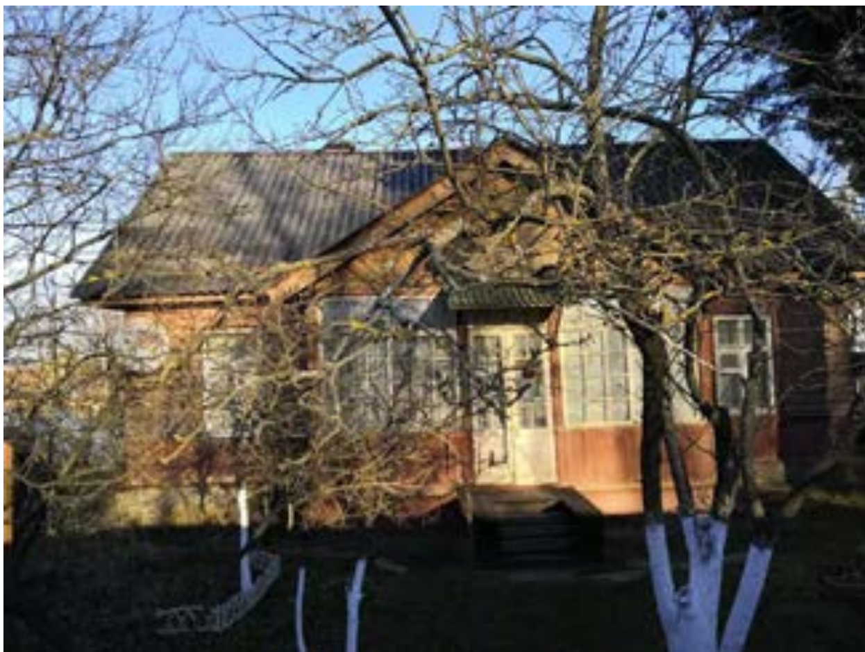
Фото.21. Дом лоцманов (ул. Приморская, 19) от 08.11.2021 г.
