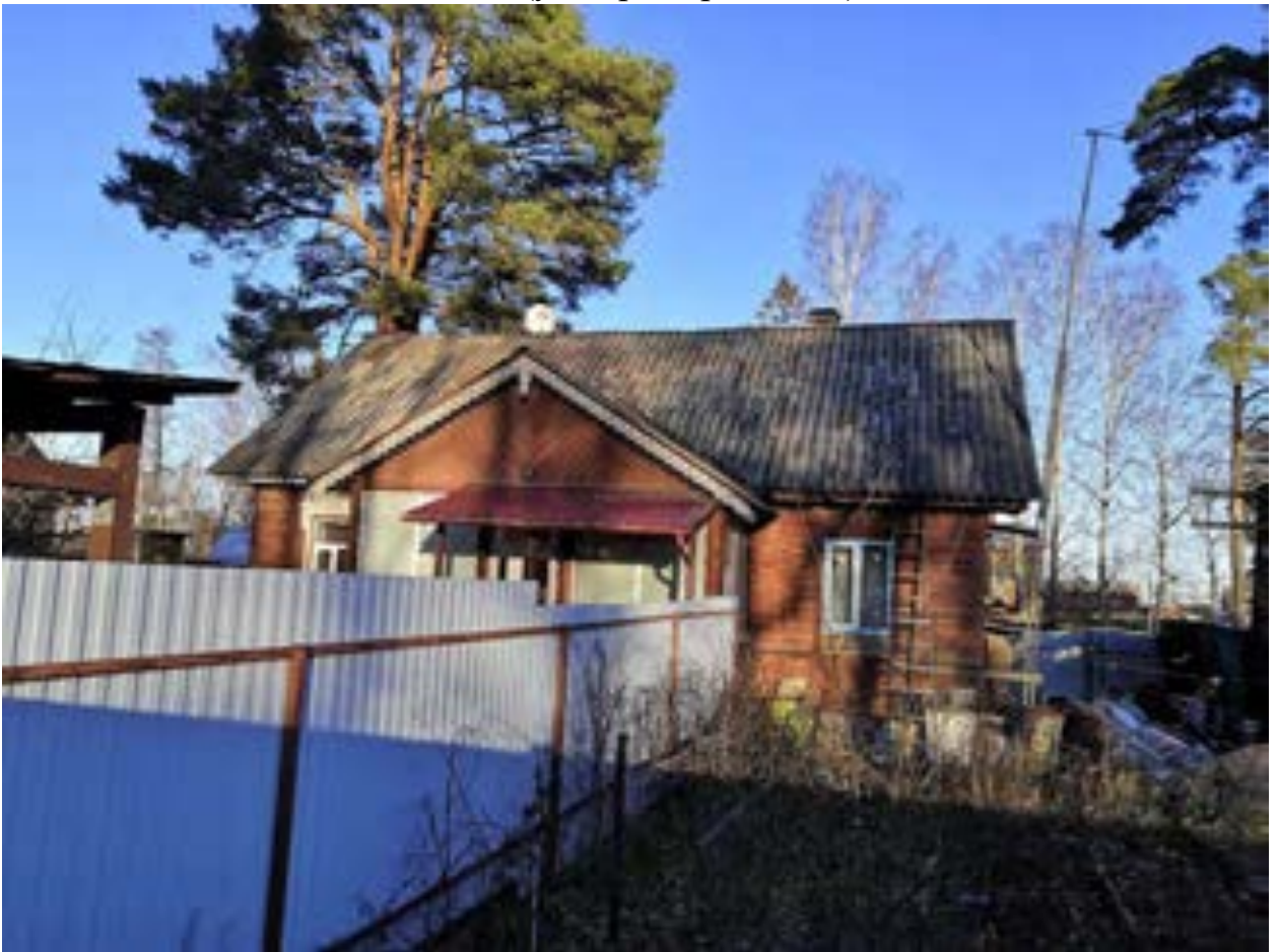
Фото.20. Дом лоцманов (ул. Приморская, 17) от 08.11.2021 г.
