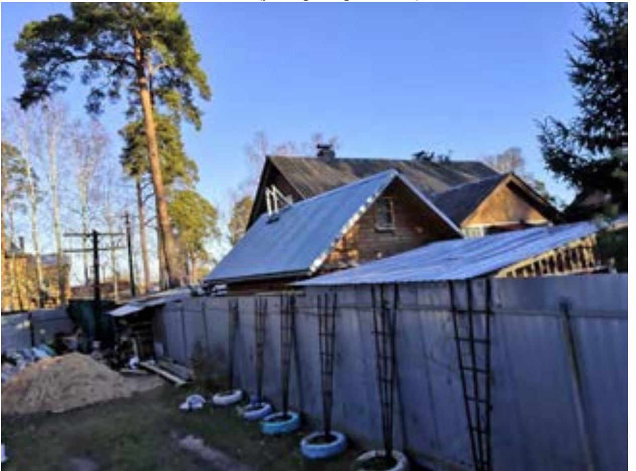
Фото.14. Дом лоцманов (ул. Приморская, 15) от 08.11.2021 г.
