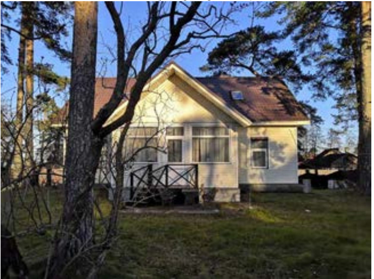
Фото.36. Дом лоцманов (ул. Приморская, 31) от 08.11.2021 г.
