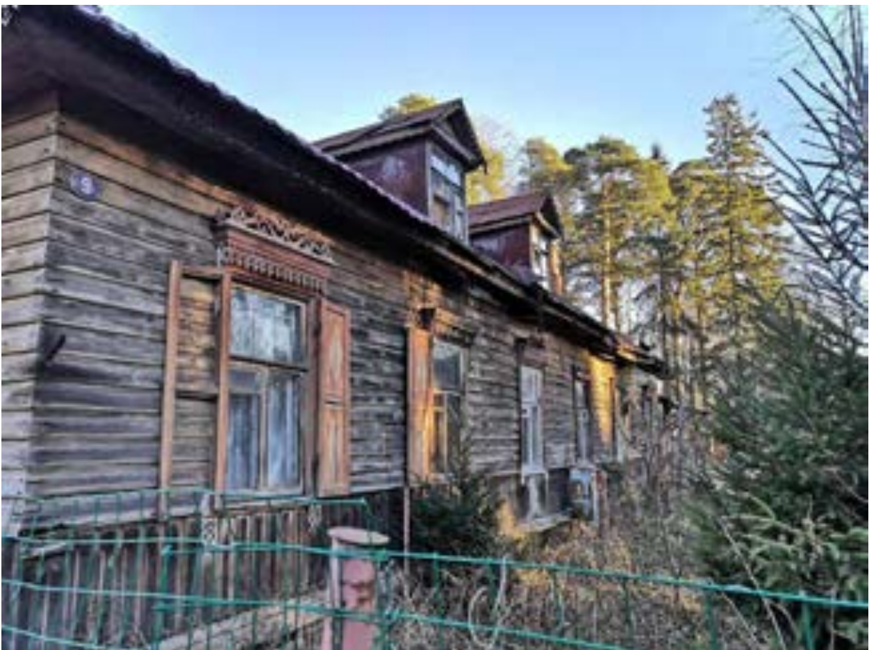
Фото.2. Общий вид на дом лоцманского командира (Приморская ул., 9) от 08.11.2021 г.
