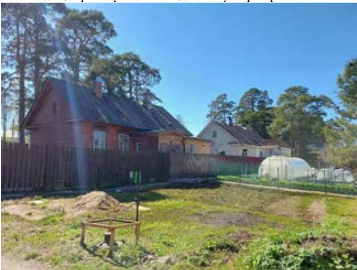
Фото.147. Вид на дворовые фасады линии домов по ул. Приморская от 4.05.2022 г.
