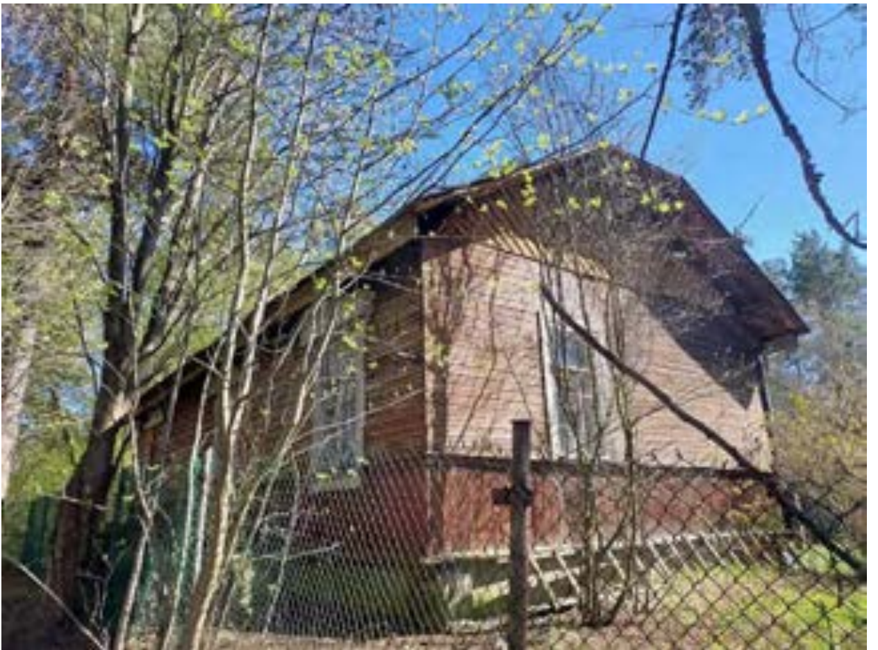
Фото.141. Дом дворника-сторожа для пенсионных домов (ул. Приморская, 8) от 4.05.2022 г.
