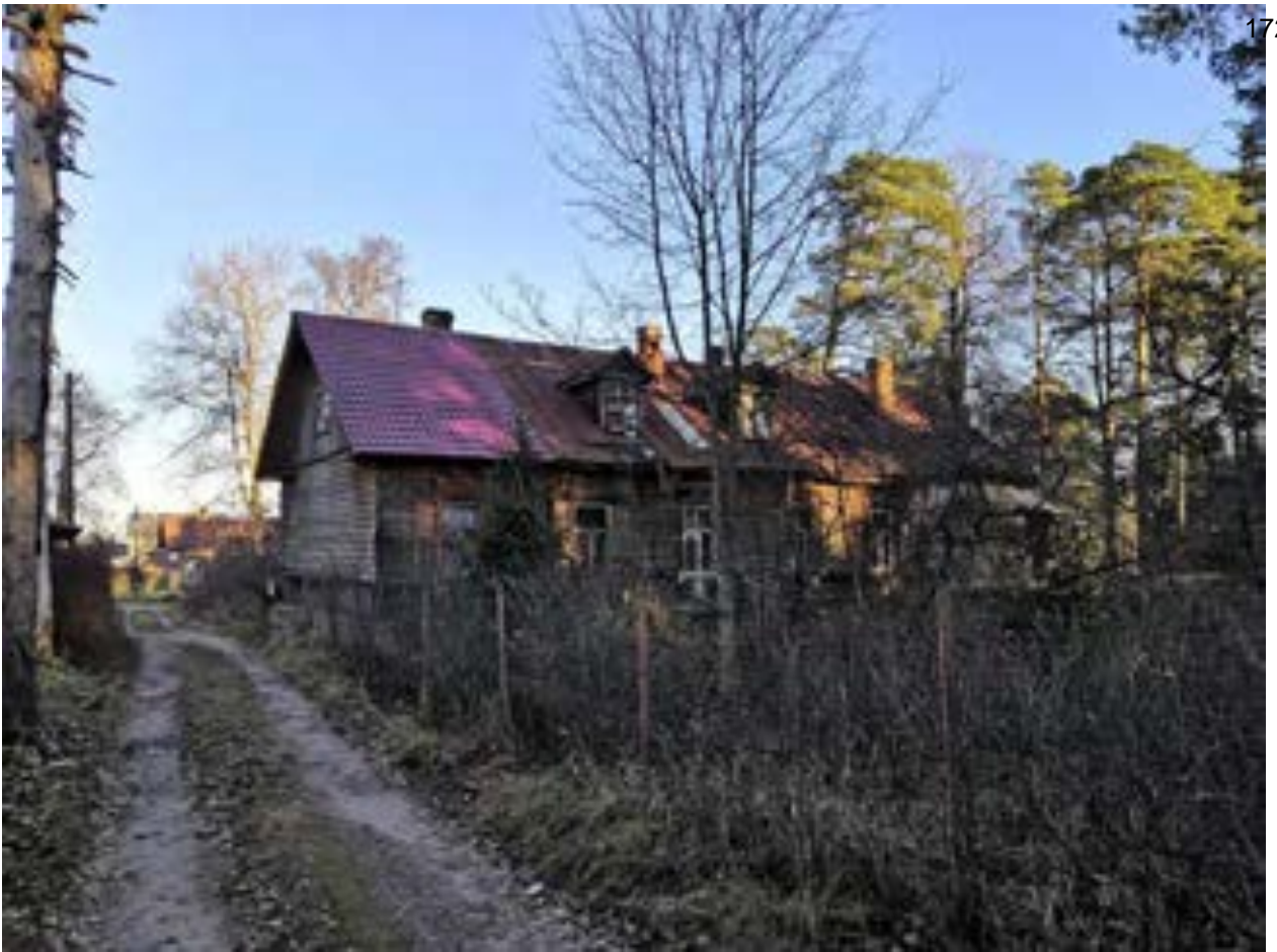
Фото.1. Общий вид на дом лоцманского командира (Приморская ул., 9) от 08.11.2021 г.
