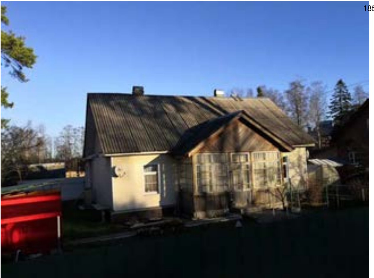
Фото.27. Дом лоцманов (ул. Приморская, 23) от 08.11.2021 г.
