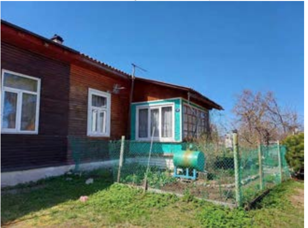
Фото.115. Дом священника (ул. Лоцманская, 14) от 4.05.2022 г.
