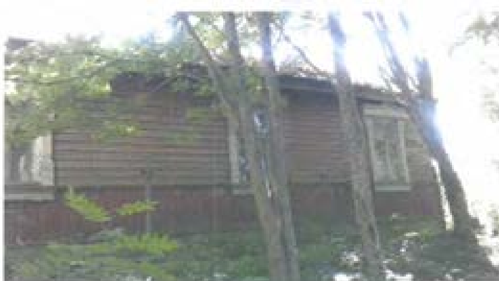
Дом дворника-сторожа для пенсионных домов. Северная сторона дома. Фото 2019 год.
