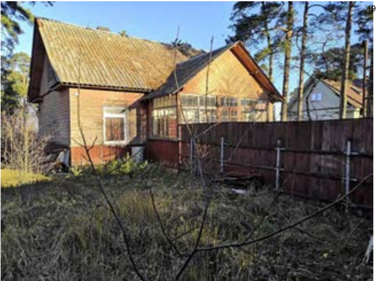
Фото.37. Дом лоцманов (ул. Приморская, 33) от 08.11.2021 г.
