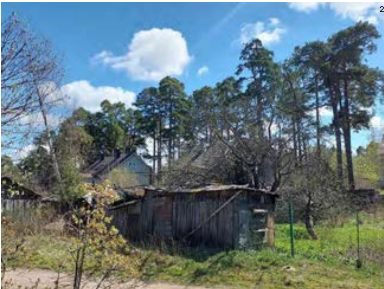
Фото.146. Вид на дворовые фасады линии домов по ул. Приморская от 4.05.2022 г.
