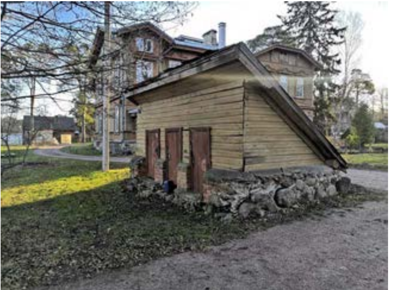
Фото.103. Ледник (ул. Лоцманская, 36, лит. Б) от 08.11.2021 г.
