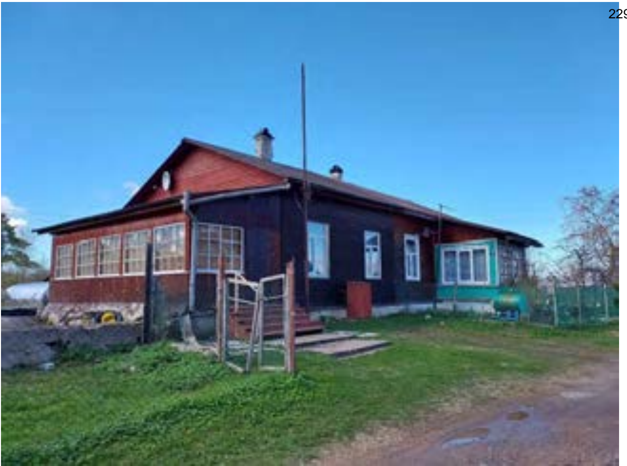
Фото.114. Дом священника (ул. Лоцманская, 14) от 4.05.2022 г.
