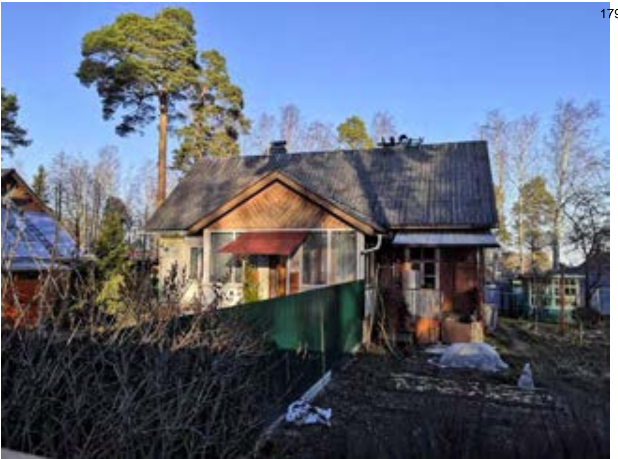
Фото.15. Дом лоцманов (ул. Приморская, 15) от 08.11.2021 г.
