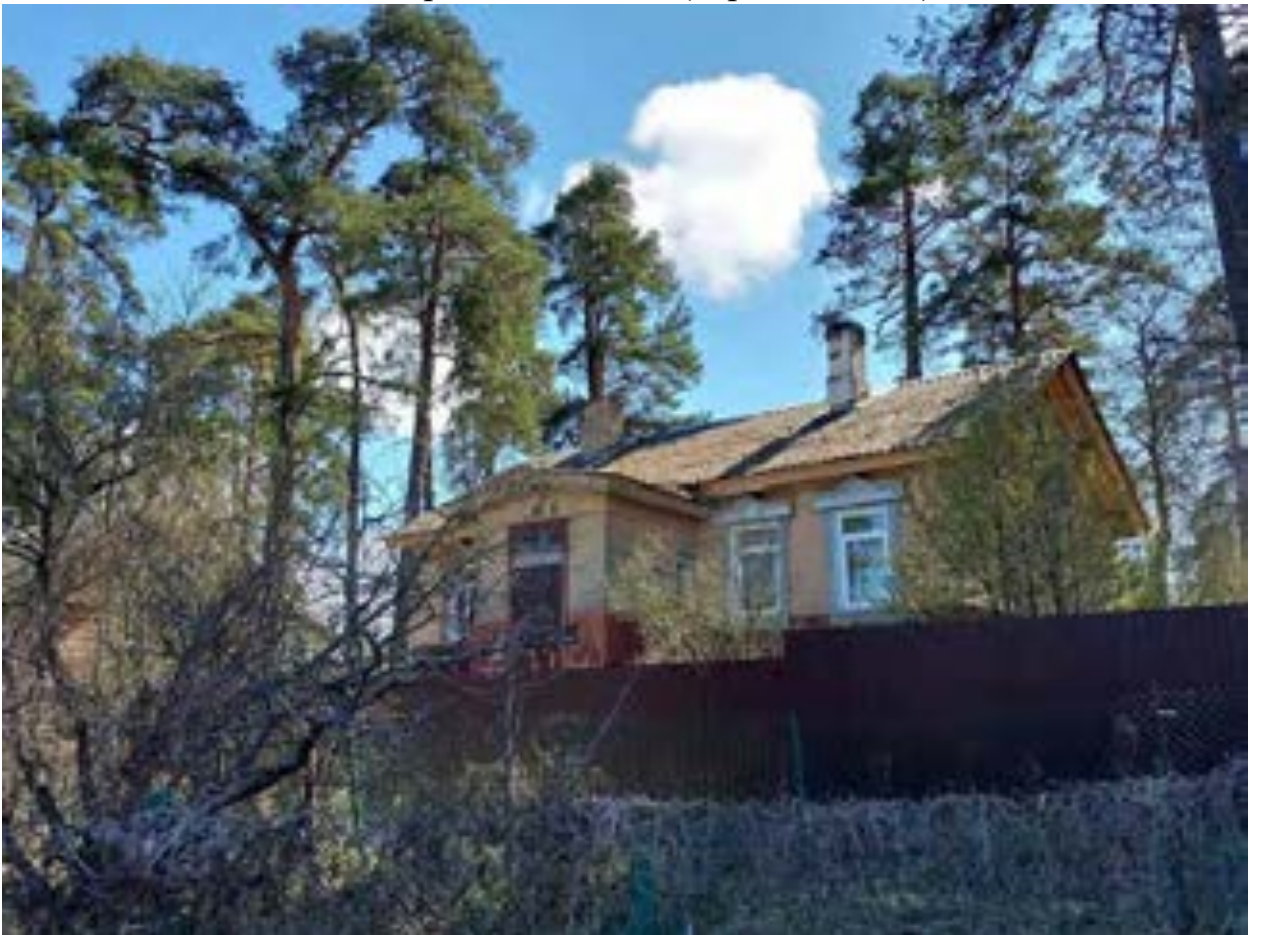
Фото.145. Вид на дворовые фасады линии домов по ул. Приморская от 4.05.2022 г.
