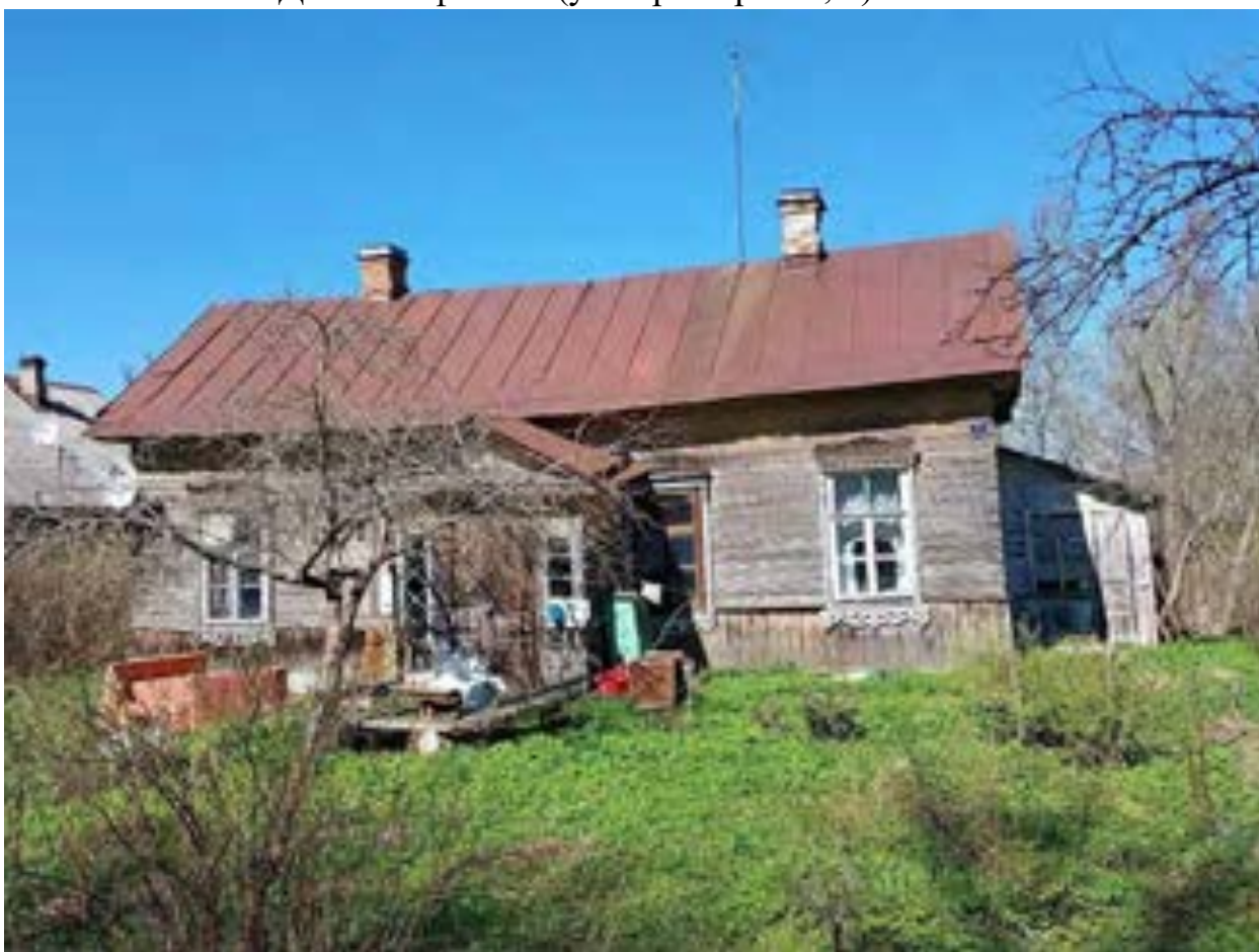
Фото.131. Дом-телефонная (ул. Приморская, 7) от 4.05.2022 г.
