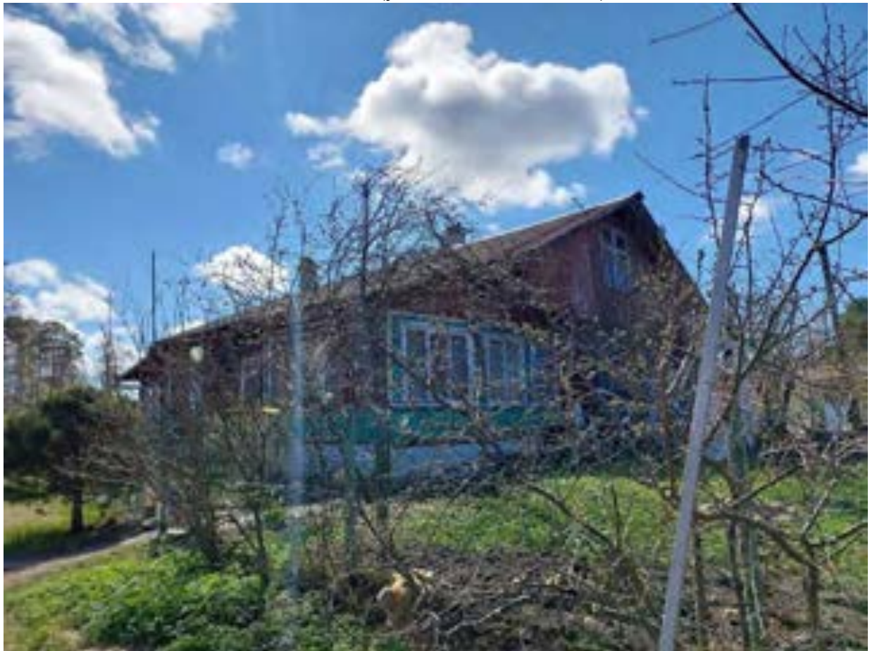
Фото.117. Дом священника (ул. Лоцманская, 14) от 4.05.2022 г.
