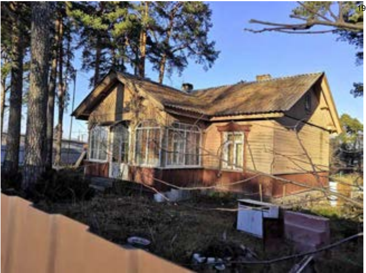
Фото.39. Дом лоцманов (ул. Приморская, 35) от 08.11.2021 г.
