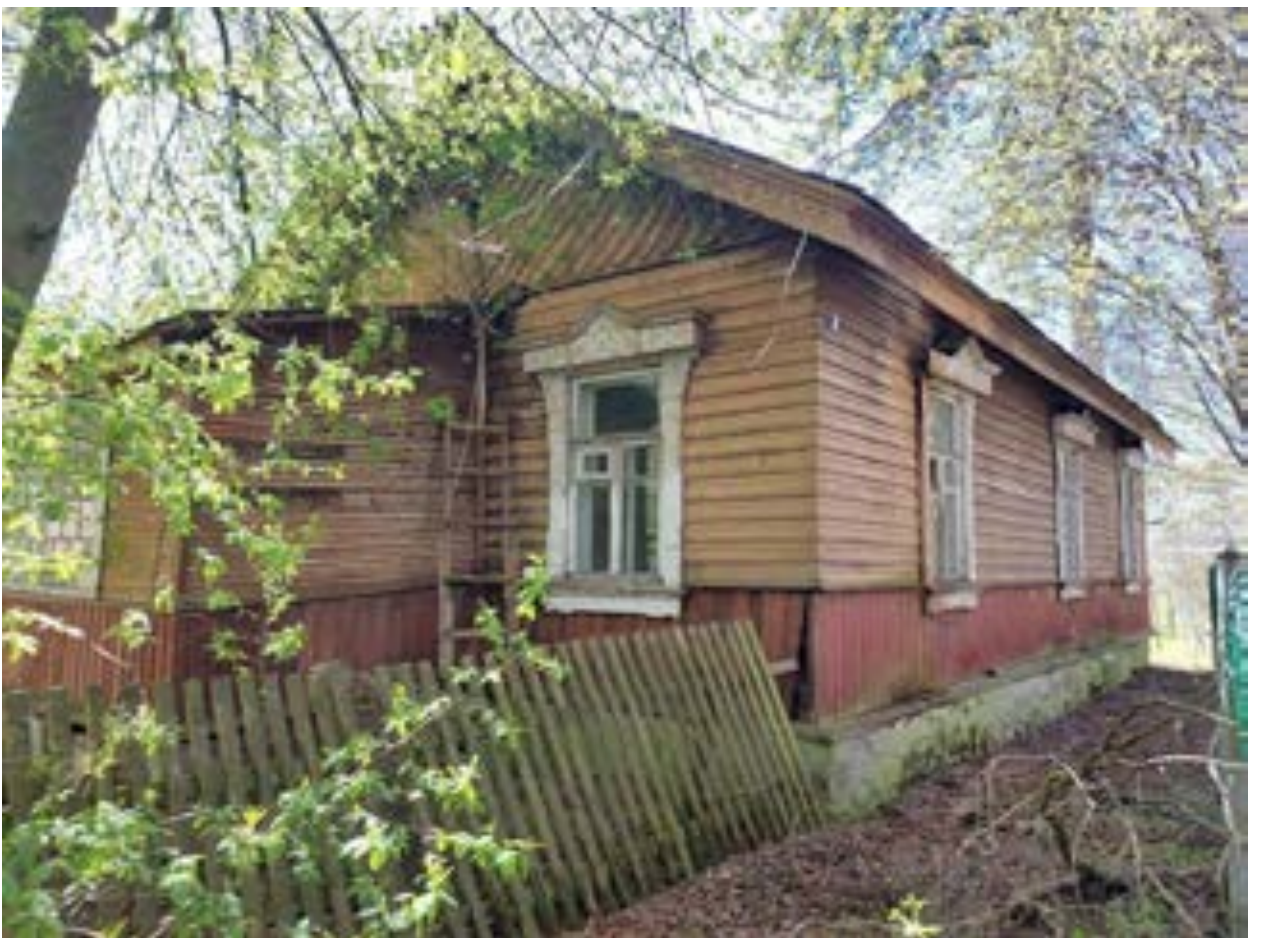
Фото.139. Дом дворника-сторожа для пенсионных домов (ул. Приморская, 8) от 4.05.2022 г.
