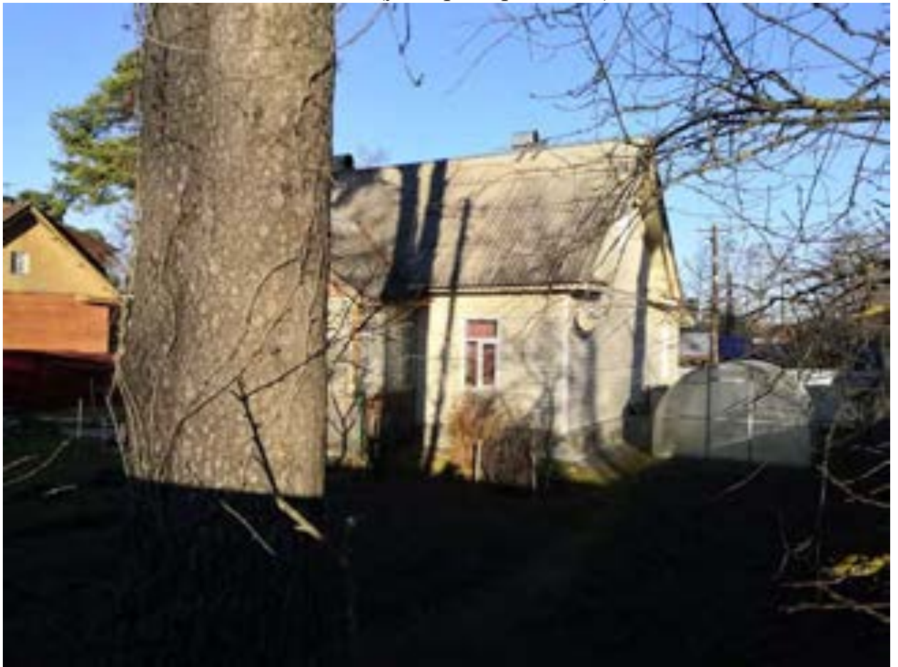
Фото.28. Дом лоцманов (ул. Приморская, 23) от 08.11.2021 г.
