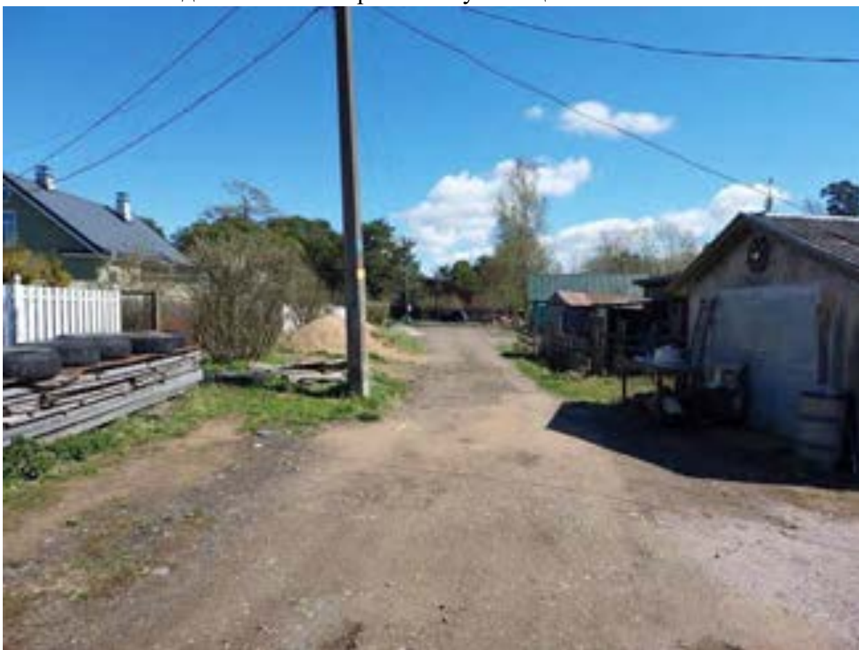
Фото.153. Вид на линию застройки по ул. Лоцманская от 4.05.2022 г.
