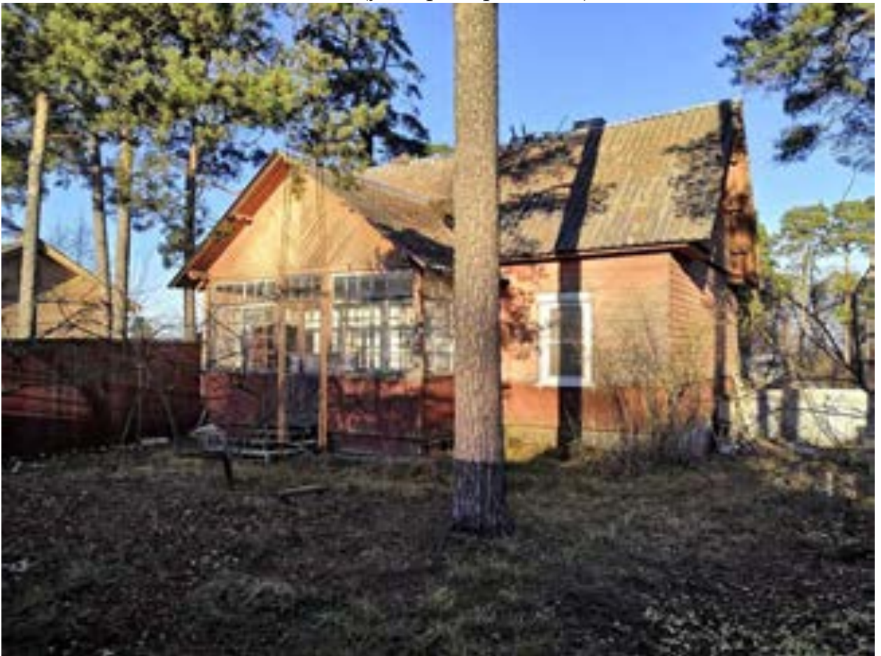
Фото.38. Дом лоцманов (ул. Приморская, 33) от 08.11.2021 г.
