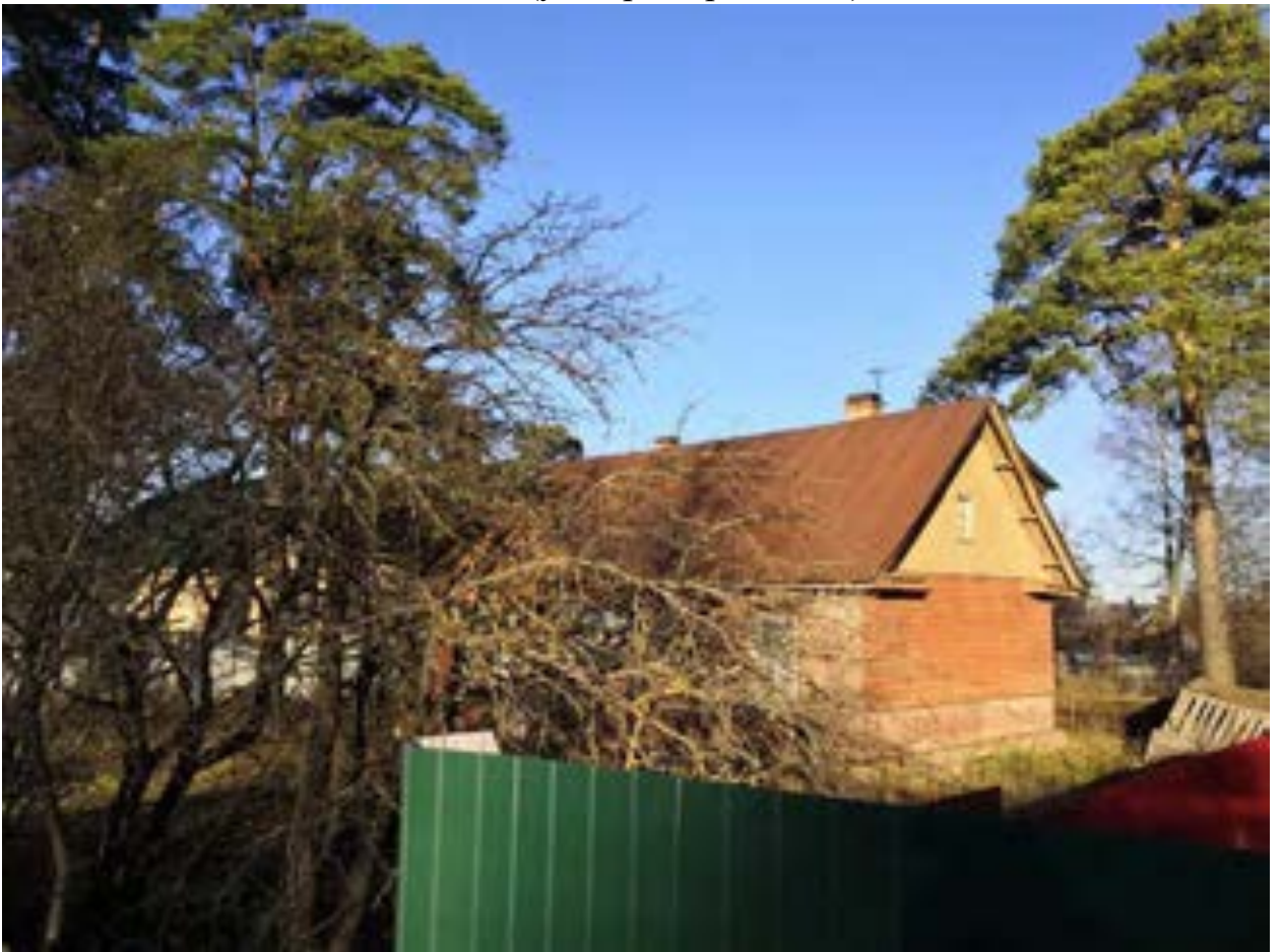
Фото.30. Дом лоцманов (ул. Приморская, 25) от 08.11.2021 г.
