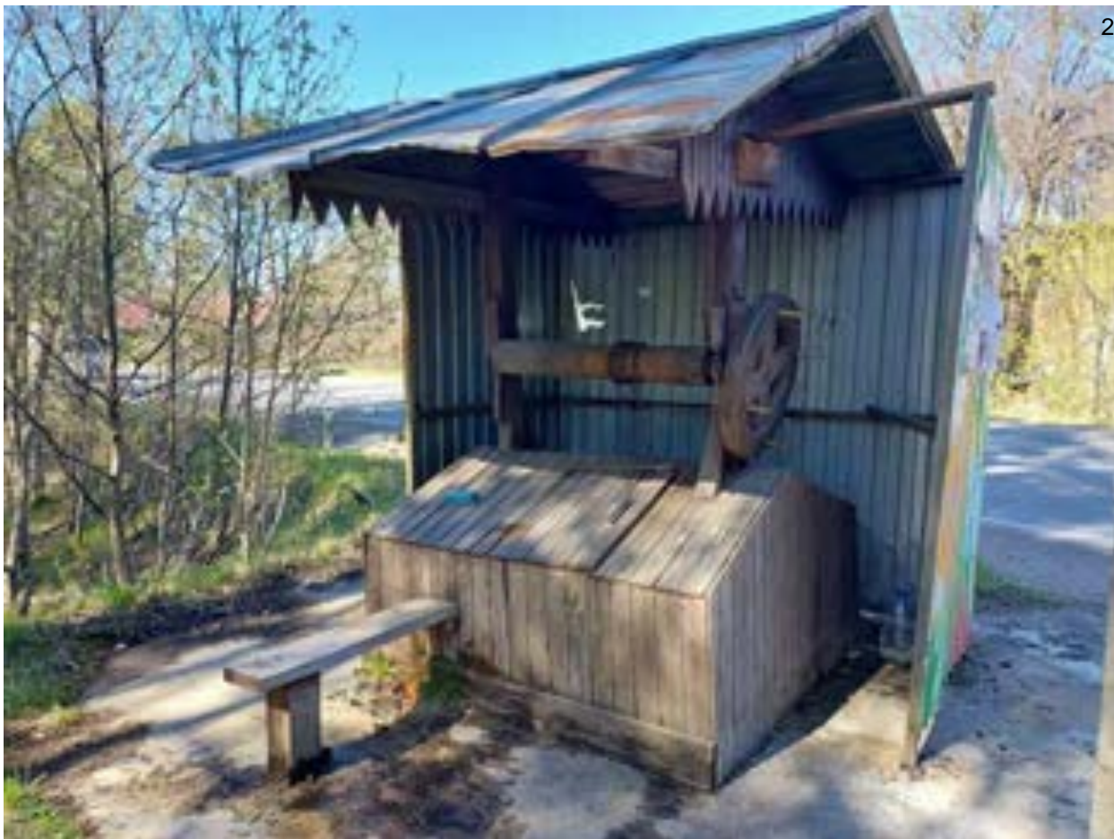
Фото.184. Вид на колодец, расположенный у ул. Приморская рядом с домом дворника-сторожа для пенсионных домов от 4.05.2022 г.
