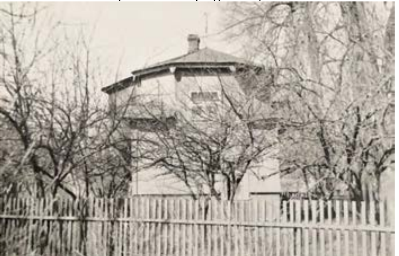
Илл.33. Вид на часовню св. Николая. 1991 г. (в настоящее время утрачено) / Архив комитета по культуре Ленинградской области
