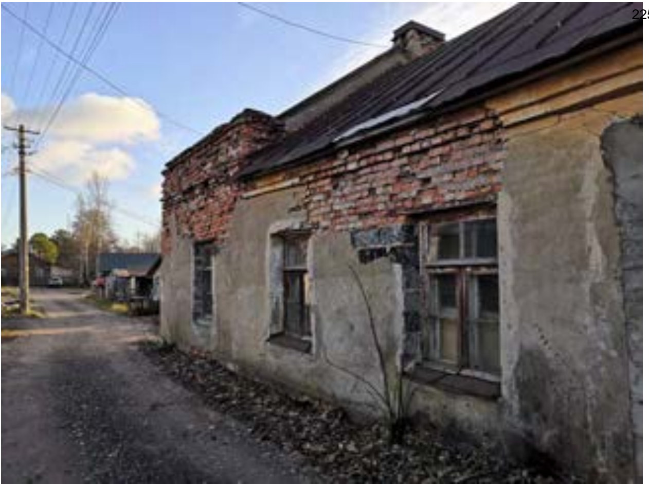
Фото.106. Прачечная (баня) (ул. Лоцманская, 36, лит. Г) от 08.11.2021 г.
