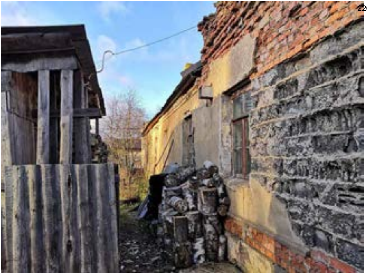
Фото.108. Прачечная (баня) (ул. Лоцманская, 36, лит. Г) от 08.11.2021 г.
