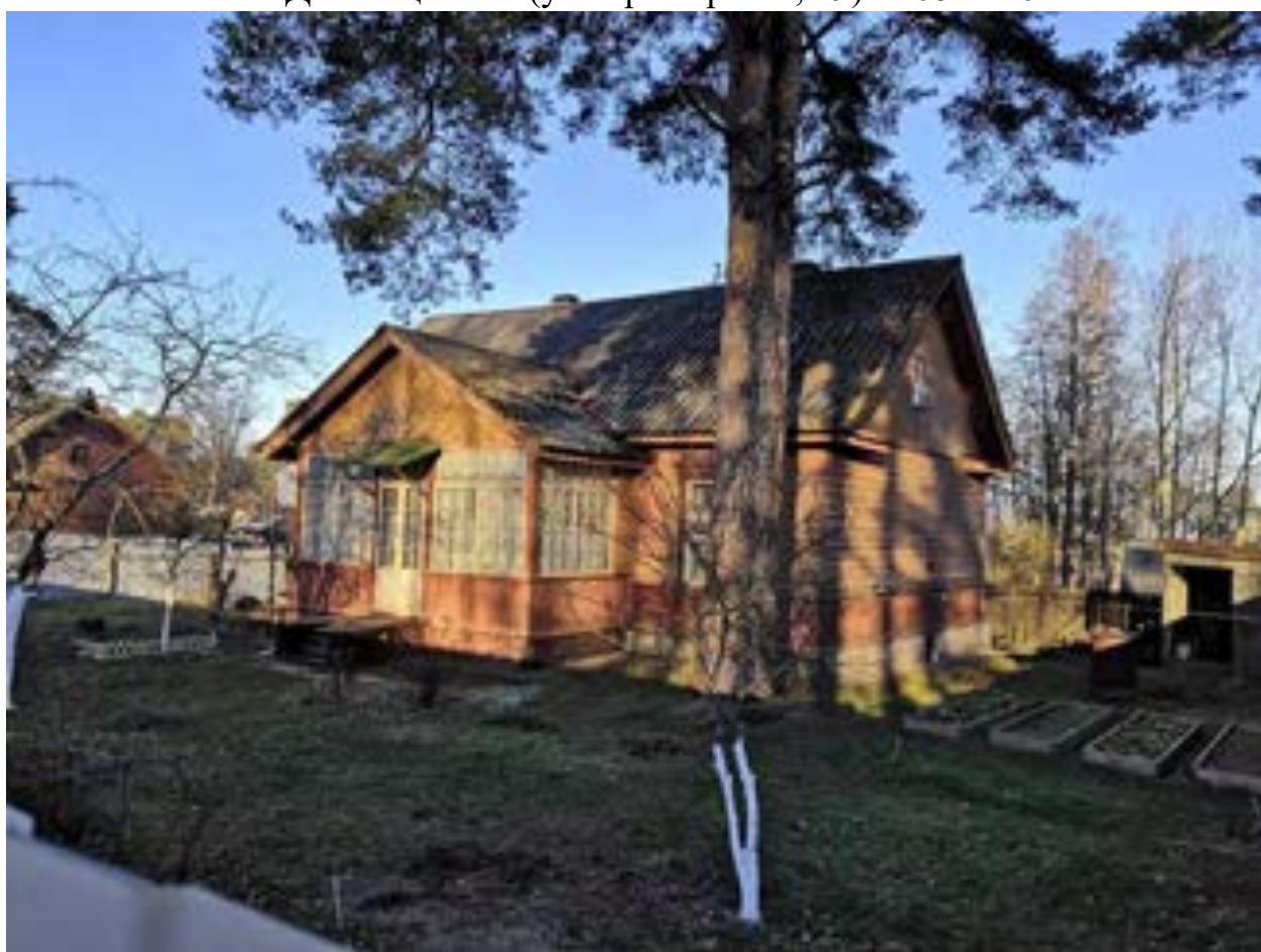
Фото.22. Дом лоцманов (ул. Приморская, 19) от 08.11.2021 г.
