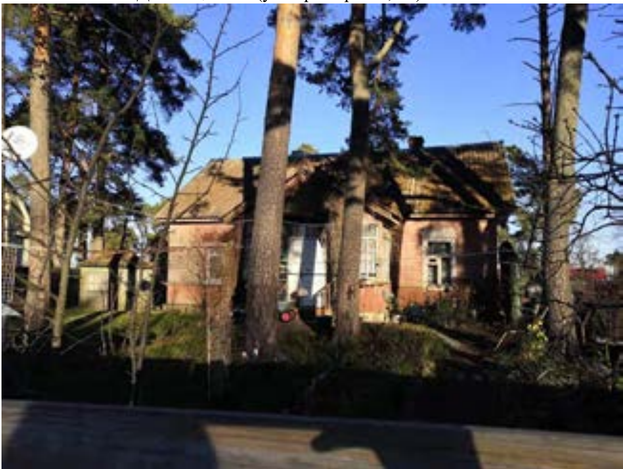
Фото.34. Дом лоцманов (ул. Приморская, 29) от 08.11.2021 г.
