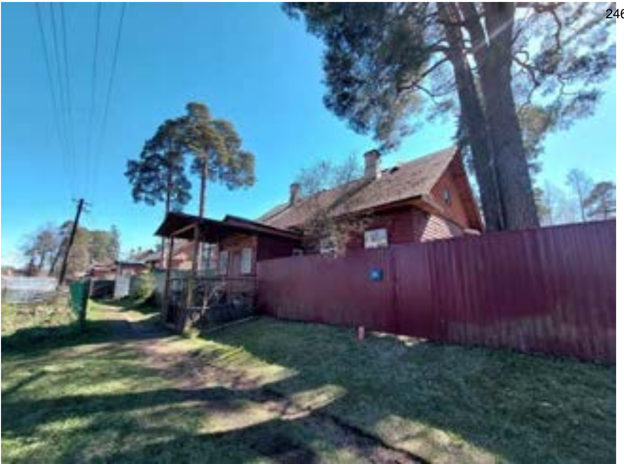
Фото.148. Вид на дворовые фасады линии домов по ул. Приморская от 4.05.2022 г.
