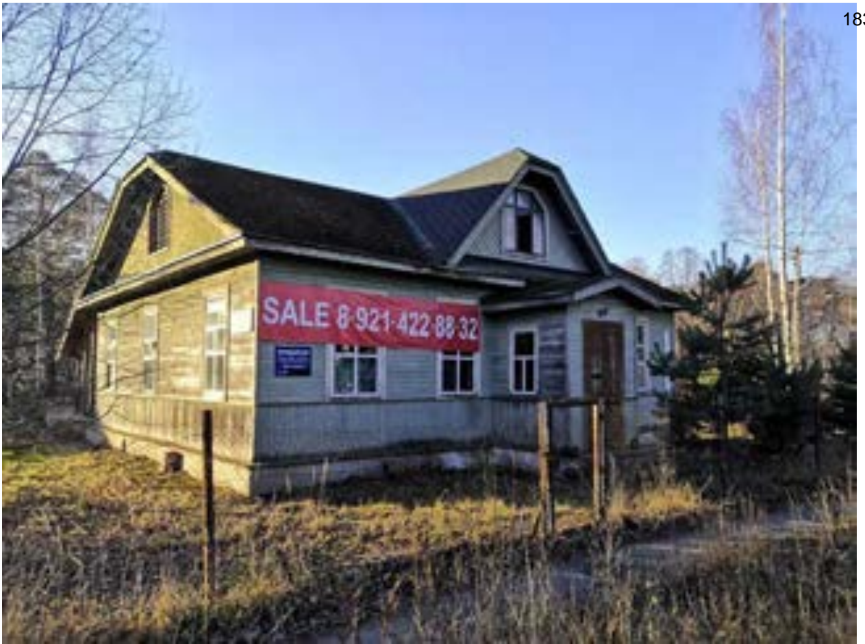
Фото.23. Амбулатория (ул. Приморская, 20) от 08.11.2021 г.
