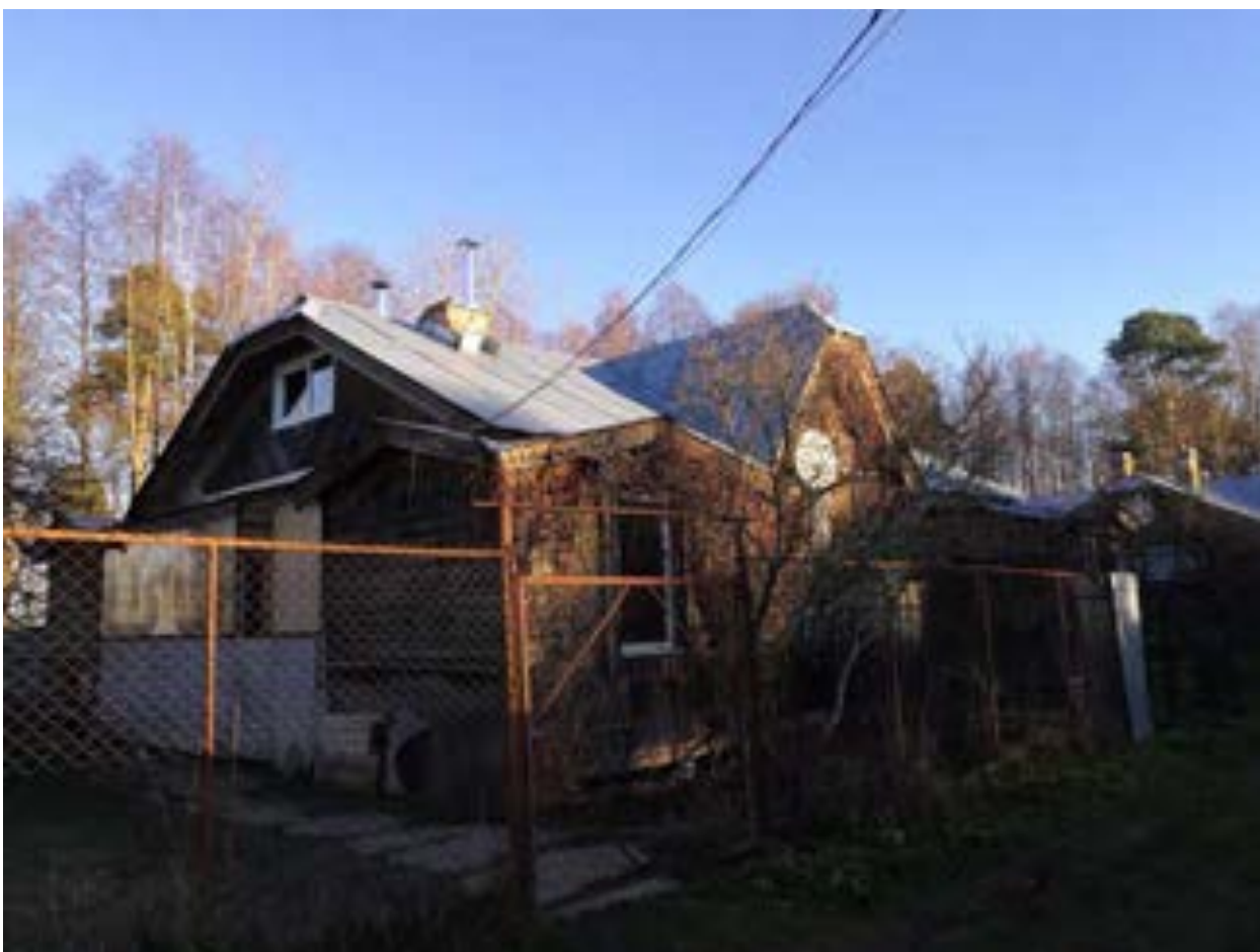
Фото.10. Дом пенсионеров-лоцманов (ул. Приморская, 12) от 08.11.2021 г.
