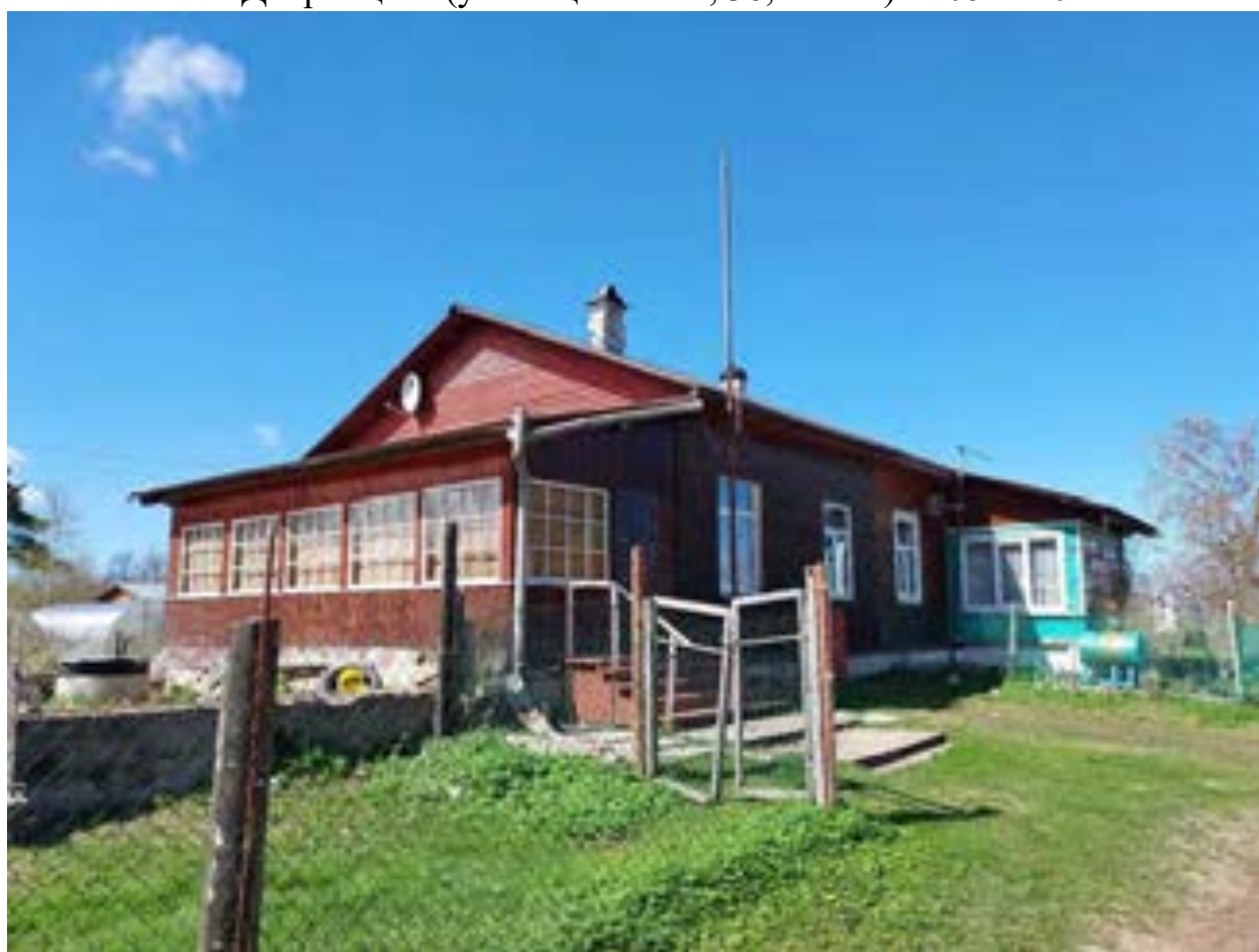
Фото.113. Дом священника (ул. Лоцманская, 14) от 4.05.2022 г.
