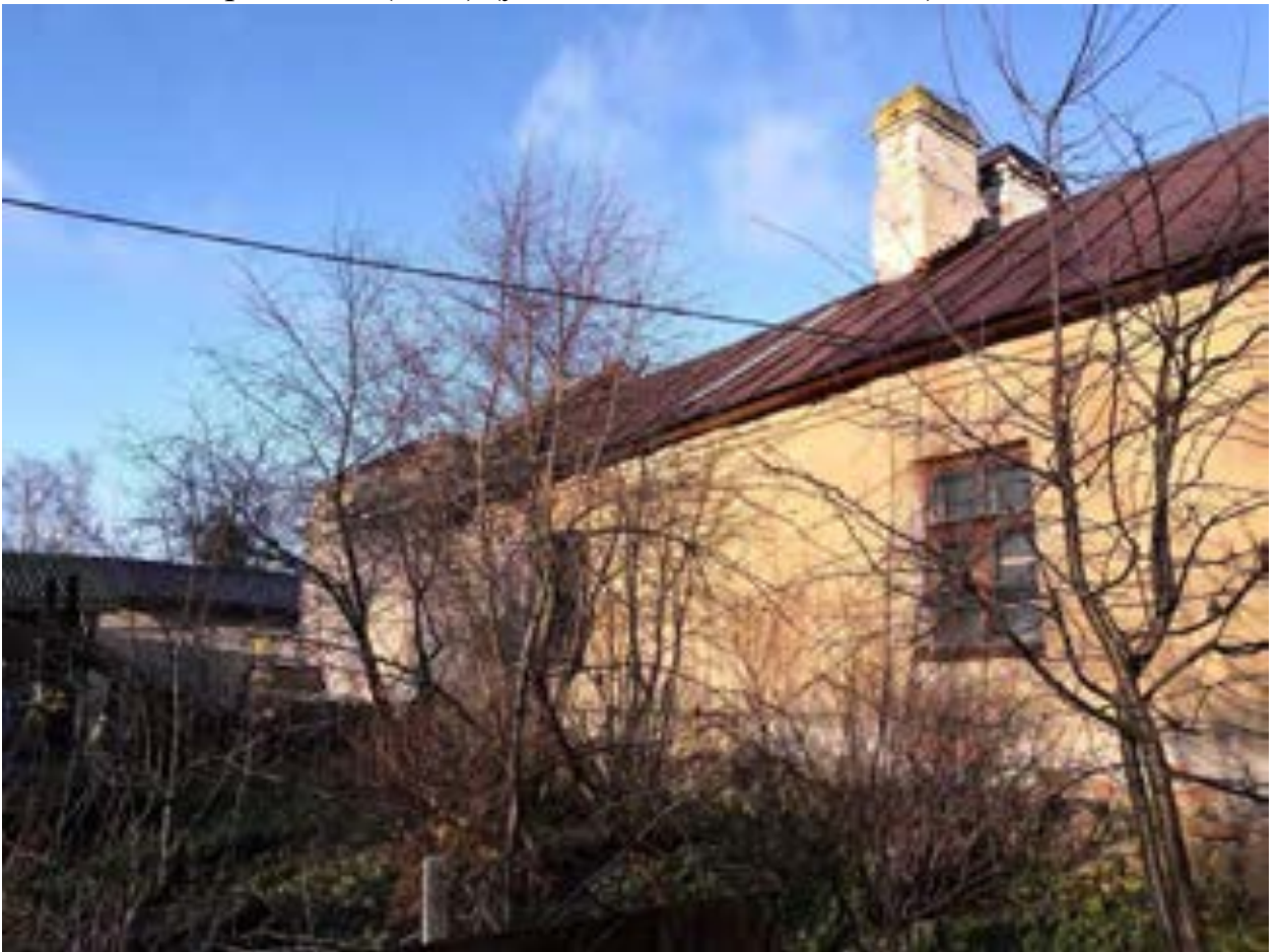
Фото.109. Прачечная (баня) (ул. Лоцманская, 36, лит. Г) от 08.11.2021 г.
