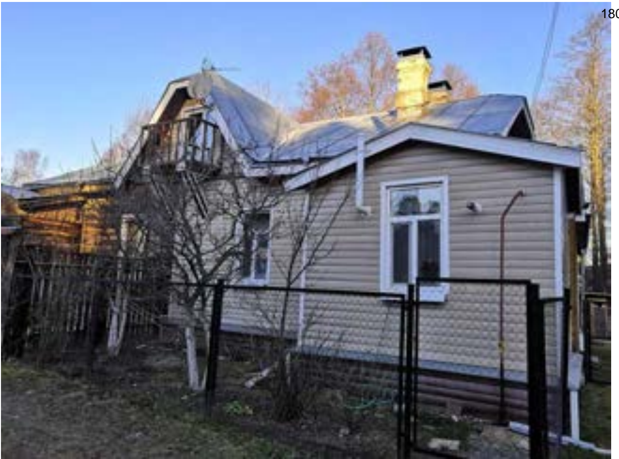
Фото.17. Дом пенсионеров-лоцманов (ул. Приморская, 16) от 08.11.2021 г.
