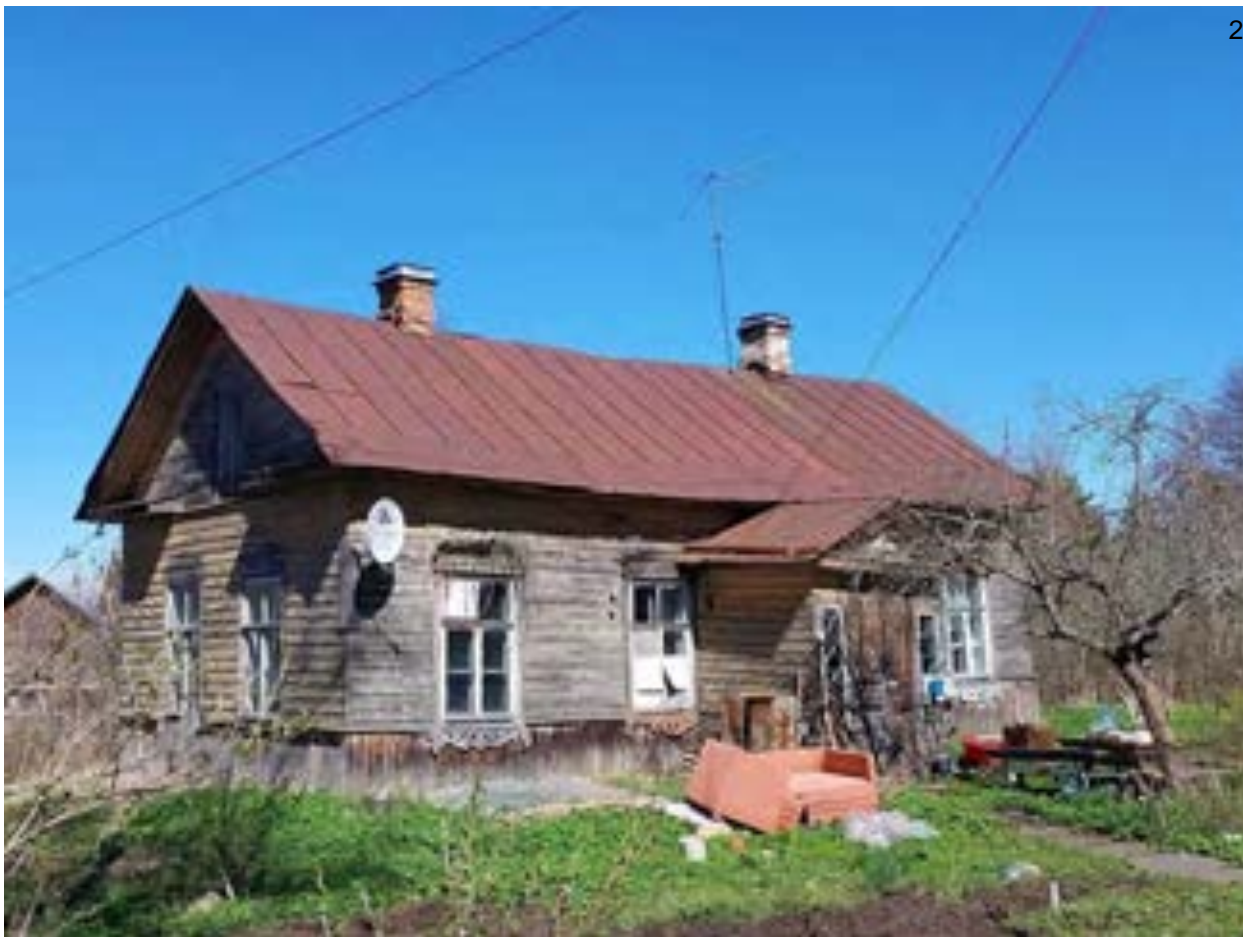
Фото.130. Дом-телефонная (ул. Приморская, 7) от 4.05.2022 г.
