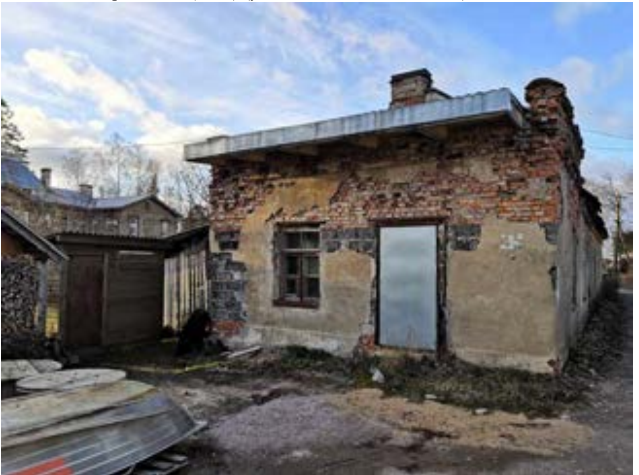
Фото.107. Прачечная (баня) (ул. Лоцманская, 36, лит. Г) от 08.11.2021 г.
