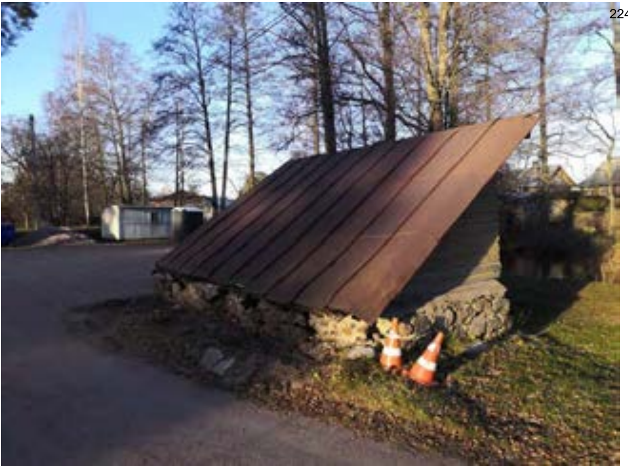
Фото.104. Ледник (ул. Лоцманская, 36, лит. Б) от 08.11.2021 г.
