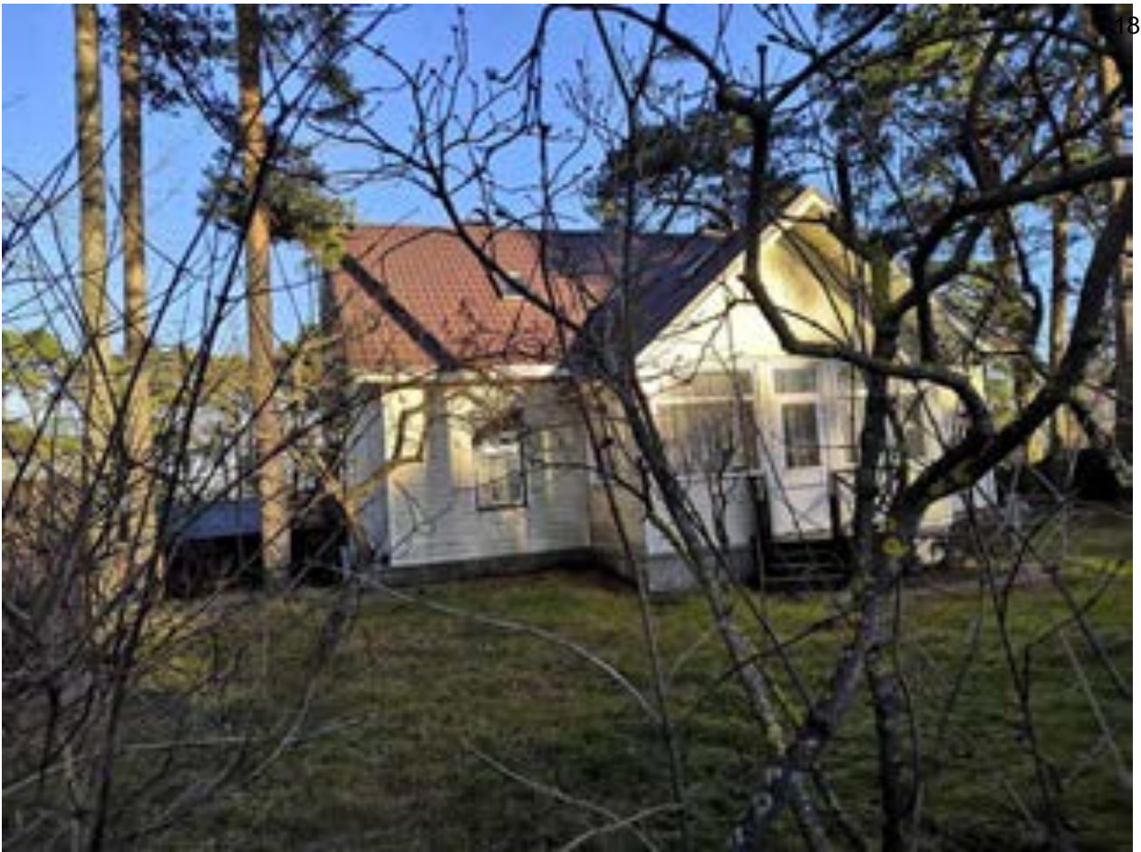
Фото.35. Дом лоцманов (ул. Приморская, 31) от 08.11.2021 г.
