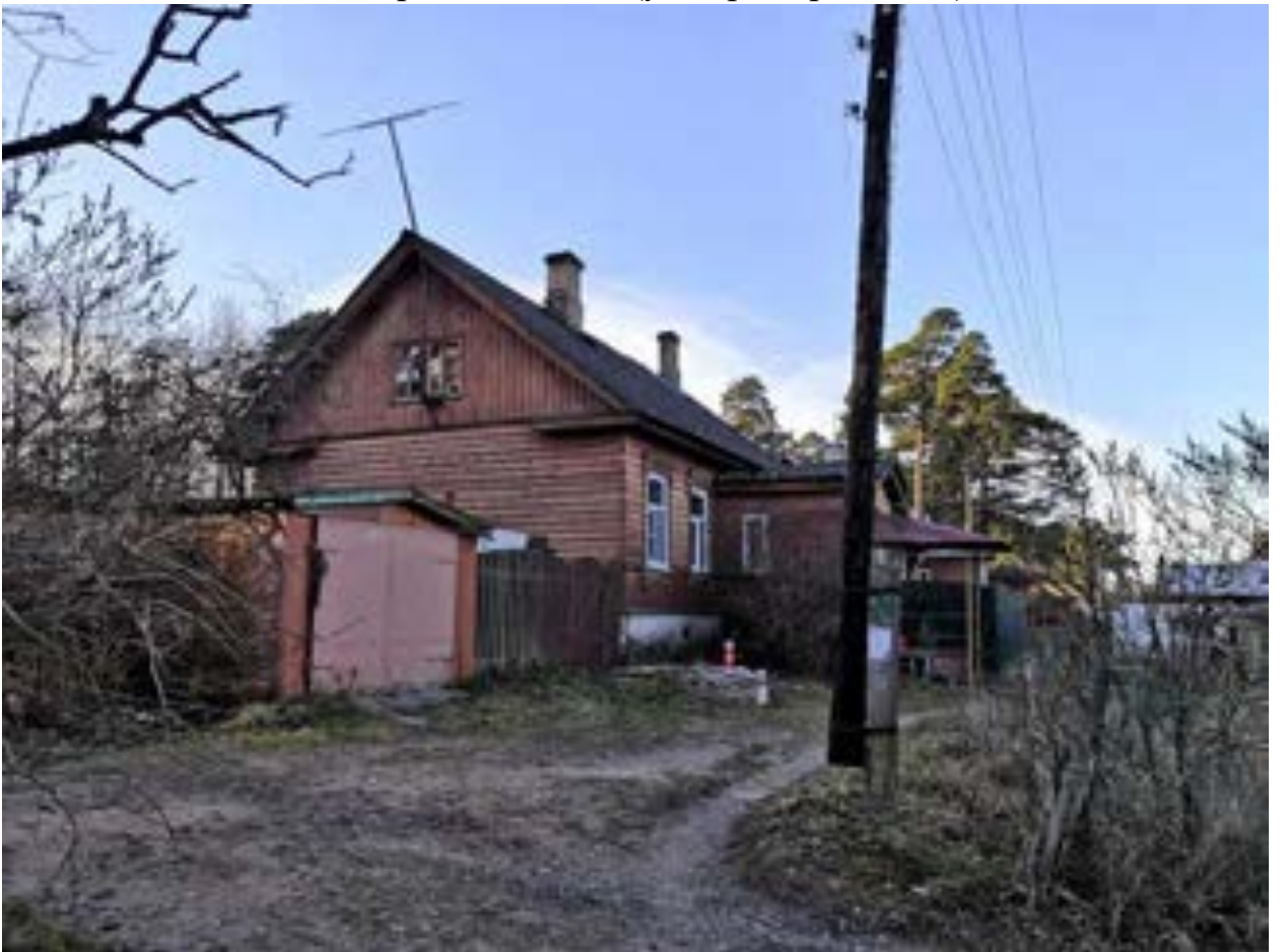
Фото.12. Дом лоцманов (ул. Приморская, 13) от 08.11.2021 г.
