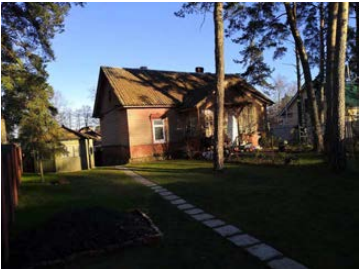
Фото.33. Дом лоцманов (ул. Приморская, 29) от 08.11.2021 г.
