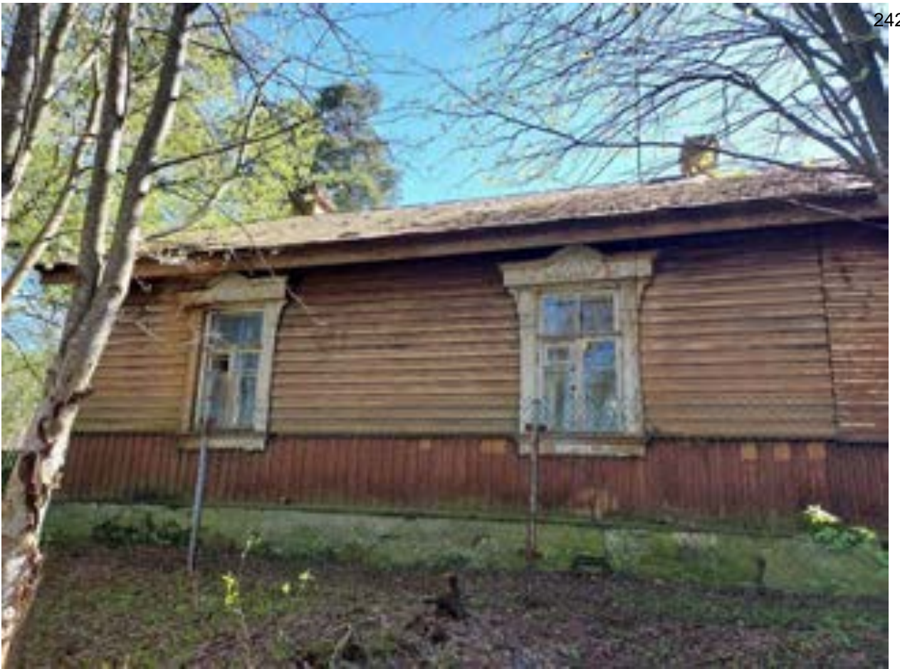
Фото.140. Дом дворника-сторожа для пенсионных домов (ул. Приморская, 8) от 4.05.2022 г.
