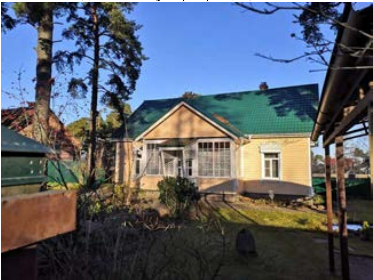
Фото.32. Дом лоцманов (ул. Приморская, 27) от 08.11.2021 г.
