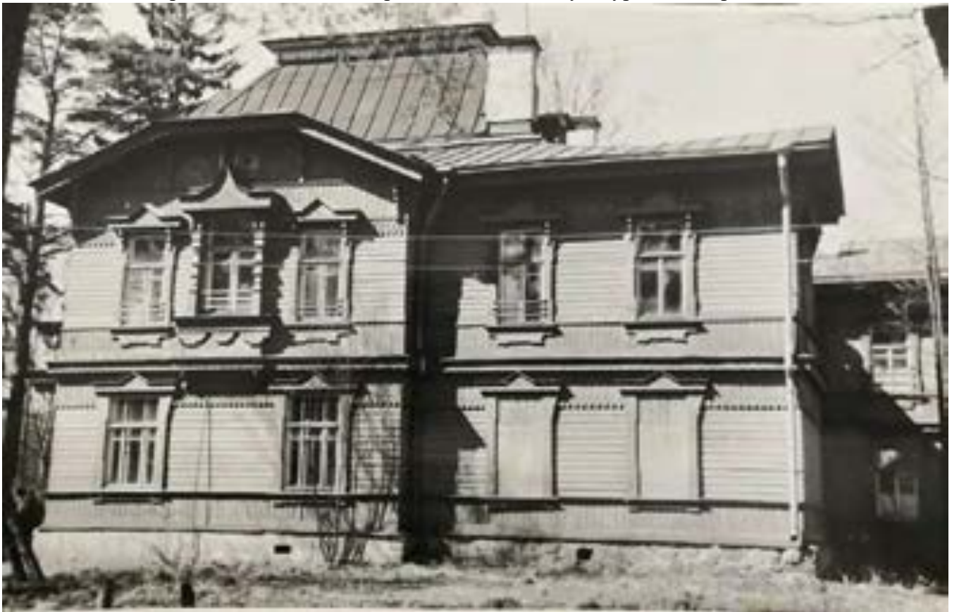
Илл.29. Дом лоцманского собрания с придомовой церковью. Вид на восточный фасад. 1991 г. / Архив комитета по культуре Ленинградской области
