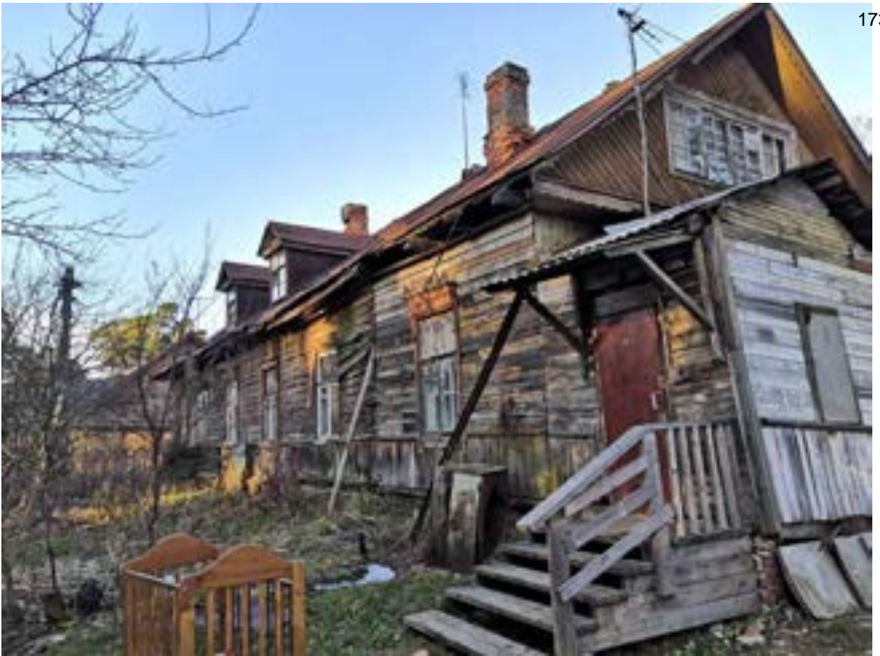
Фото.3. Общий вид на дом лоцманского командира (Приморская ул., 9) от 08.11.2021 г.
