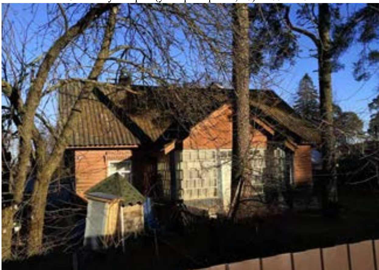
Фото.26. Дом лоцманов (ул. Приморская, 21) от 08.11.2021 г.
