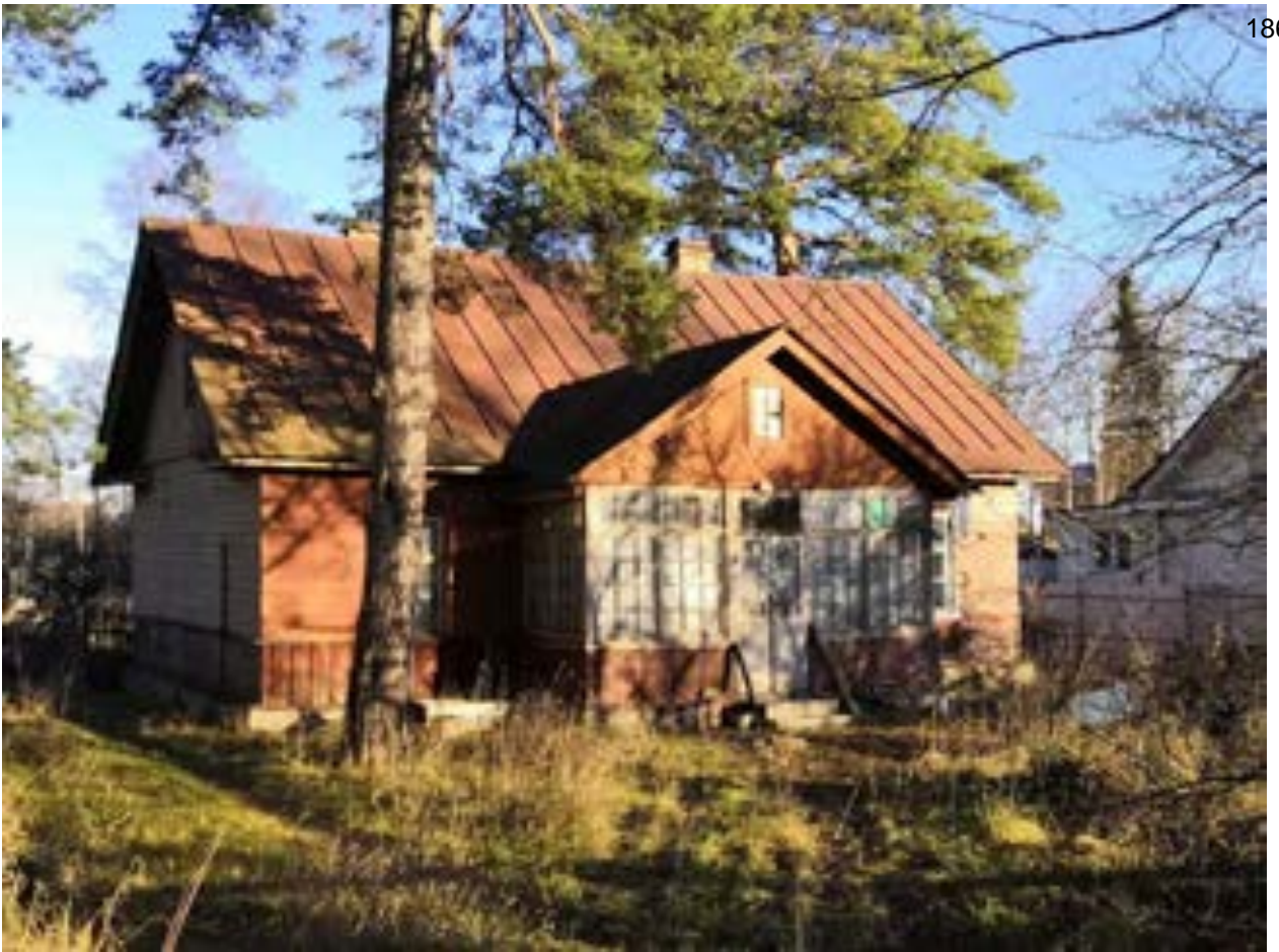
Фото.29. Дом лоцманов (ул. Приморская, 25) от 08.11.2021 г.
