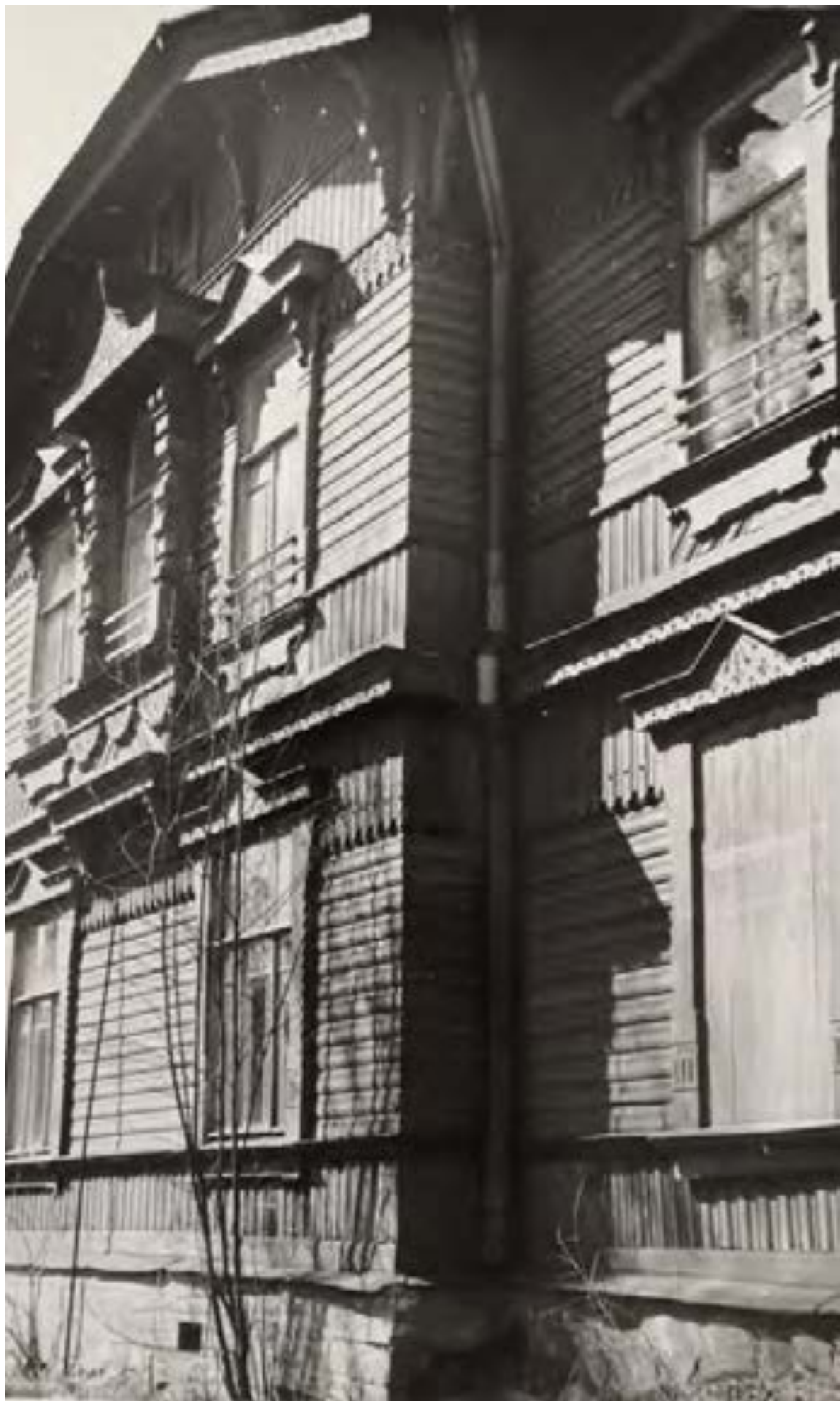
Илл.30. Дом лоцманского собрания с придомовой церковью. Вид с северо-востока. 1991 г. / Архив комитета по культуре Ленинградской области
