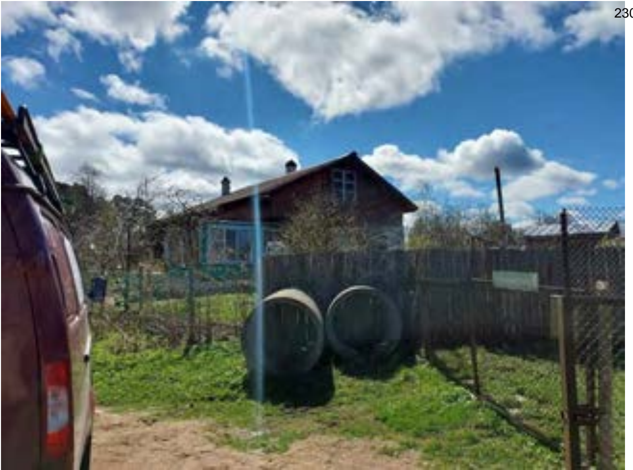
Фото.116. Дом священника (ул. Лоцманская, 14) от 4.05.2022 г.
