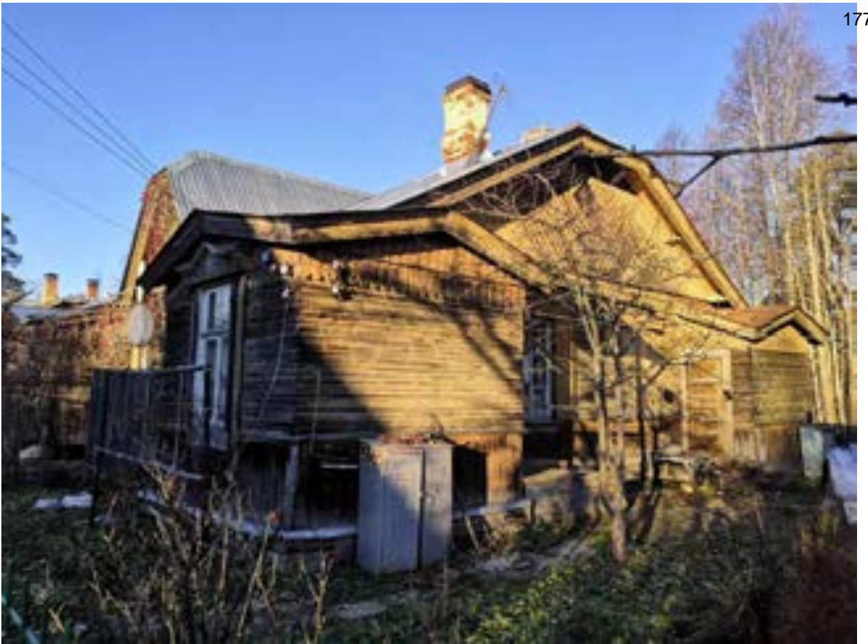
Фото.11. Дом пенсионеров-лоцманов (ул. Приморская, 12) от 08.11.2021 г.
