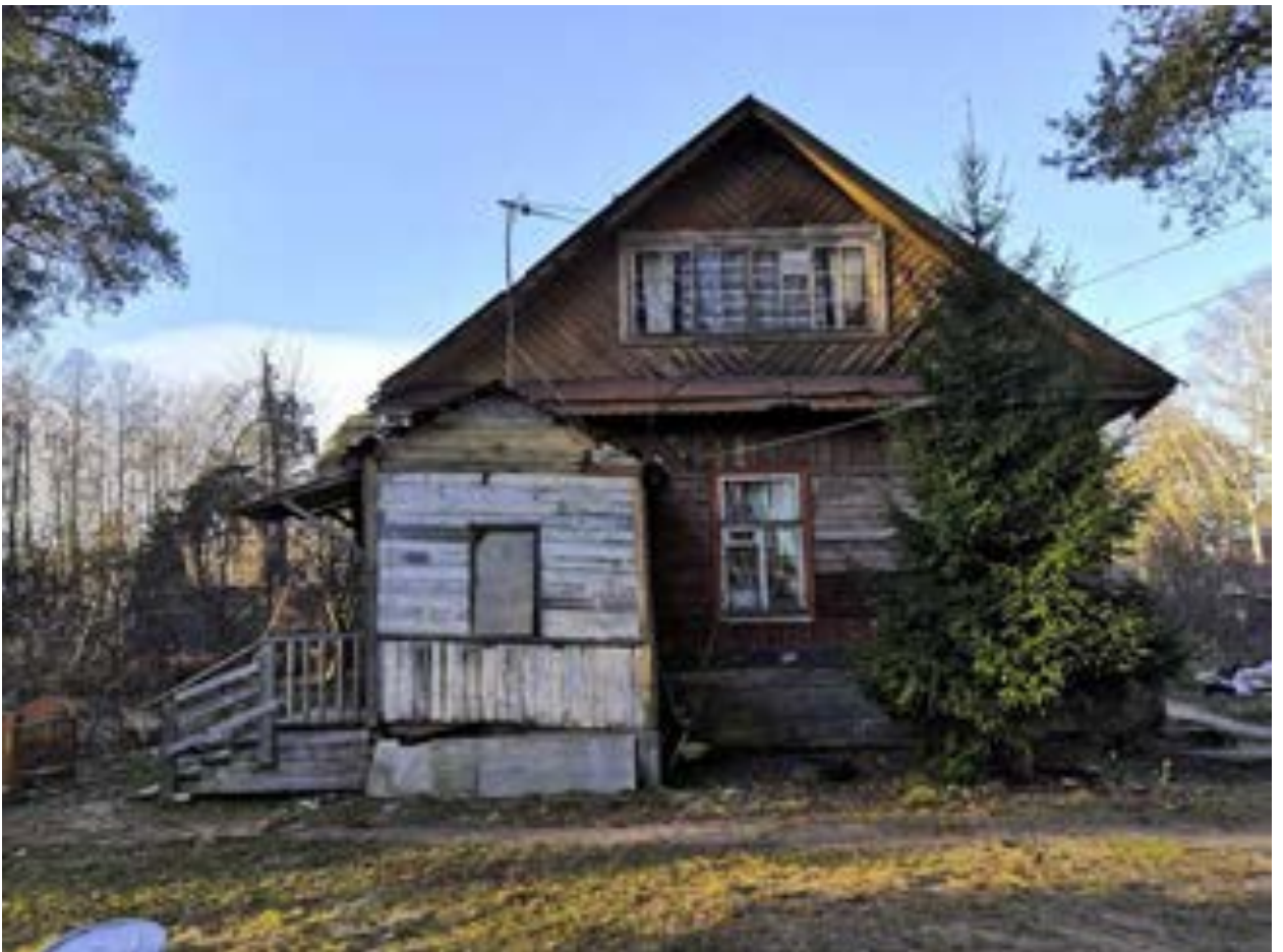
Фото.4. Общий вид на дом лоцманского командира (Приморская ул., 9) от 08.11.2021 г.
