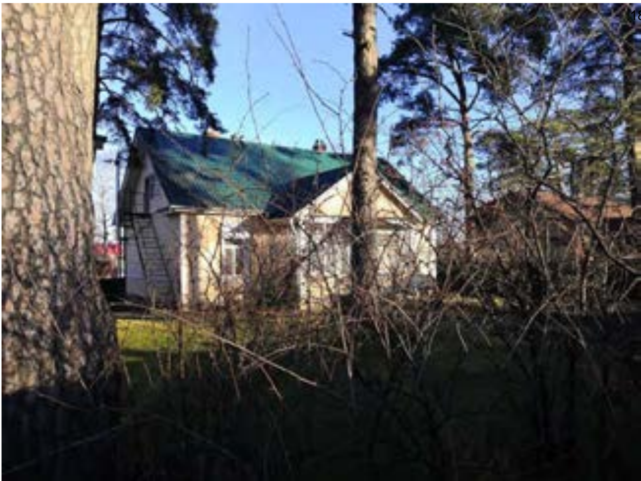
Фото.31. Дом лоцманов (ул. Приморская, 27) от 08.11.2021 г.
