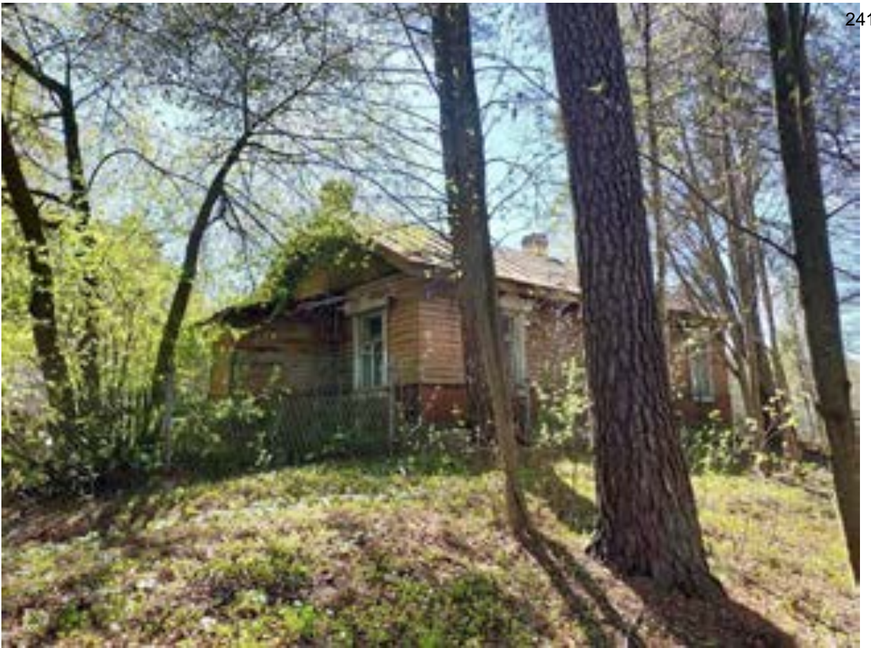
Фото.138. Дом дворника-сторожа для пенсионных домов (ул. Приморская, 8) от 4.05.2022 г.
