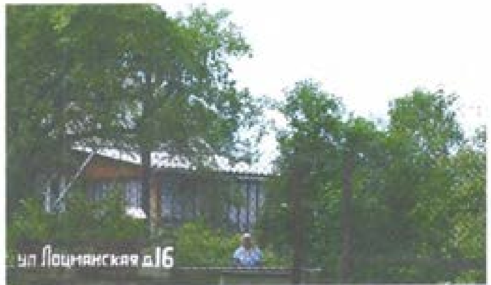
Вид здания с улицы Лоцманской. Фото 2019 год.
