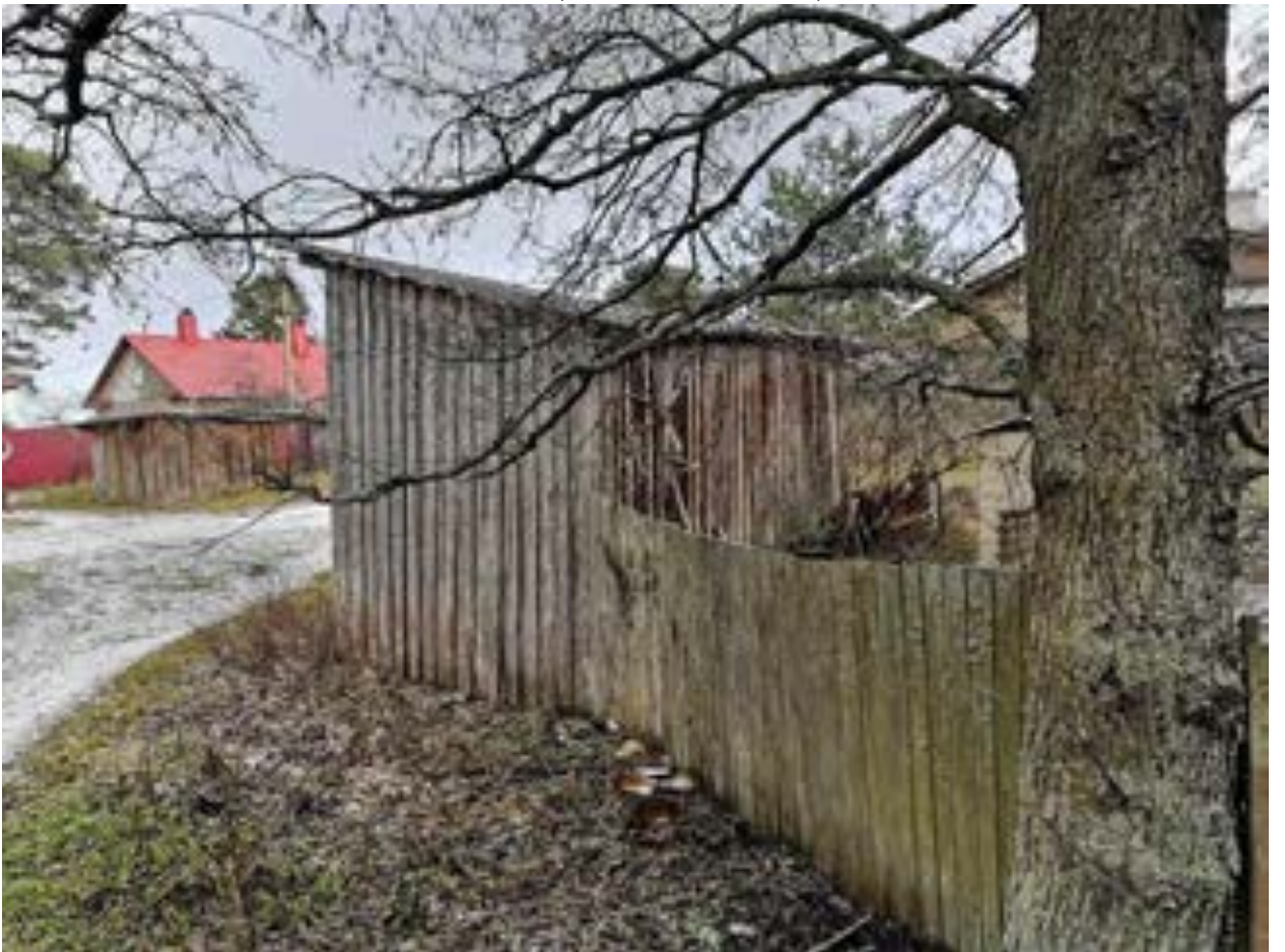
Фото.70. Общий вид на хозяйственные строения при дома лоцмана от 08.11.2021 г.
