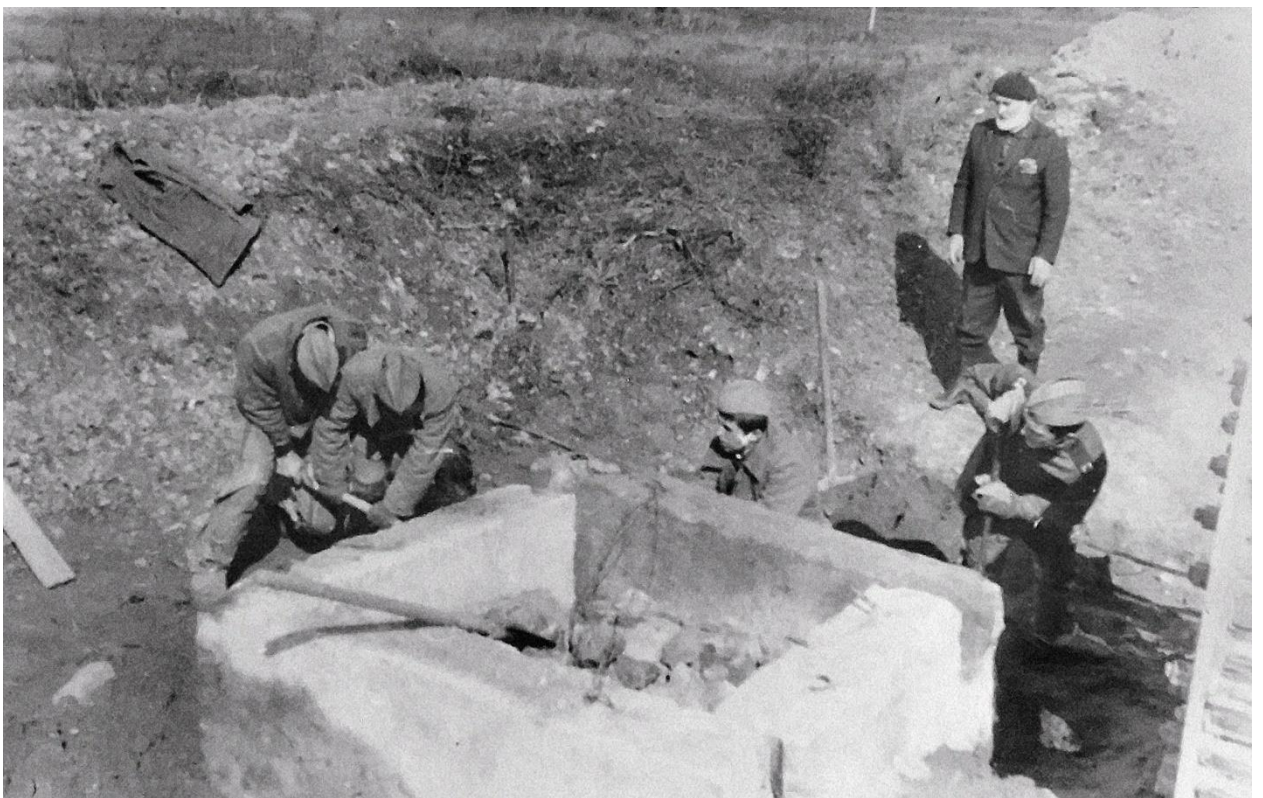
Илл.53. Строительство мемориала «Взрыв». Закладка бетонного основания под станину орудия. Фото, 1987 г. СПб БУ «Краеведческий музей г.Ломоносова».
