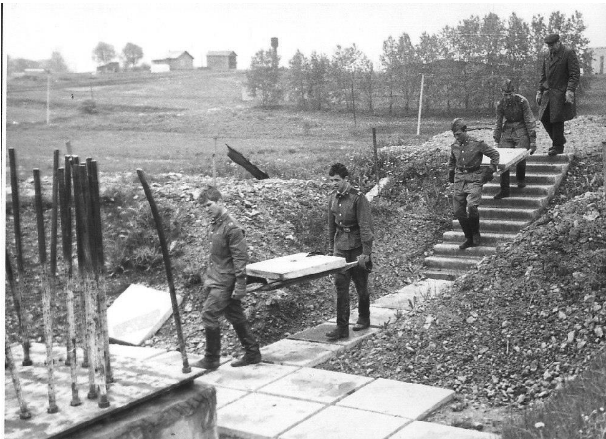
Илл.54. Строительство мемориала «Взрыв». Фото, 1987 г. СПб БУ «Краеведческий музей г.Ломоносова».
