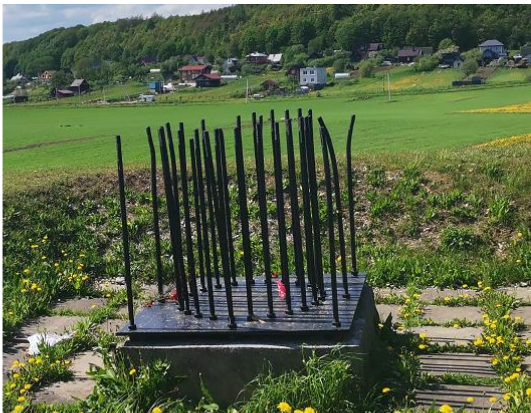
Фото 12. ОКН регионального значения «Памятный знак «Взрыв», на рубеже обороны Ленинграда, где в августе 1941 г. находилось одно из орудий крейсера «Аврора» и где сражались моряки-артиллеристы КФБ, в составе батареи из 9 орудий». Станина второго орудия. Фото 19.05.2022 г.
