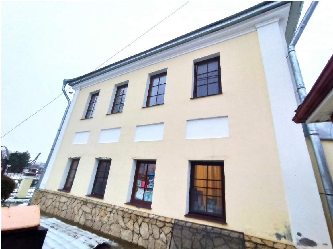
6. Восточный фасад объекта.
