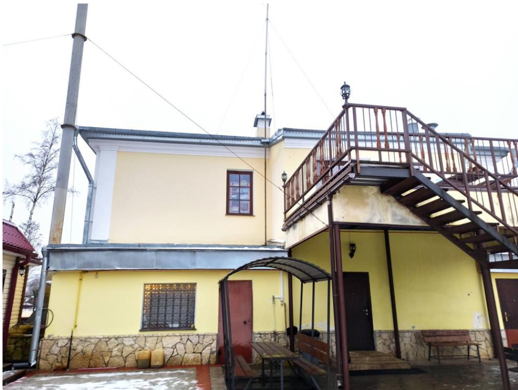
4. Вид здания с севера.
