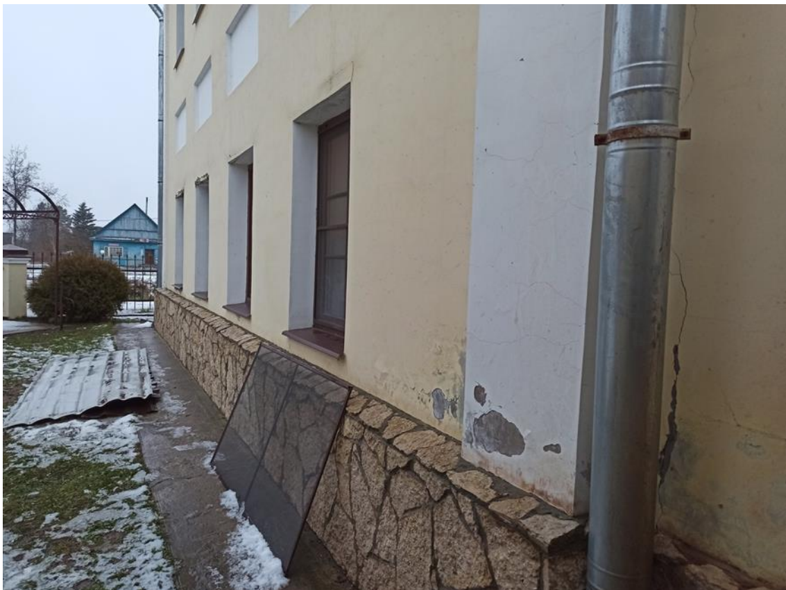
7. Фрагмент восточного фасад объекта.
