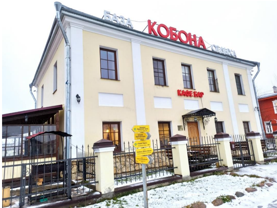
1. Вид здания с юга.
