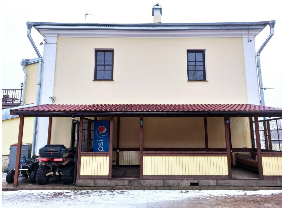
2. Вид здания с запада.
