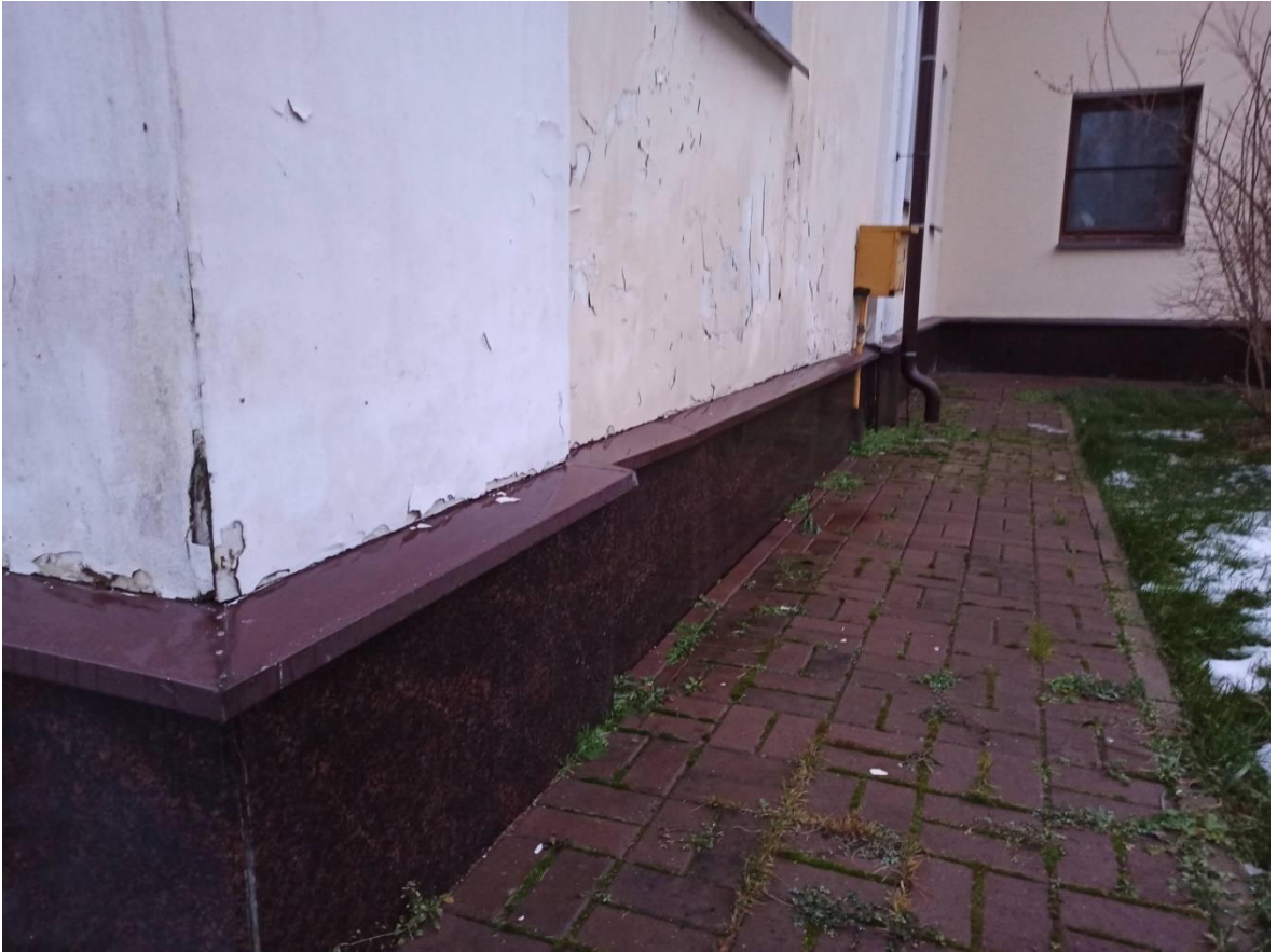
9. Фрагмент фасада объекта.
