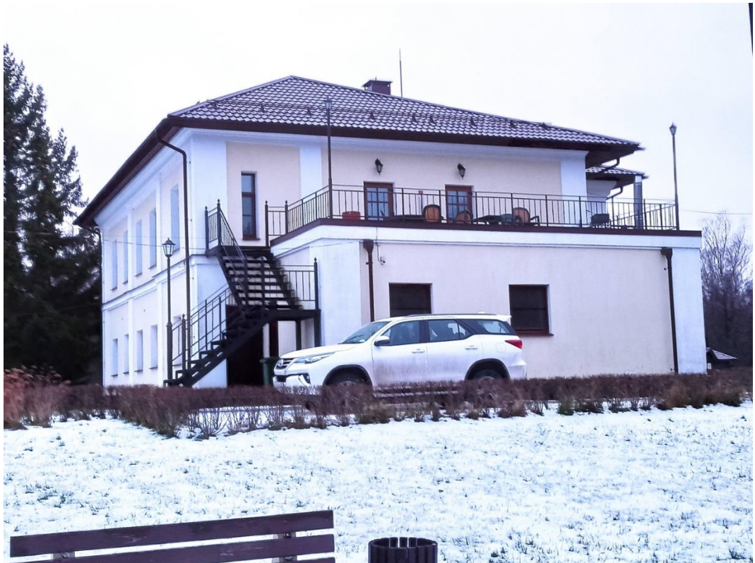
6. Вид обьекта с востока.
