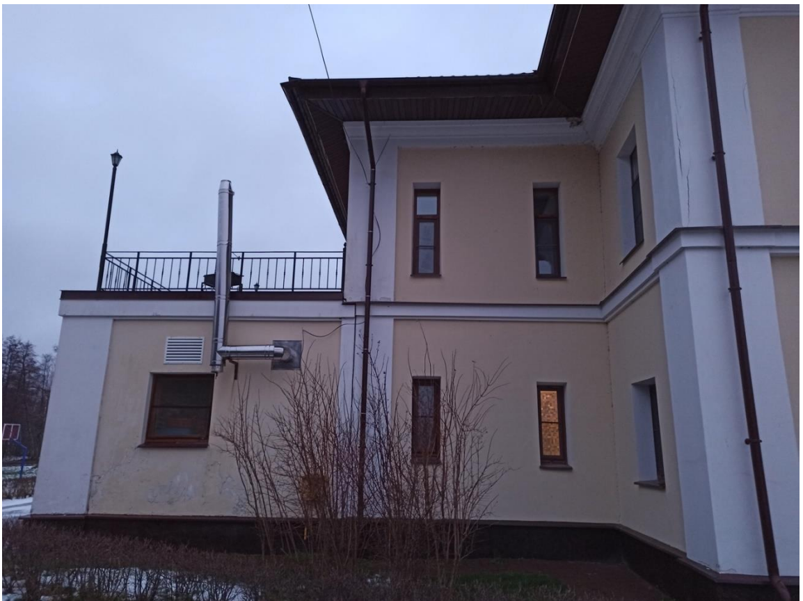
10. Фрагмент фасада объекта.
