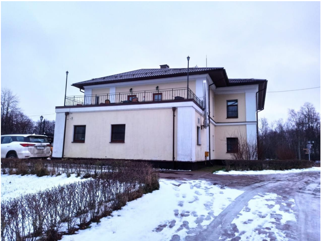
7. Вид обьекта с востока.
