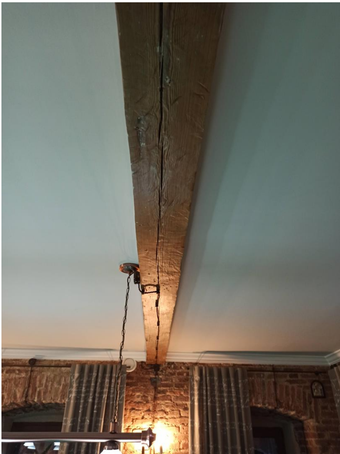
15. Интерьер одного из помещений объекта. Потолочная балка.
