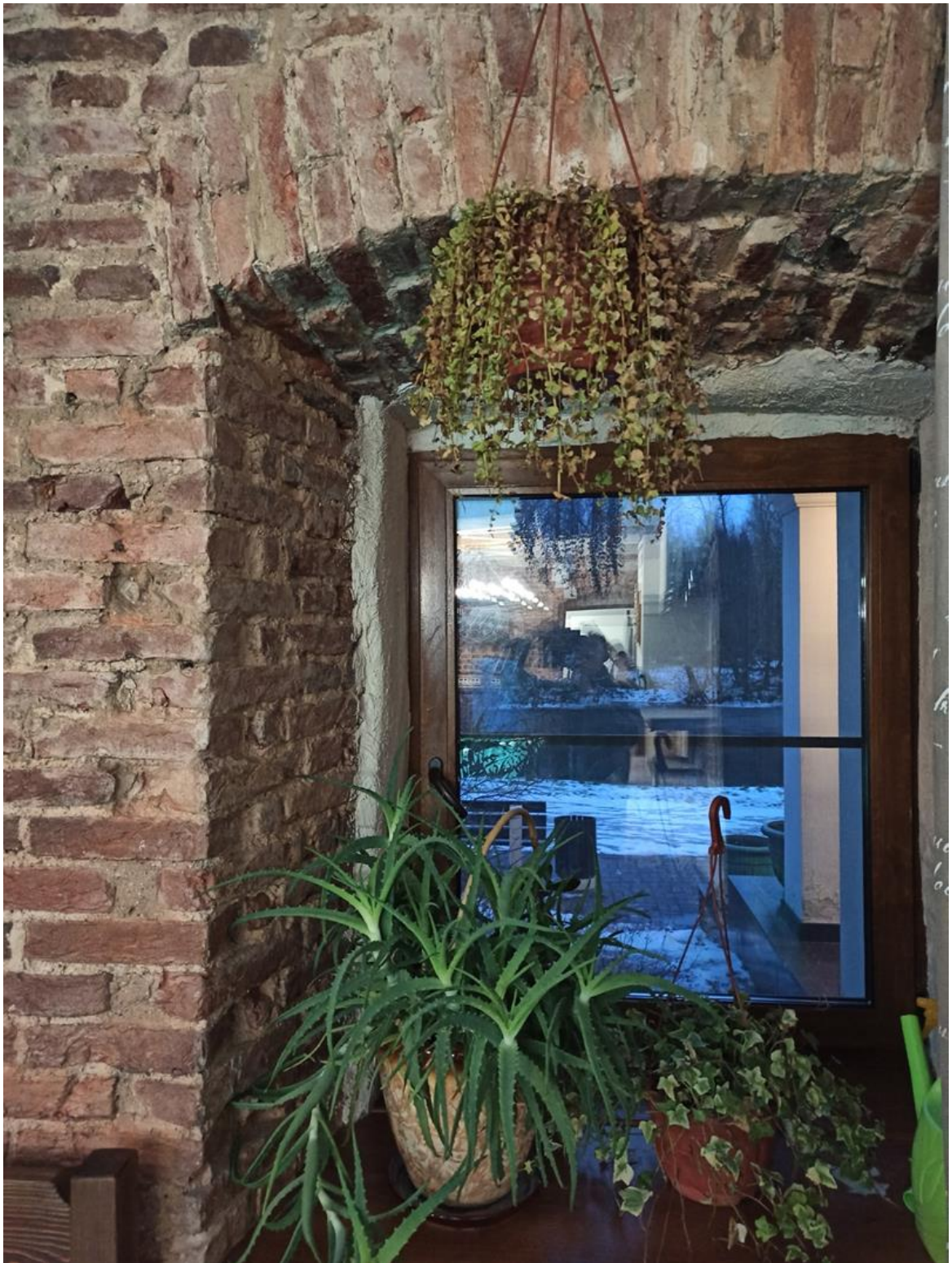
14. Интерьер одного из помещений объекта. Оконный проем.
