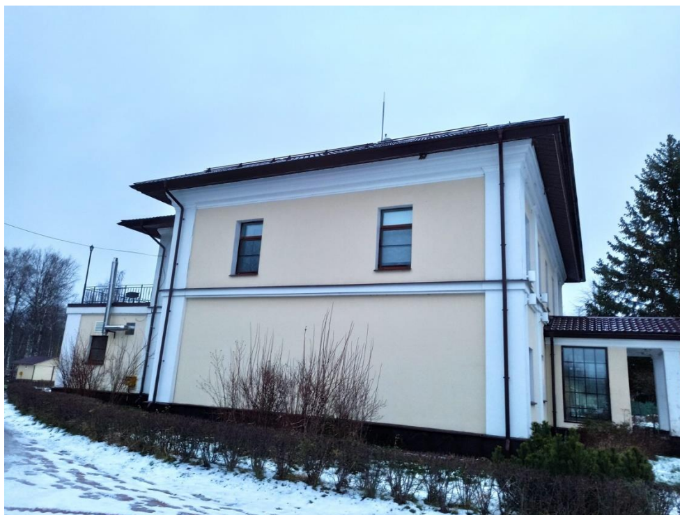
2. Вид объекта с севера.
