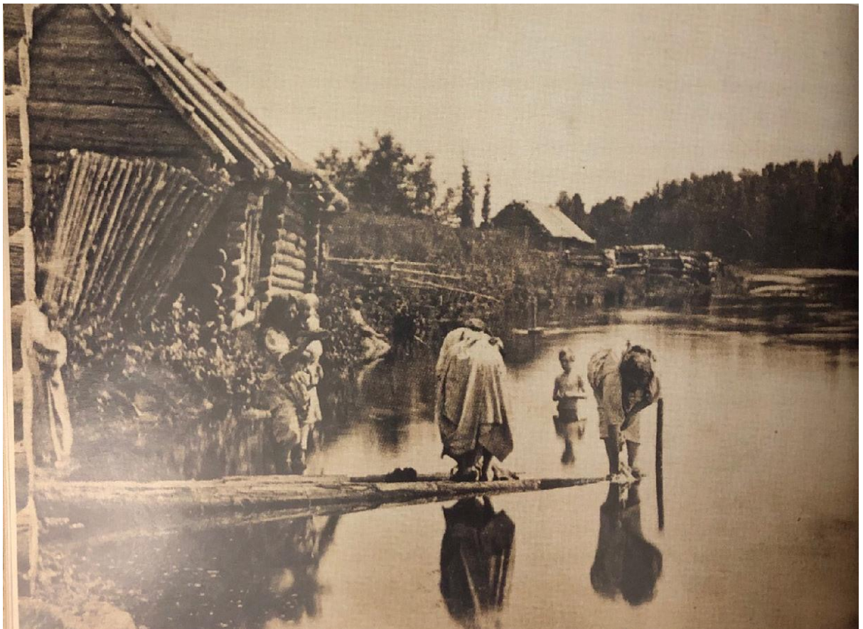
13. 1860-е гг. На Староладожском канале. Фото В.Каррика. Воспр. по кн.: Безносюк И. Земли Путиловской минувшая судьба. СПб, 2012 г.
