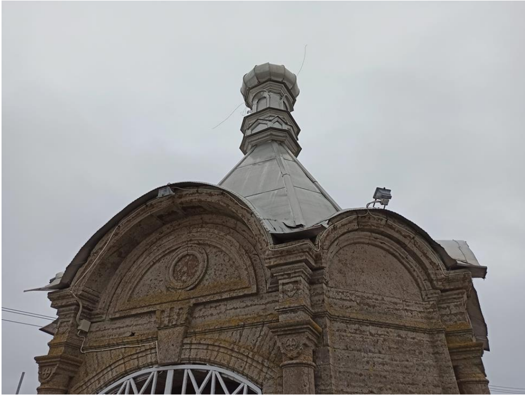
8. Фрагмент фасада объекта.
