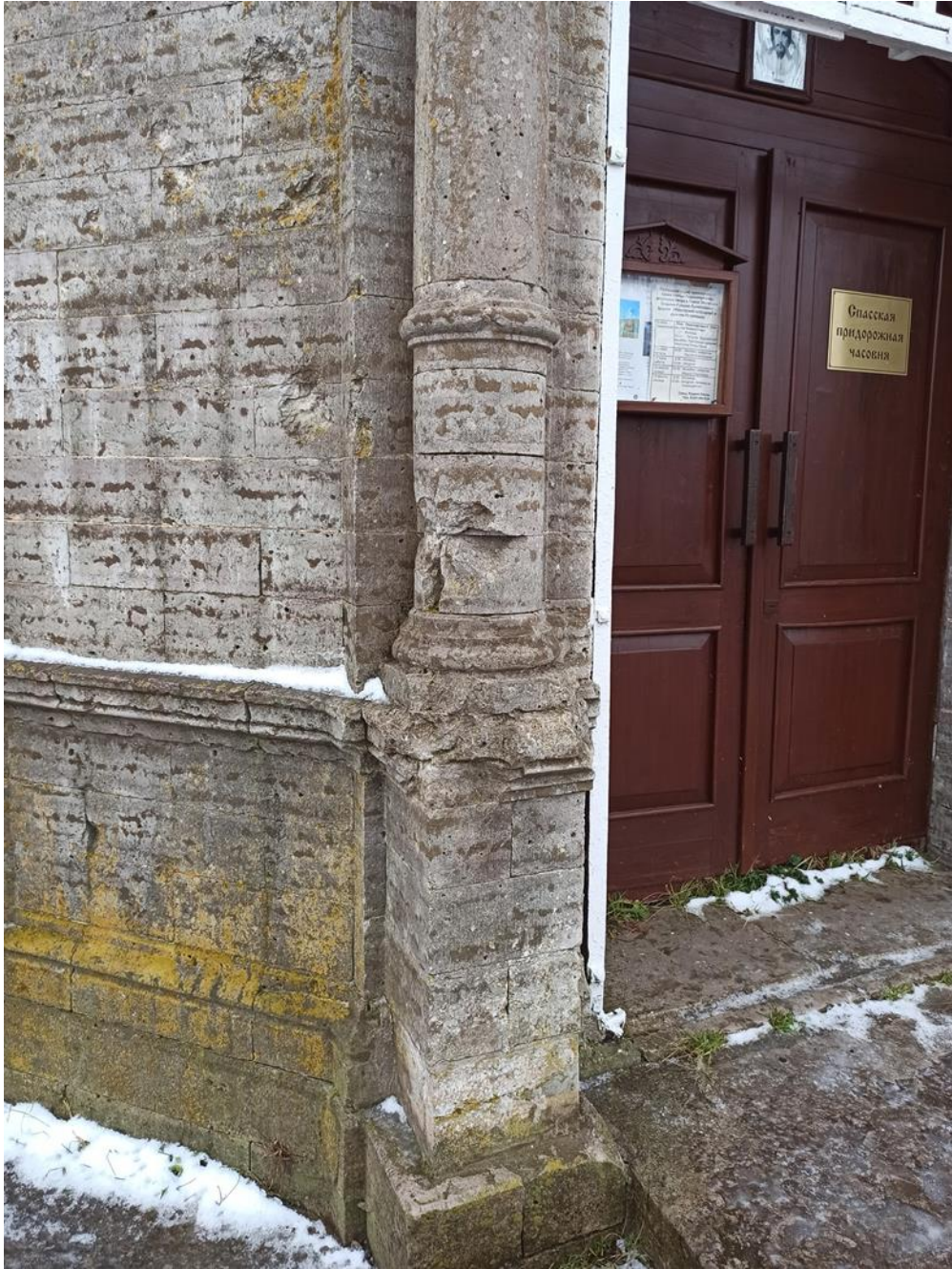
9. Фрагмент фасада объекта.
