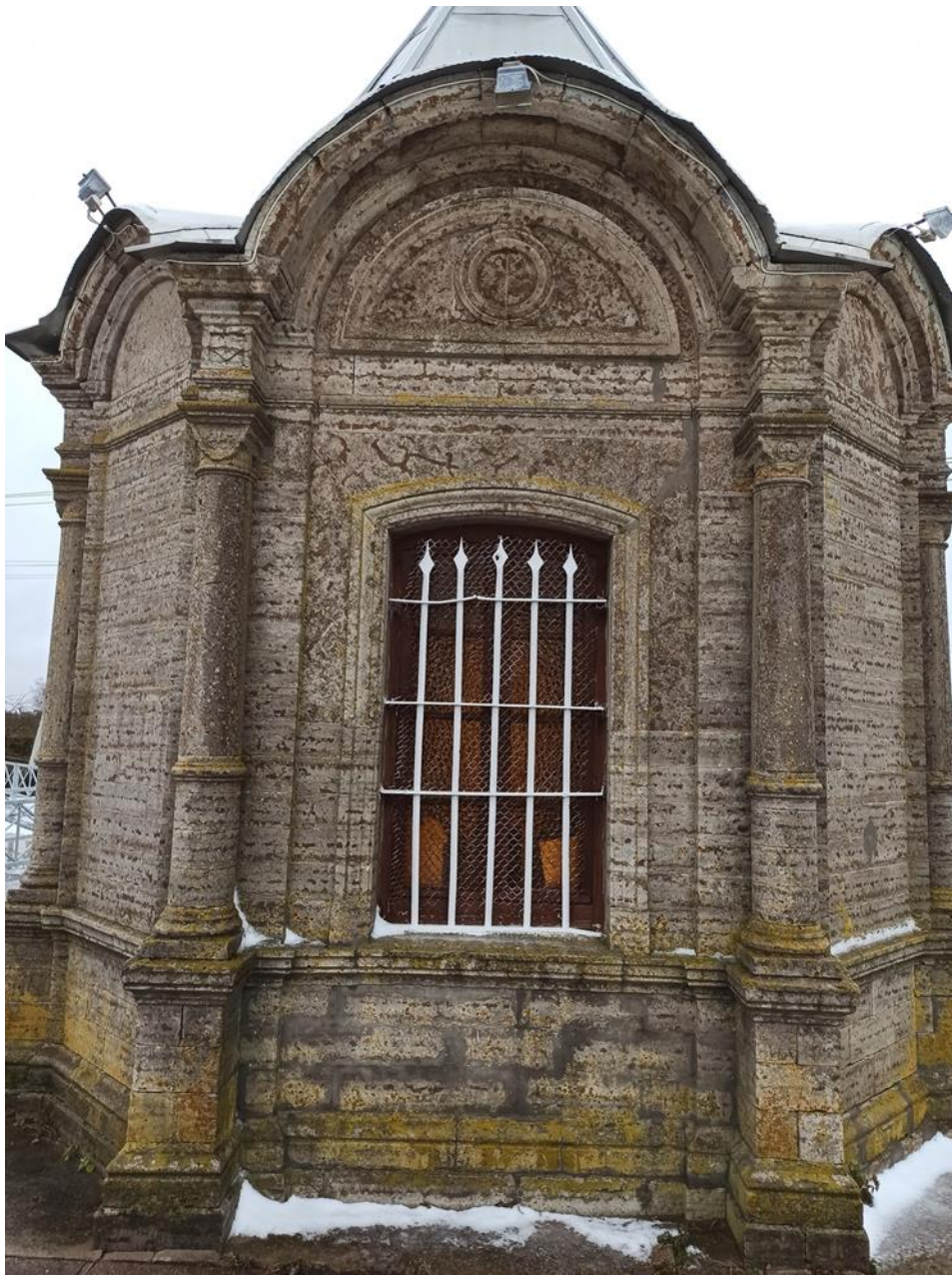
7. Южный фасад объекта.
