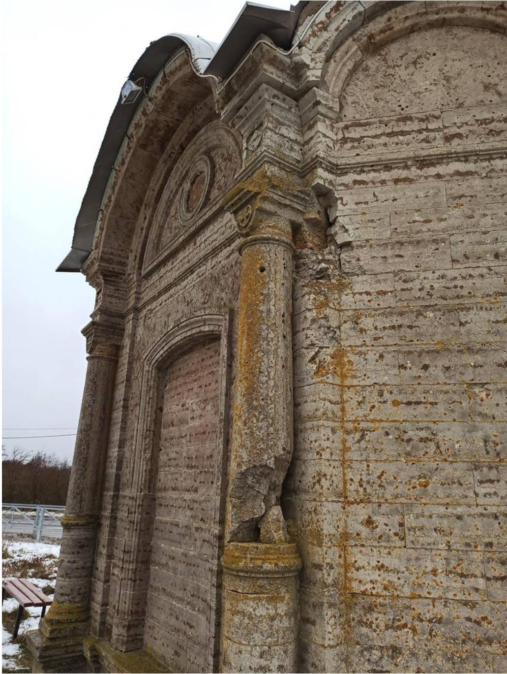
3. Фрагмент фасада объекта.
