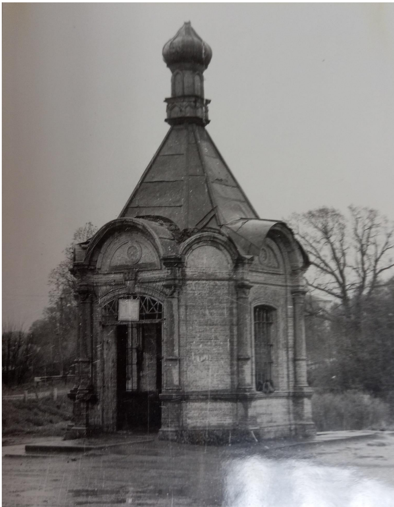
22. 1997 г. Часовня из плитняка между с. Путилово и Горная Шальдиха. Воспр. по: Лермонтова М.А. Старо-Ладожский канал. История строительства и архитектура его зданий и сооружений. Диссертация на соискание ученой степени кандидата искусствоведения. РАХ, СПб Государственный академический институт живописи, скульптуры и архитектуры им. И.Е. Репина, 1997, с.427
