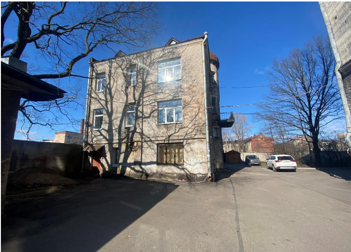
Фото 2. Общий вид здания с юго-запада. Дата съемки: 11.04.2022 г. Автор: Прокофьев М.Ф.
