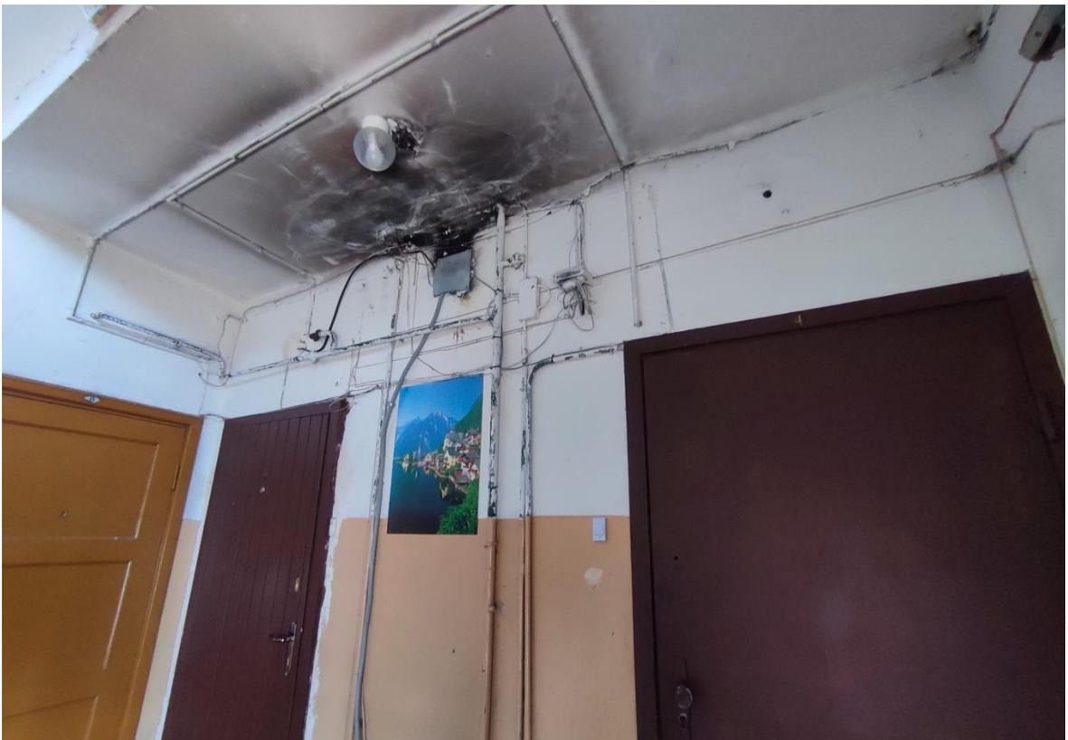
Фото 8. 2-ой этаж лестничной клетки ЛК-1. Следы возгорания кабеля. Расположение электропроводки по стенам с нарушением способа прокладки. Провода сетей связи не закреплены. Аварийное освещение отсутствует. Дата съемки: 11.04.2022 г. Автор: Глинская Н.Б.
