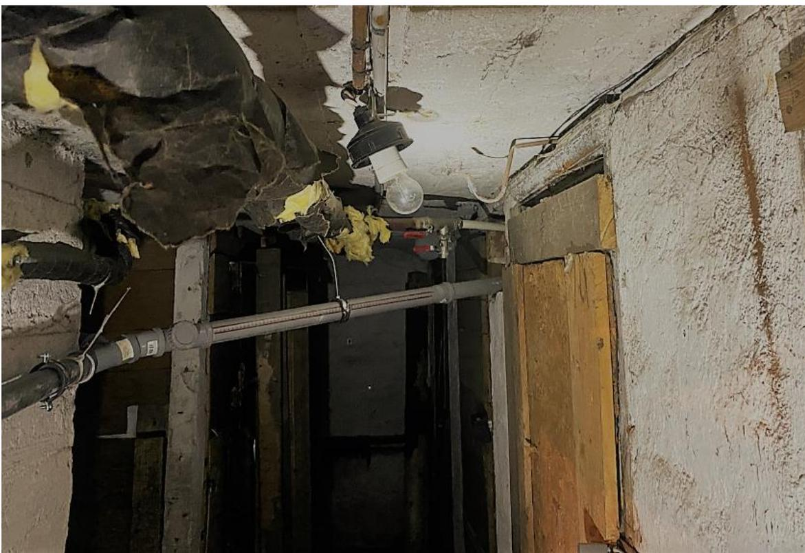
Фото 5. Подвал. Отсутствует плафон светильника.
