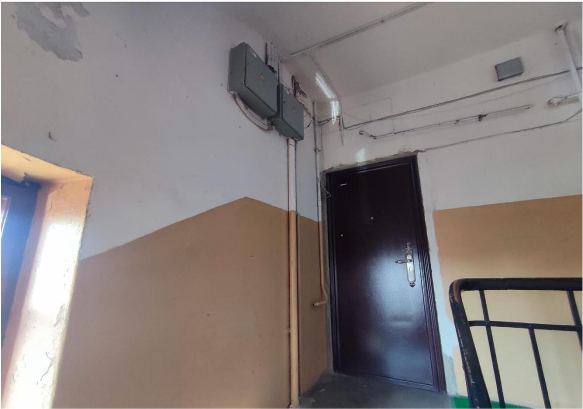
Фото 11. 3-ий этаж лестничной клетки ЛК-2. Расположение электропроводки по стенам с нарушением способа прокладки. Провода сетей связи не закреплены. Дата съемки: 11.04.2022 г. Автор: Глинская Н.Б.
