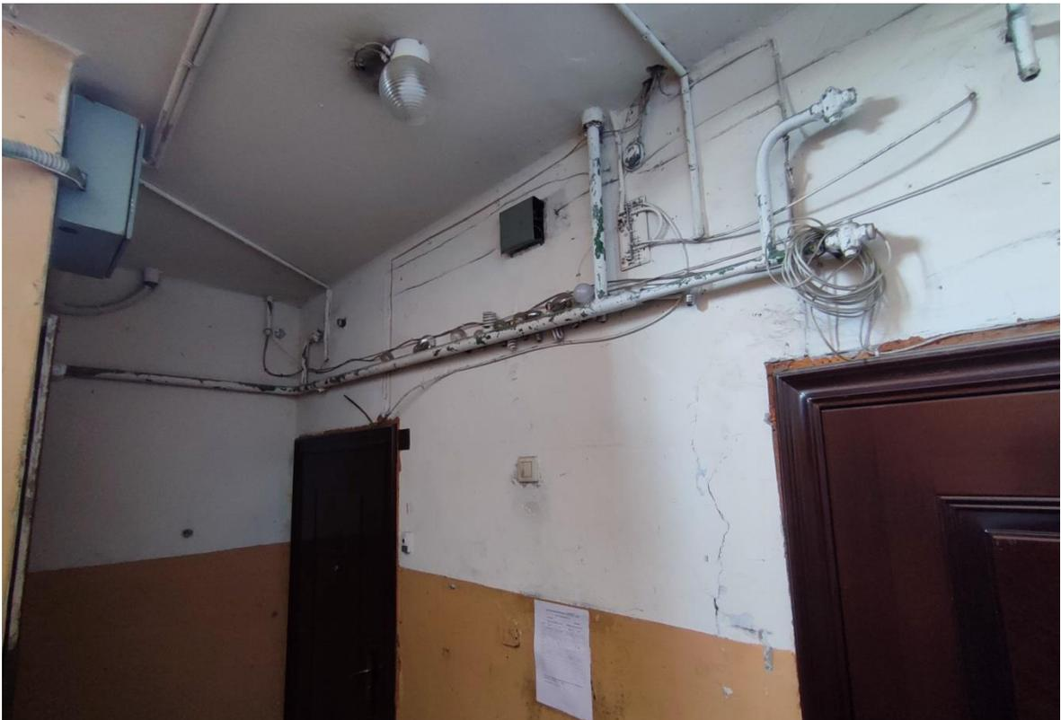
Фото 7. 1-ый этаж лестничной клетки ЛК-2. Расположение электропроводки по стенам с нарушением способа прокладки. Провода сетей связи не закреплены. Аварийное освещение отсутствует. Дата съемки: 11.04.2022 г. Автор: Глинская Н.Б.
