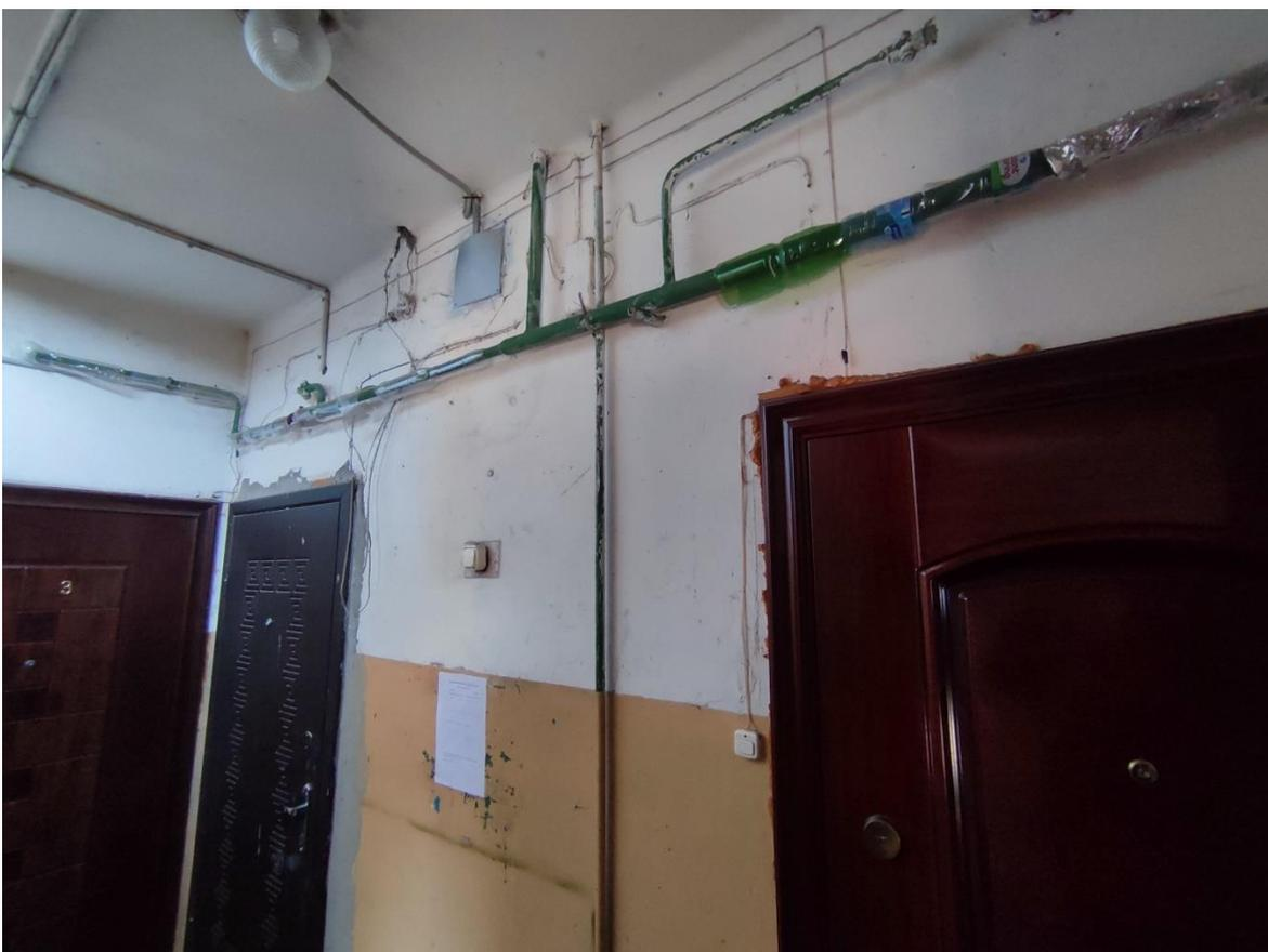
Фото 6. 1-ый этаж лестничной клетки ЛК-1. Расположение электропроводки по стенам с нарушением способа прокладки.
