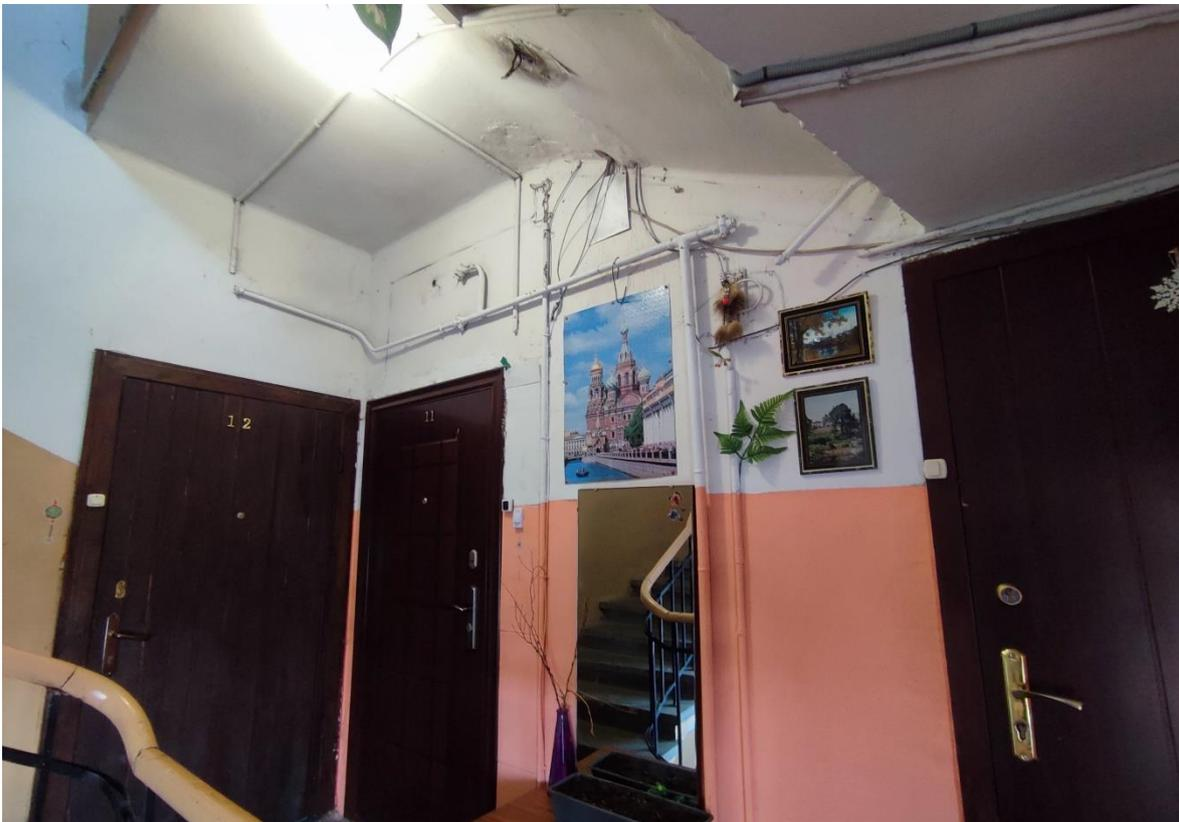
Фото 12. 4-ый этаж лестничной клетки ЛК-1. Расположение электропроводки по стенам с нарушением способа прокладки. Провода сетей связи не закреплены. Дата съемки: 11.04.2022 г. Автор: Глинская Н.Б.
