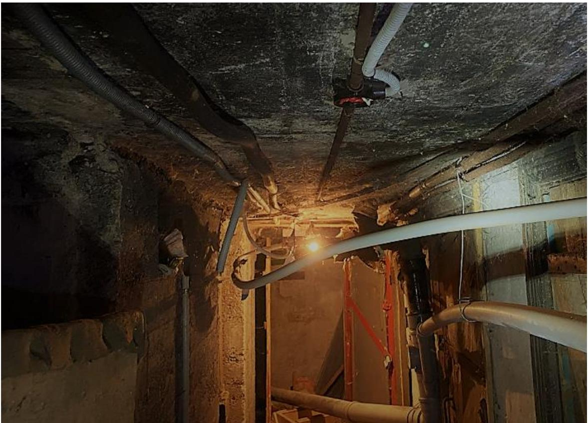
Фото 4. Подвал. Вскрыта распределительная коробка. Отсутствует плафон светильника.
