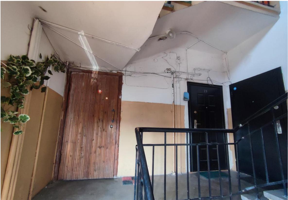
Фото 13. 4-ый этаж лестничной клетки ЛК-2. Расположение электропроводки по стенам с нарушением способа прокладки. Провода сетей связи не закреплены. Аварийное освещение отсутствует. Дата съемки: 11.04.2022 г. Автор: Глинская Н.Б.
