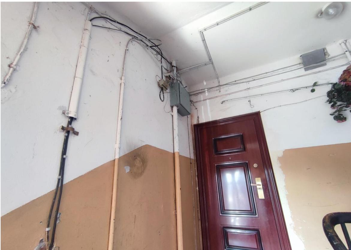
Фото 9. 2-ой этаж лестничной клетки ЛК-2. Расположение электропроводки по стенам с нарушением способа прокладки.
