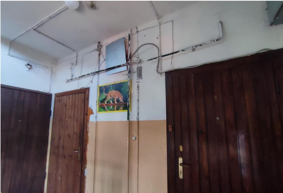
Фото 10. 3-ий этаж лестничной клетки ЛК-1. Расположение электропроводки по стенам с нарушением способа прокладки. Провода сетей связи не закреплены.
