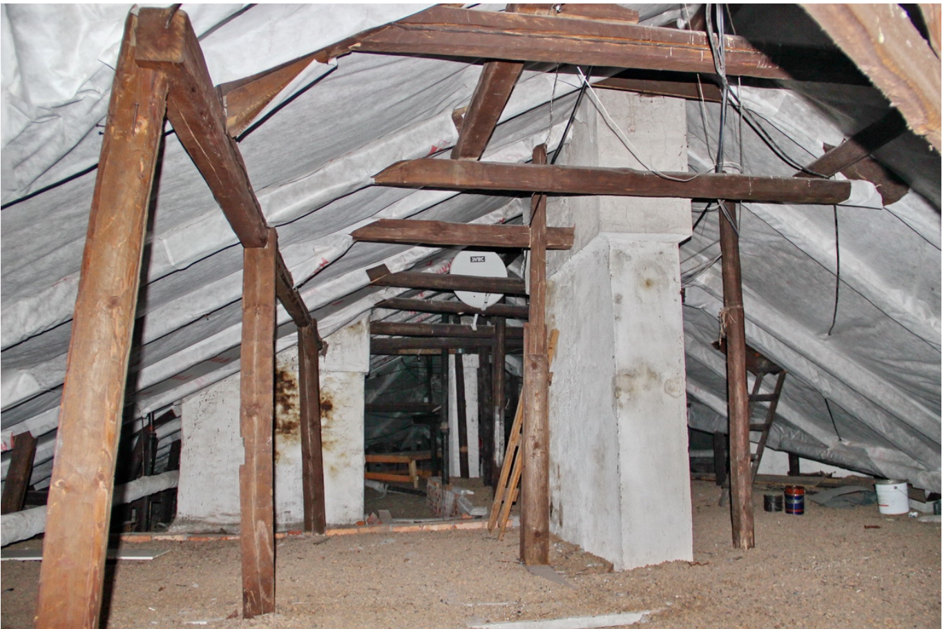
8 ОКН регионального значения “Жилой дом” ул. Выборгская, д. 1. Чердак. Дата съемки: 13.10.2021 г.
