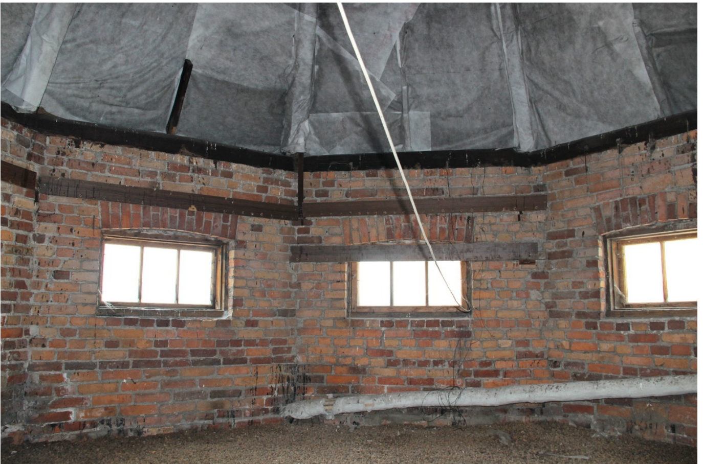
10 ОКН регионального значения “Жилой дом” ул. Выборгская, д. 1. Чердак. Дата съемки: 13.10.2021 г.
