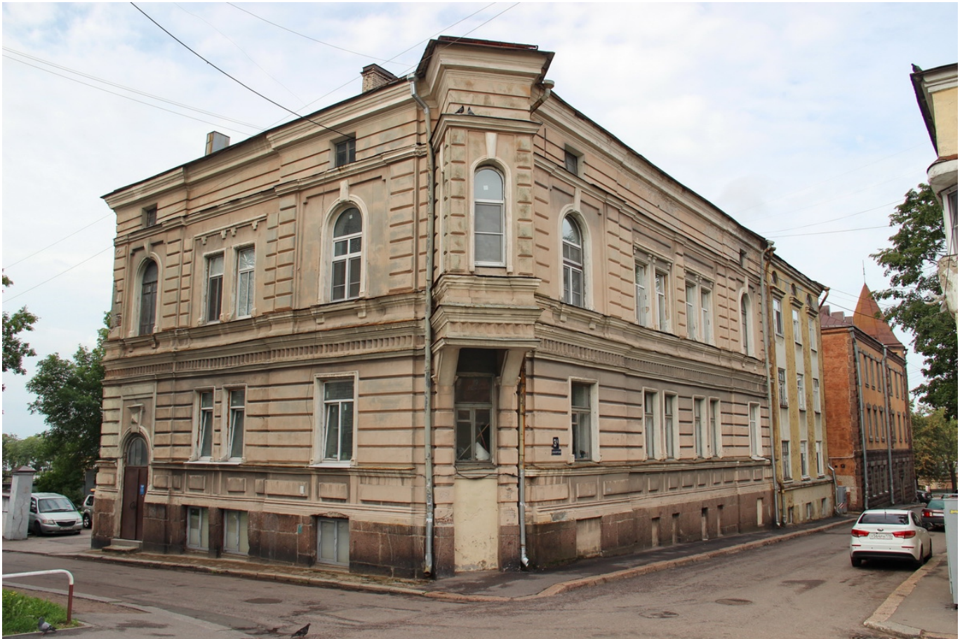
1 ОКН регионального значения “Жилой дом” ул. Выборгская, д. 3А. Вид на лицевые фасады с пересечения ул. Новой Заставы и Выборгской ул. Дата съемки: 13.10.2021 г.
