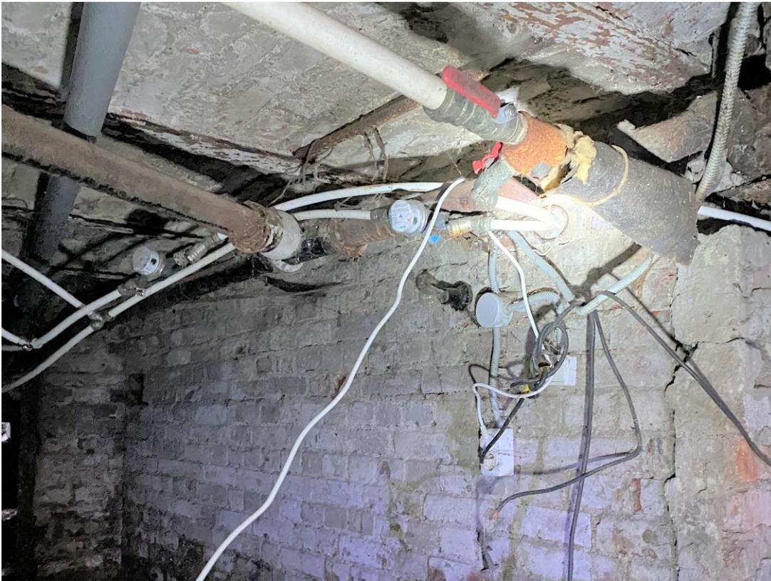
Фото 3. Подвал. Расположение электропроводки (открытая и в гофра) по стенам с нарушением способа прокладки. Освещение помещения лампой накаливания без защитного плафона. Дата съемки: 11.04.2022 г. Автор: Куваева Ю.П.
