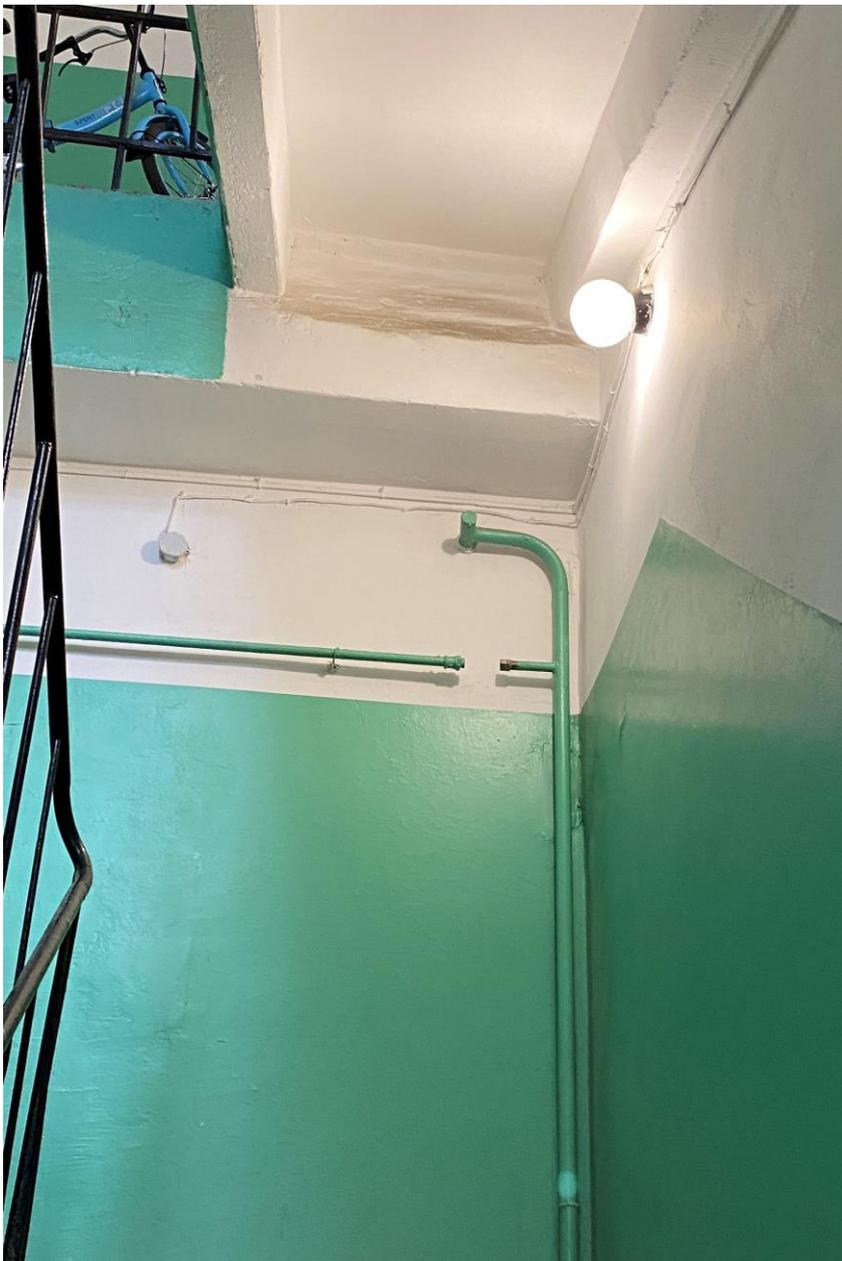
Фото 6. 2-ой этаж лестничной клетки ЛК-2. Расположение электропроводки по стенам с нарушением способа прокладки. Дата съемки: 11.04.2022 г. Автор: Куваева Ю.П.
