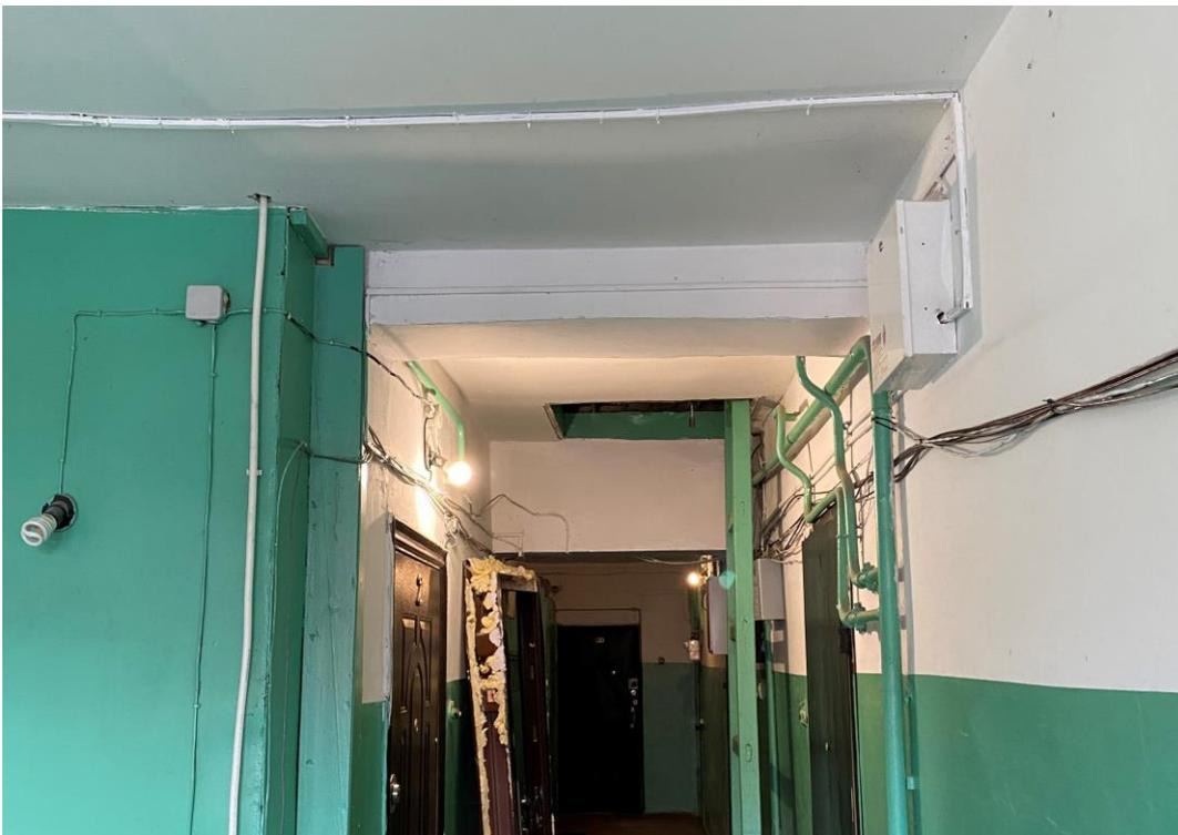
Фото 9. 4-ый этаж лестничной клетки ЛК-2. Расположение электропроводки по стенам и перекрытию с нарушением способа прокладки. Дата съемки: 11.04.2022 г. Автор: Куваева Ю.П.
