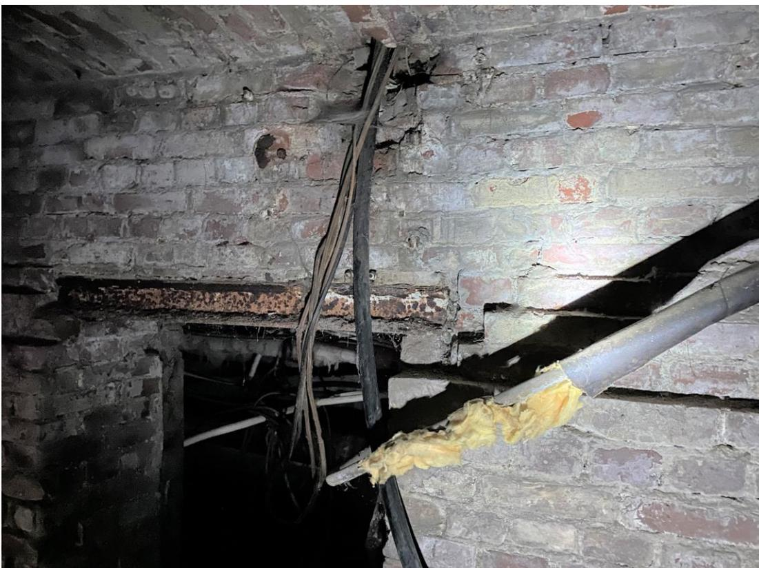
Фото 4. Подвал. Расположение электропроводки в кабелях сквозь перекрытия и по стене с нарушением способа прокладки. Дата съемки: 11.04.2022 г. Автор: Куваева Ю.П.
