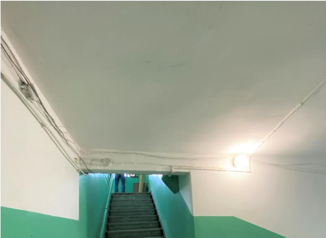
Фото 8. 3-ий этаж лестничной клетки ЛК-2. Расположение электропроводки по стенам и перекрытию с нарушением способа прокладки. Дата съемки: 11.04.2022 г. Автор: Куваева Ю.П.
