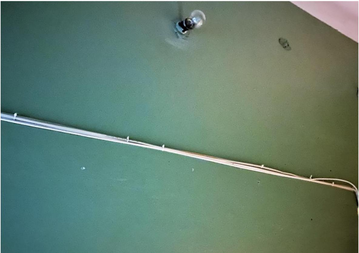
Фото 15. Коридор 2-го этажа. Отсутствует плафон светильника.
