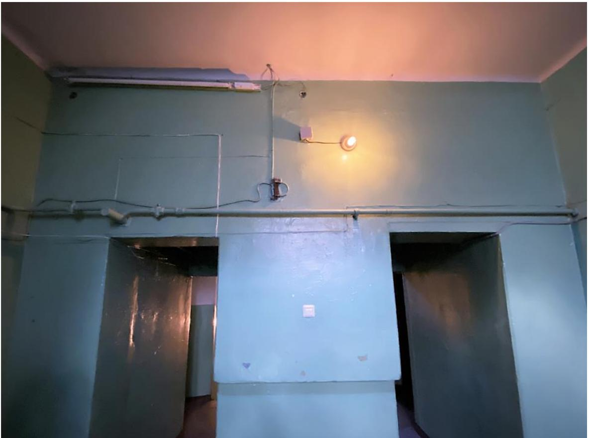
Фото 12. 1-ый этаж парадной лестницы. Отсутствуют плафон светильника и аварийное освещение.
