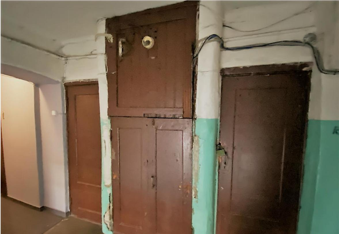
Фото 18. Общий вид верхней площадки служебной лестницы в уровне 5-го этажа. Расположение электропроводки по стенам с нарушением способа прокладки. Отсутствует плафон светильника. Дата съемки: 11.04.2022 г. Автор: Прокофьев М.Ф.
