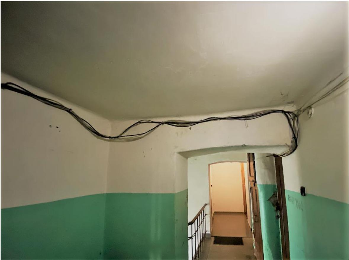
Фото 19. Коридор 5-го этажа. Расположение электропроводки по стенам с нарушением способа прокладки. Дата съемки: 11.04.2022 г. Автор: Прокофьев М.Ф.
