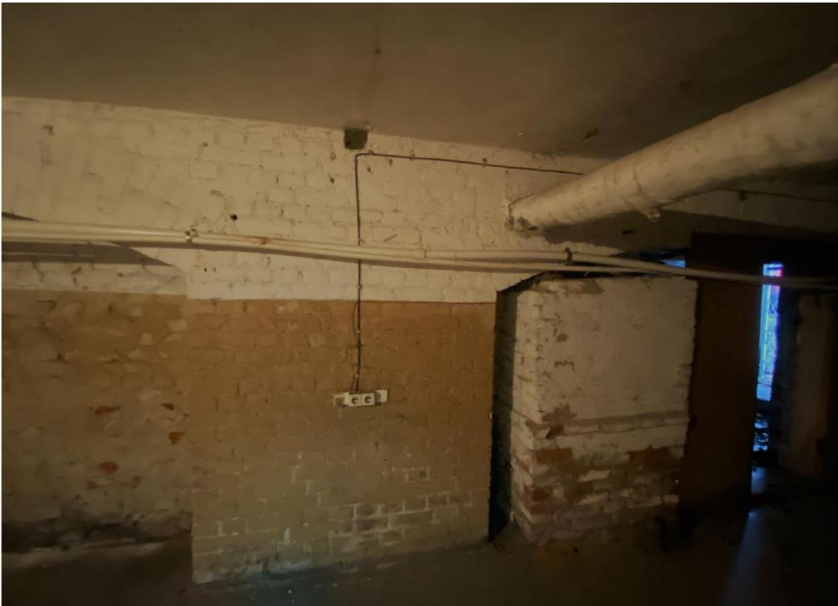
Фото 9. Подвал. Расположение электропроводки по стенам с нарушением способа прокладки.
