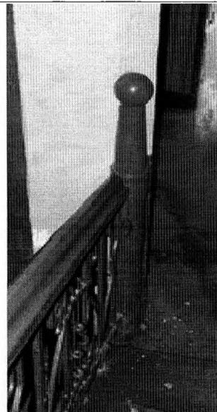
ограждения лестничных маршей – вид материала (металл), техника исполнения (ковка), рисунок (в виде вертикальных прутьев с горизонтальными тягами), поручни (материал – дерево; профиль).
