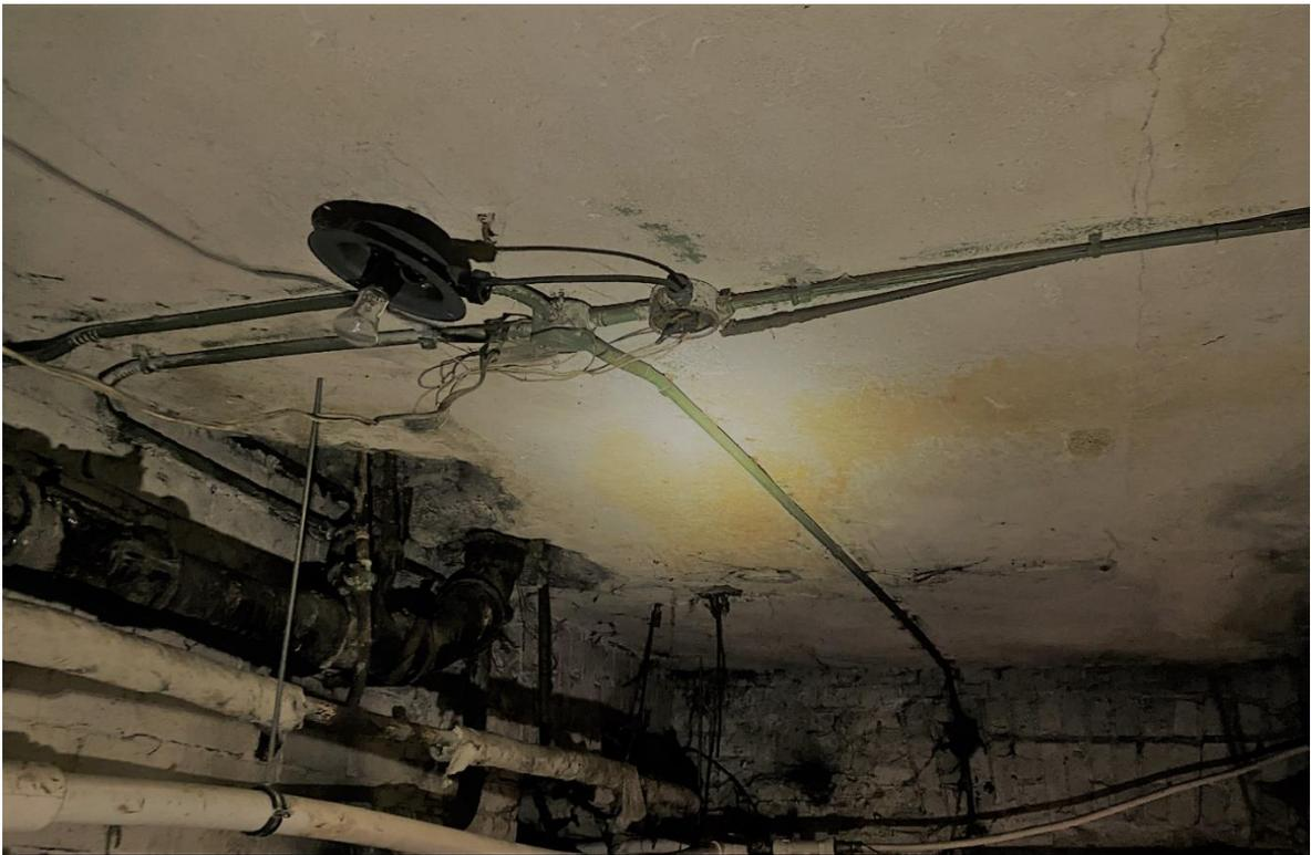
Фото 11. Подвал. Металлические трубы поражены коррозией. Вскрыта распределительная коробка, отсутствует плафон светильника.
