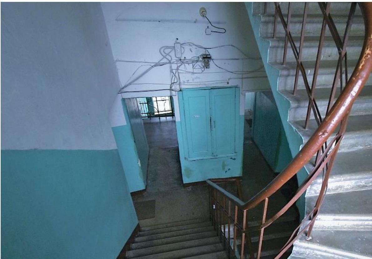
Фото 14. 2-ой этаж служебной лестницы. Расположение электропроводки по стенам с нарушением способа прокладки.
