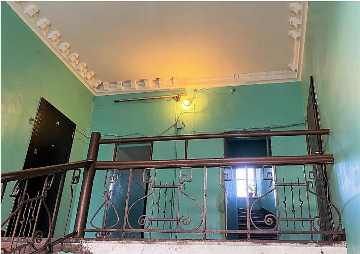
Фото 17. Общий вид верхней площадки парадной лестницы в уровне 4-го этажа. Расположение электропроводки по стенам с нарушением способа прокладки. Отсутствует плафон светильника. Дата съемки: 11.04.2022 г. Автор: Прокофьев М.Ф.
