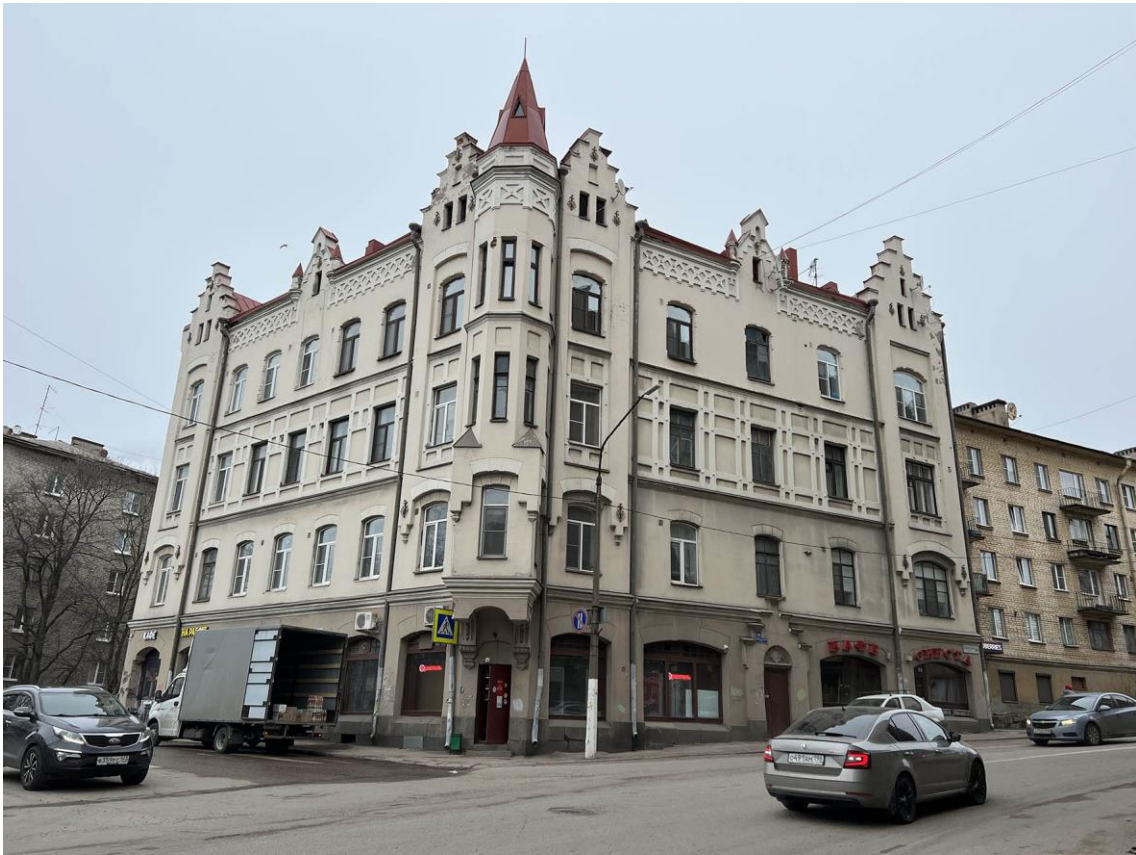
Фото 1. Общий вид здания с юго-запада, с перекрестка Ленинградского шоссе и ул. Онежской. Фото 11.04.2022 г. Автор: Куваева Ю.П.
