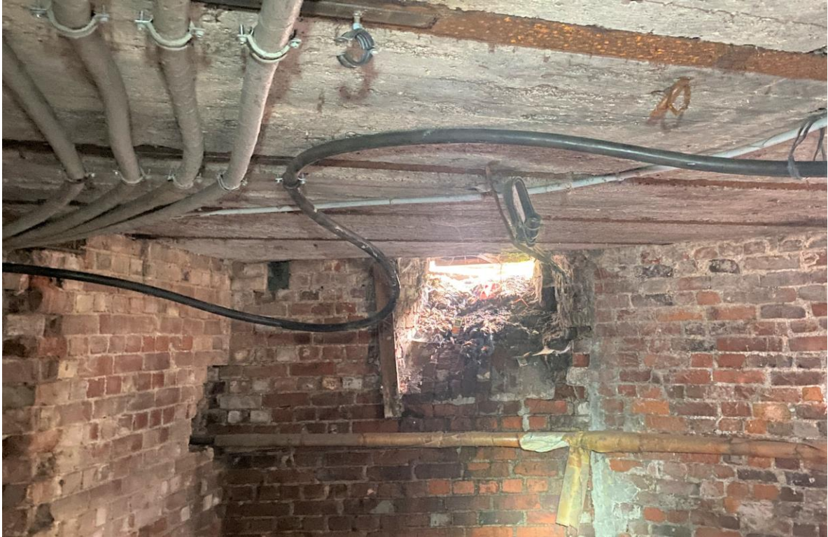
Фото 4. Подвал. Расположение кабеля питания от щитов по перекрытию. Фото 11.04.2022 г. Автор: Куваева Ю.П.
