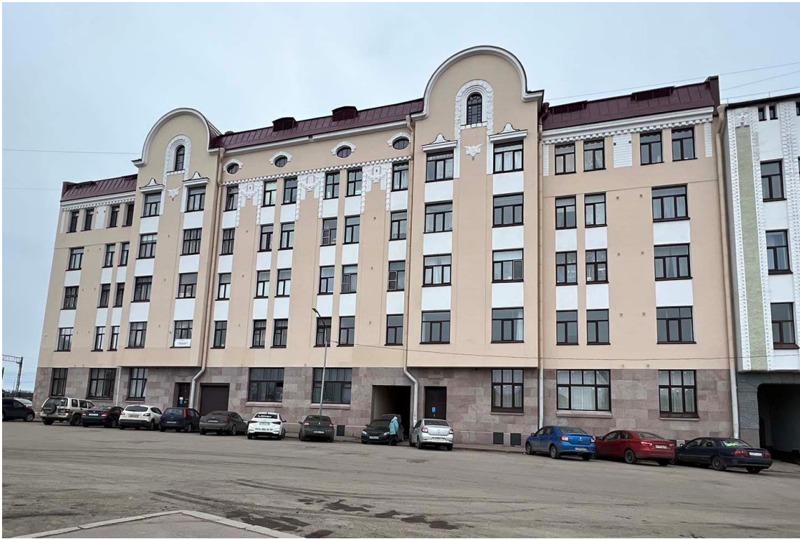
Фото 1. Общий вид здания с юга. Дата съемки: 11.04.2022 г. Автор: Куваева Ю.П.
