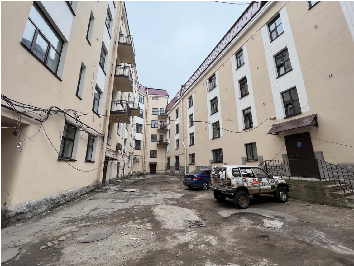
Фото 3. Общий вид дворовых фасадов здания с юго-востока. Дата съемки: 11.04.2022 г. Автор: Куваева Ю.П.
