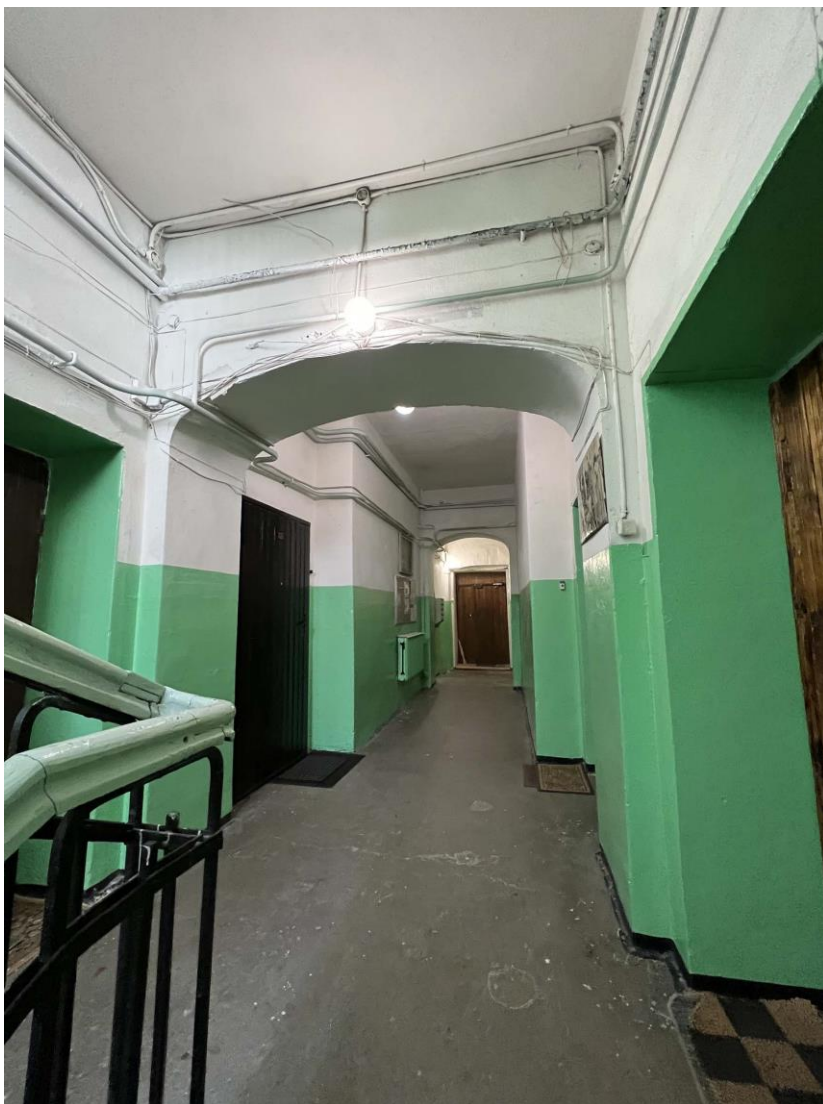
Фото 4. Коридор 1-го этажа. Фото с юго-востока. Дата съемки: 11.04.2022 г. Автор: Куваева Ю.П.
