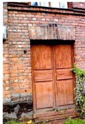
Входной проем (Ю-В фасад)
