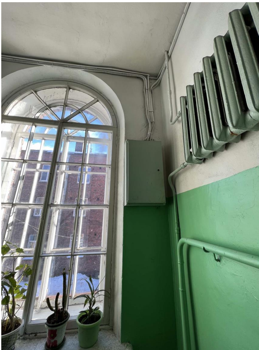
Фото 5. Прокладка сетей электропроводки по наружной юго-восточной стене. Промежуточная площадка лестничной клетки. Дата съемки: 11.04.2022 г. Автор: Куваева Ю.П.
