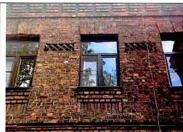
Оконные проемы боковых частей С-3 и Ю-В фасадов (2-ой этаж)
