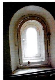
Рисунок оконного проема (Ю-В фасад, 2-ой этаж)
