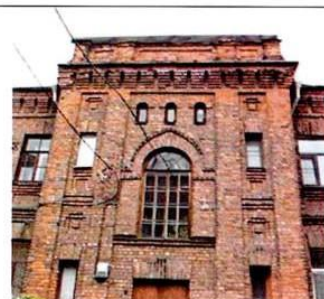
Оконные проемы Ю-В ризалита (2-ой этаж)
