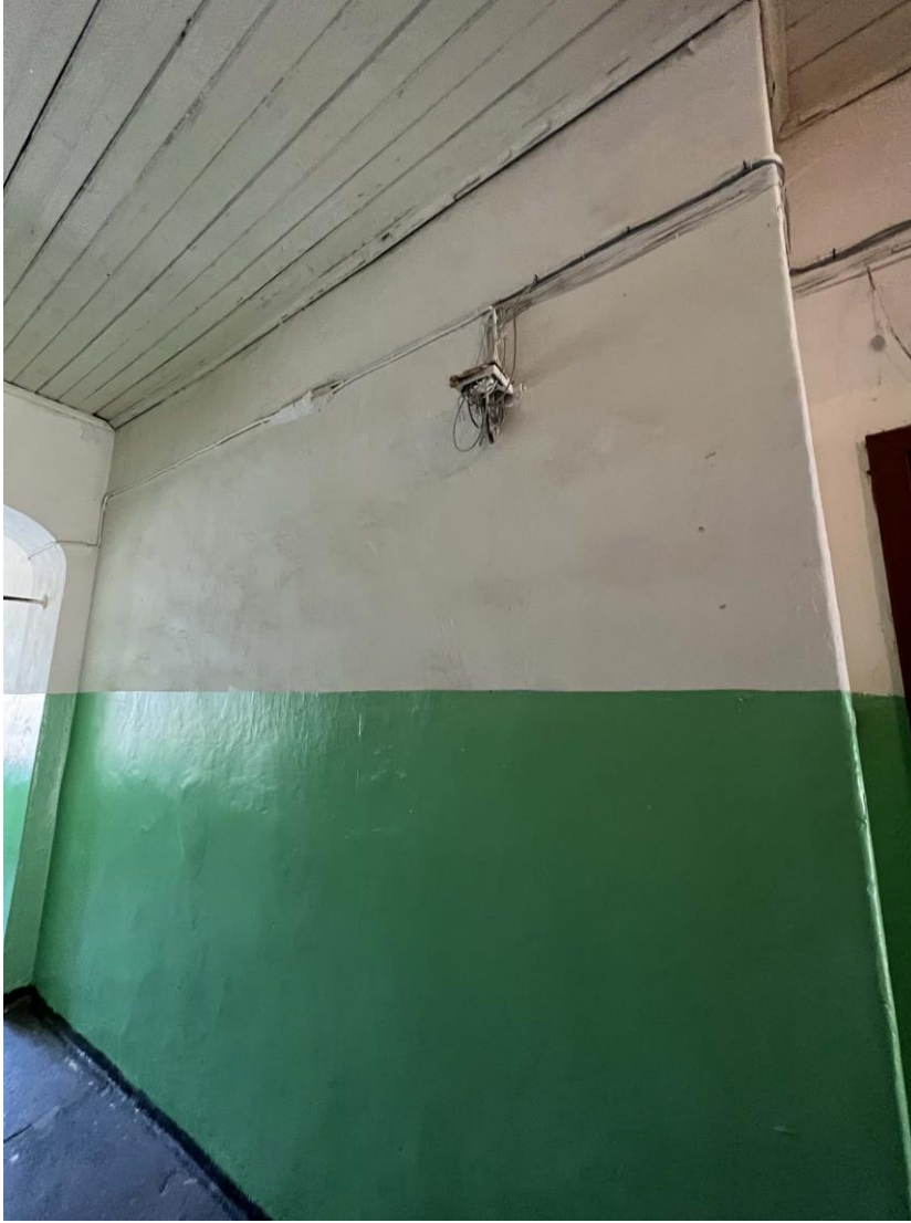
Фото 8. Прокладка электропроводов по стене коридора 2-го этажа. Дата съемки: 11.04.2022 г. Автор: Куваева Ю.П.
