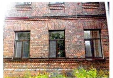
Оконные проемы боковых частей С-З и Ю-В фасадов (1-ый этаж)
