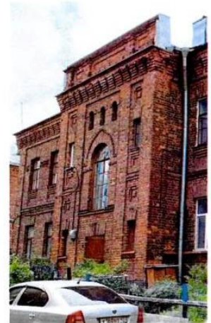
Фасады Ю-В ризалита
