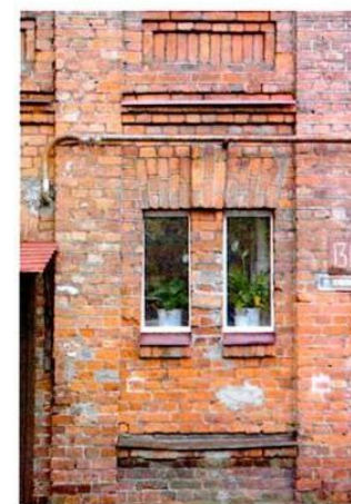
Оконные проемы С-З ризалита (1-ый этаж)
