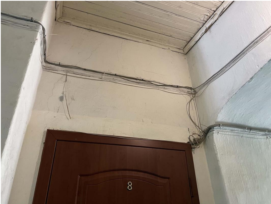
Фото 9. Прокладка электропроводов по стене коридора 2-го этажа над квартирой. Дата съемки: 11.04.2022 г. Автор: Куваева Ю.П.
