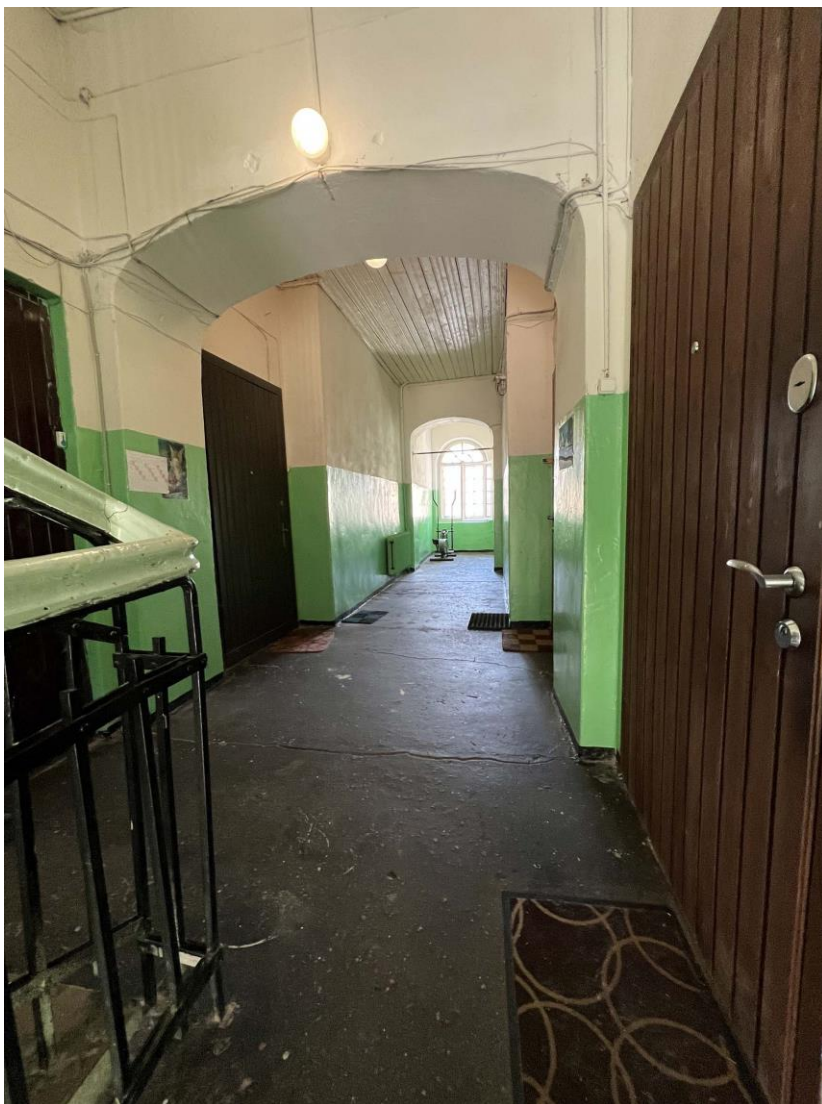
Фото 6. Коридор 2-го этажа. Фото с юго-востока. Дата съемки: 11.04.2022 г. Автор: Куваева Ю.П.
