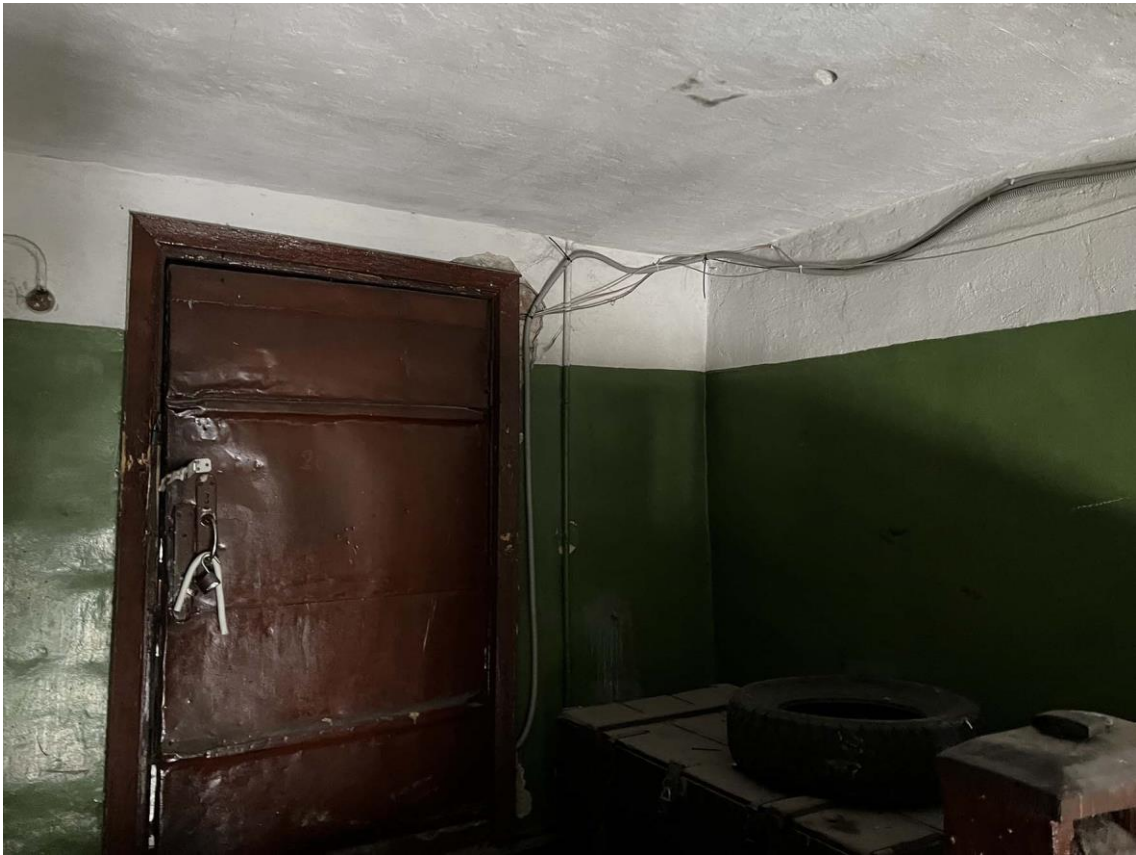
Фото 16. Лестничная клетка. 3-ий подъезд. Крепление электропроводки (открытой и в гофрированных трубах) к стенам в уровне чердака. Дата съемки: 11.04.2022 г. Автор: Куваева Ю.П.
