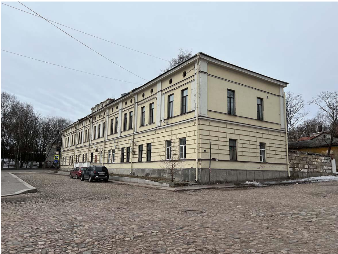
Фото 2. Общий вид здания с юго-востока. Дата съемки: 11.04.2022 г. Автор: Куваева Ю.П.
