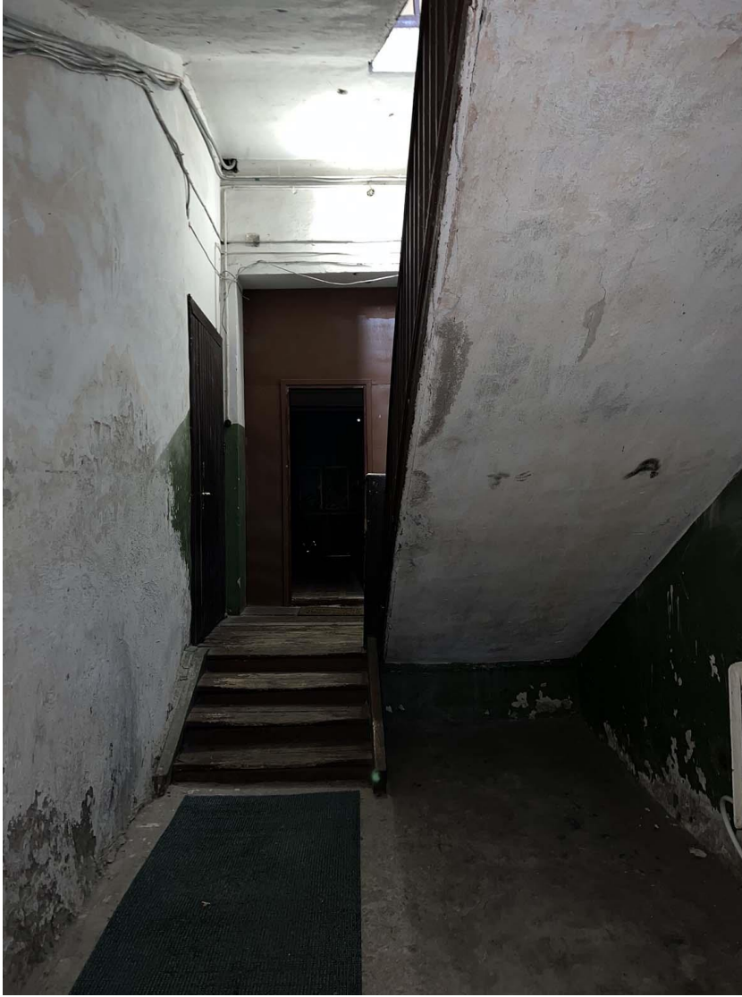
Фото 9. Лестничная клетка. 2-ой подъезд. Общий вид помещения 1-го этажа. Дата съемки: 11.04.2022 г. Автор: Куваева Ю.П.
