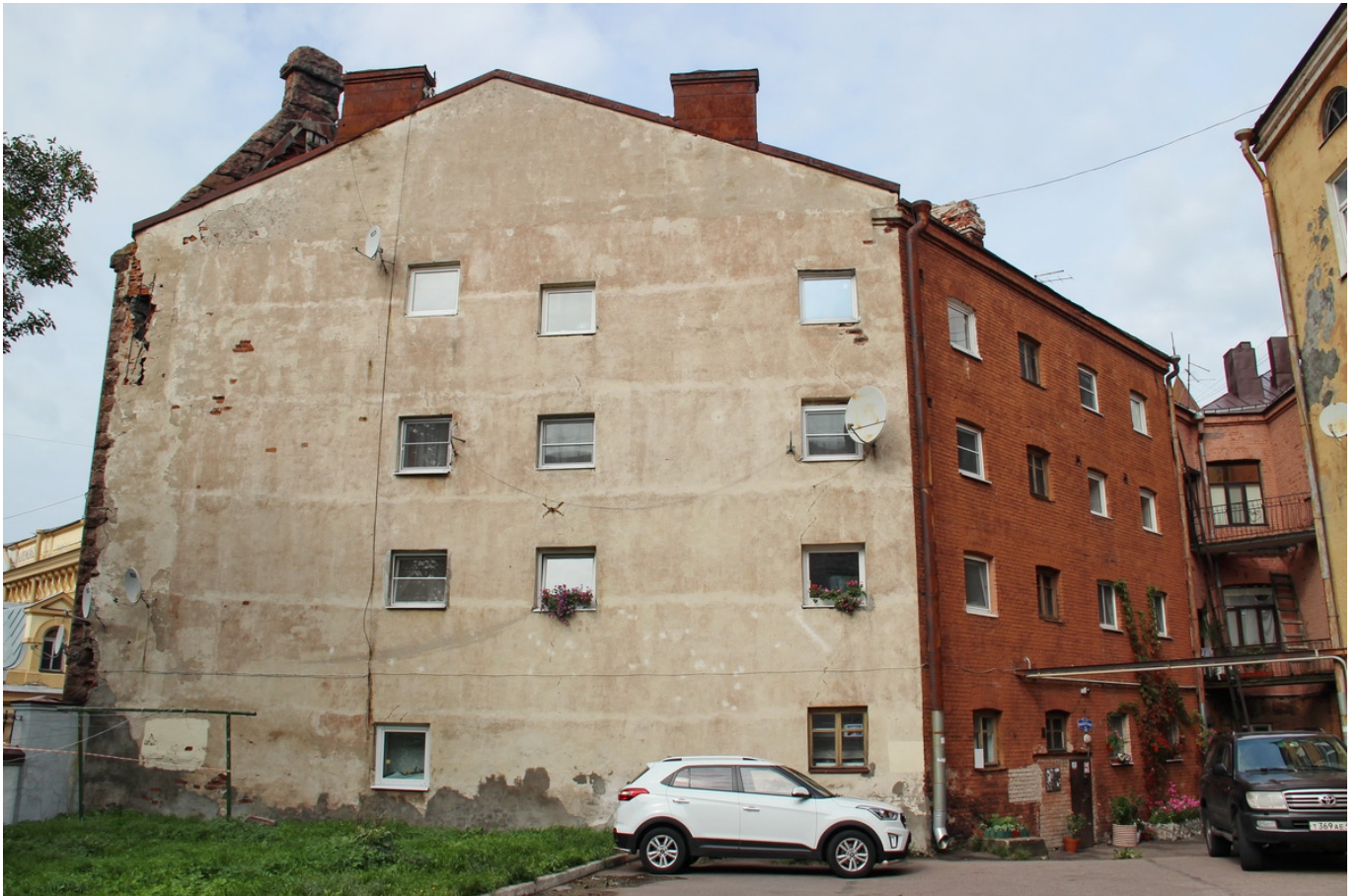
3 ОКН регионального значения “Жилой дом” ул. Выборгская, д. 1А. Юго-восточный и северо-восточный дворовые фасады. Дата съемки: 13.10.2021 г.
