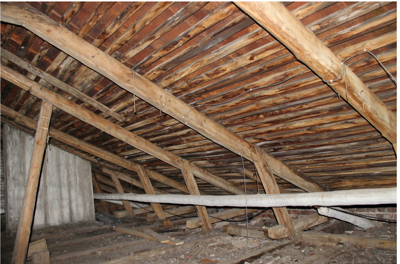
6 ОКН регионального значения “Жилой дом” ул. Выборгская, д. 1А. Чердак. Дата съемки: 13.10.2021 г.
