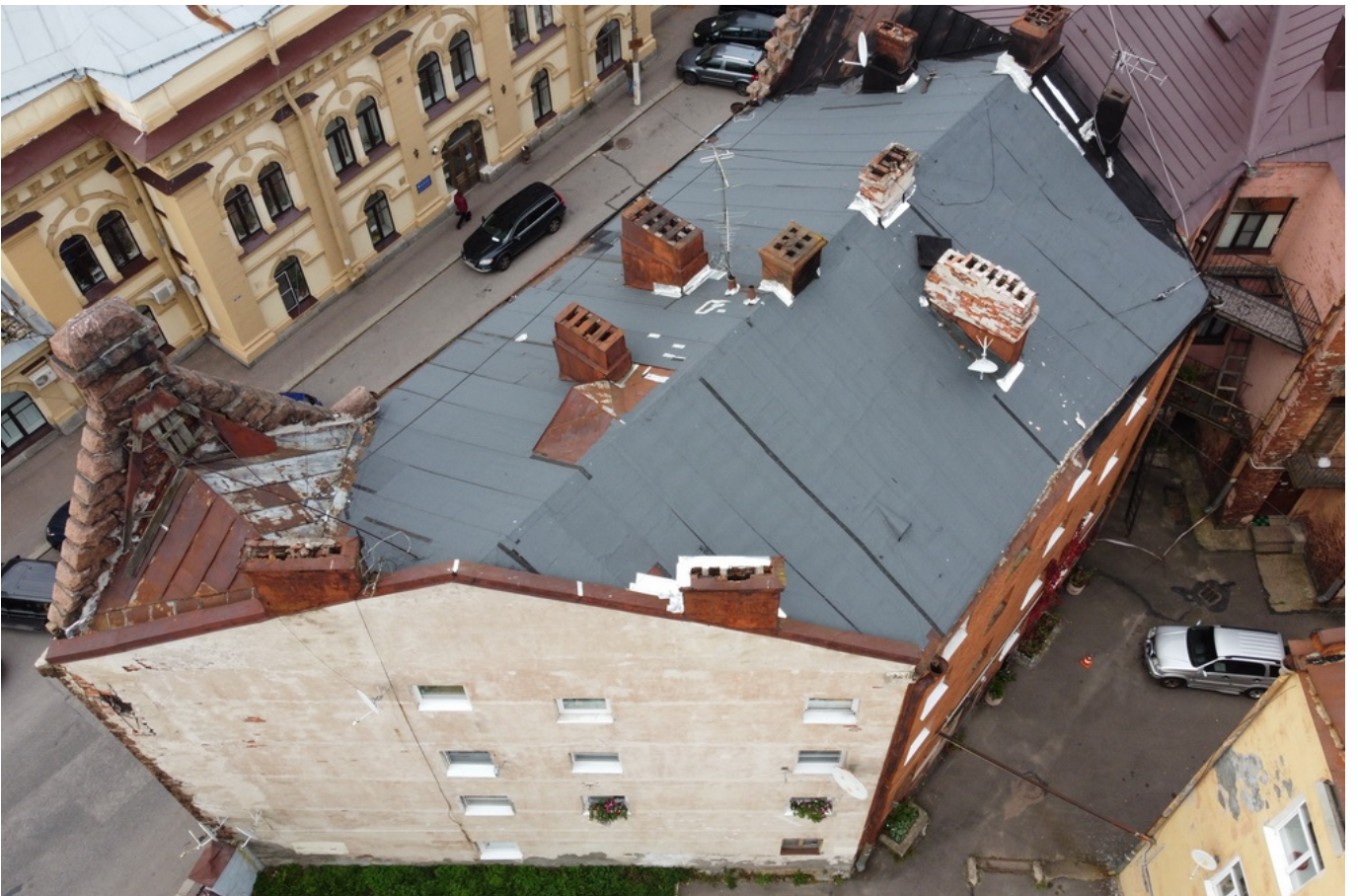
8 ОКН регионального значения “Жилой дом” ул. Выборгская, д. 1А. Вид с квадрокоптера со стороны двора. Дата съемки: 13.10.2021 г.
