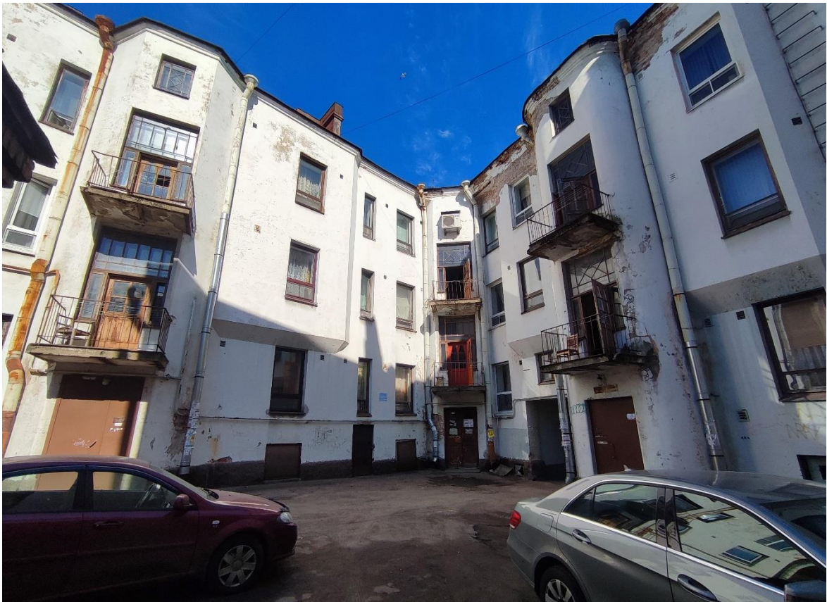
Фото 3. Общий вид здания со стороны двора, с запада. Дата съемки: 11.04.2022 г. Автор: Прокофьев М.Ф.
