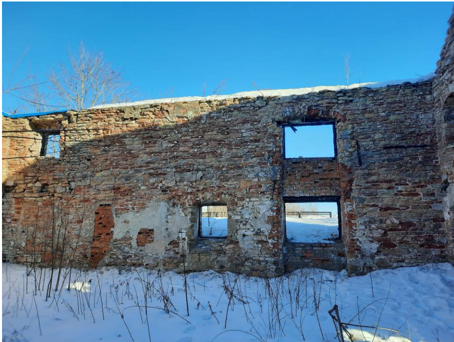
Точка фотофиксации 8. Общий вид внутреннего объема здания мельницы. Вид с С.
