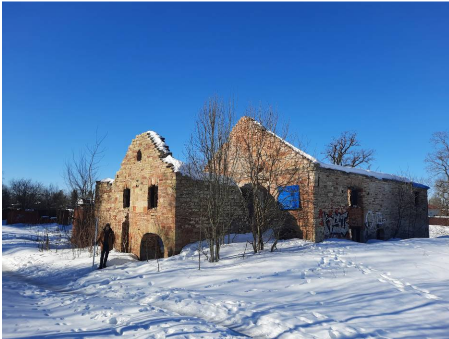
Точка фотофиксации 2. Общий вид на сохранившееся здание мельницы. Вид с С.
