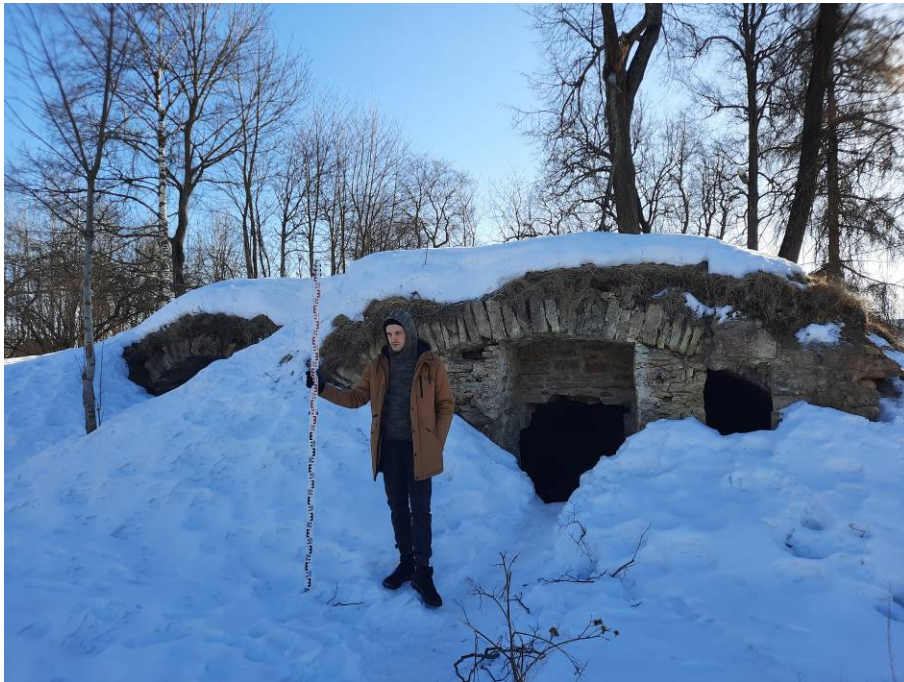
Точка фотофиксации 7. Общий вид на хозяйственные постройки. Вид с 3.
