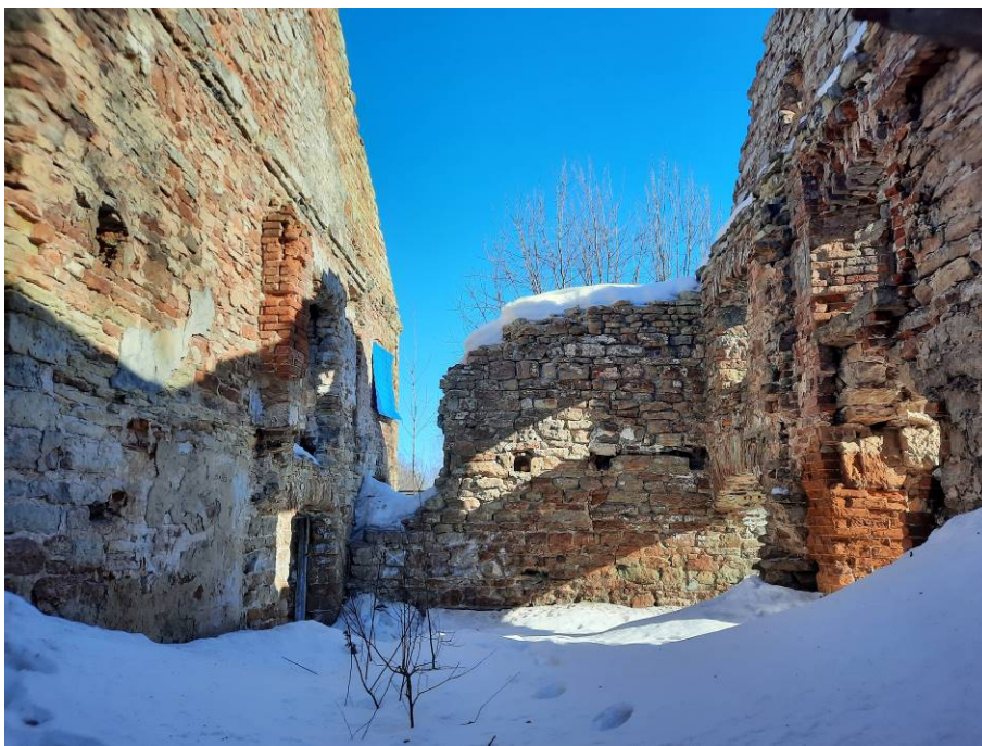
Точка фотофиксации 8. Общий вид внутреннего объема здания мельницы. Вид с Ю.
