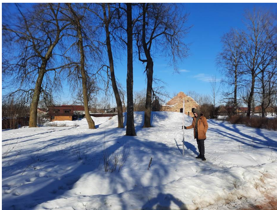
Точка фотофиксации 4. Общий вид на территорию ОКН. Вид с ЮВ.
