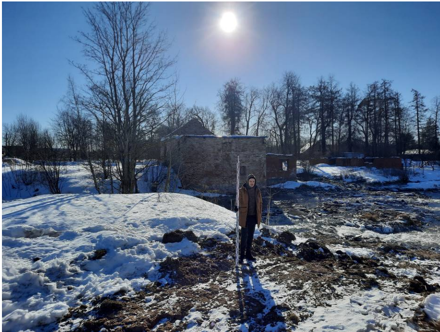
Точка фотофиксации 1. Общий вид на территорию ОКН с противоположного берега р. Ижора. Вид с СЗ.
