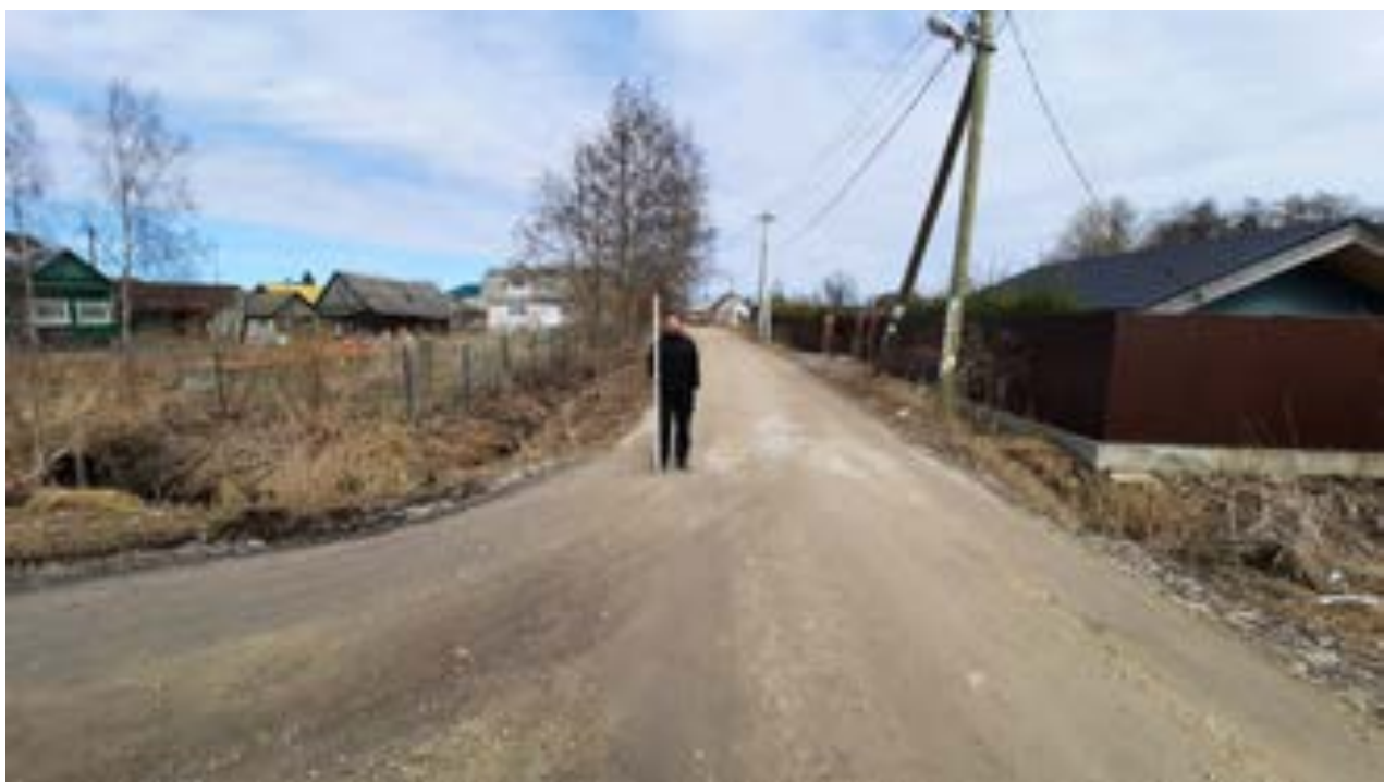
Илл.89. Ленинградская обл, Гатчинский р-н, д. Мыза-Ивановка-2021. Точка фотофиксации 41. Вид с Ю.
