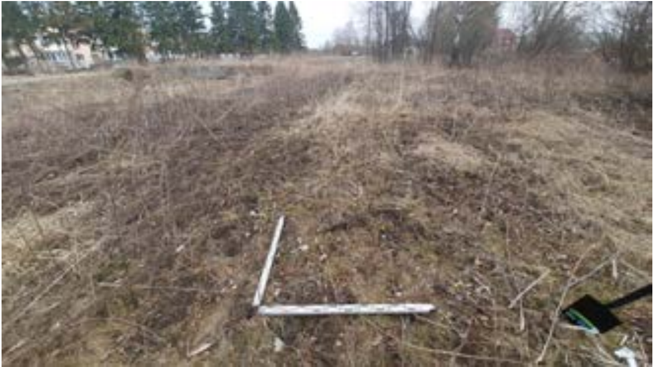
Илл.149. Ленинградская обл, Гатчинский р-н, д. Мыза-Ивановка-2021. Шурф 1. До начала работ. Вид с Ю.
