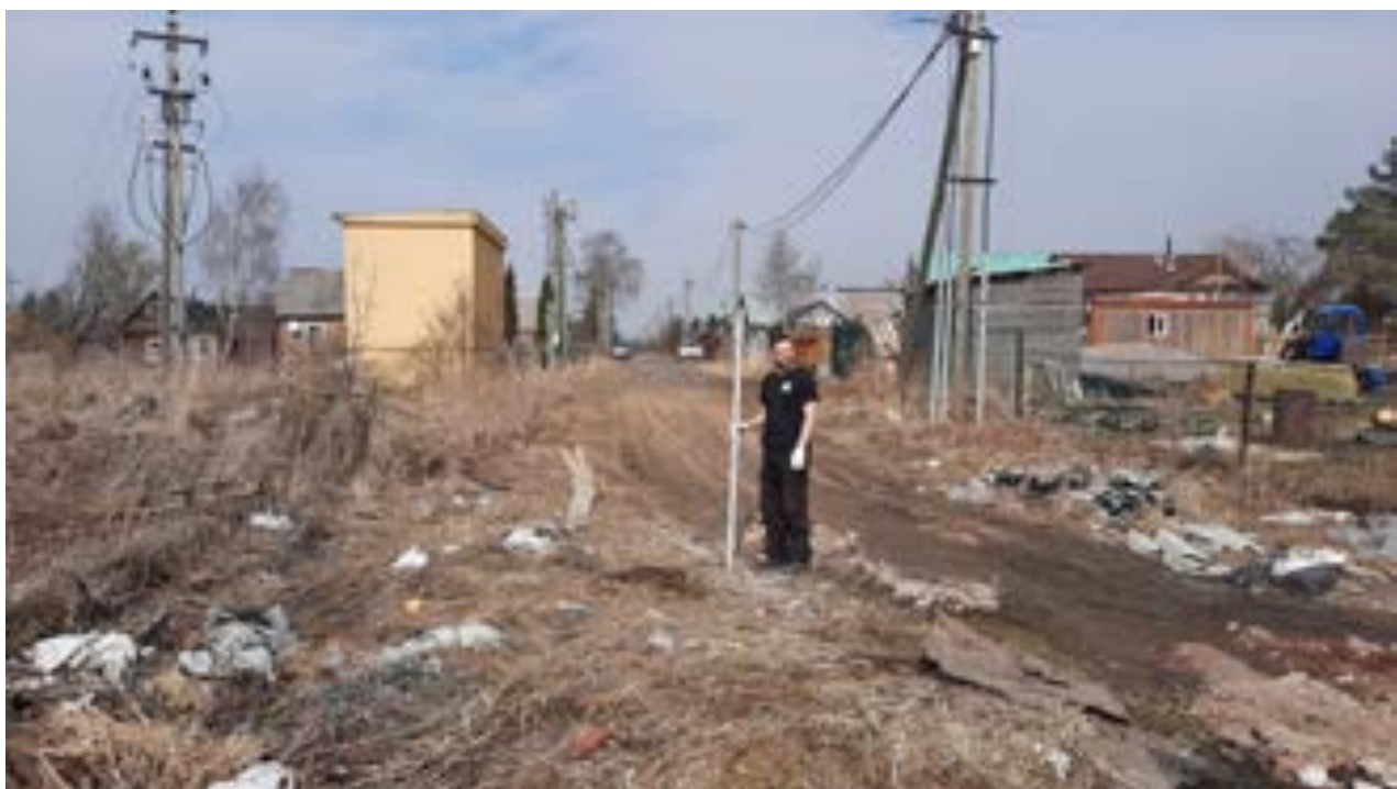
Илл.55. Ленинградская обл, Гатчинский р-н, д. Мыза-Ивановка-2021. Точка фотофиксации 22. Вид с Ю.
