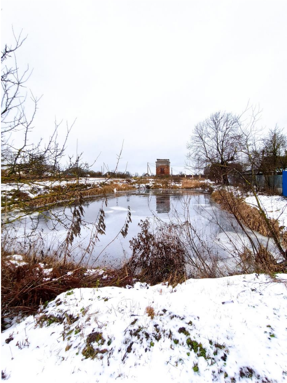
5. Вид на обьект с юга.
