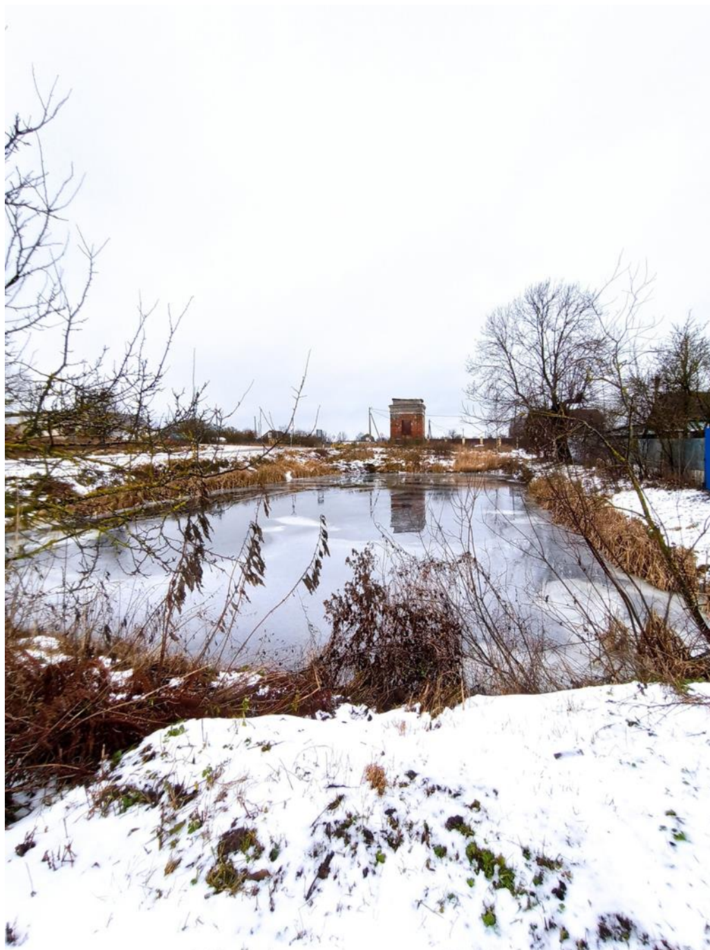
15. Общий вид на объект и пожарный пруд.
