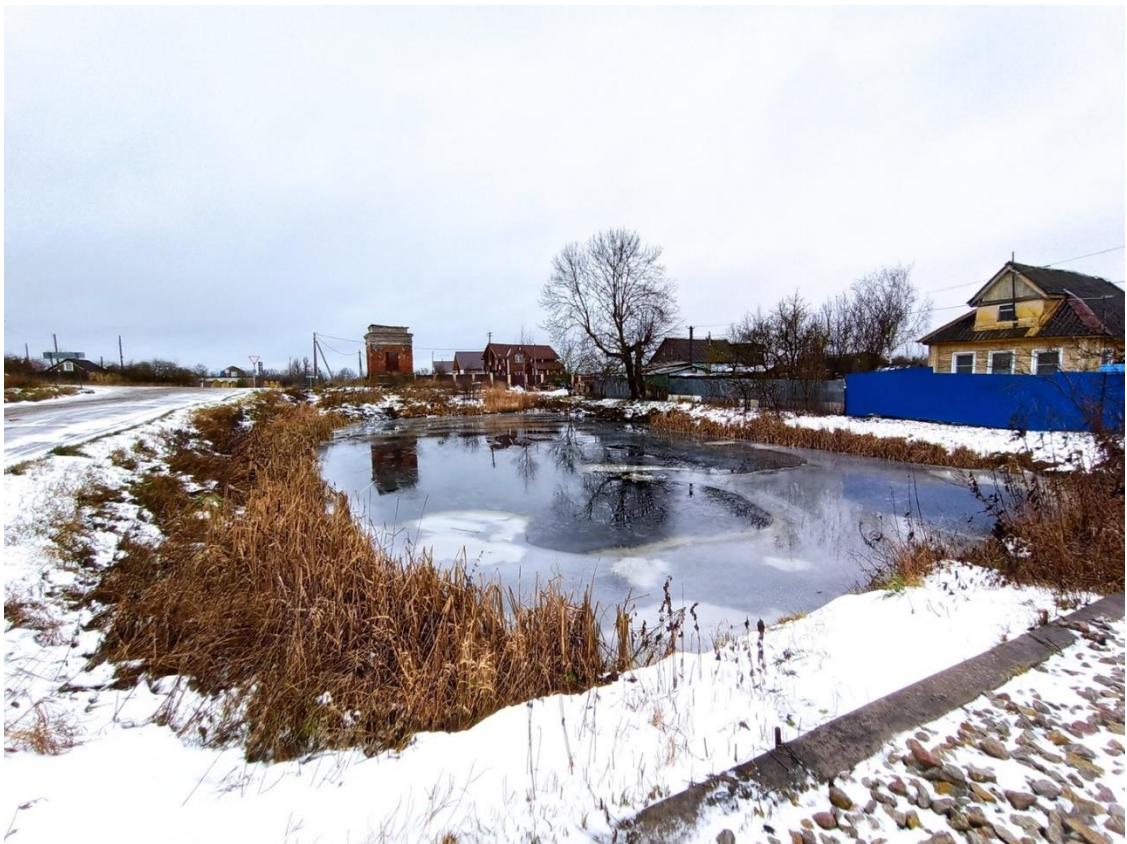
14. Общий вид на объект и пожарный пруд.
