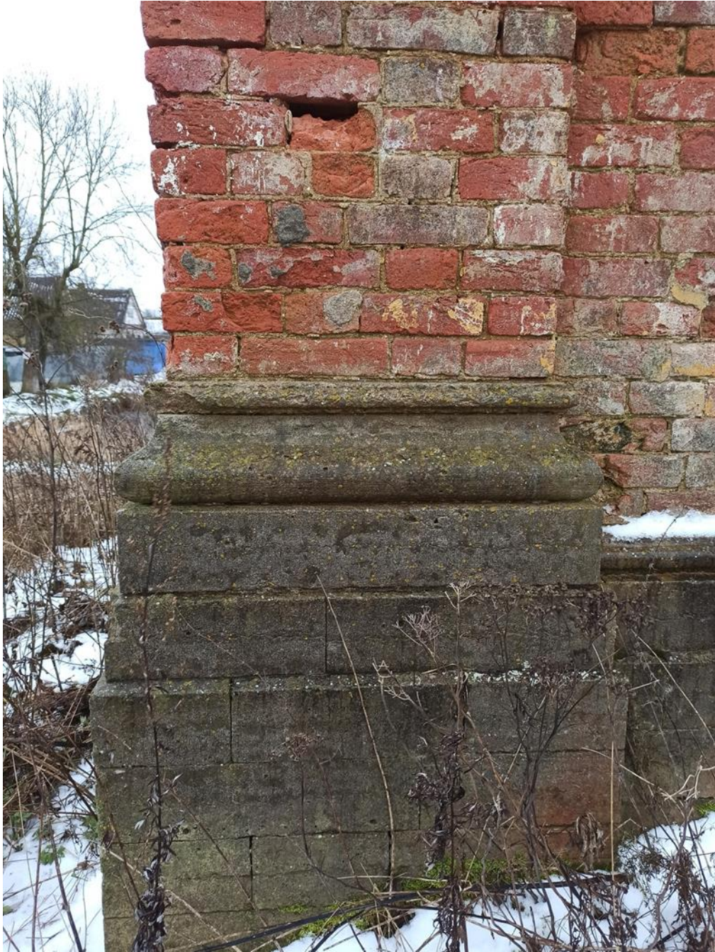
5. Фрагмент фасада с юго-запада.
