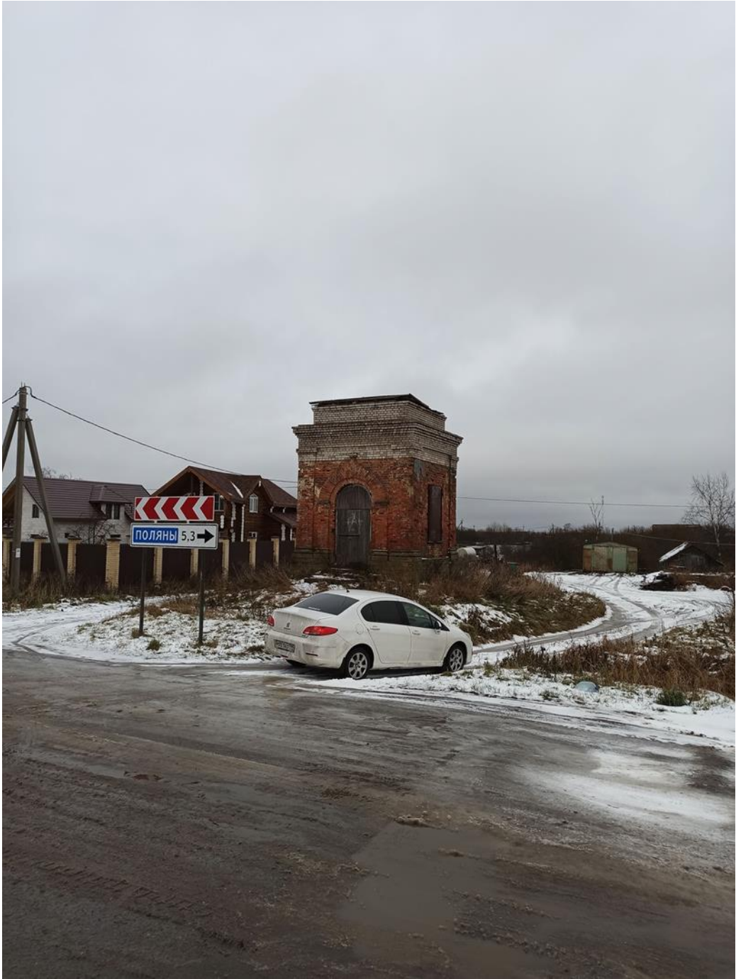
12. Общий вид на объект с севера.
