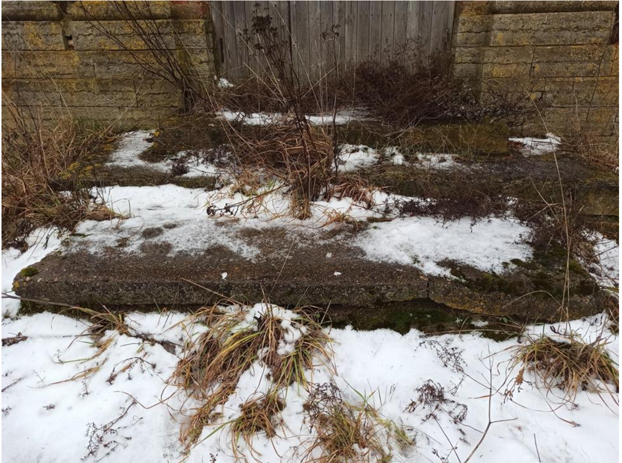
10. Фрагмент фасада объекта.
