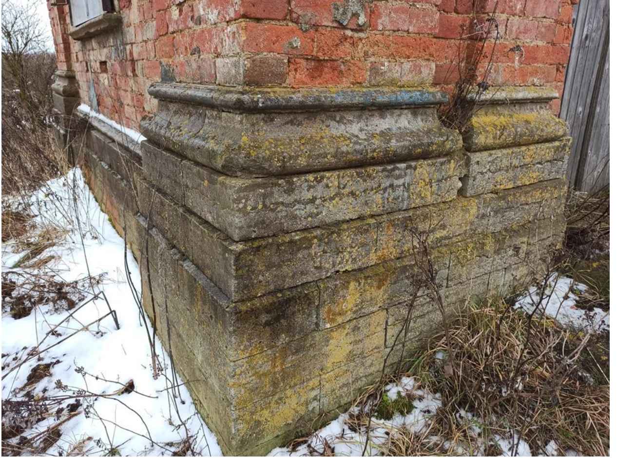
3. Фрагмент фасада с севера-востока.
