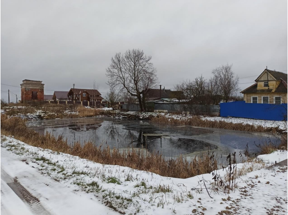
13. Общий вид на объект и пожарный пруд.
