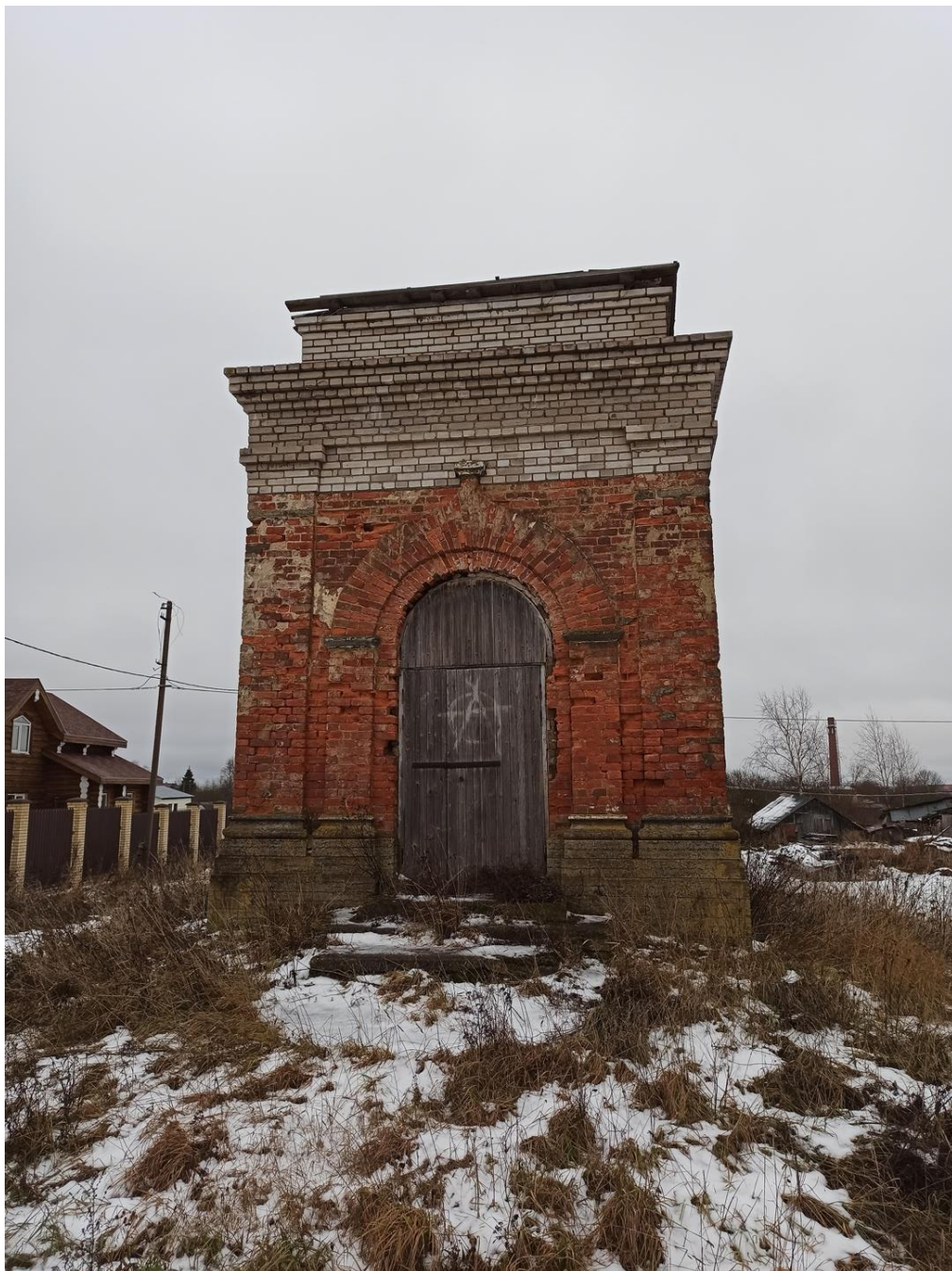
1. Общий вид на объект с севера.
