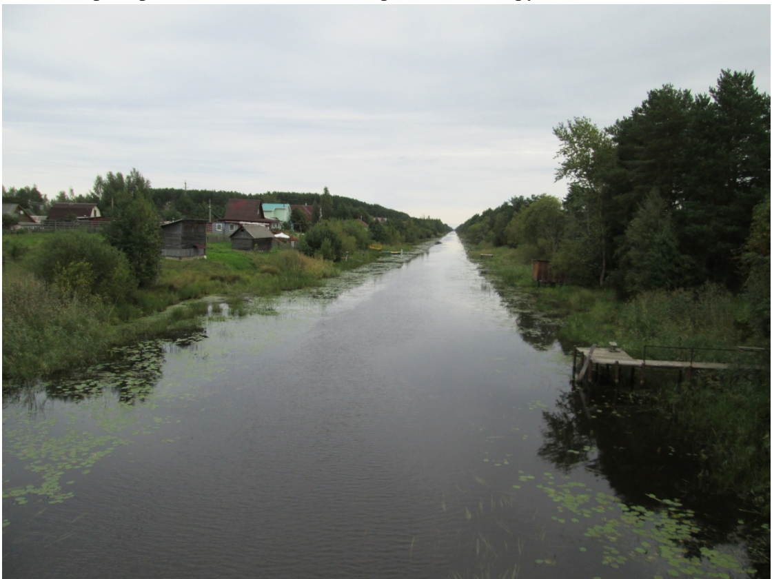
Илл. 44. Ленинградская обл., Волховский р-н. ОКН «Сяьский канал (б. канал Екатерины II)». Точка фотофиксации Ф11. Вид с юго-запада на русло канала, д. Немятово 2.
