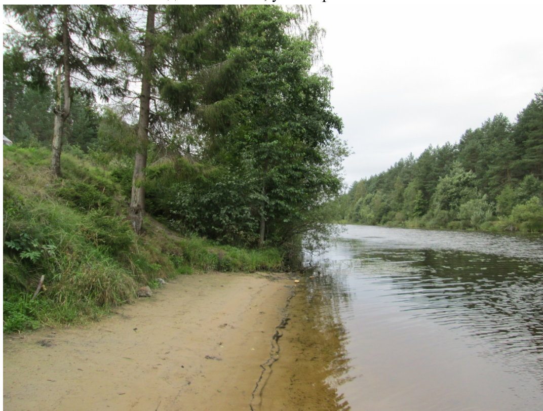
Илл. 48. Ленинградская обл., Волховский р-н. ОКН «Сясьский канал (б. канал Екатерины II)», южный берег. Точка фотофиксации Ф14. Вид с северо-востока на берега и русло канала в районе пересечения проектируемым газопроводом.
