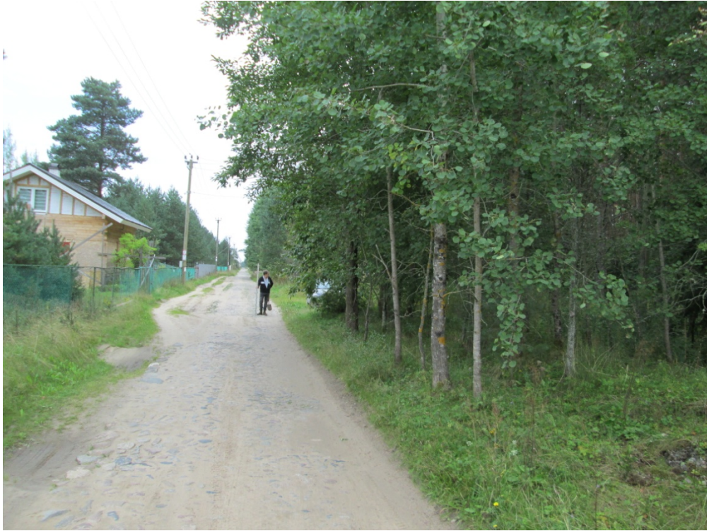
Илл. 45. Ленинградская обл., Волховский р-н. ОКН «Сясьский канал (б. канал Екатерины II)», южный берег. Точка фотофиксации Ф12. Вид с юго-запада на трассу проектирования, д. Немятово 2, ул. Петровская.
