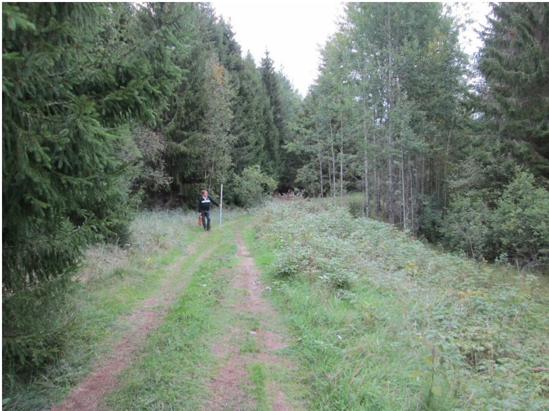
Илл. 35. Ленинградская обл., Волховский р-н. ОКН «Новосясьский канал (б. канал Императрицы Марии Федоровны)», северный берег. Точка фотофиксации Ф7. Вид с юго-запада на трассу проектирования.
