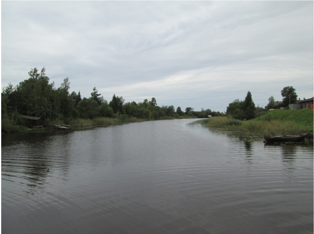
Илл. 41. Ленинградская обл., Волховский р-н. ОКН «Новосясский канал (б. канал Императрицы Марии Федоровны)». Точка фотофиксации Ф10. Вид с востока на русло канала, д. Немятово 1.
