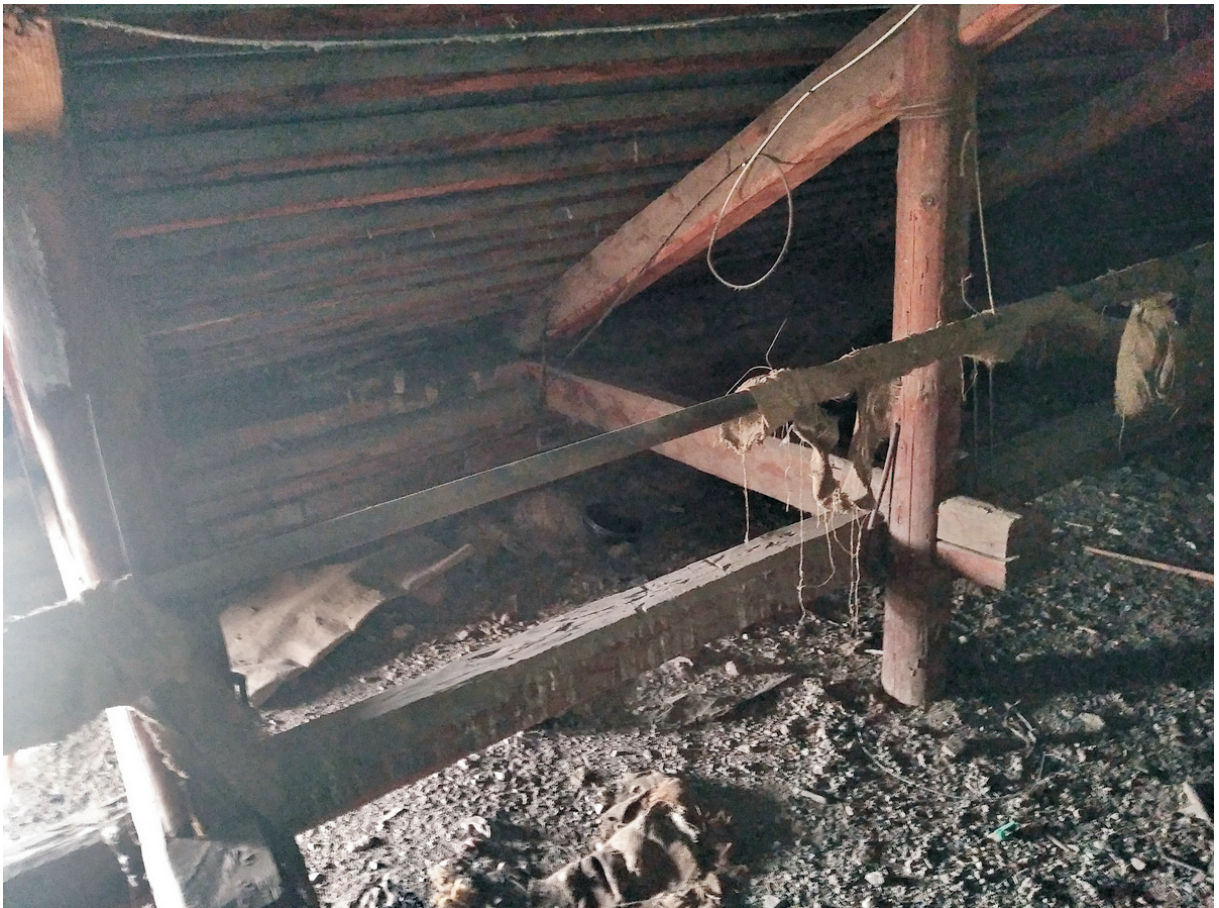
28 ОКН регионального значения “Жилой дом А.П. Воробьева” Ленинградская область, Выборгский муниципальный район, г. Выборг, ул. Майорова, д. 4. Чердак. Дата съемки: 02.05.2022 г.
