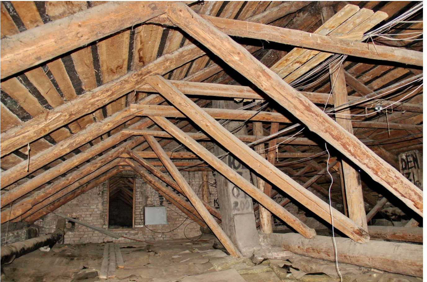
25 ОКН регионального значения “Жилой дом” Ленинградская область, Кингисеппский муниципальный район, г. Кингисепп, ул. Жукова, д. 14. Чердак. Дата съемки: 08.06.2022 г.
