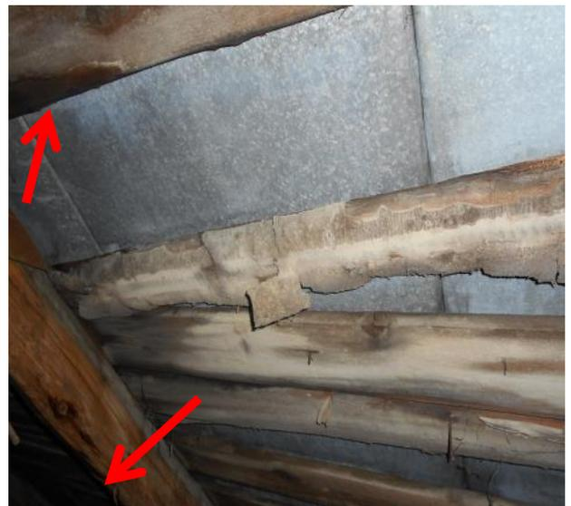
Фото №16- Поражение гнилью, следы протечек
