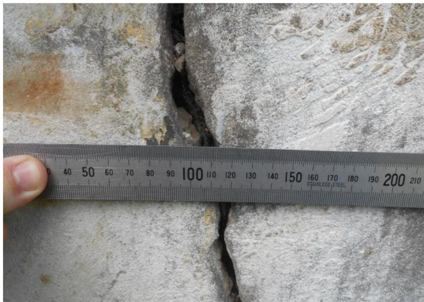
Фото №6 – Образование трещин
