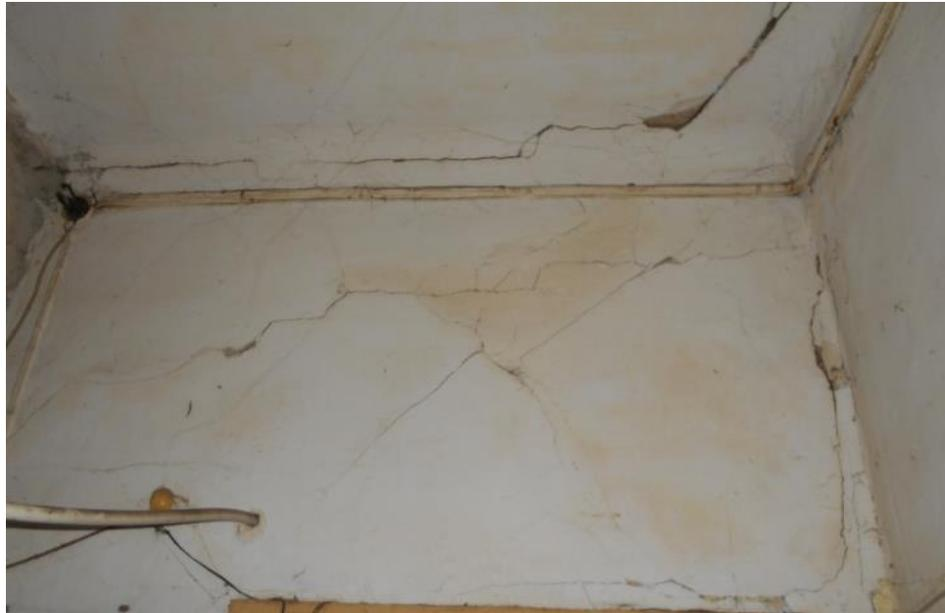
Фото №11 – Образование трещин в местах сопряжения конструкций
