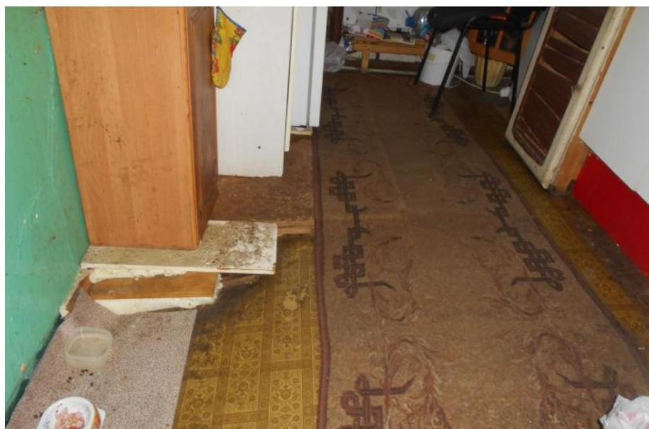
Фото №19- Образование просядок пола
