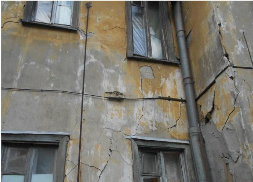
Фото №5 – Массовое образование трещин
