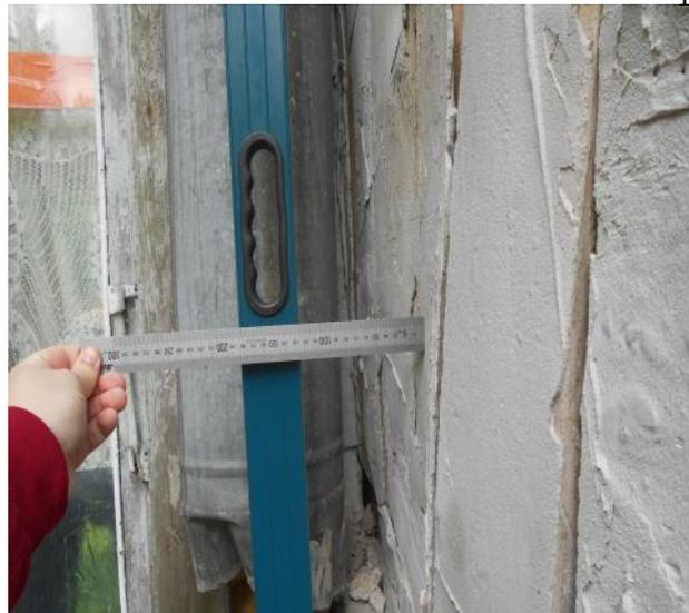
Фото №8 – Деформации стен
