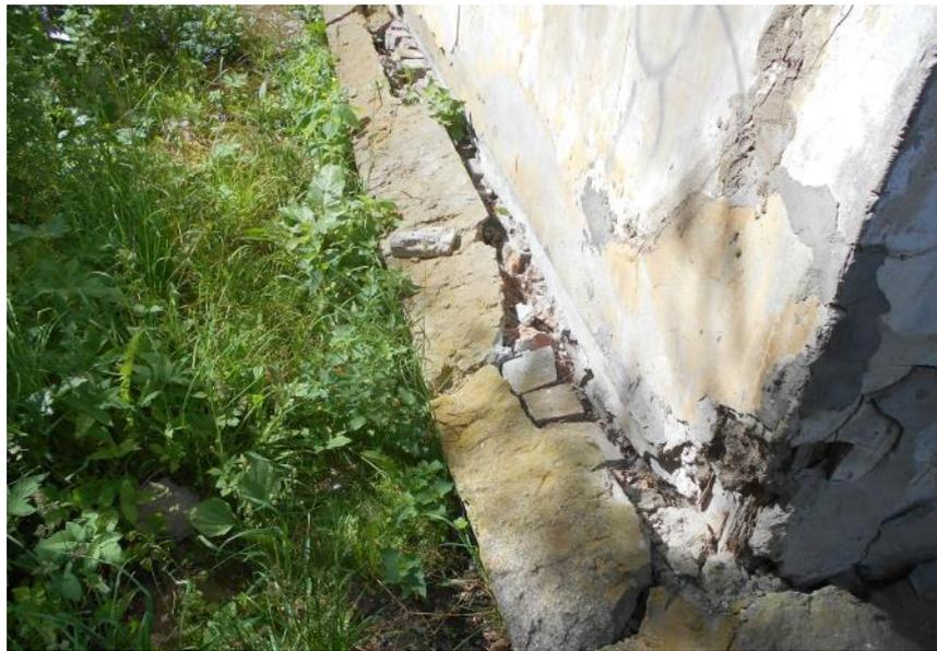
Фото №3 – Выпучивание, искривление и разрушение цоколя
