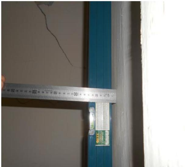
Фото №7 – Деформации стен
