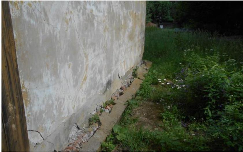
Фото №4 – Выпучивание, искривление и разрушение цоколя
