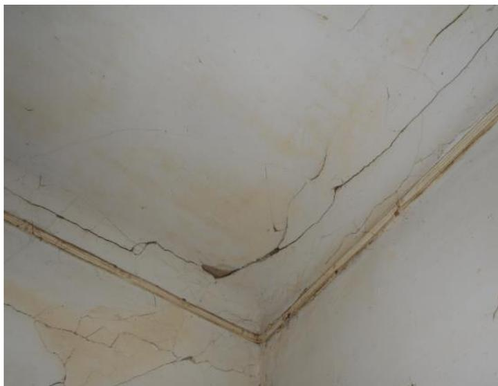
Фото №14 – Образование трещин, прогиба
