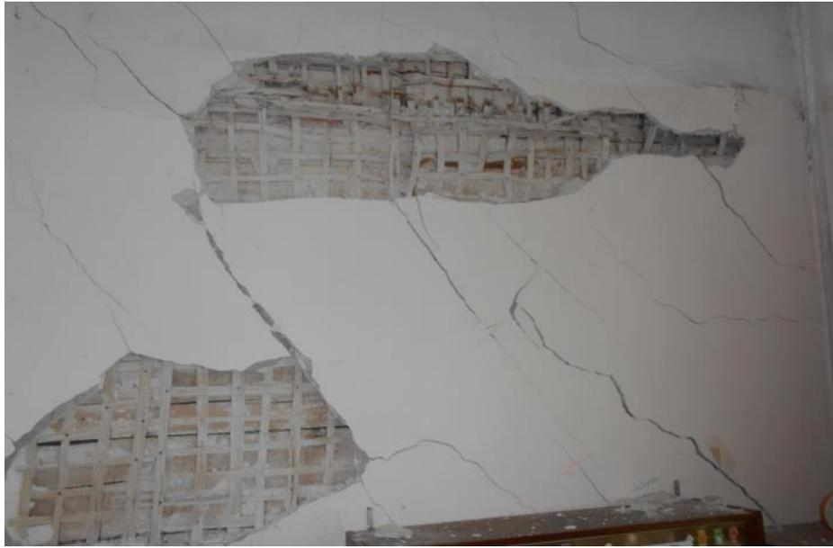
Фото №10 – Образование диагональных трещин
