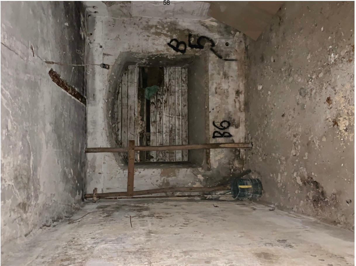
17 ОКН регионального значения “Жилой дом со службами К. Клоуберга” Ленинградская область, Выборгский муниципальный район, г. Выборг, ул. Сторожевой башни, д. 18. Подвал № 1. Помещение 4. Дата съемки: 02.05.2022 г.
