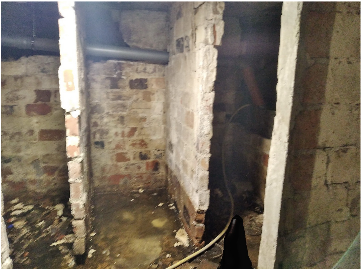
36 ОКН регионального значения “Жилой дом со службами К. Клоуберга” Ленинградская область, Выборгский муниципальный район, г. Выборг, ул. Сторожевой башни, д. 18. Подвал № 3. Вид из помещения 1 на помещения 9, 10 и 11. Дата съемки: 02.05.2022 г.
