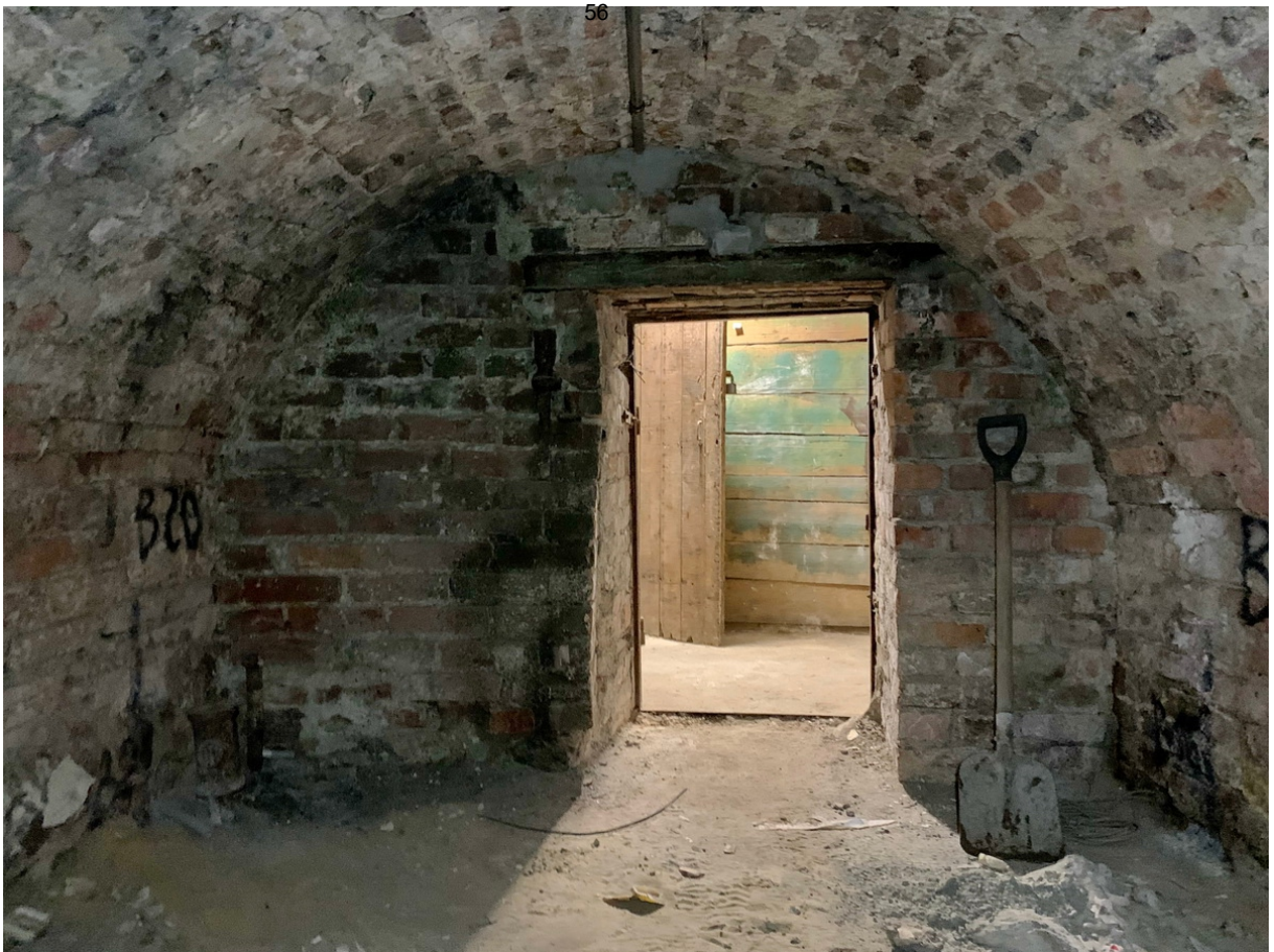
13 ОКН регионального значения “Жилой дом со службами К. Клоуберга” Ленинградская область, Выборгский муниципальный район, г. Выборг, ул. Сторожевой башни, д. 18. Подвал № 1. Помещение 2. Дата съемки: 02.05.2022 г.
