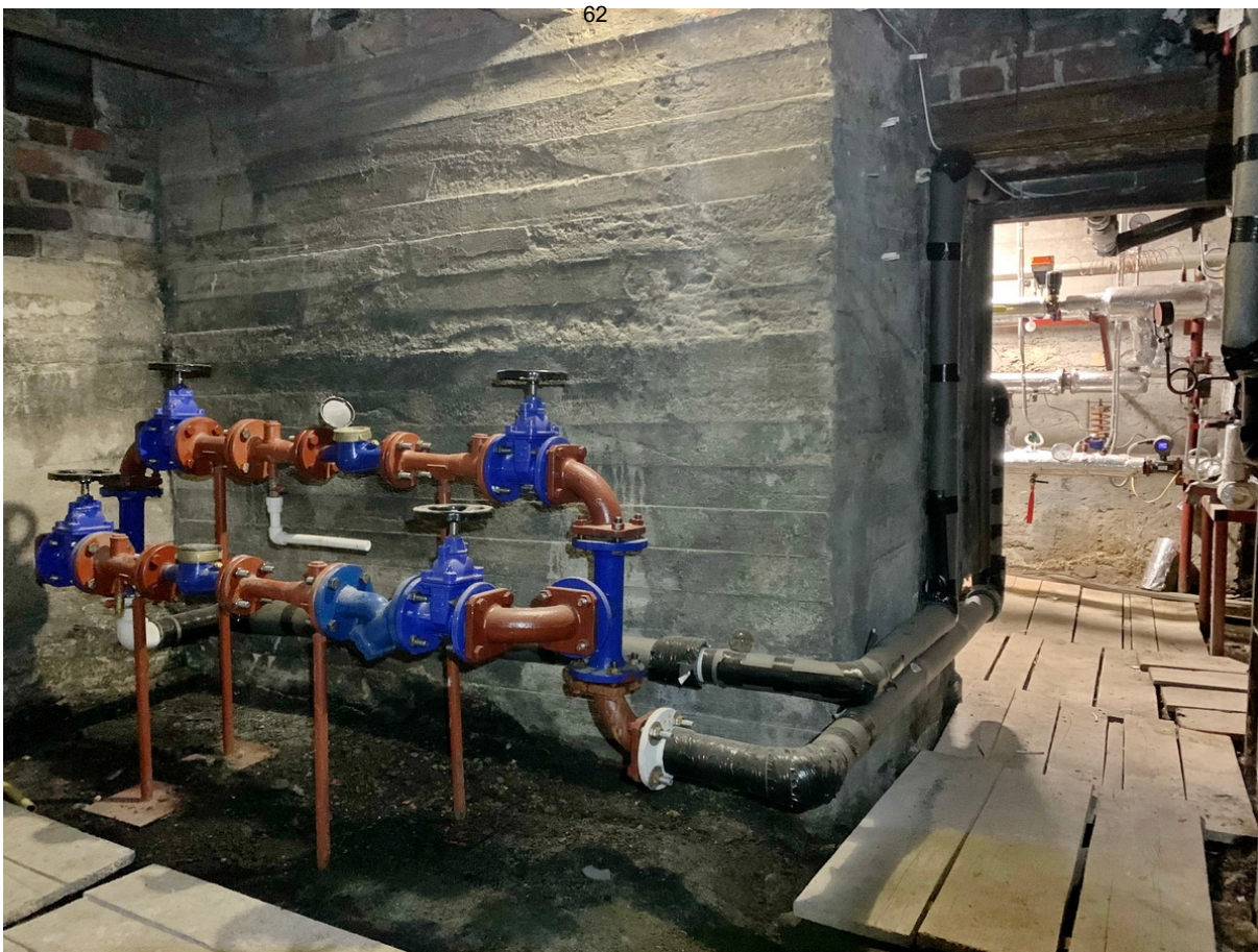
25 ОКН регионального значения “Жилой дом со службами К. Клоуберга” Ленинградская область, Выборгский муниципальный район, г. Выборг, ул. Сторожевой башни, д. 18. Подвал № 1. Помещение 11. Дата съемки: 02.05.2022 г.
