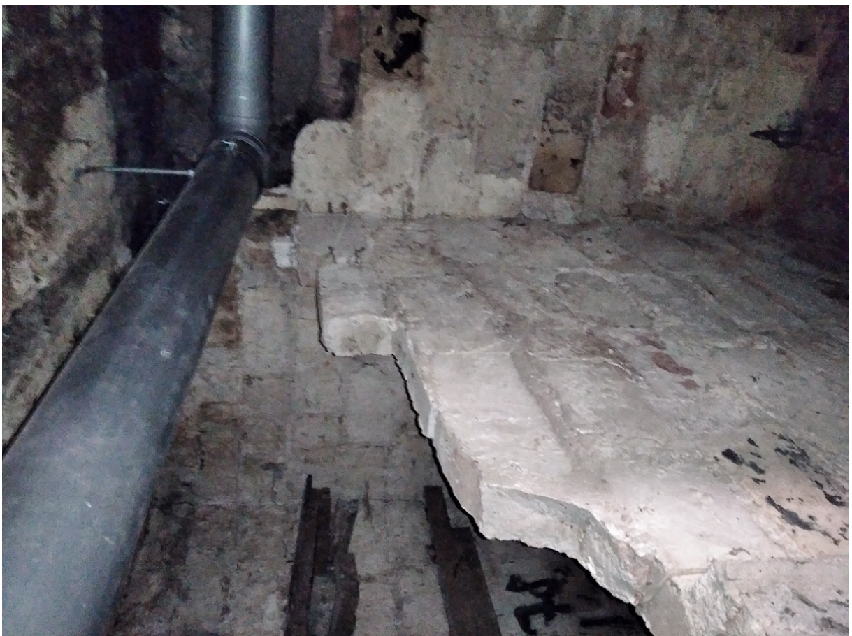
40 ОКН регионального значения “Жилой дом со службами К. Клоуберга” Ленинградская область, Выборгский муниципальный район, г. Выборг, ул. Сторожевой башни, д. 18. Подвал № 3. Вид из помещения 1 на помещения 7 и 8. Дата съемки: 02.05.2022 г.
