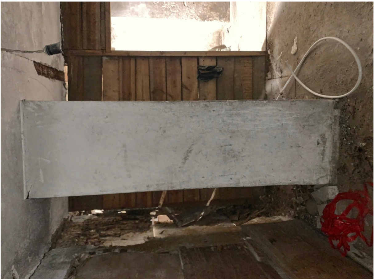
18 ОКН регионального значения “Жилой дом со службами К. Клоуберга” Ленинградская область, Выборгский муниципальный район, г. Выборг, ул. Сторожевой башни, д. 18. Подвал № 1. Помещение 4. Дата съемки: 02.05.2022 г.
