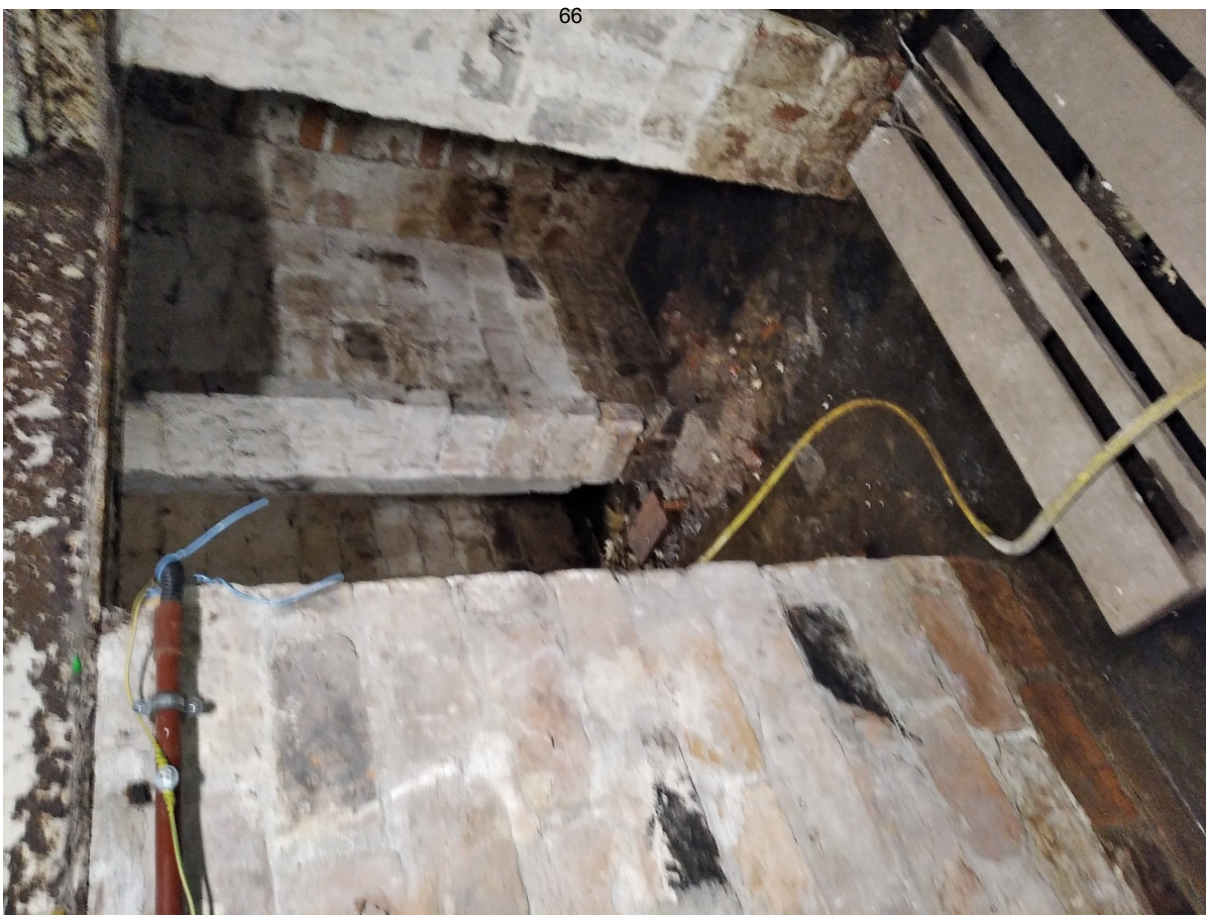
33 ОКН регионального значения “Жилой дом со службами К. Клоуберга” Ленинградская область, Выборгский муниципальный район, г. Выборг, ул. Сторожевой башни, д. 18. Подвал № 3. Помещение 1. Дата съемки: 02.05.2022 г.
