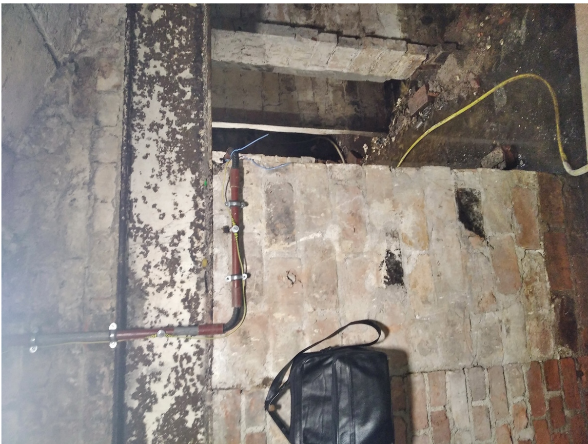
34 ОКН регионального значения “Жилой дом со службами К. Клоуберга” Ленинградская область, Выборгский муниципальный район, г. Выборг, ул. Сторожевой башни, д. 18. Подвал № 3. Помещение 1. Дата съемки: 02.05.2022 г.
