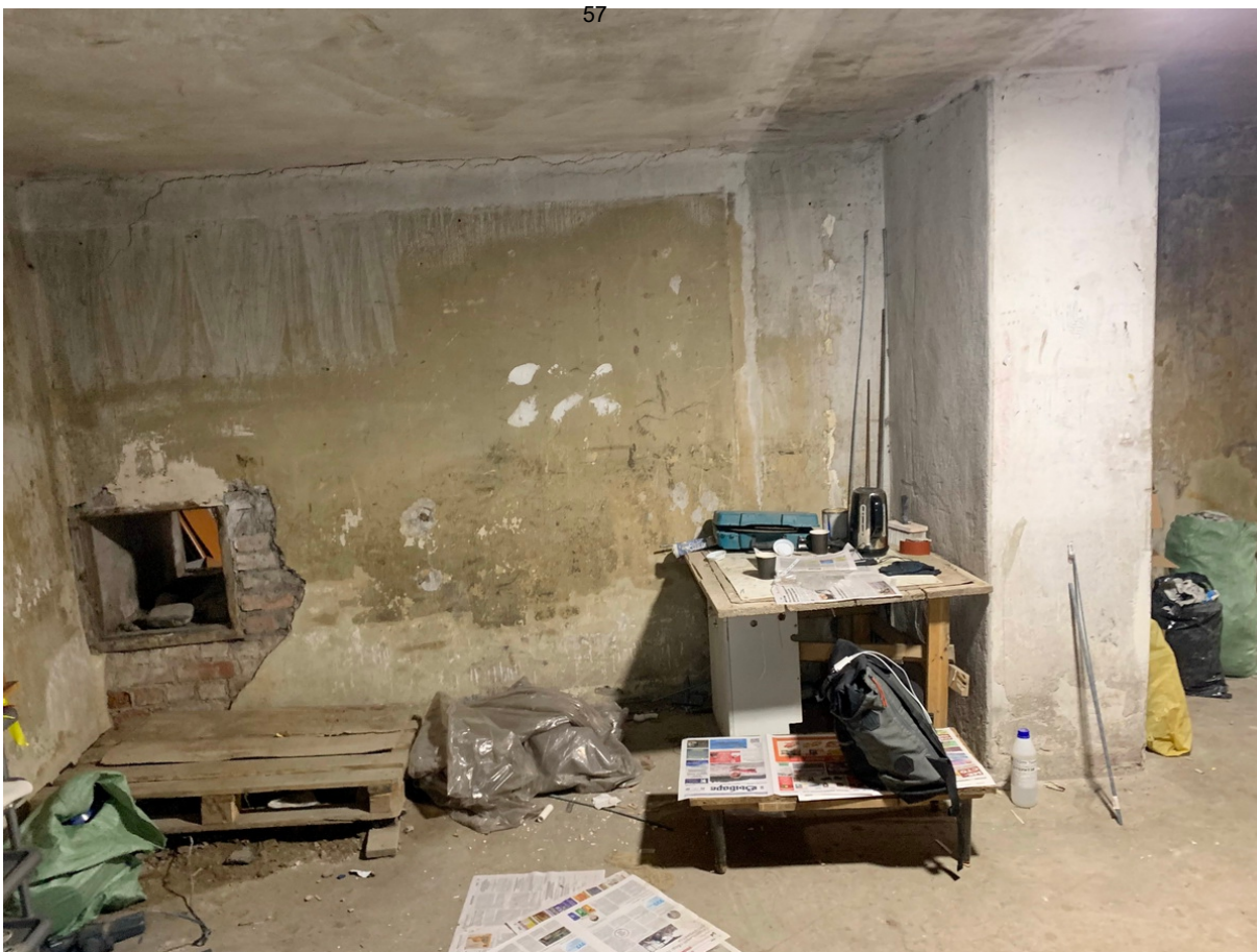
15 ОКН регионального значения “Жилой дом со службами К. Клоуберга” Ленинградская область, Выборгский муниципальный район, г. Выборг, ул. Сторожевой башни, д. 18. Подвал № 1. Помещение 3. Дата съемки: 02.05.2022 г.
