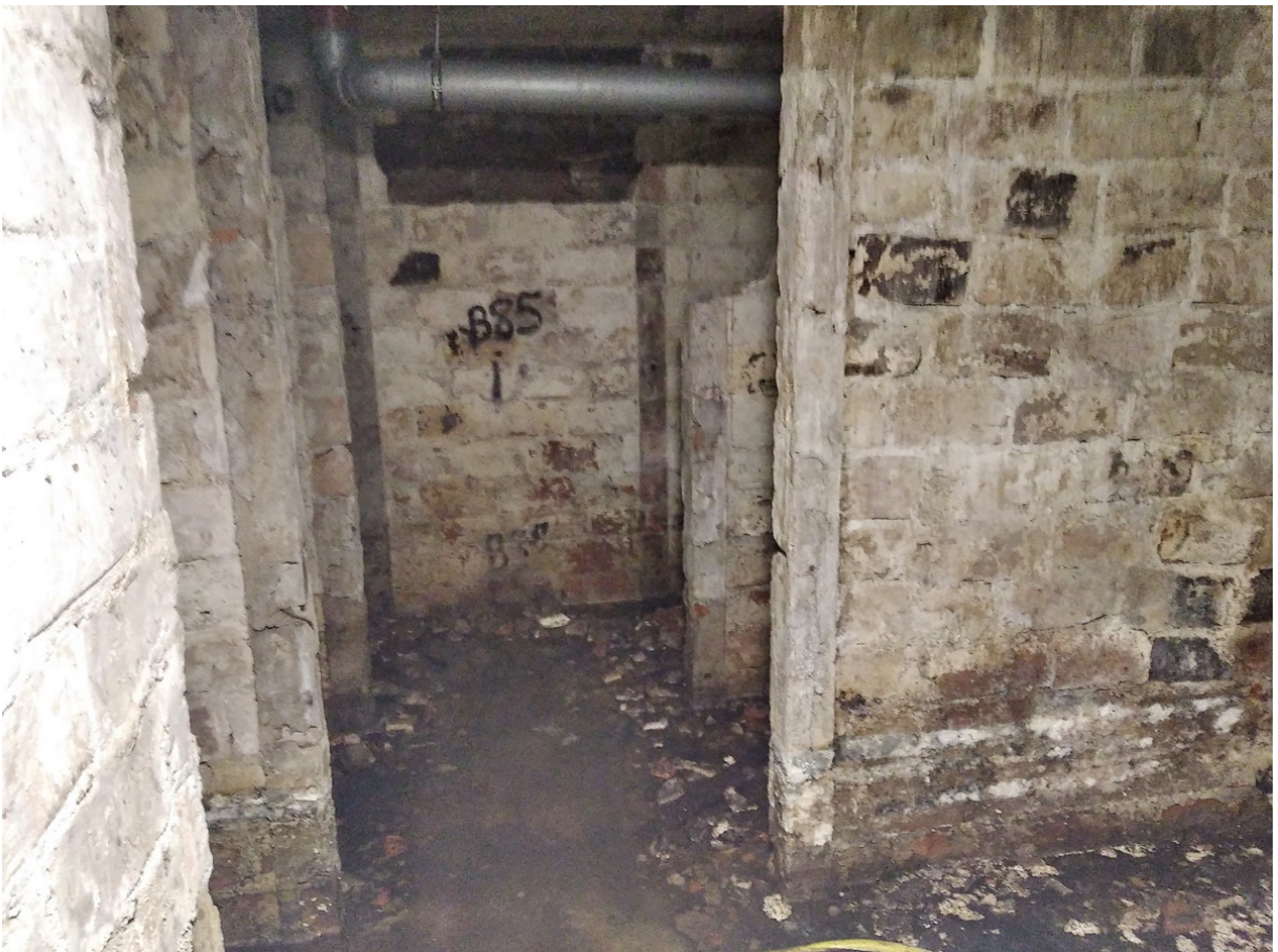
38 ОКН регионального значения “Жилой дом со службами К. Клоуберга” Ленинградская область, Выборгский муниципальный район, г. Выборг, ул. Сторожевой башни, д. 18. Подвал № 3. Помещение 1. Дата съемки: 02.05.2022 г.
