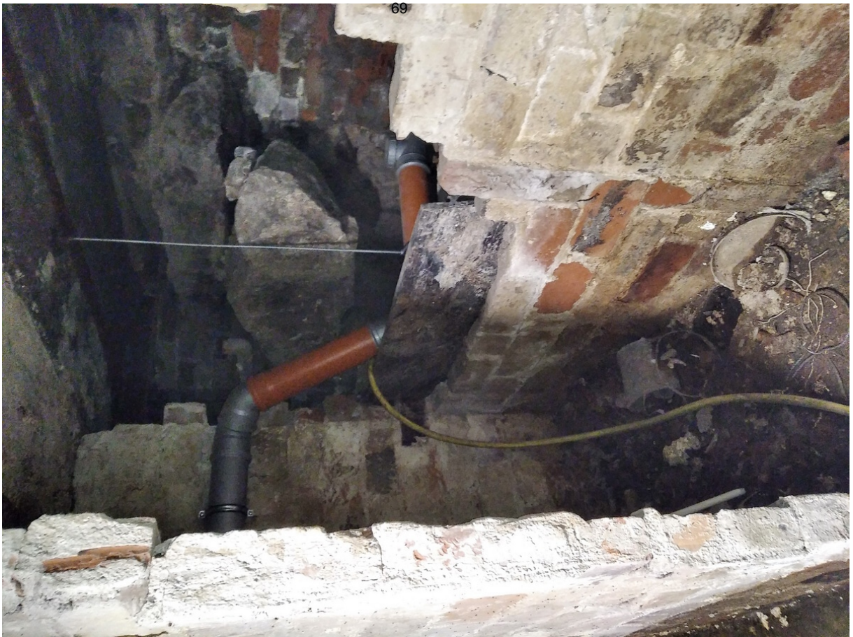
39 ОКН регионального значения “Жилой дом со службами К. Клоуберга” Ленинградская область, Выборгский муниципальный район, г. Выборг, ул. Сторожевой башни, д. 18. Подвал № 3. Вид из помещения 1 на помещение 11. Дата съемки: 02.05.2022 г.
