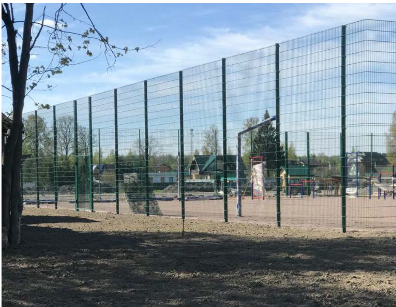
2. Вид на зону производства работ и Малоневский канал объекта культурного наследия регионального значения «Комплекс зданий и сооружений на Староладожском канале», расположенного по адресу: Ленинградская область, Кировский муниципальный район, Шлиссельбургское городское поселение, г. Шлиссельбург, ул. Малоневский канал, соор. 1.
