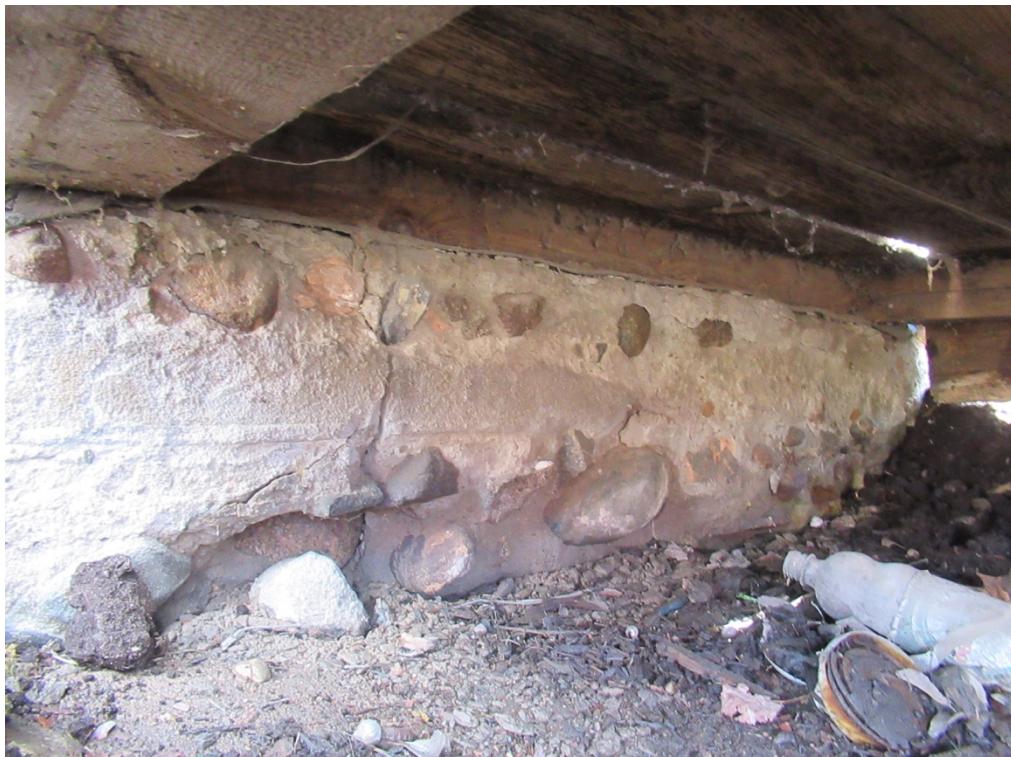
Фото 19. Цокольная часть под крыльцом
