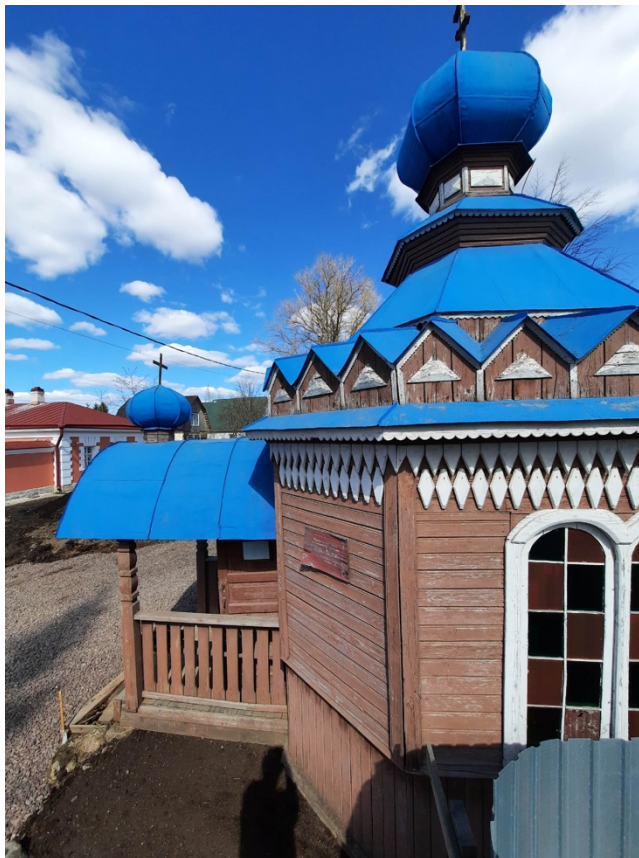
Фото 3. Вид карниза со с южной стороны
