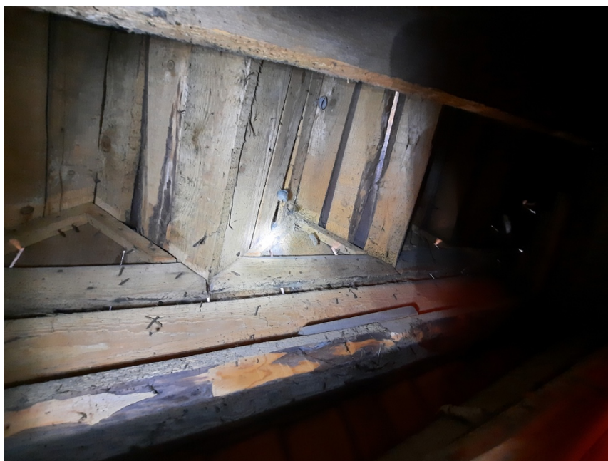
Фото 16. Внутренний вид под одшивкой потолка
