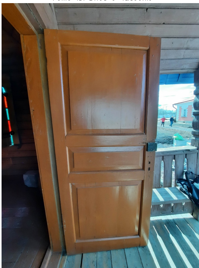
Фото 14. Внутренняя сторона дверного заполнения Д-1
