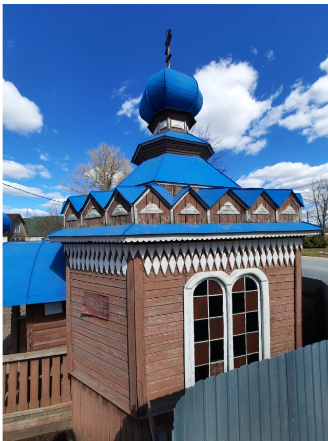
Фото 4. Общий вид на карнизную часть часовни
