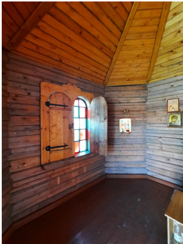
Фото 1. Интерьер часовни с северной стороны
