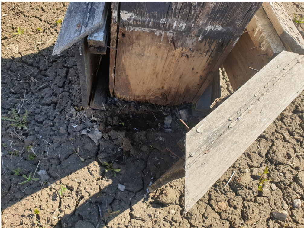
Фото 5. Вскрытие обшивки цоколя Верстового знака
