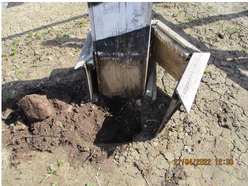
Фото 7. Шурф основания Верстового знака
