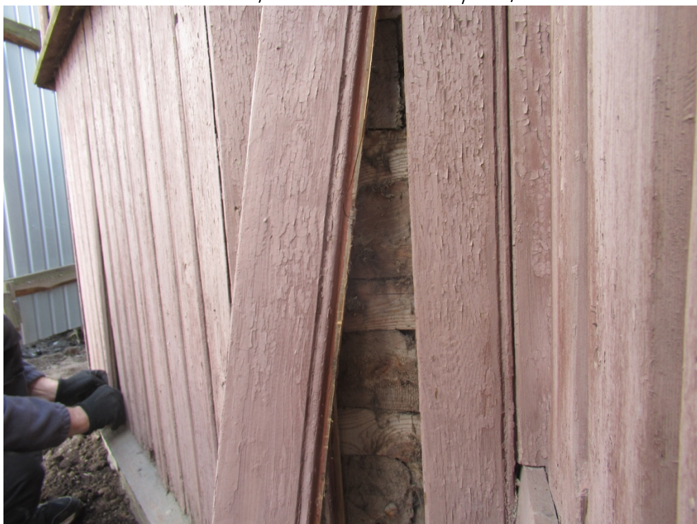
Фото 20. Вскрытие обшивки часовни
