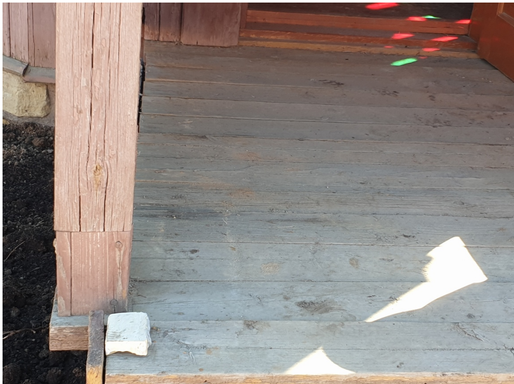
Фото 17. Внутренний вид под одшивкой потолка
